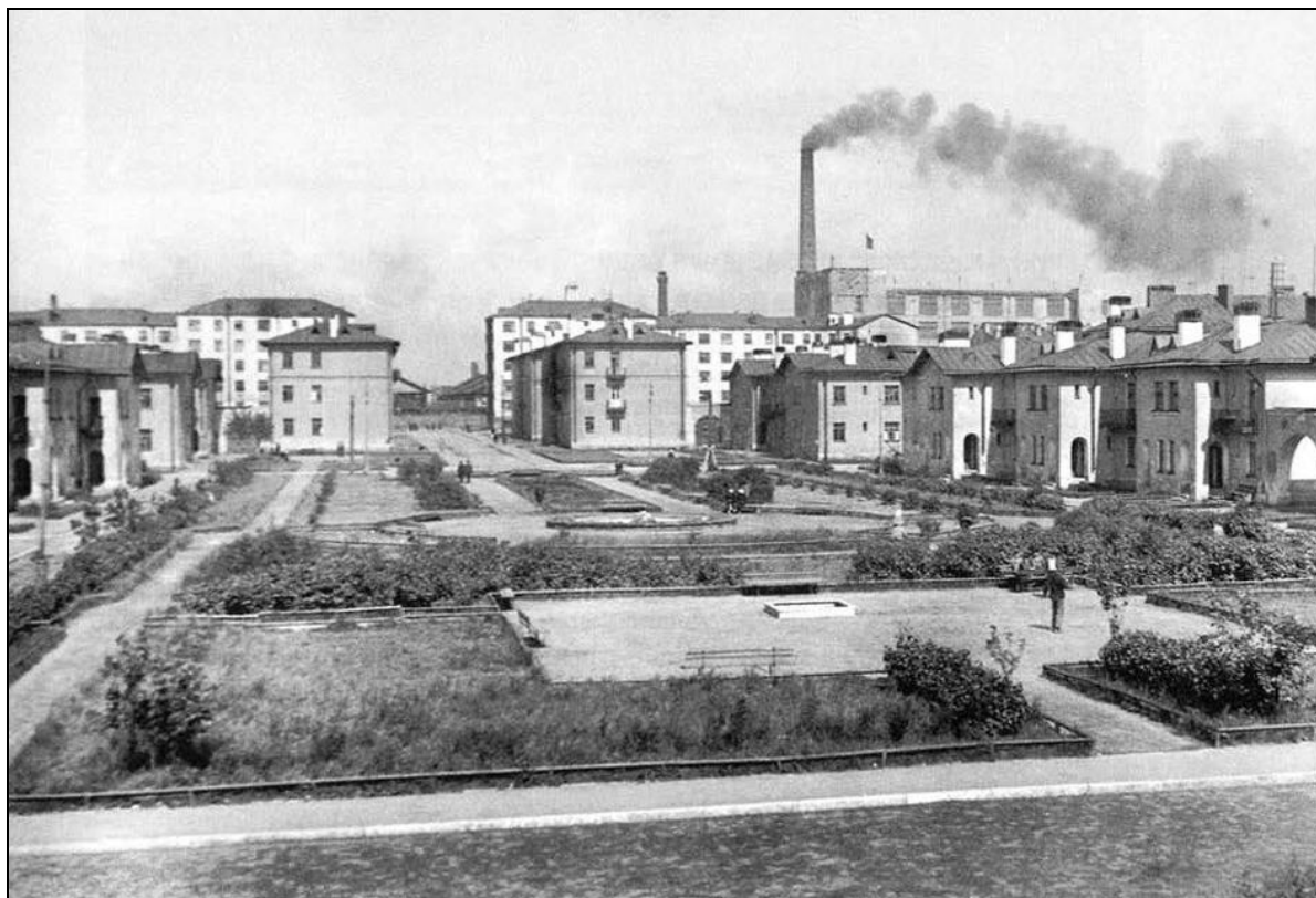
Илл. 14. Палевский жилмассив. Фотография. 1939 г. Из кн.: Архитектура ленинградского авангарда. Путеводитель / Б.М. Кириков, М.С. Штиглиц. – СПб.: Коло, 2008. – С. 137.
