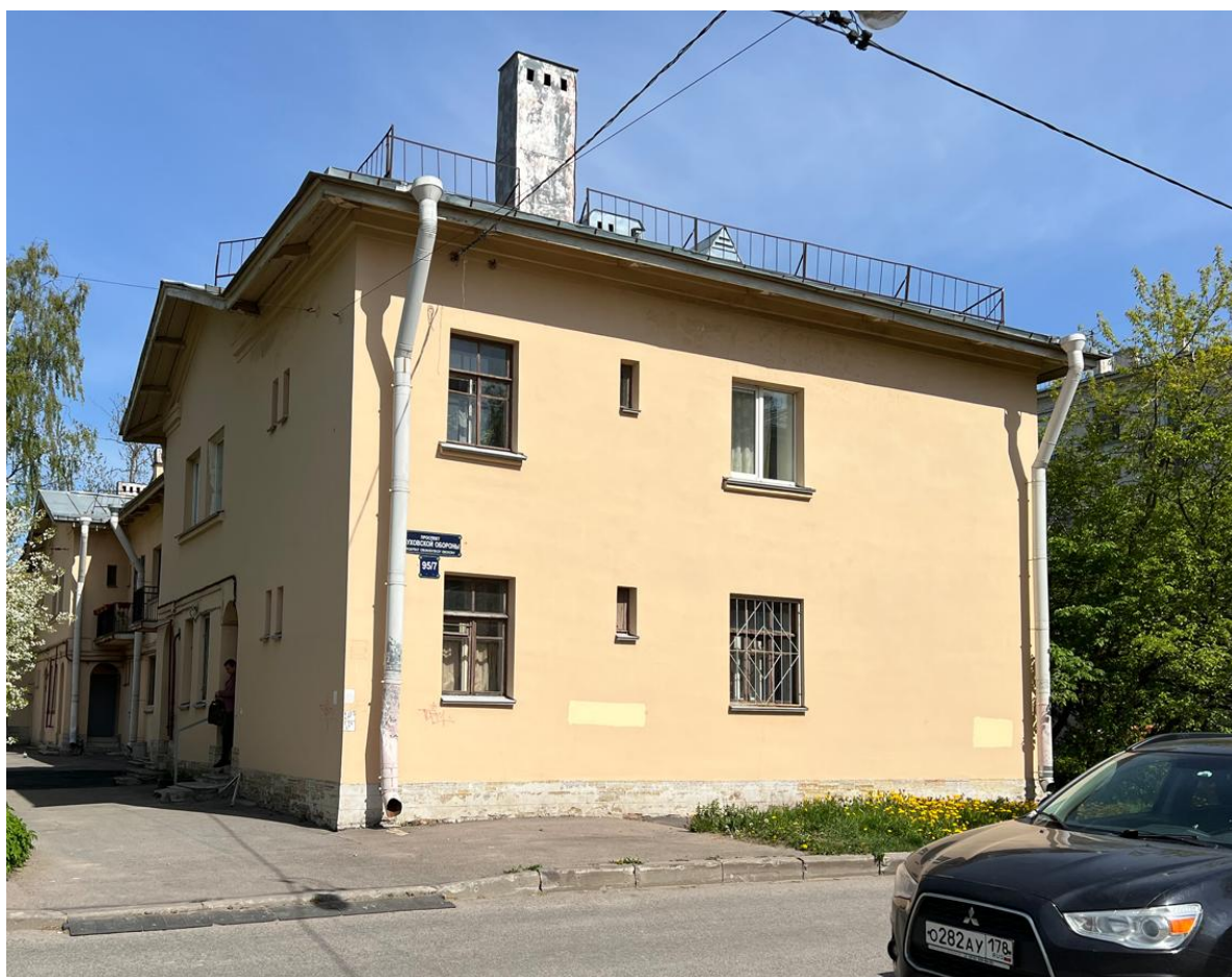
2. Выявленный объект культурного наследия «Жилой дом» в составе выявленного объекта культурного наследия «Палевский жилмассив (19 домов)», расположенный по адресу: г. Санкт-Петербург, ул. Ольги Берггольц, д. 5, корп. 2. Вид с запада.
