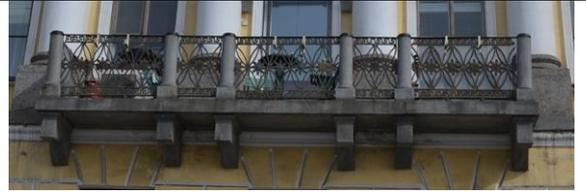
балкон угловой северо-западной части лицевого фасада - конфигурация, местоположение и габариты (в уровне 3-го этажа), конструкция и материал (гранитное основание на гранитных кронштейнах), балконное ограждение в виде металлических секций с рисунком из пересекающихся овалов и горизонтальных поясов меандра и бегущей волны, между гранитными, круглыми в плане столбиками;
