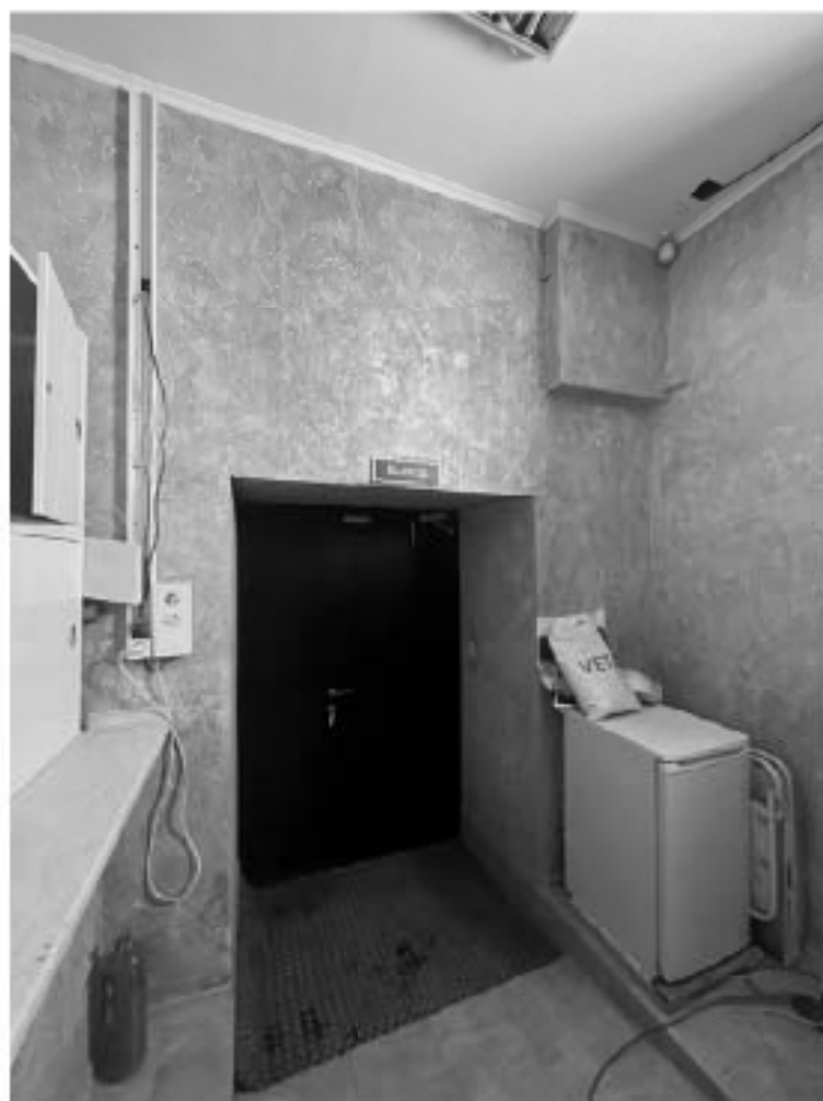
Фото №9. Помещение 3-Н, 1 этаж.
