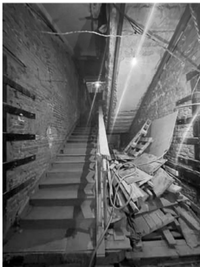
Фото №14. Помещение 3-Н, 1 этаж, лестничная клетка.
