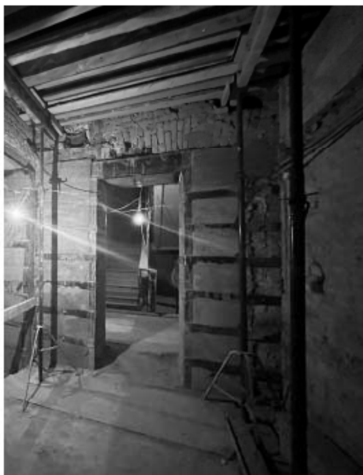
Фото №22. Помещение 3-Н, 2 этаж.
