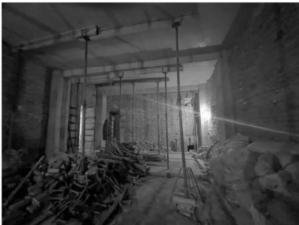
Фото №15. Помещение 3-Н, 1 этаж.
