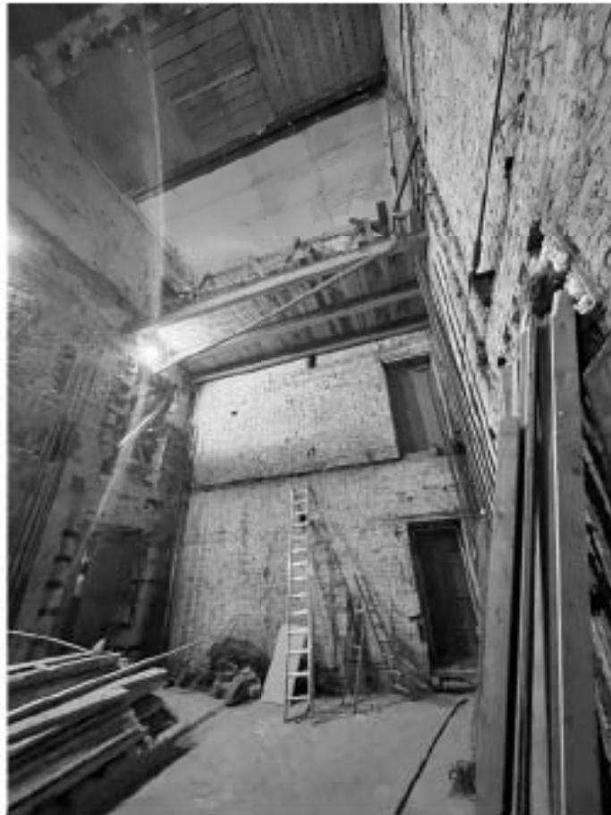
Фото №30. Помещение 3-Н, 3 этаж.
