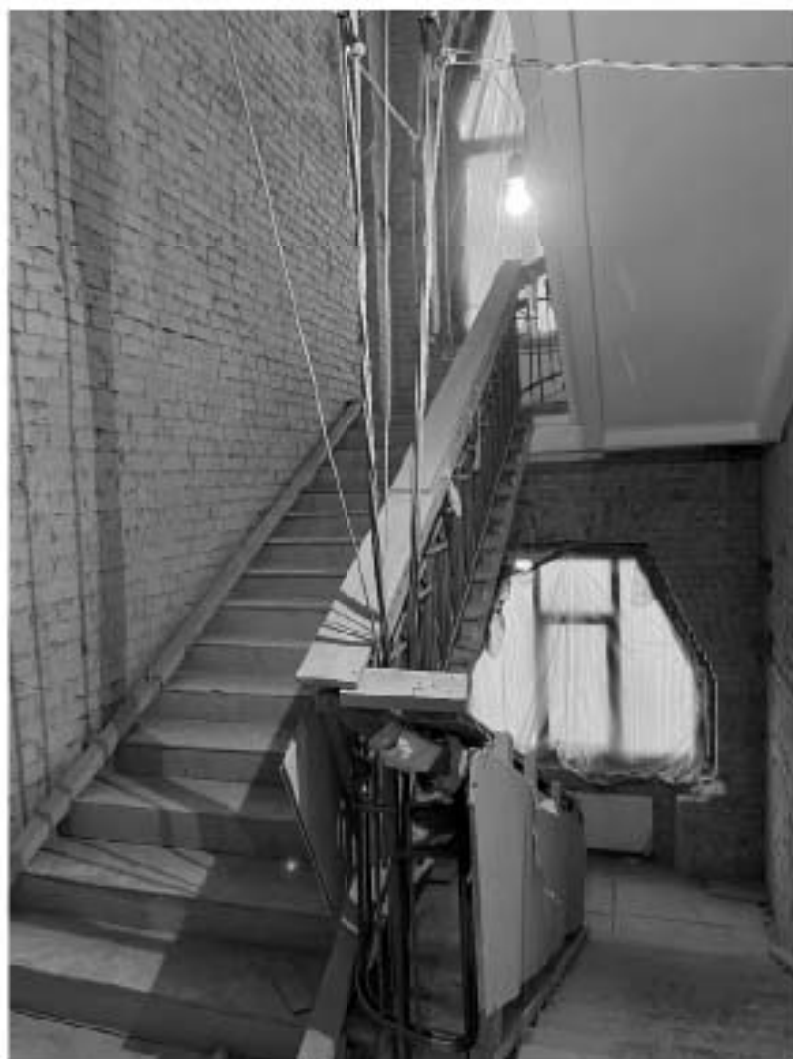
Фото №8. Помещение 3-Н, восточная лестничная клетка – 4-ый этаж.
