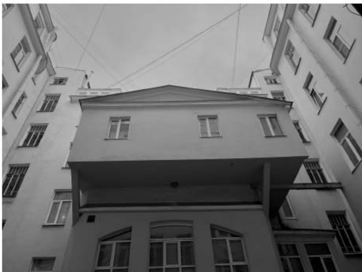
Фото №2. Южный дворовый фасад.
