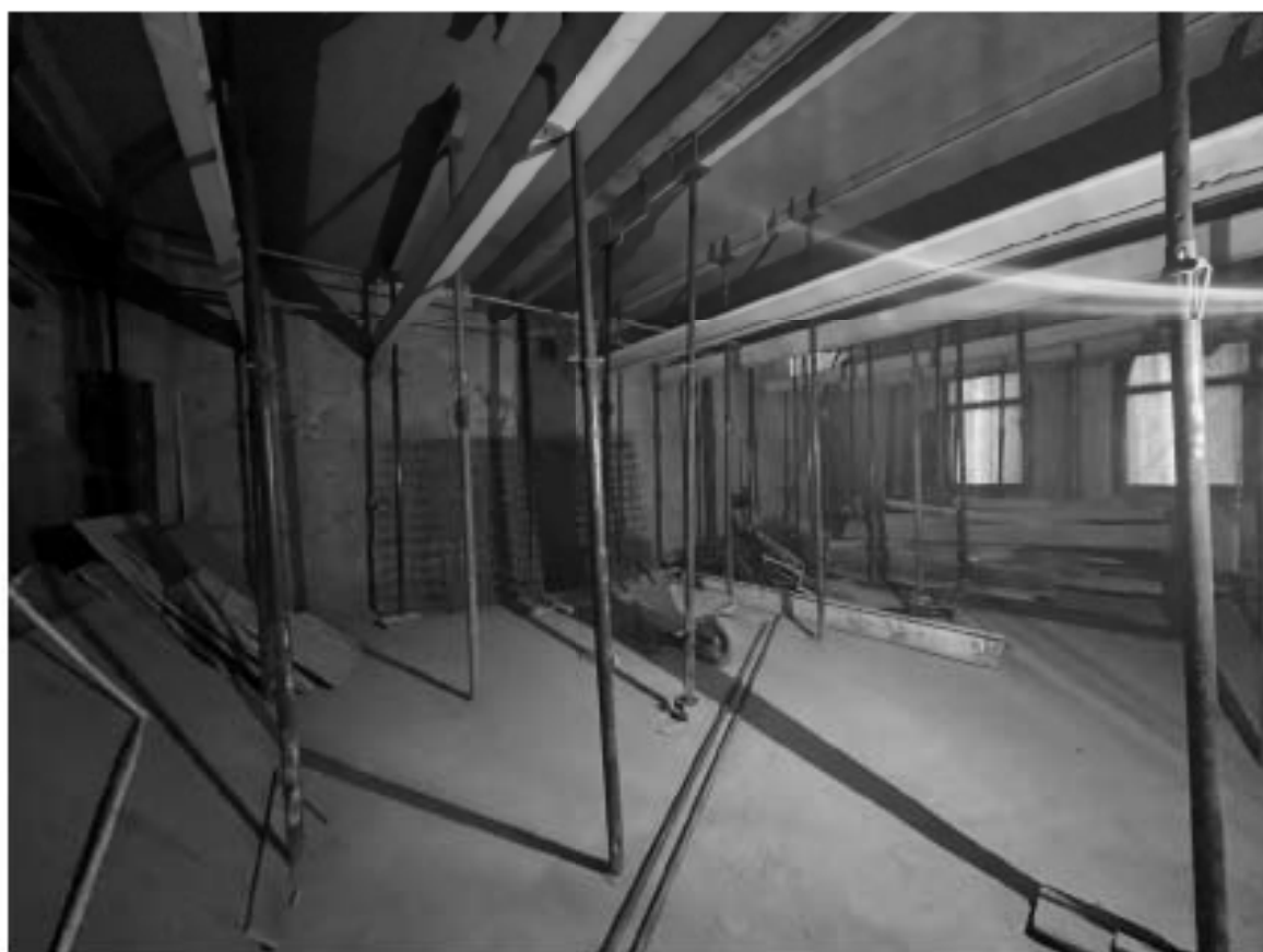
Фото №25. Помещение 3-Н, 2 этаж.
