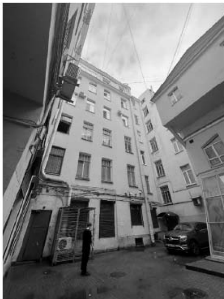
Фото №3. Западный фасад западного продольного дворового флигеля.
