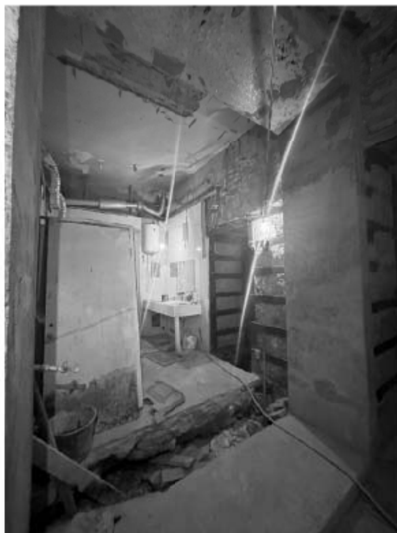
Фото №13. Помещение 3-Н, 1 этаж.
