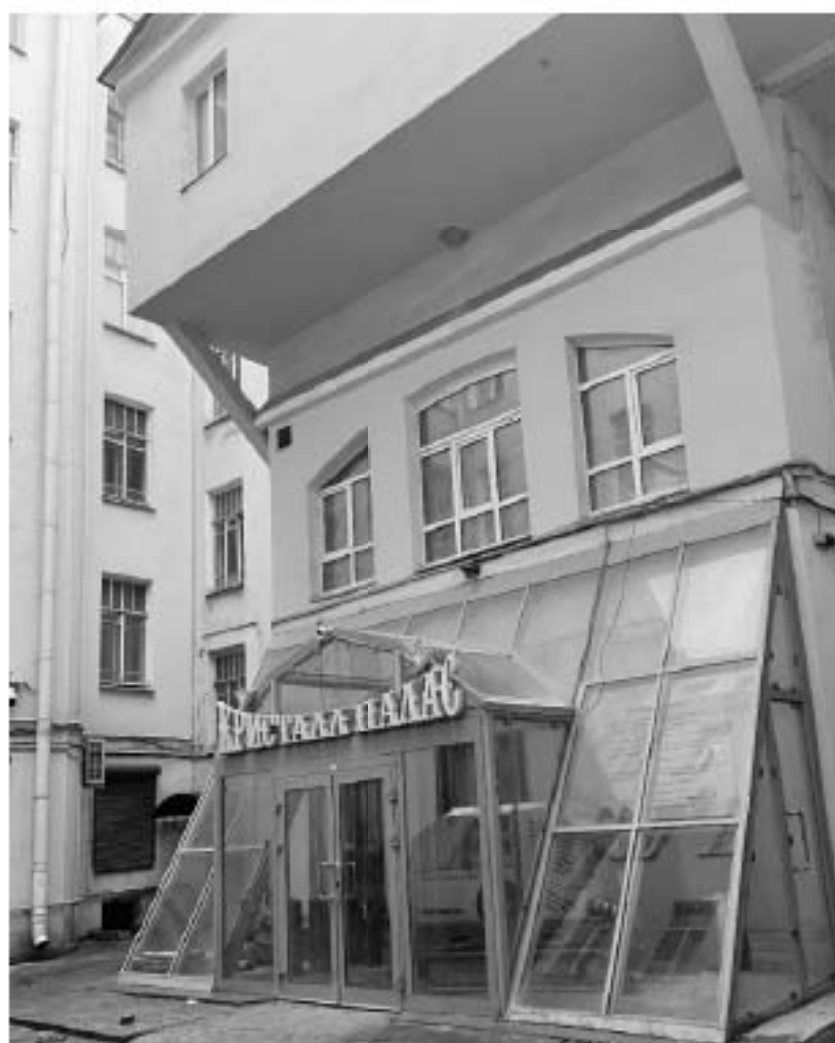
Фото №1. Южный дворовый фасад.
