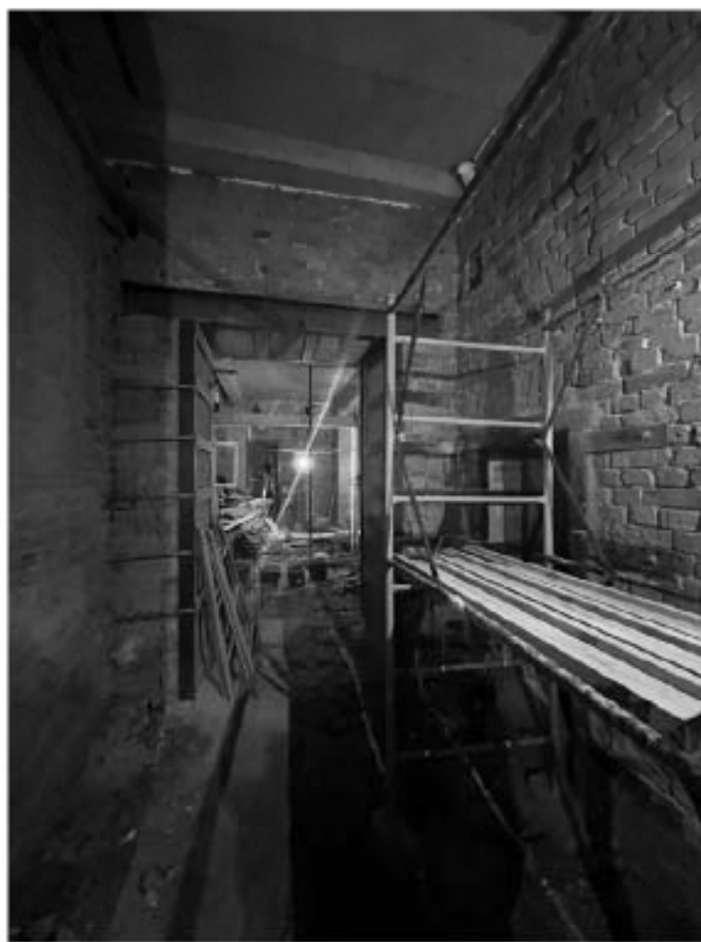
Фото №17. Помещение 3-Н, 1 этаж.
