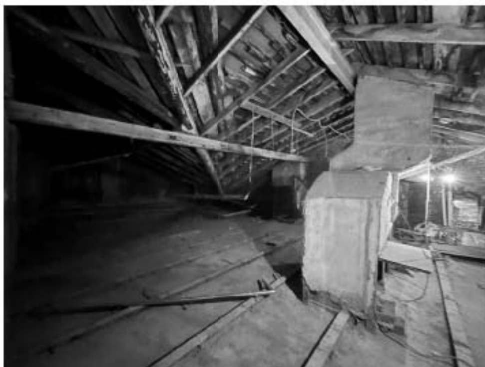
Фото №22. Чердачное пространство.
