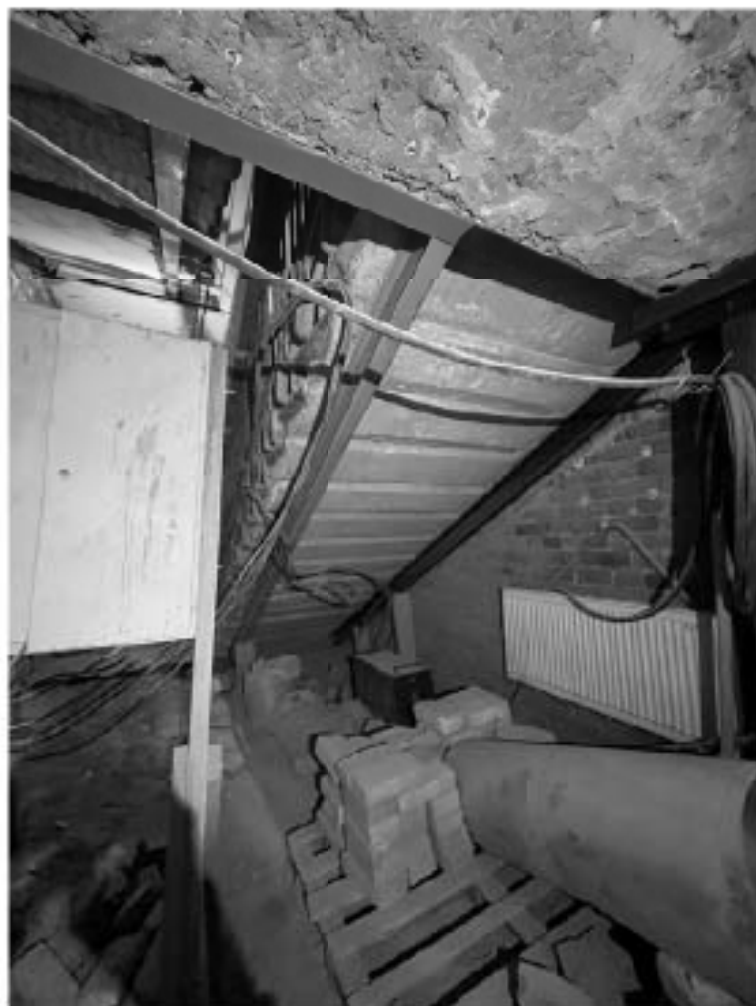
Фото №16. Помещение 3-Н, 1 этаж, лестничная клетка.
