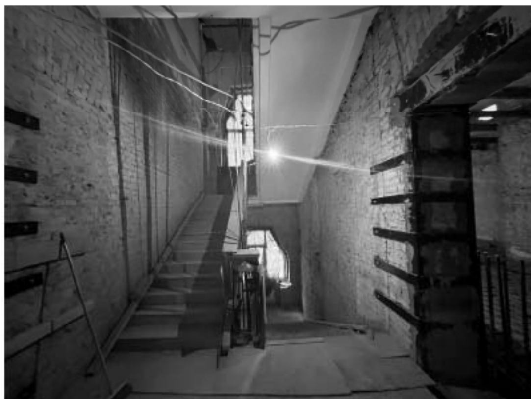
Фото №36. Помещение 3-Н, 4 этаж, лестничная клетка.
