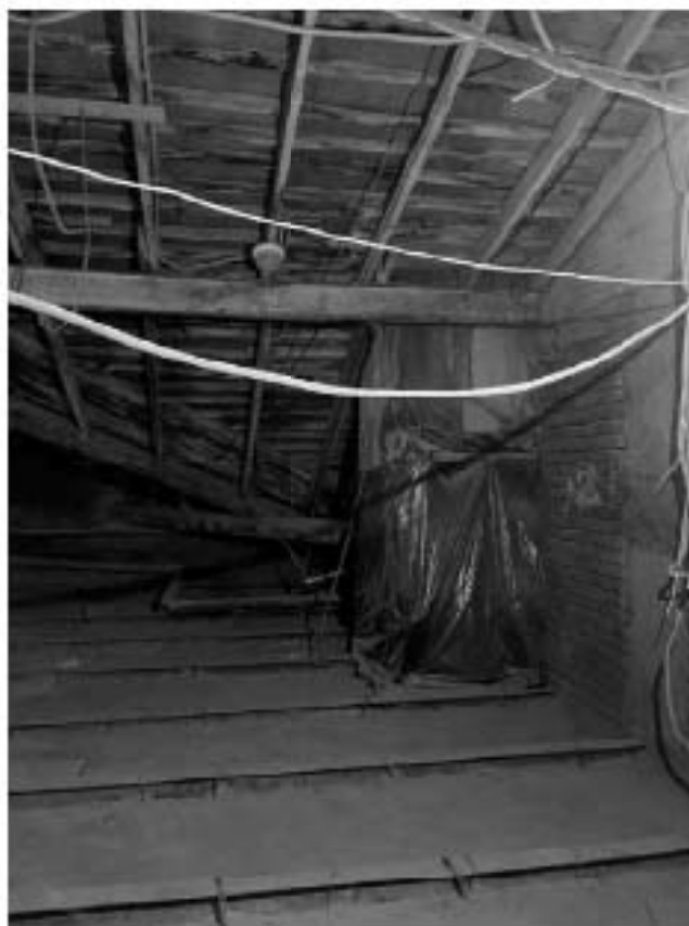
Фото №21. Чердачное пространство.
