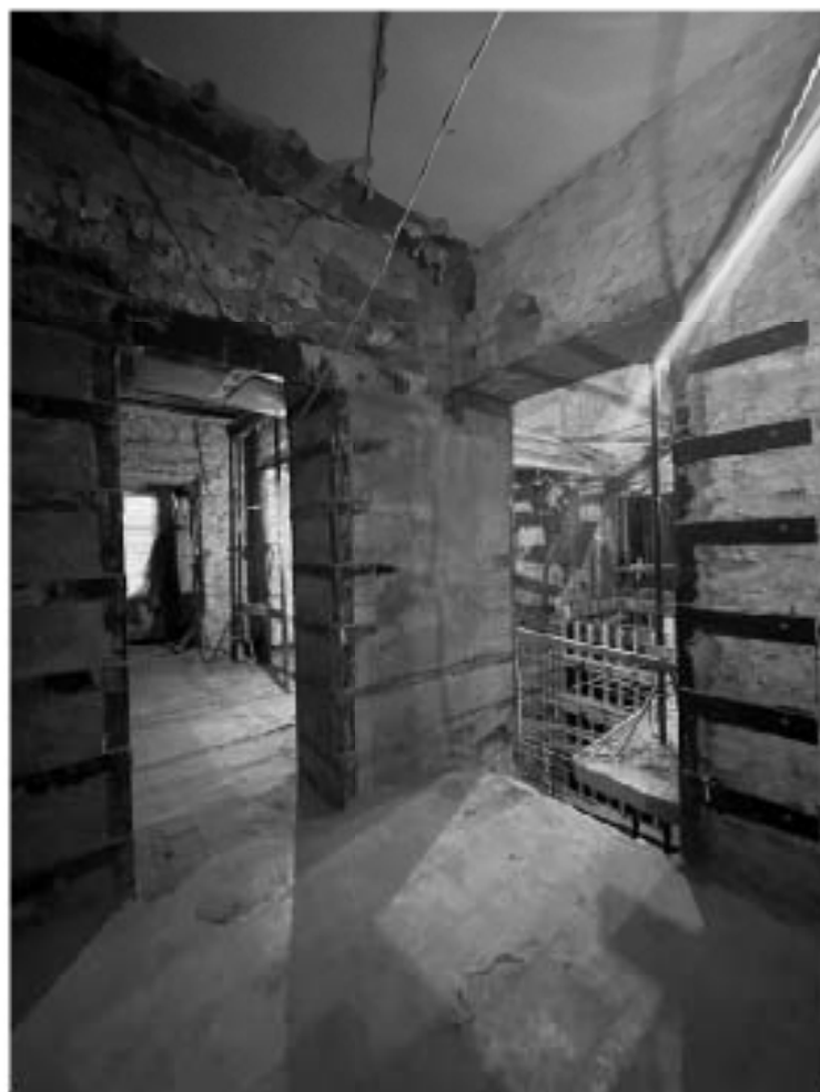
Фото №18. Помещение 3-Н, 2 этаж.
