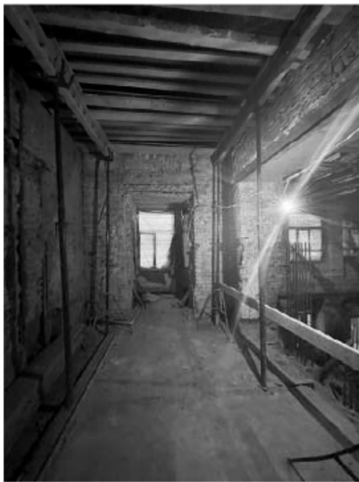
Фото №21. Помещение 3-Н, 2 этаж.
