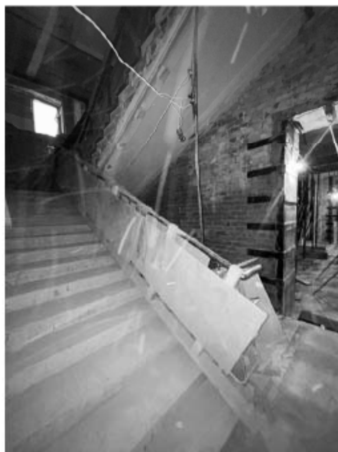
Фото №27. Помещение 3-Н, 2 этаж.
