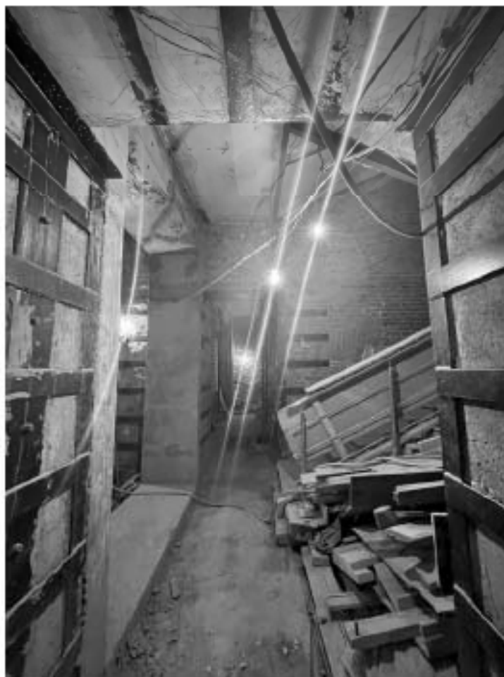
Фото №12. Помещение 3-Н, 1 этаж.
