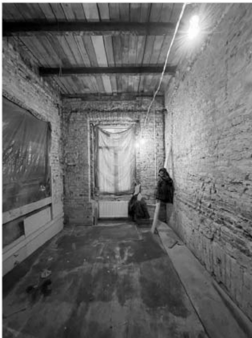
Фото №7. Помещение 3-Н, четвертый этаж.
