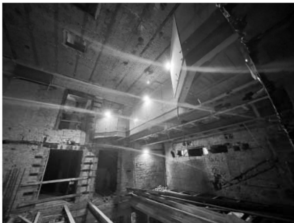
Фото №32. Помещение 3-Н, 3 этаж.
