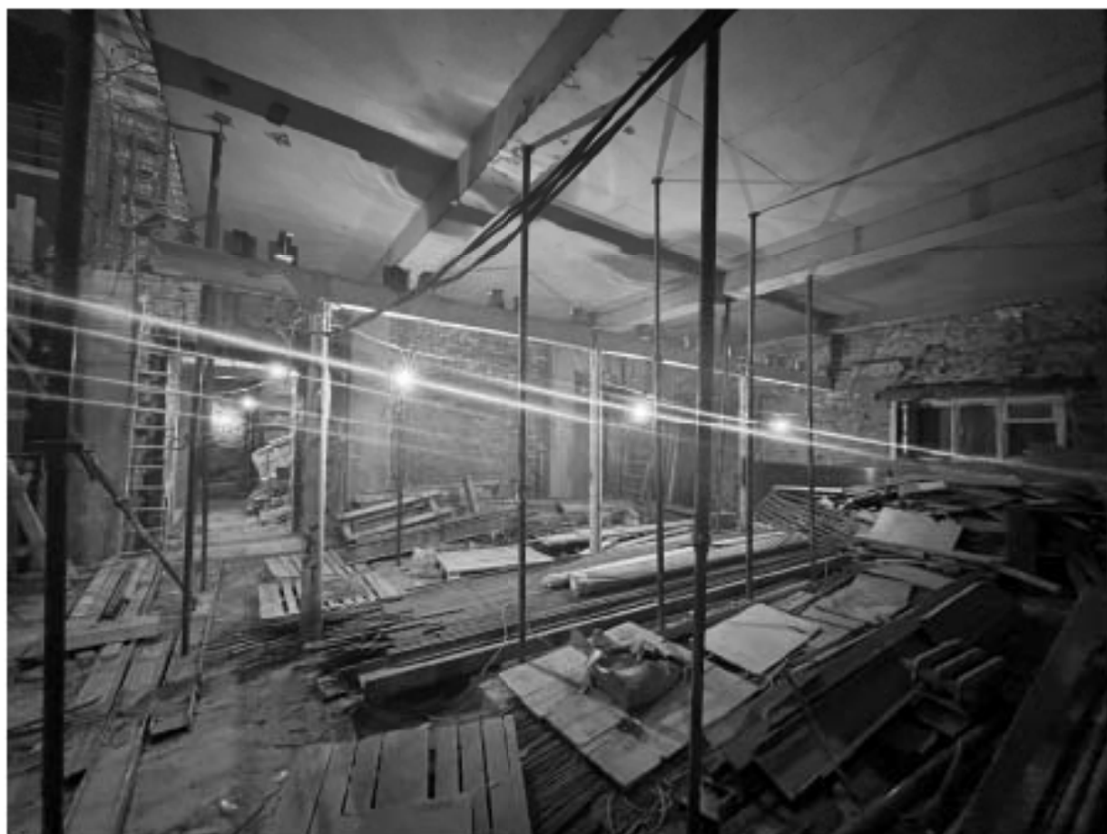
Фото №8. Помещение 3-Н, 1 этаж.
