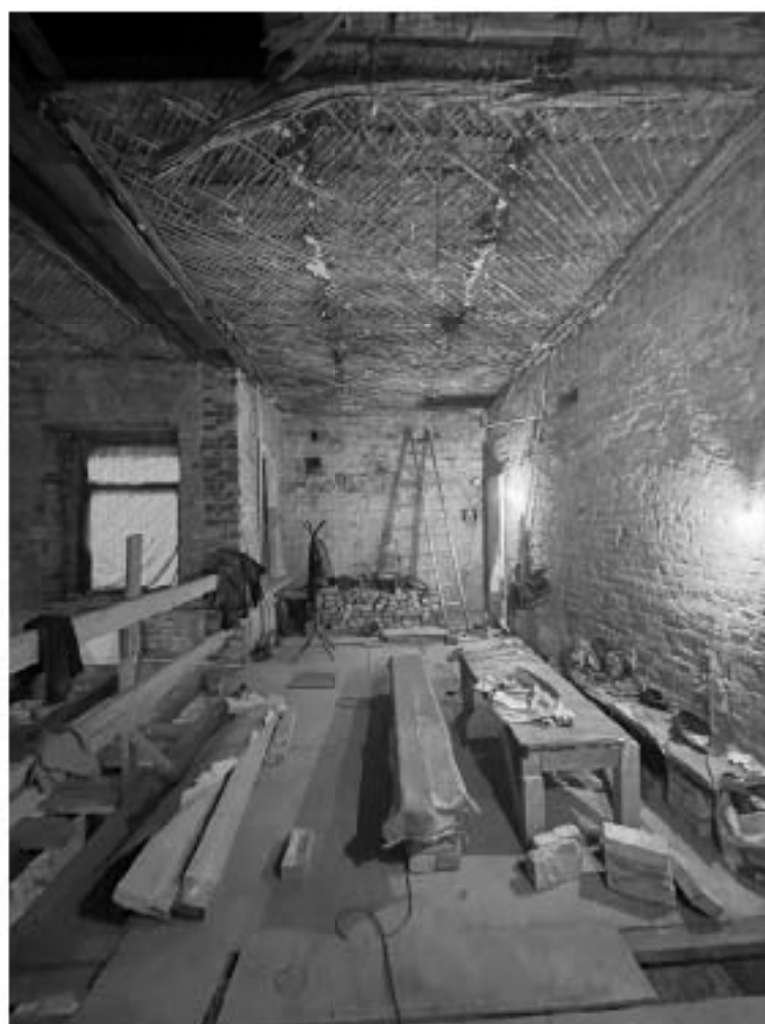
Фото №40. Помещение 3-Н, 4 этаж.
