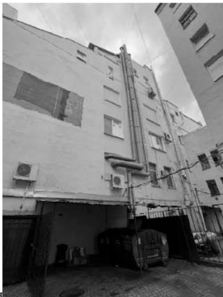
Фото №7. Северный дворовой фасад лицевого флигеля.
