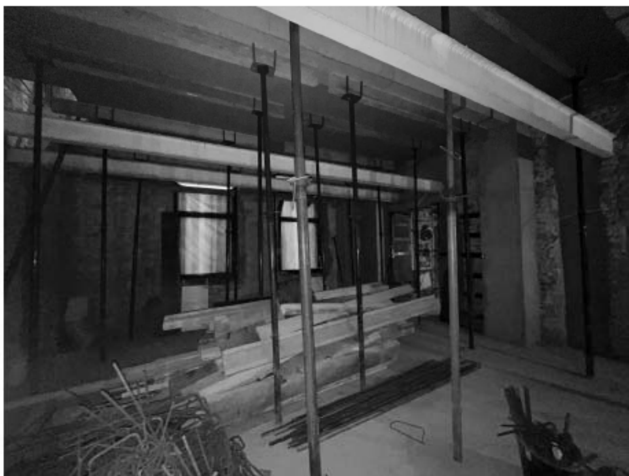
Фото №26. Помещение 3-Н, 2 этаж.
