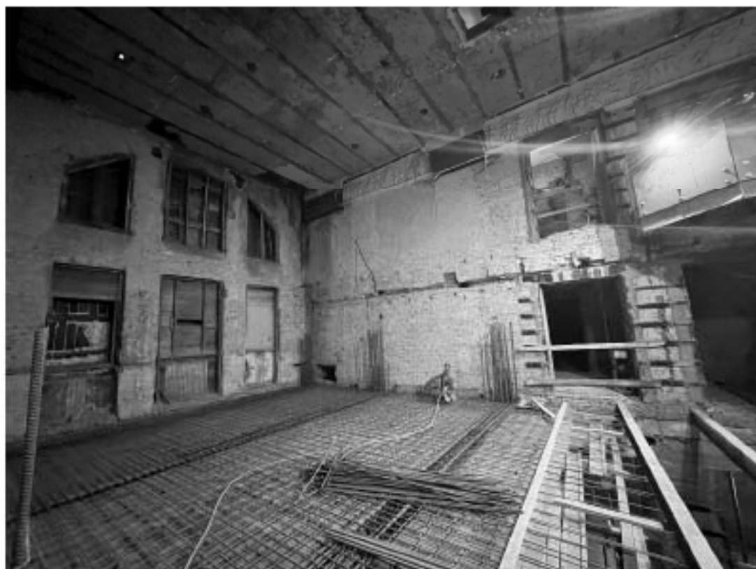
Фото №33. Помещение 3-Н, 3 этаж.
