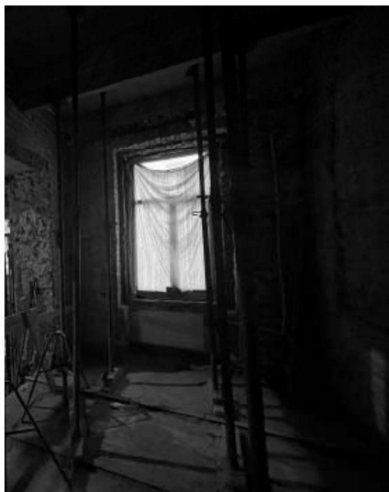
Фото №24. Помещение 3-Н, 2 этаж.
