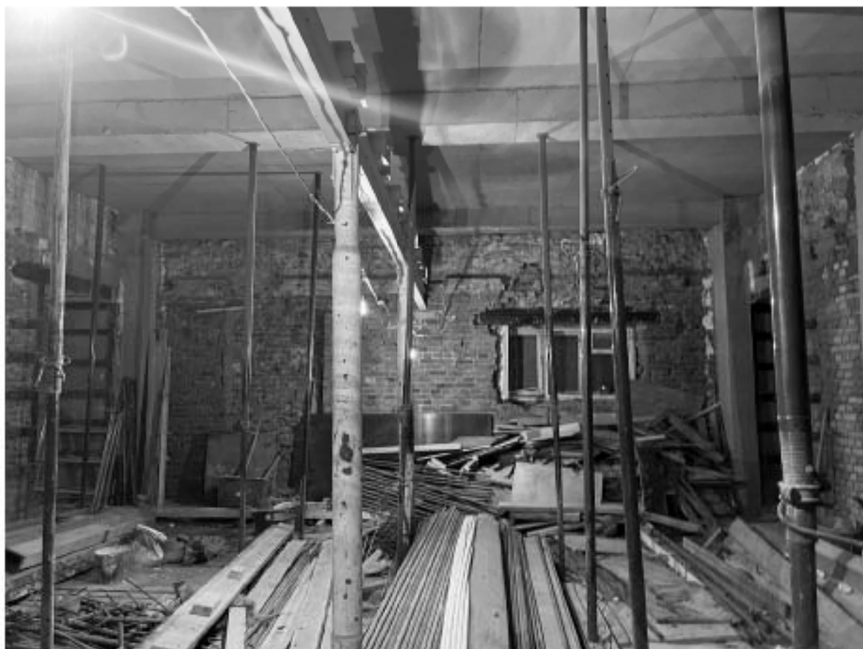
Фото №11. Помещение 3-Н, 1 этаж.
