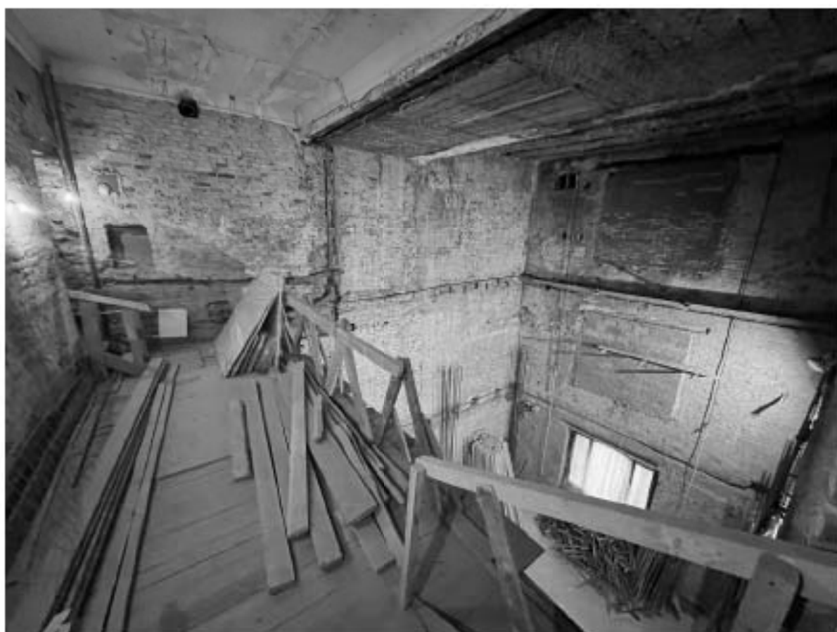
Фото №41. Помещение 3-Н, 4 этаж.
