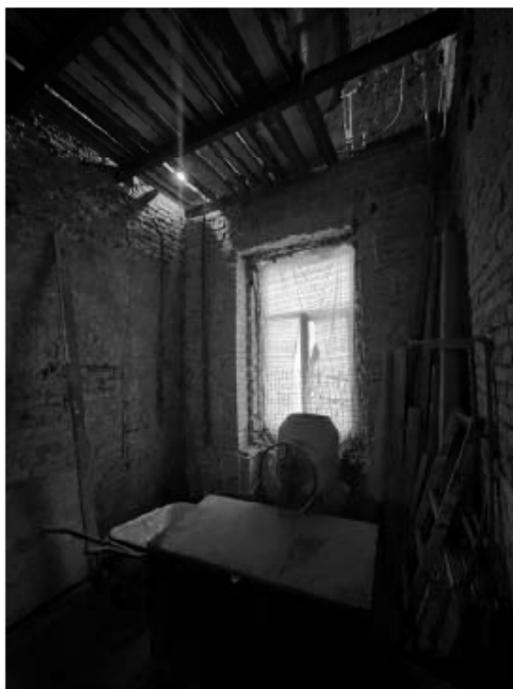
Фото №35. Помещение 3-Н, 4 этаж.
