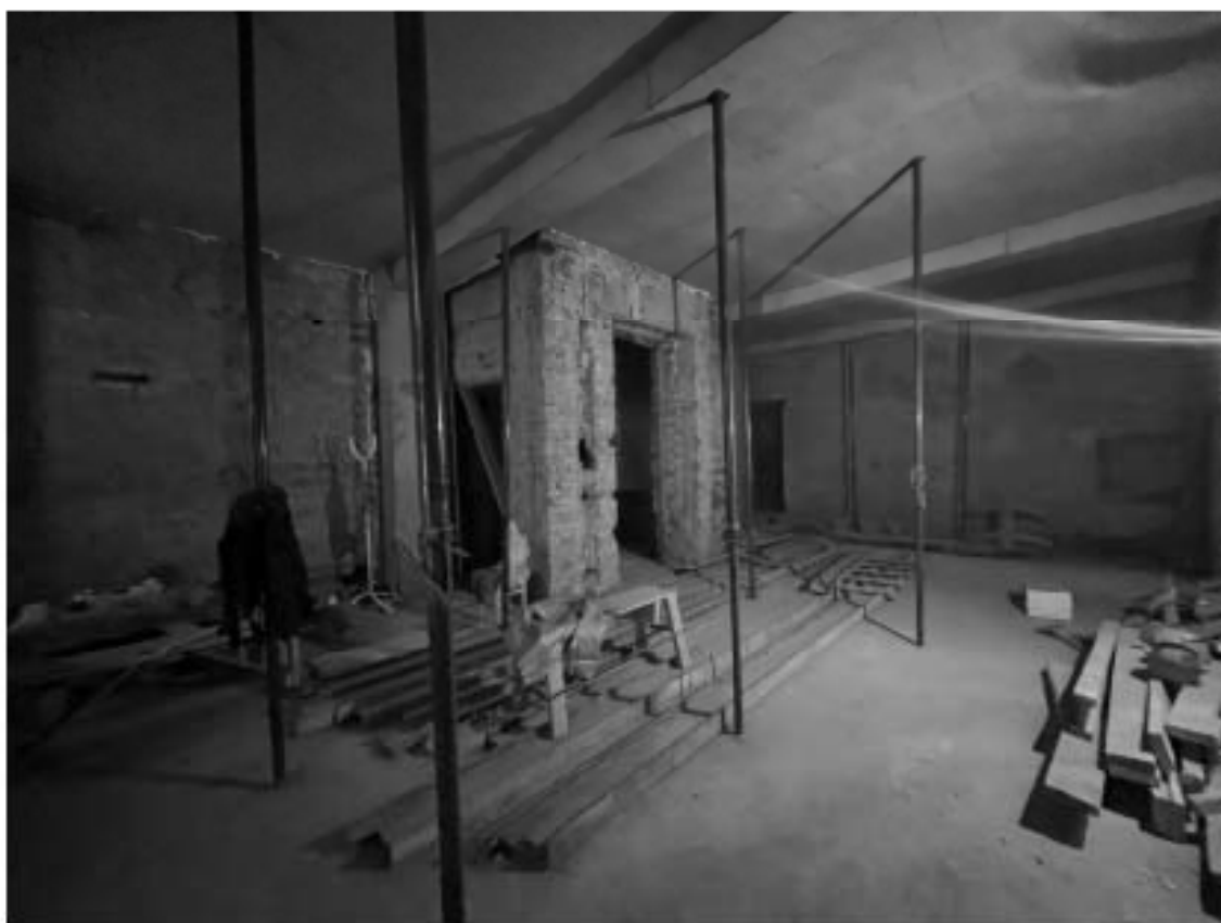
Фото №20. Помещение 3-Н, 2 этаж.
