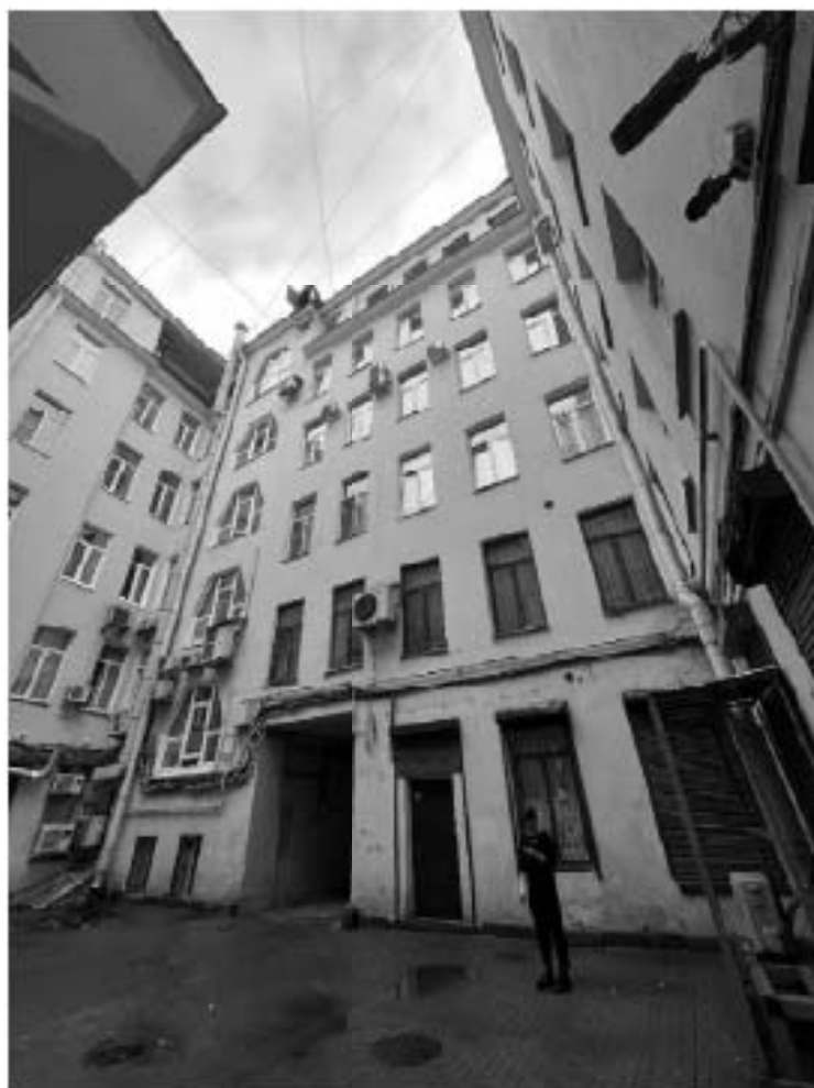
Фото №4. Северный дворовой фасад лицевого флигеля.
