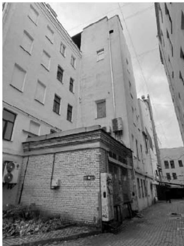
Фото №5. Северный дворовой фасад лицевого флигеля.
