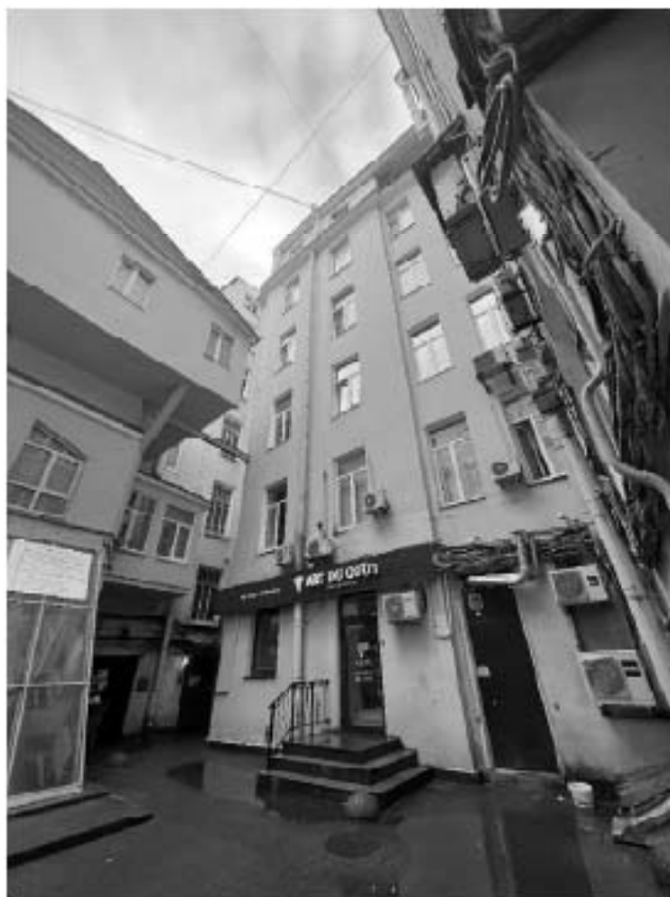
Фото №2. Западный фасад западного продольного дворового флигеля.
