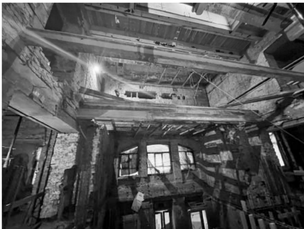
Фото №23. Помещение 3-Н, 2 этаж.
