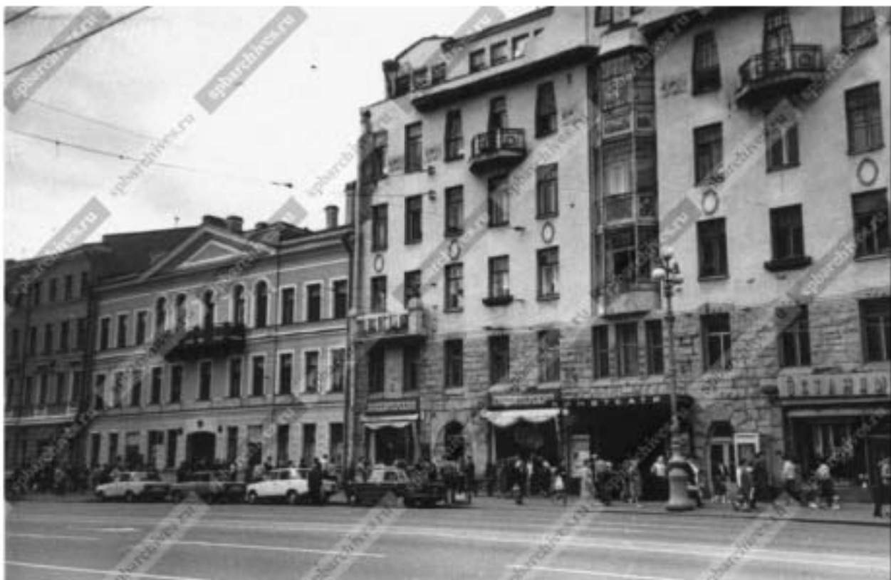
Илл. 90. Общий вид здания, где размещен кинотеатр «Знание» (Невский проспект, д. 72). 1985 г. ЦГАКФФД СПб. Ар 132309.
