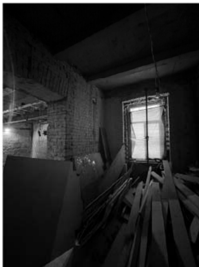
Фото №31. Помещение 3-Н, 3 этаж.
