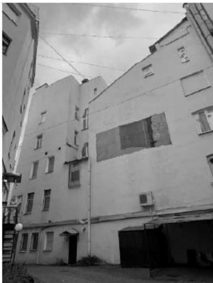
Фото №6. Северный дворовой фасад лицевого флигеля.
