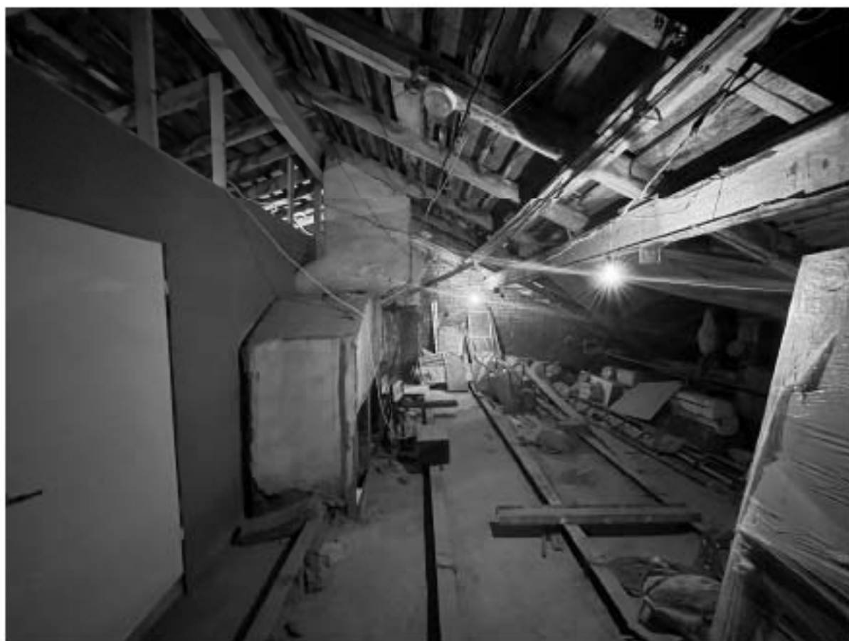
Фото №42. 5 этаж, чердак.
