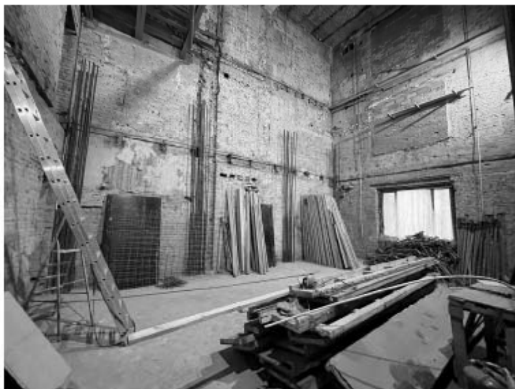
Фото №29. Помещение 3-Н, 3 этаж.
