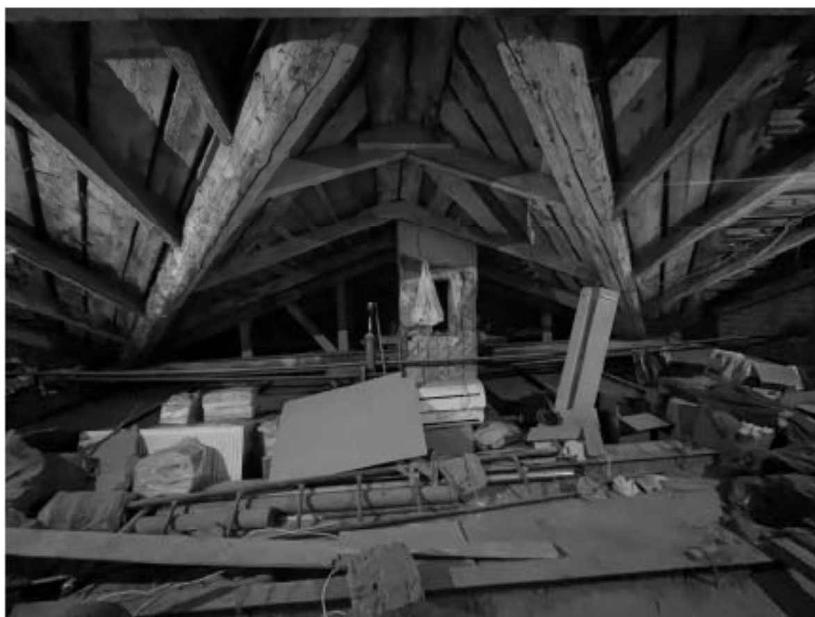
Фото №43. 5 этаж, чердак.
