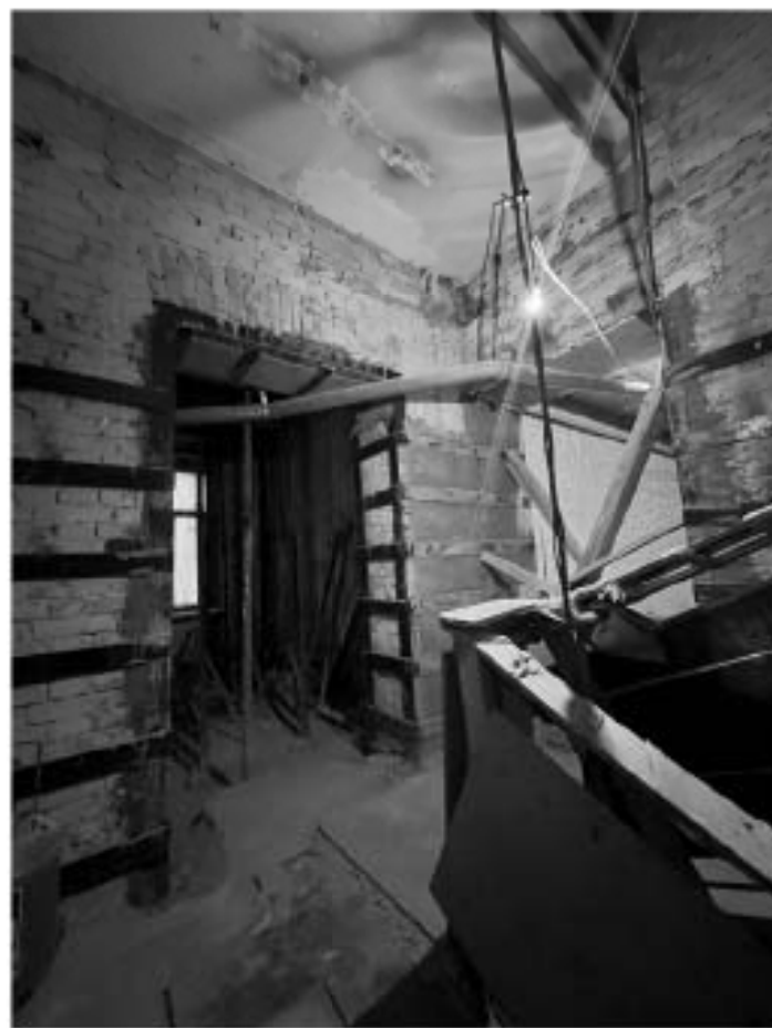
Фото №34. Помещение 3-Н, 4 этаж.
