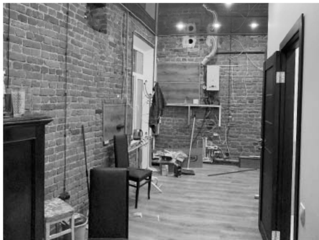
Фото №13. Квартира №25, 4 этаж, комната 1.
