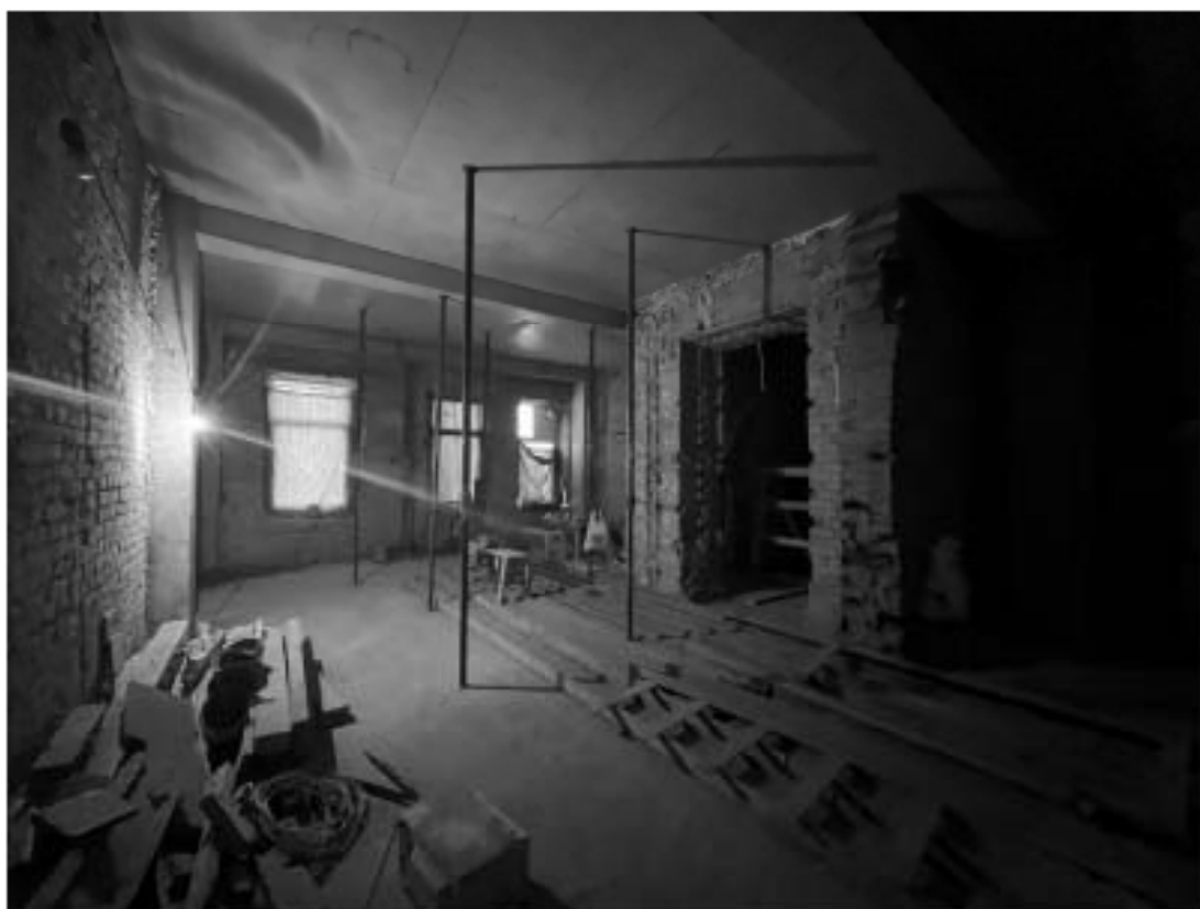
Фото №19. Помещение 3-Н, 2 этаж.
