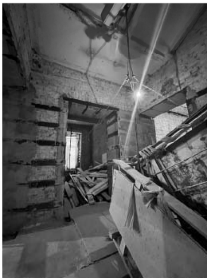
Фото №28. Помещение 3-Н, 3 этаж.
