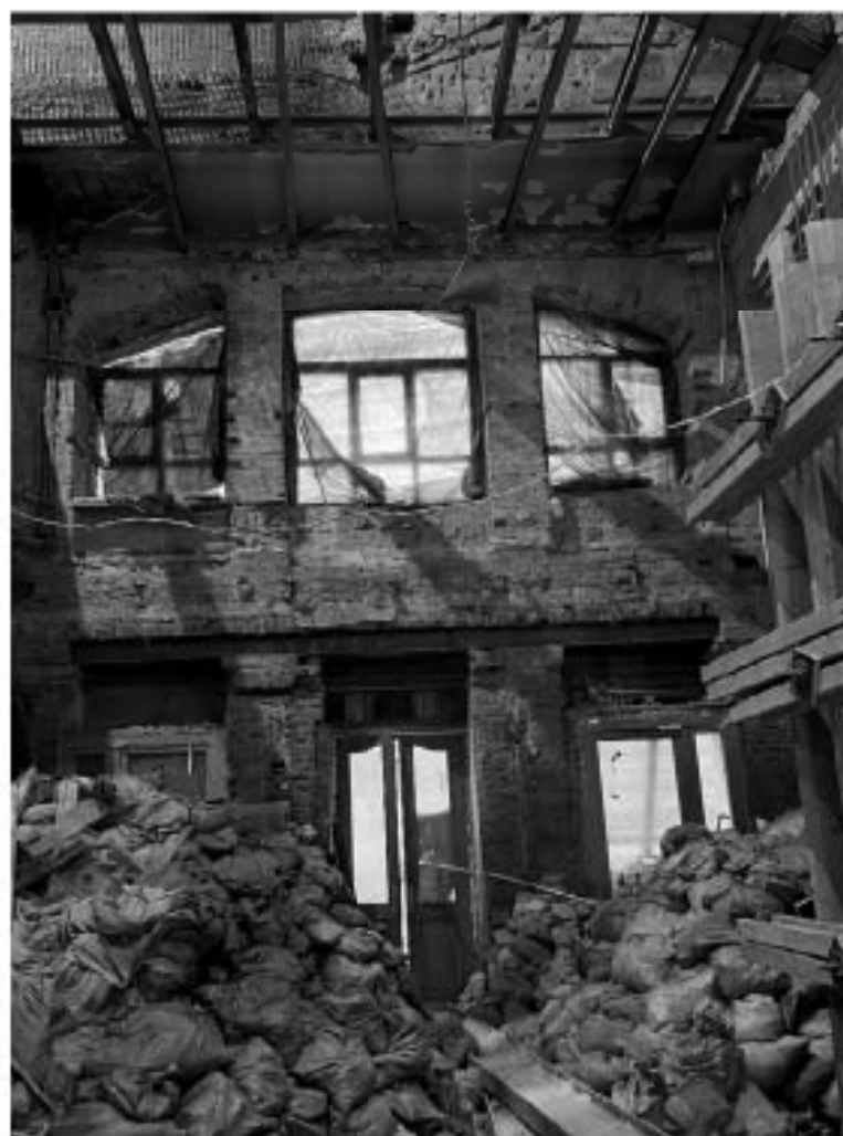
Фото №10. Помещение 3-Н, 1 этаж.
