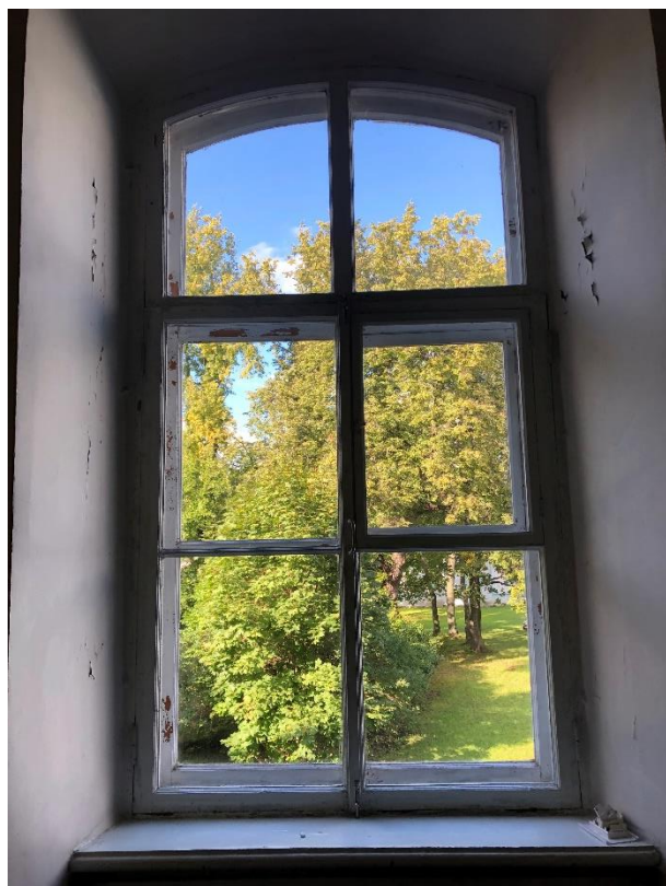
Фото 8. Заполнение оконного проема в аудитории.
