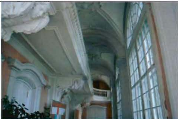
24. (Фрагмент интерьера северо-западного корпуса)
