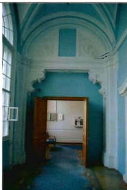
10. (Фрагмент интерьера юго-западного корпуса)
