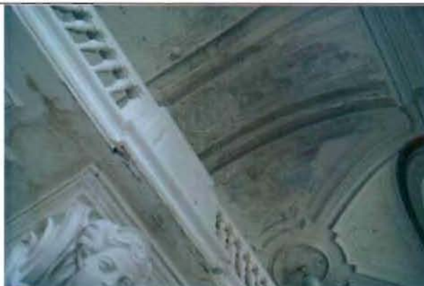
25. (Фрагмент интерьера северо-западного корпуса)
