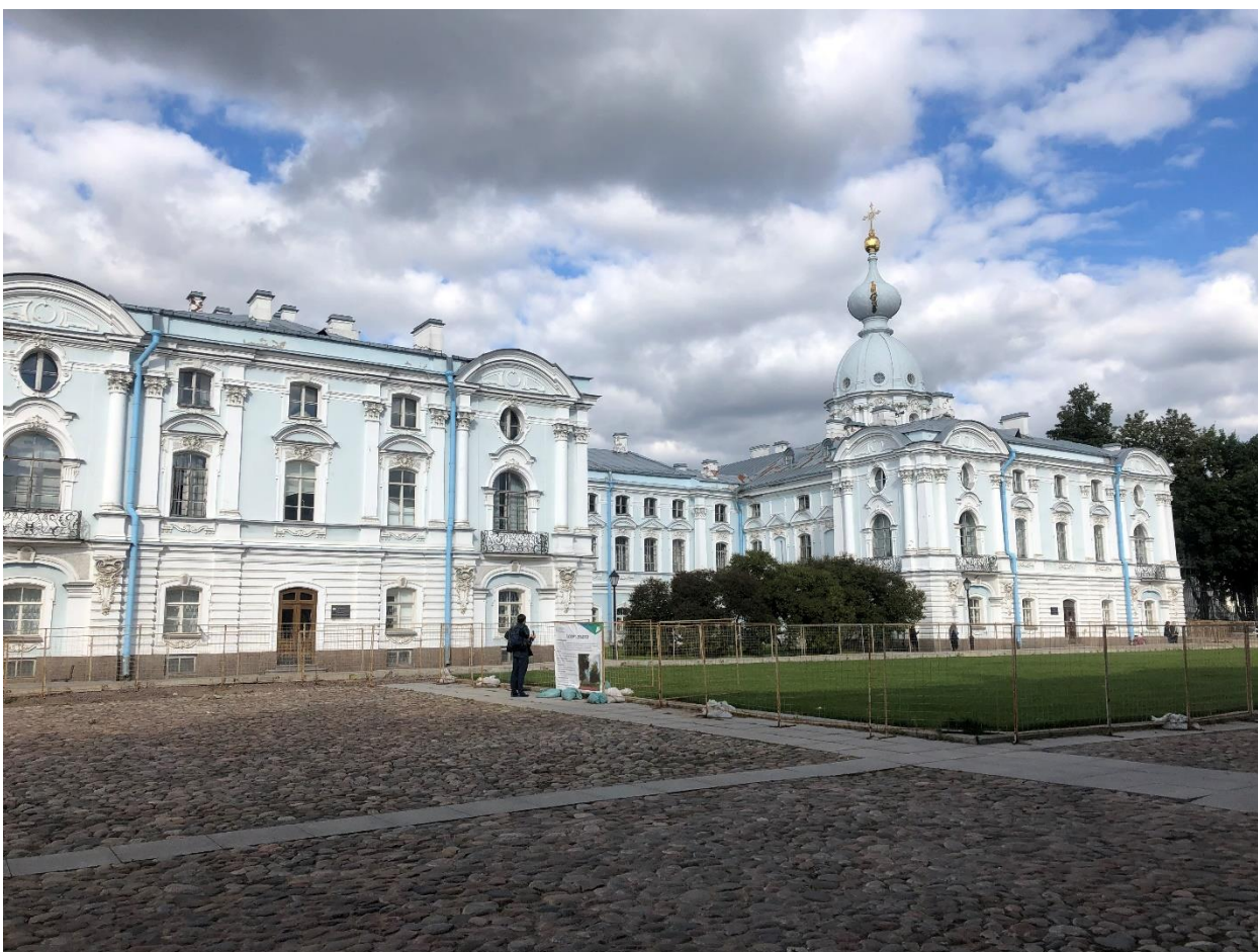
Фото 2. Вид на северные корпуса (первое каре), подъезд № 9.
