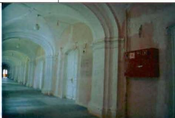
30. (Фрагмент интерьера северо-западного корпуса)
