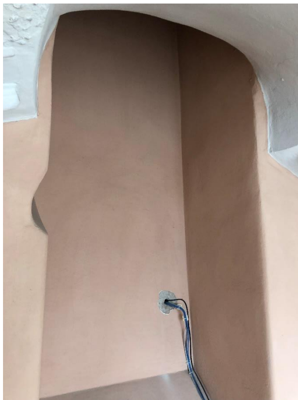
Фото 7. Ниша в уровне балкона восточной части коридора.
