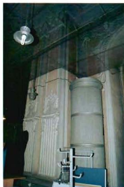
21. (Фрагмент интерьера северного корпуса)
