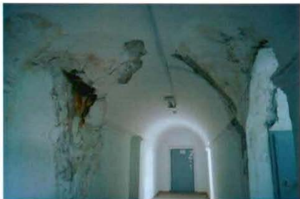
17. (Фрагмент интерьера северного корпуса)
