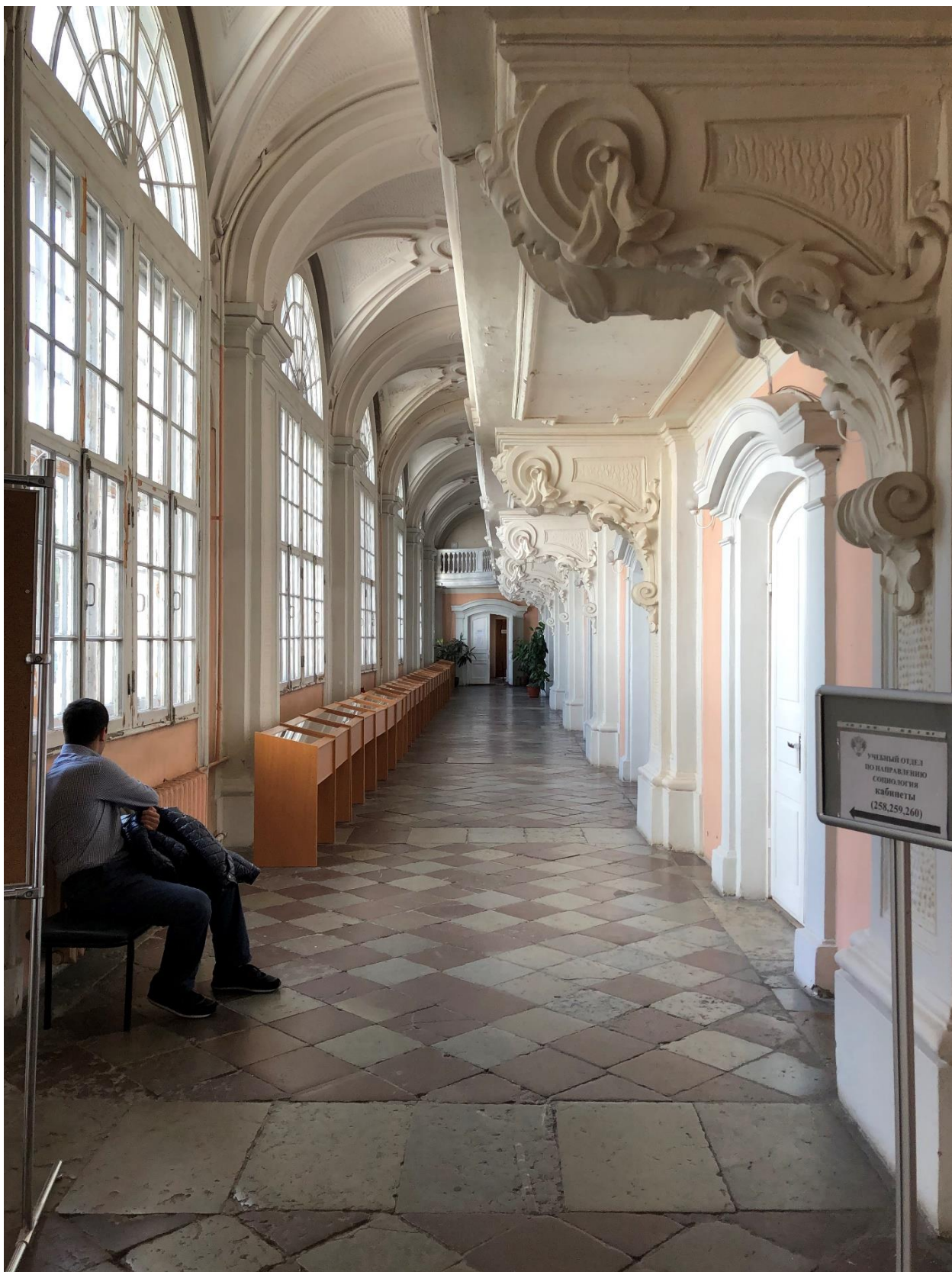
Фото 1. Вид на южную часть коридора.
