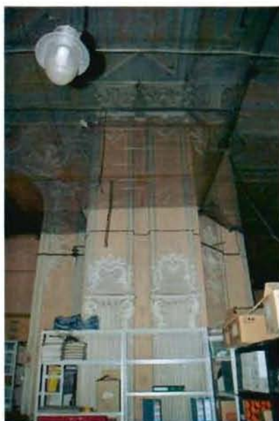
20. (Фрагмент интерьера северного корпуса)
