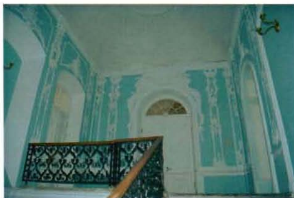
23. (Фрагмент интерьера северного корпуса)
