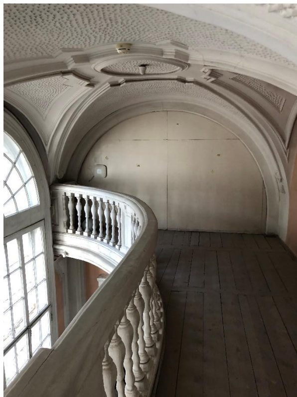
Фото 10. Вид на балкон в южной части коридора.
