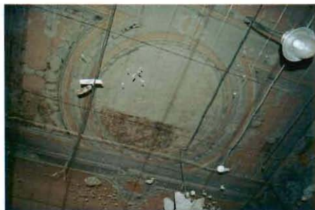
22. (Фрагмент интерьера северного корпуса)
