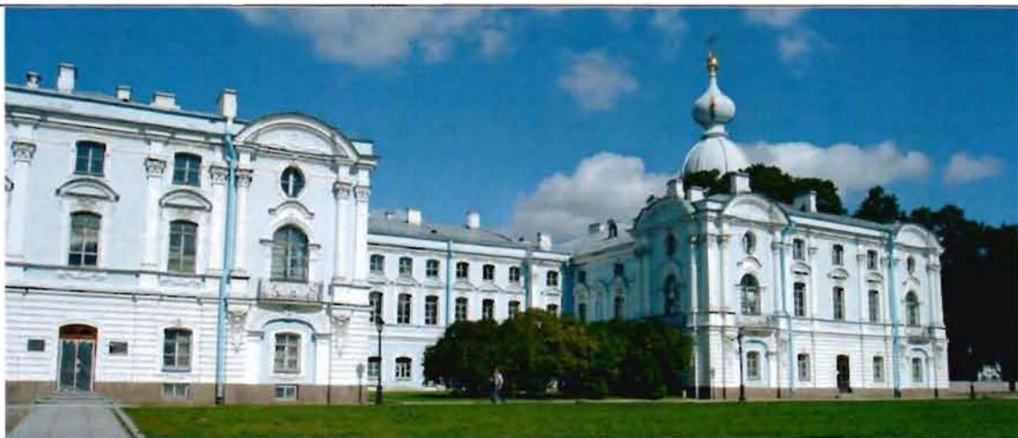
1. (Южный фасад северо-западного корпуса)
