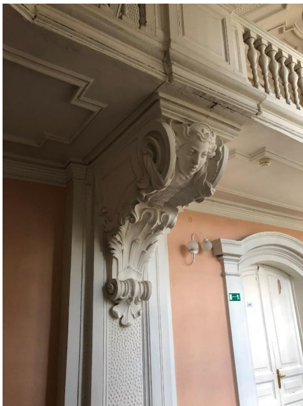
Фото 2. Вид на один из кронштейнов, поддерживающих балкон (галерею).
