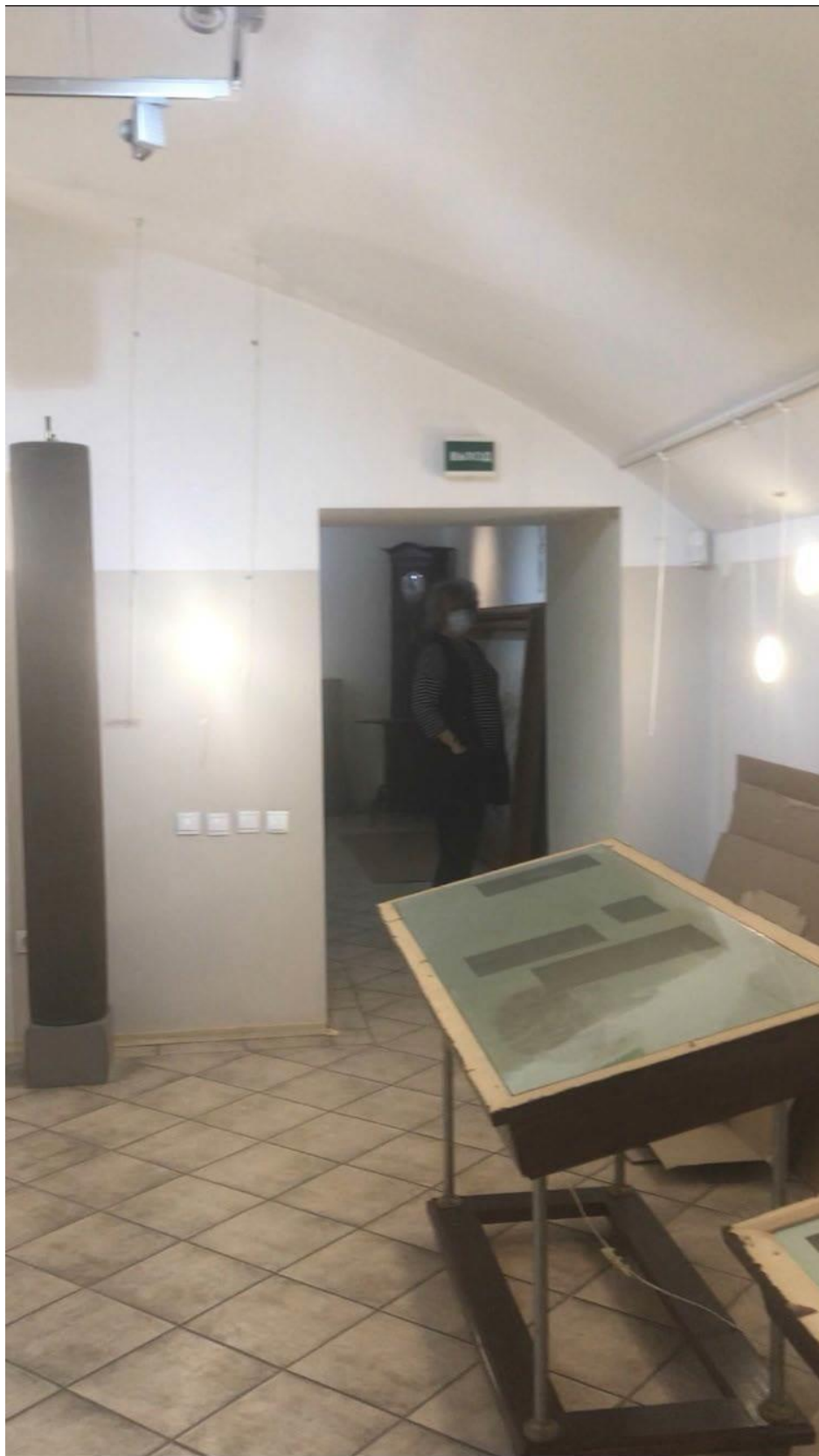
8. Экспедиция заготовления государственных бумаг. Заводоуправление и служебный корпус. Интерьер помещений в границах проектирования. Штиглиц М.С. 28.02.2022.
