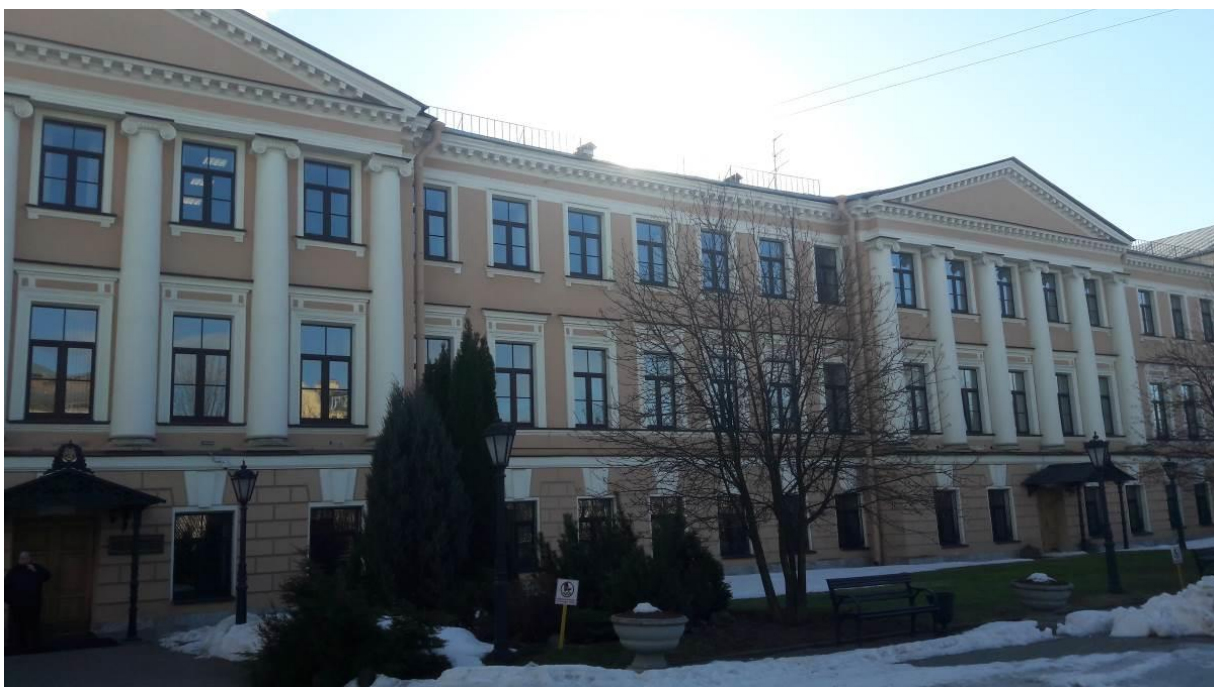
20. Экспедиция заготовки государственных бумаг. Заводоуправление и служебный корпус. Фрагмент лицевого фасада. Штиглиц М.С. 28.02.2022.
