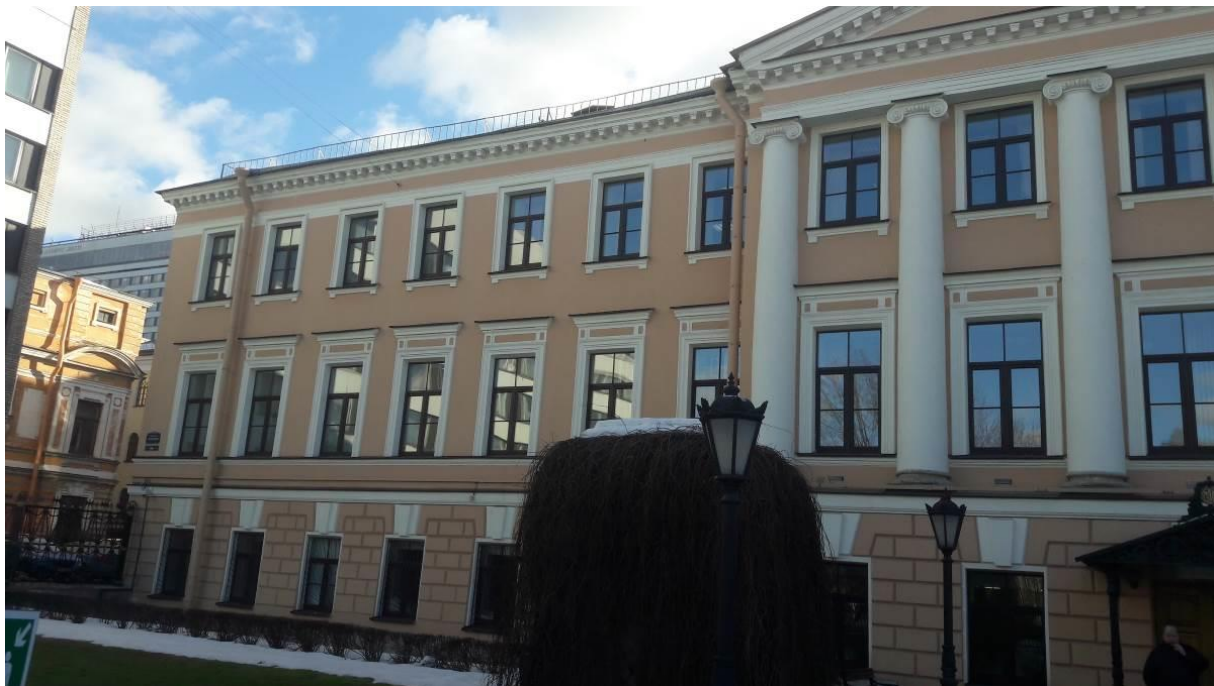
19. Экспедиция заготовки государственных бумаг. Заводоуправление и служебный корпус. Фрагмент лицевого фасада. Штиглиц М.С. 28.02.2022.
