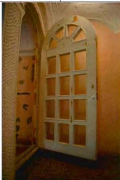
27. (Фрагмент интерьера северо-западного корпуса)
