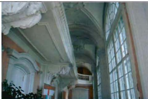
24. (Фрагмент интерьера северо-западного корпуса)
