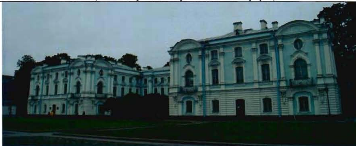
2. (Северный фасад юго-западного корпуса)
