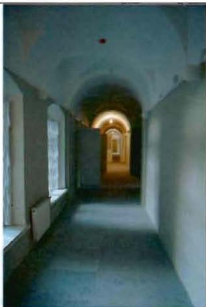
26. (Фрагмент интерьера северо-западного корпуса)
