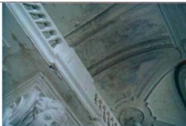
25. (Фрагмент интерьера северо-западного корпуса)
