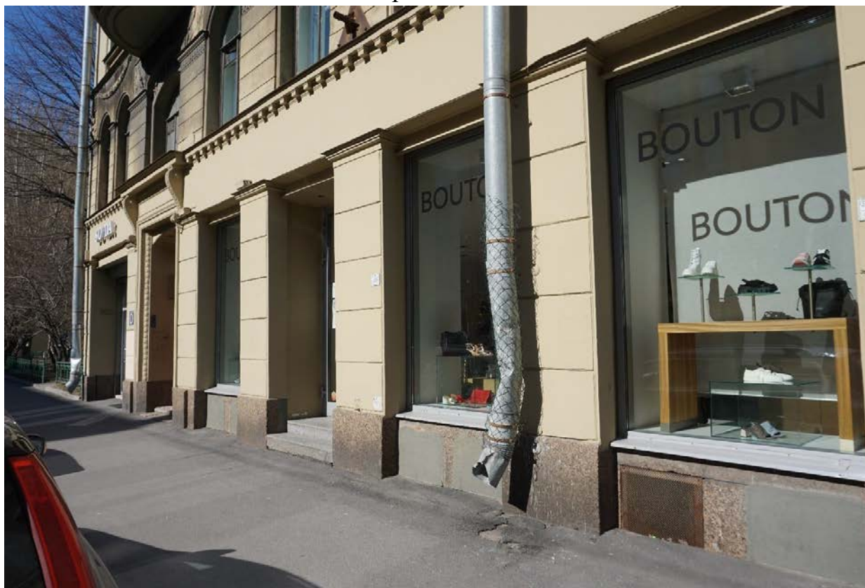
4. Фрагмент первого этажа
