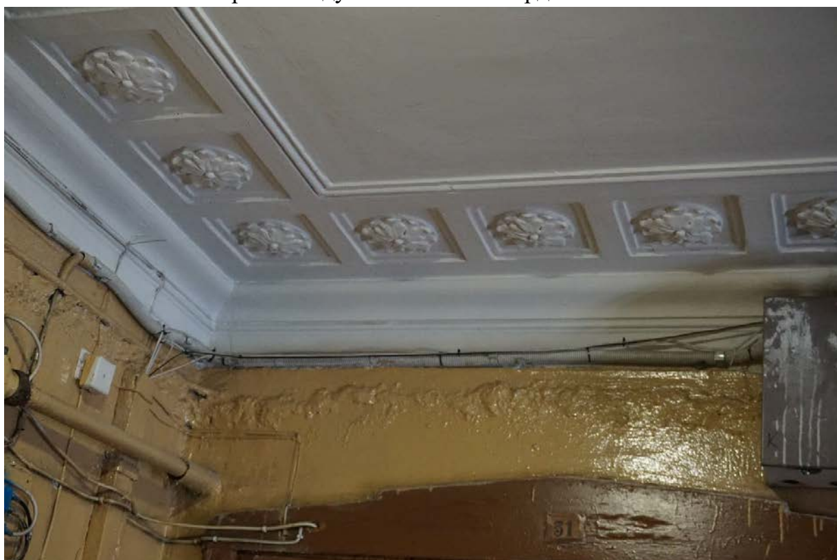
65. Фрагмент декора перекрытия левой парадной лестницы
