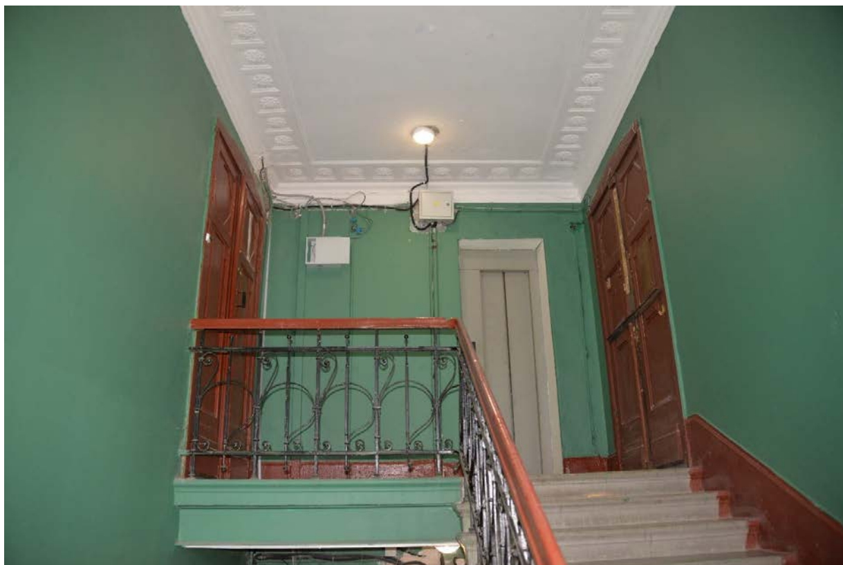
98. Правая парадная лестница в уровне мансардного этажа
