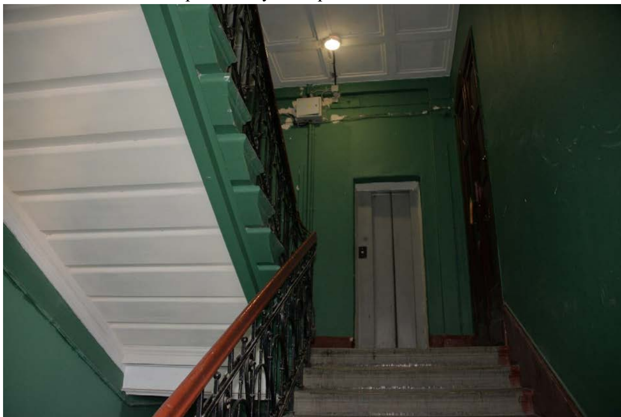
93. Правая парадная лестница в уровне пятого этажа
