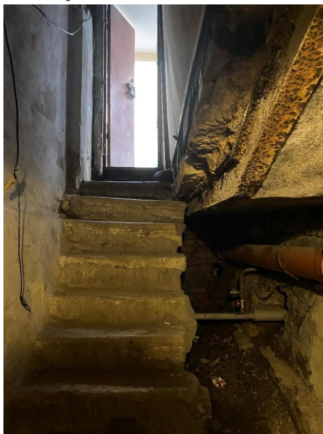
25. Лестница в подвал
