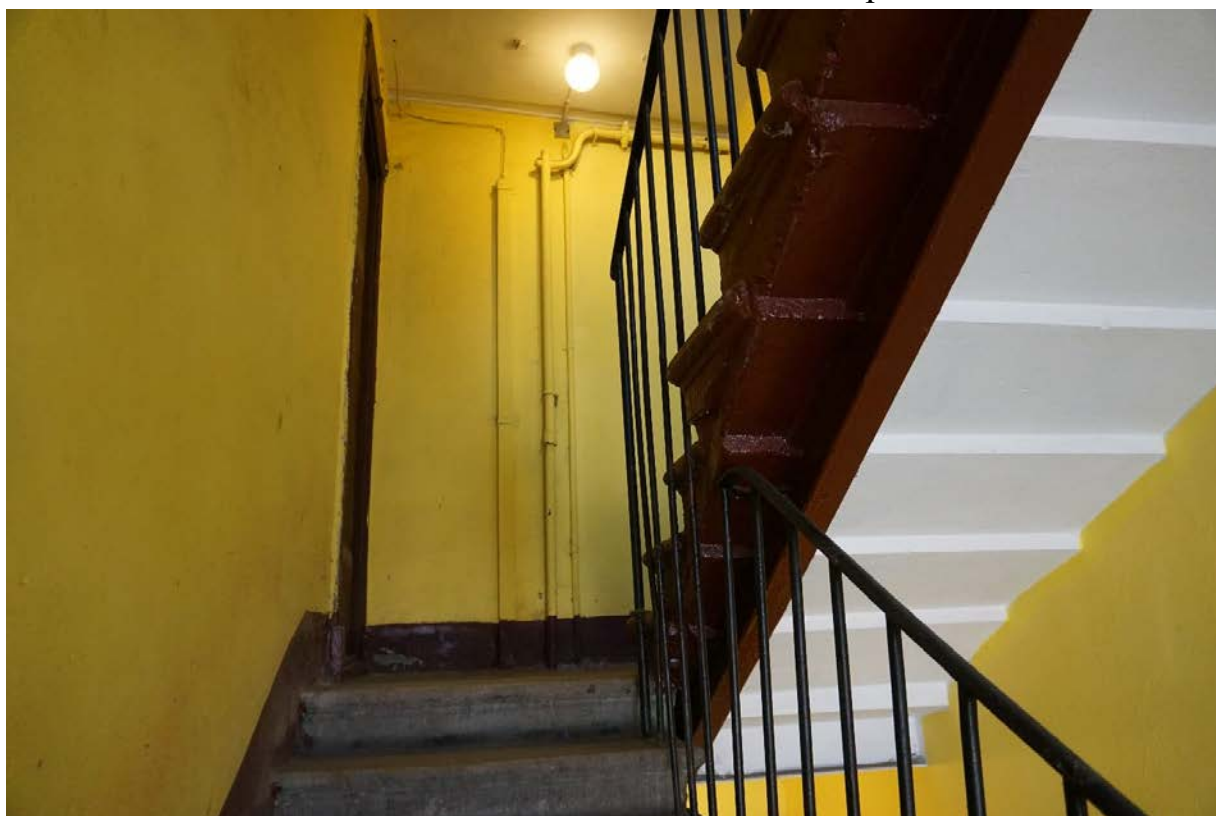
40. Дворовая лестница в уровне мансардного этажа
