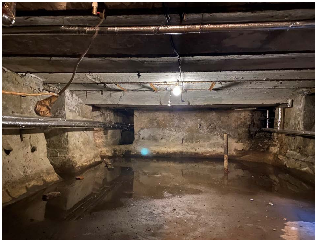
24. Фрагмент части помещения подвала
