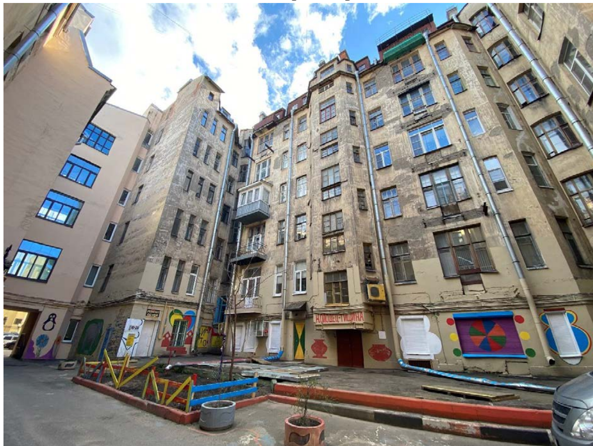
19.Фрагмент дворового фасада
