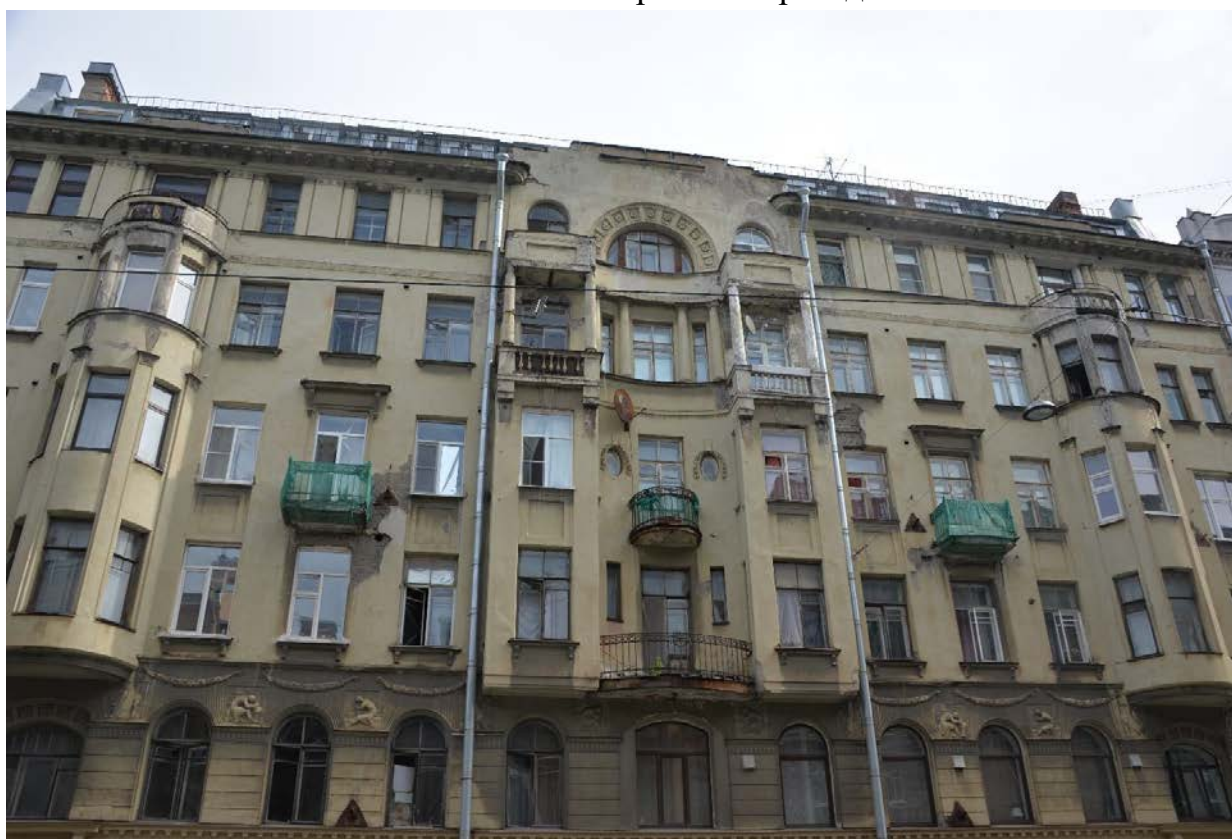
6. Фрагмент лицевого фасада
