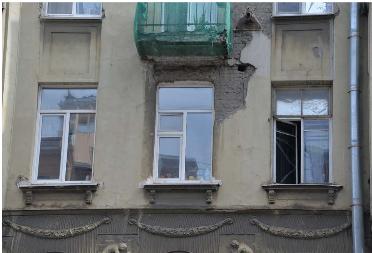
11. Фрагмент лицевого фасада в уровне третьего этажа
