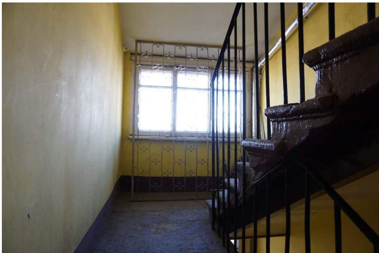
41. Дворовая лестница в уровне мансардного этажа
