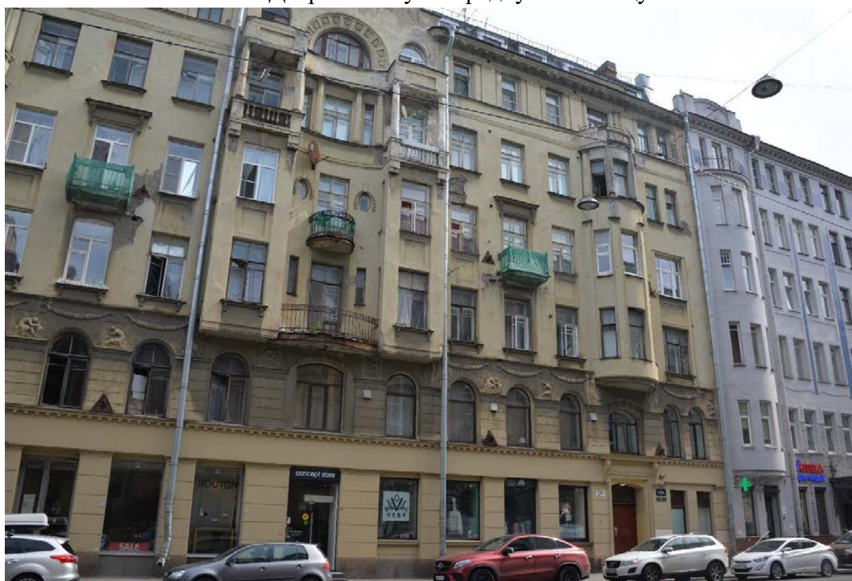
16. Фрагмент лицевого фасада
