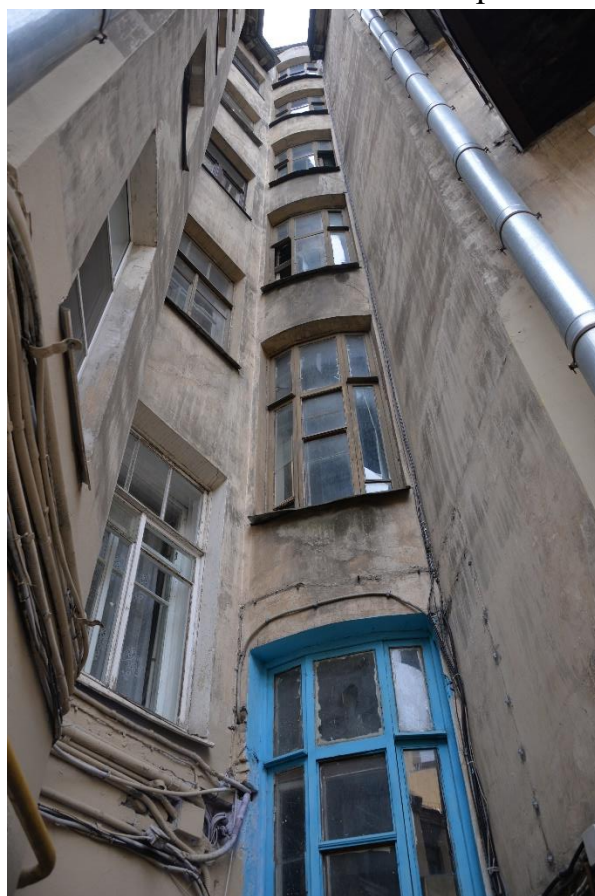
21. Фрагмент дворового фасада с лестничной клеткой
