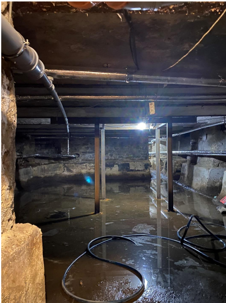
23.Фрагмент части помещения подвала
