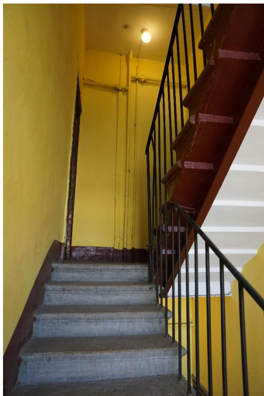
38. Дворовая лестница в уровне шестого этажа
