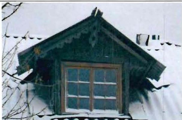
5. Фрагмент Юго-Западного фасада
