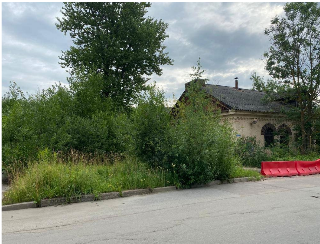
4. Вид на юго-западную часть фасада здания;
