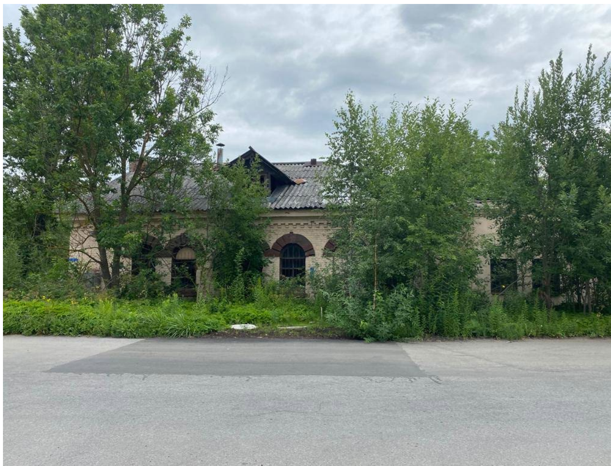
6. Вид на юго-западную часть фасада здания;
