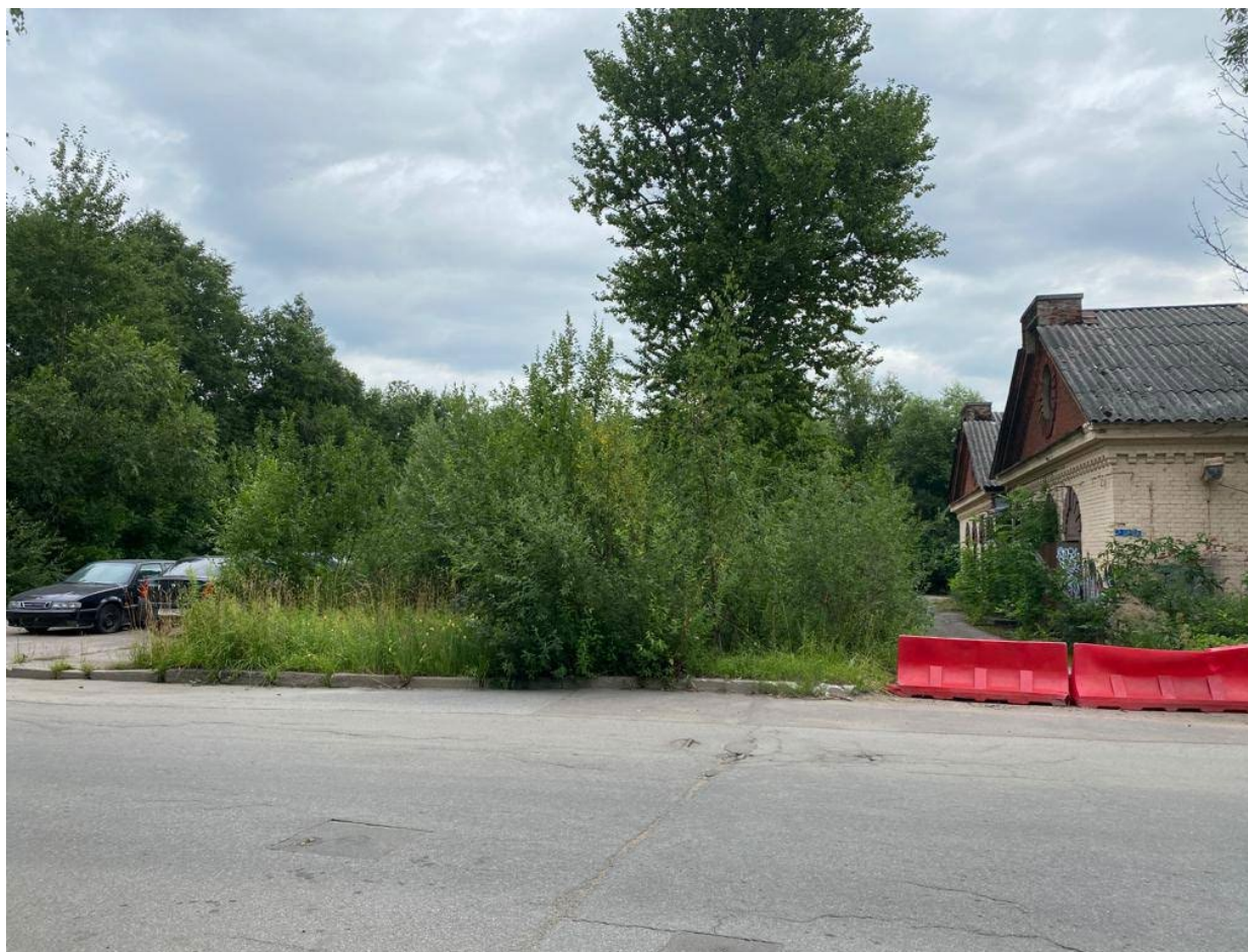
5. Вид на юго-западную часть фасада здания;
