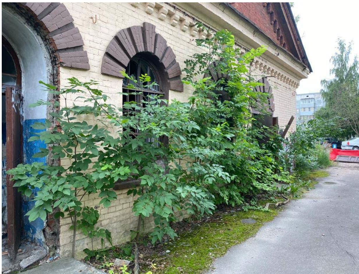
12. Вид на северо-западную часть фасада здания;
