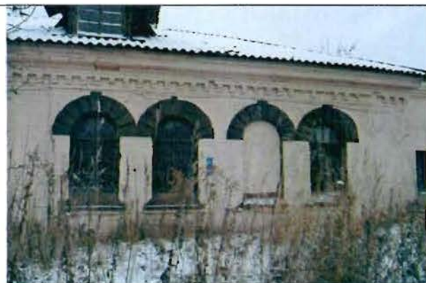
6. Фрагмент Юго-Западного фасада
