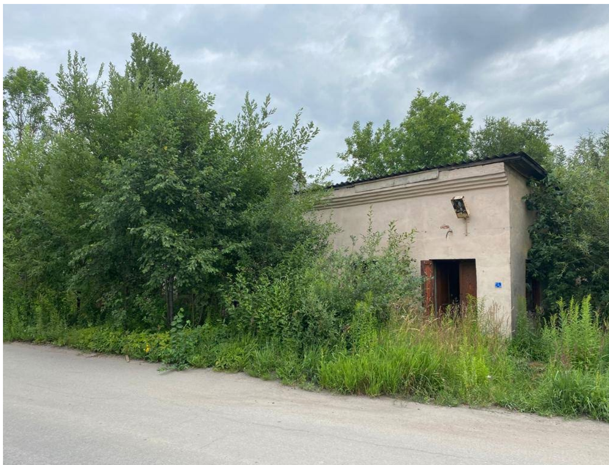
7. Вид на юго-западный фасад здания и вход в помещение;
