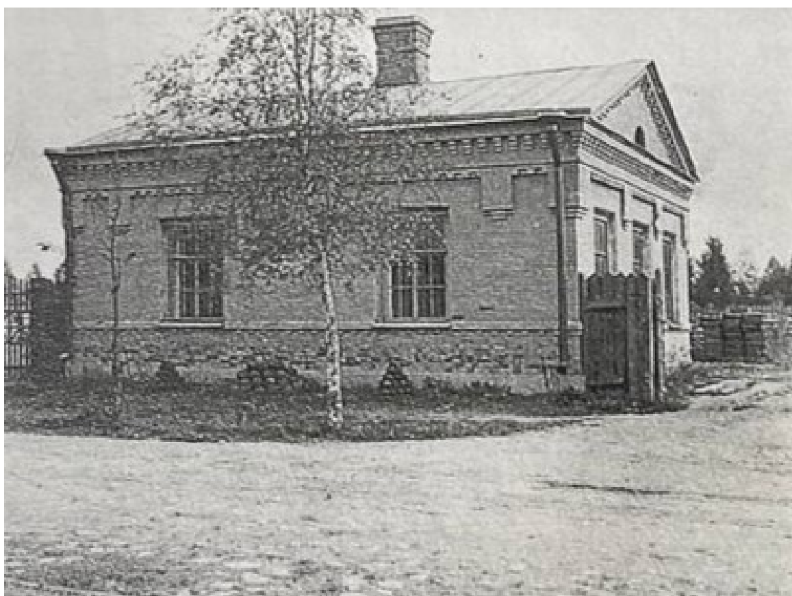
22. Лабораторное здание. Нач. 20 в. Музей Ржевского полигона.
