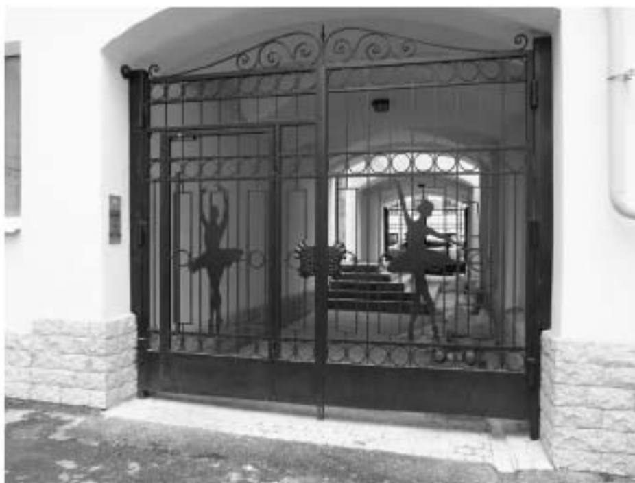
Фото 4. Земельный участок с кадастровым номером 78:31:0001707:17, расположенный по адресу: Санкт-Петербург, Лиговский проспект, дом 141, литера Б. Двор дома. Общий вид с востока.
