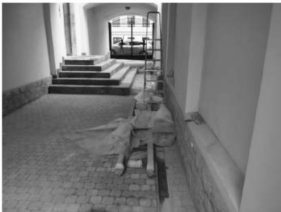
Фото 5. Земельный участок с кадастровым номером 78:31:0001707:17, расположенный по адресу: Санкт-Петербург, Лиговский проспект, дом 141, литера Б. Двор дома. Общий вид с востока.
