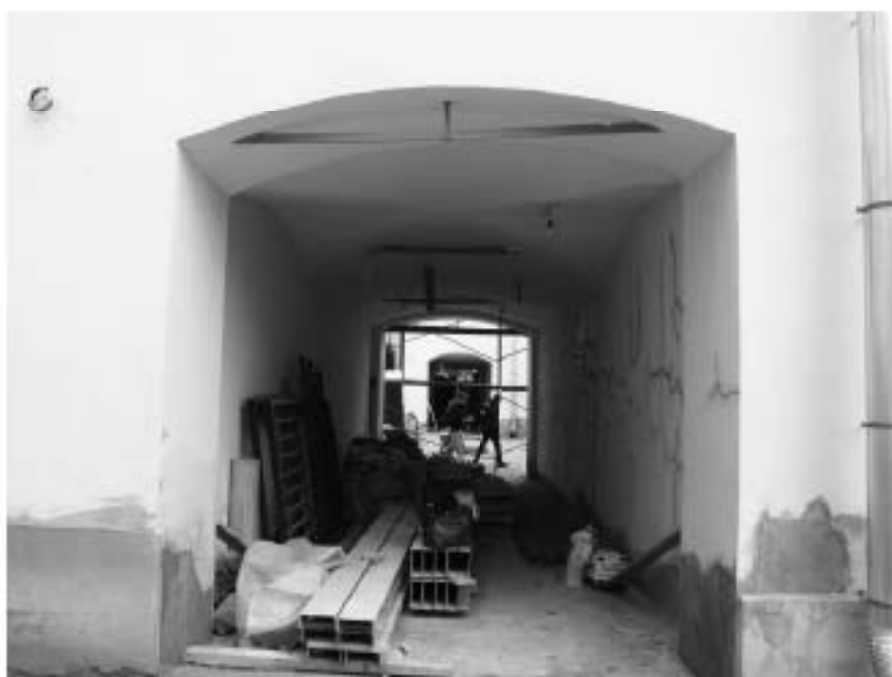
Фото 4. Улица Печатника Григорьева, дом 14, литера А. Вид из второго двора здания на проход в центральный двор (на северо-запад).
