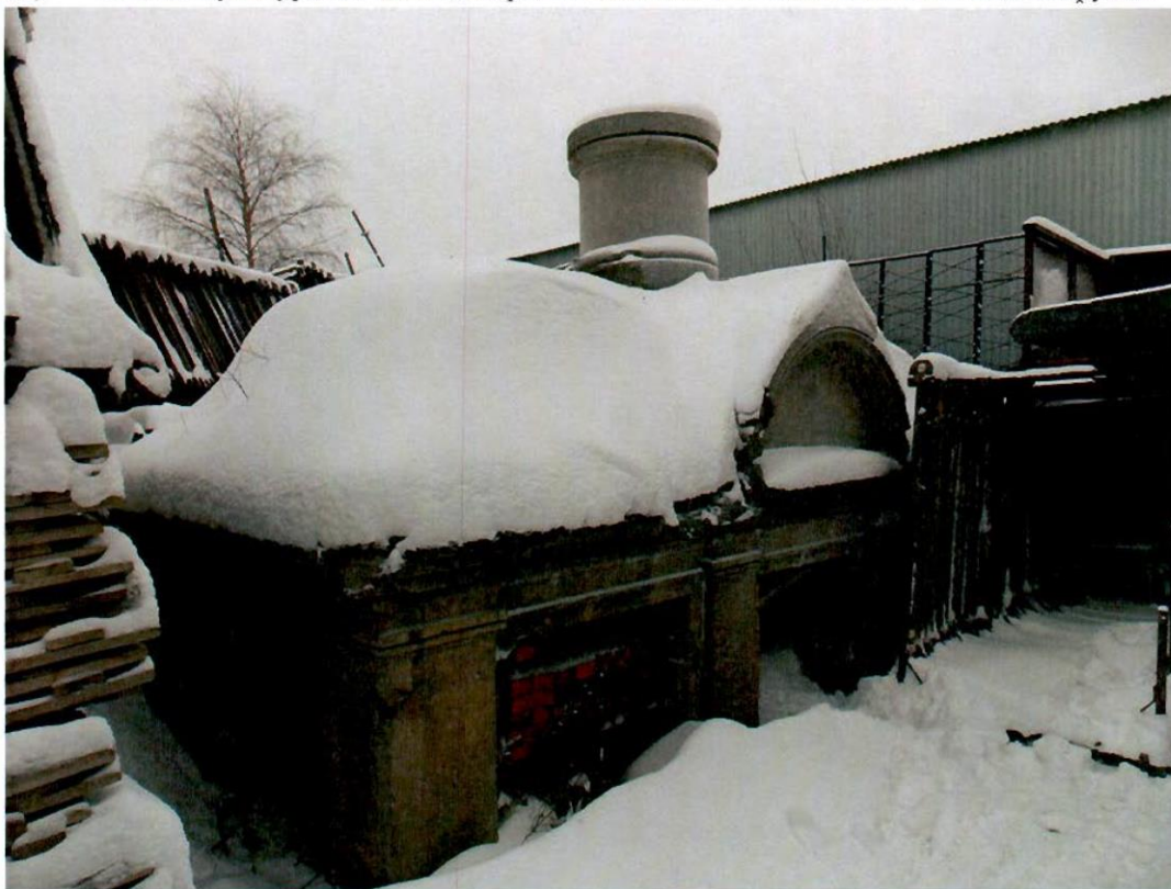
17) Объект культурного наследия регионального значения «Склеп». Вид снаружи.
