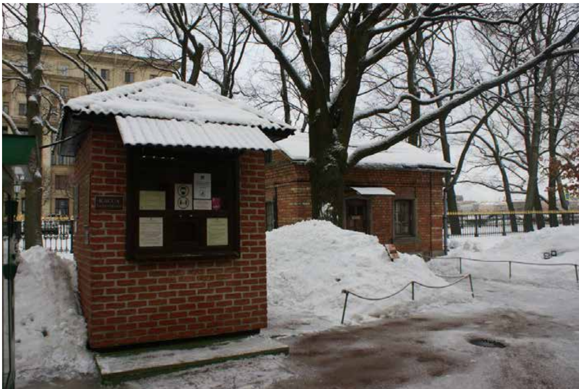
Фото 41. Территория объекта культурного наследия «Домик Петра I». Северо-восточная часть сада. Службное здание и касса. Съемка 24.01.2022 г. Трушковский В.Э.
