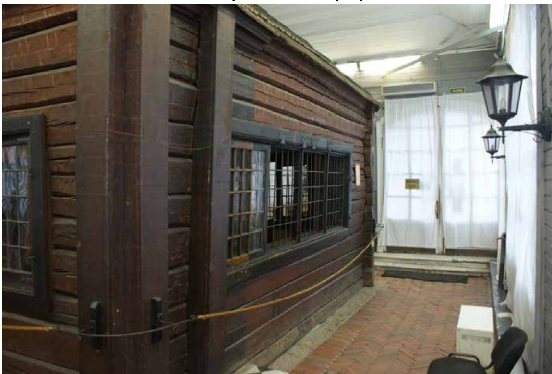
Фото 1. Объект культурного наследия «Футляр домика». Помещение 2/93,7. Съемка 24.01.2022 г. Трушковский В.Э.
