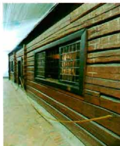
3). Фрагмент восточного лицевого фасада
