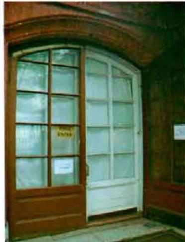
14). Дверной проем северный лицевой фасад
