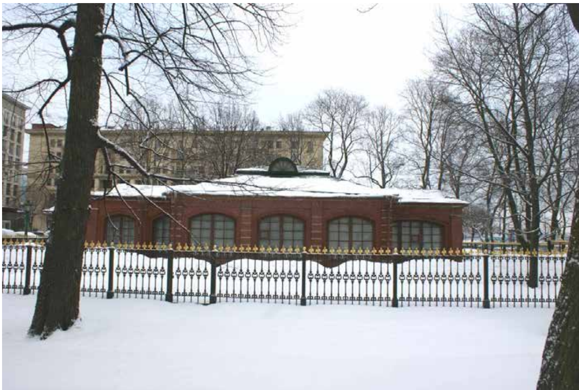
Фото 9. Объект культурного наследия «Футляр домика». Западный фасад. Съемка 24.01.2022 г. Трушковский В.Э.
