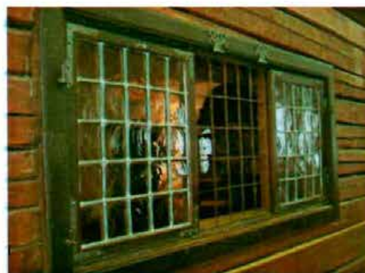
4). Фрагмент западного лицевого фасада
