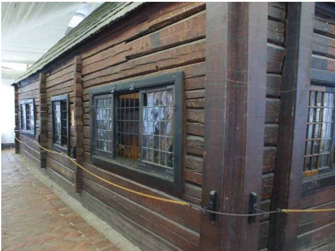
Фото 20. Объект культурного наследия «Футляр домика». Помещение 2/93,7. Юго-восточный фасад «Домика Петра I». Съемка 24.01.2022 г. Трушковский В.Э.
