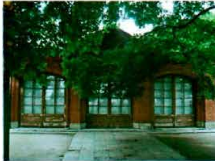
12) Южный дворовый фасад
