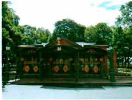
10). Северный лицевой фасад
