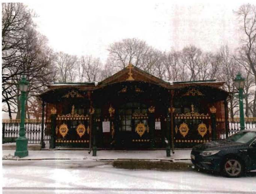
1. Вид на объект культурного наследия с северной стороны.
