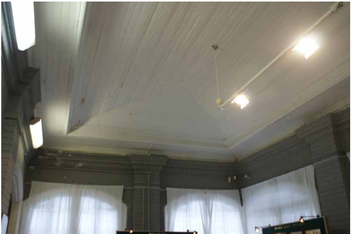
Фото 8. Объект культурного наследия «Футляр домика». Помещение 1/54,1. Съемка 24.01.2022 г. Трушковский В.Э.
