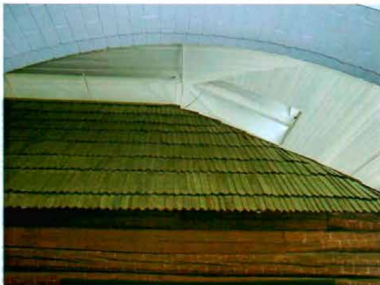
5). Фрагмент кровли домика (колотые сосновые клиновидные дощечки)
