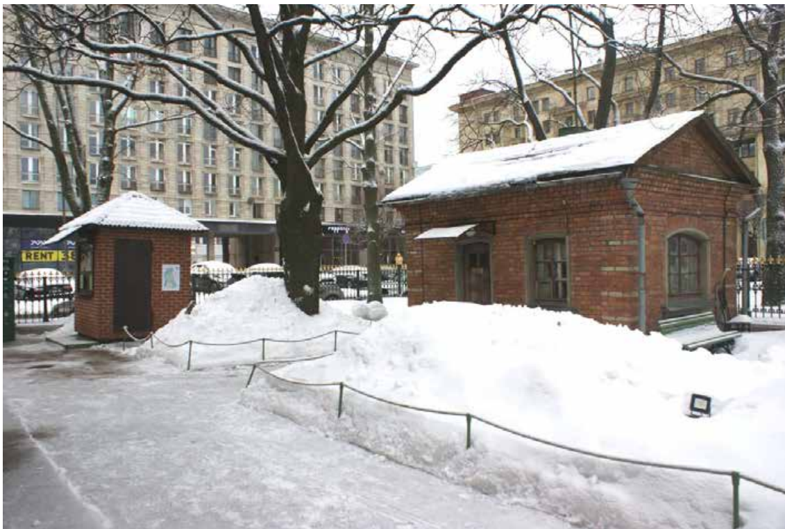
Фото 35. Территория объекта культурного наследия «Домик Петра I». Касса и служебное здание. Северо-восточная сторона сада. Съемка 24.01.2022 г. Трушковский В.Э.
