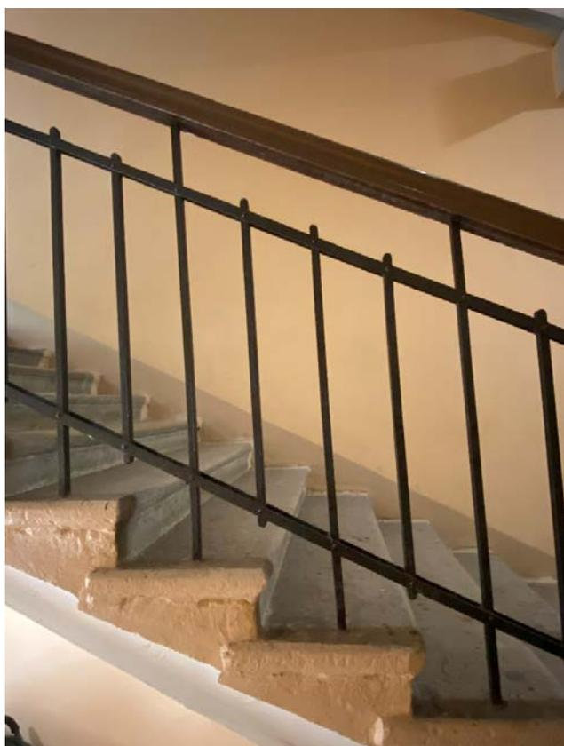
Фото 24. Ограждения маршей в виде вертикальных кованых стержней прямоугольного сечения, соединенных верхней и нижней тетивой; профилированный деревянный поручень.
