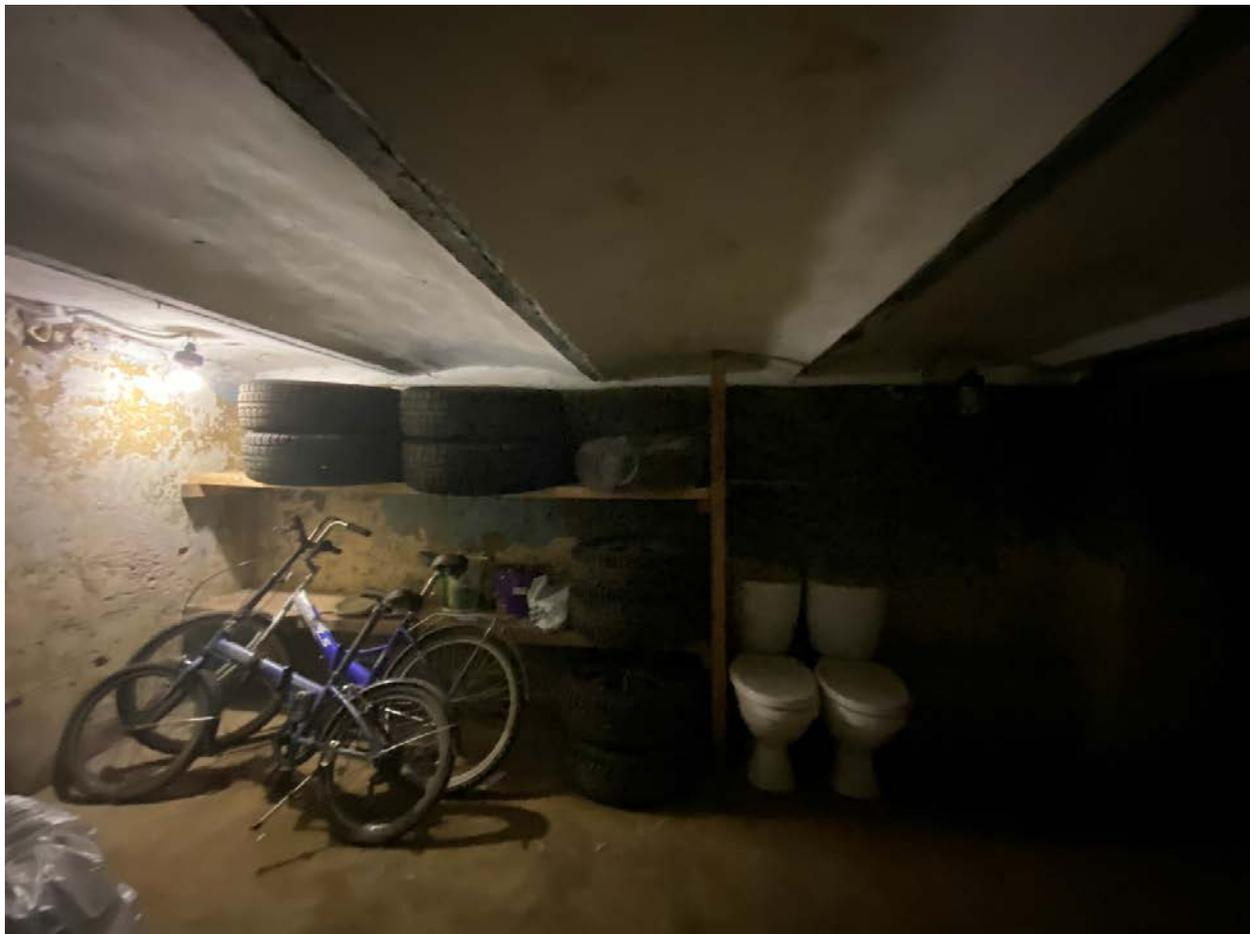
Фото 53. Подвальное помещение. Перекрытия, выполненные в виде прусских сводов по металлическим балкам.
