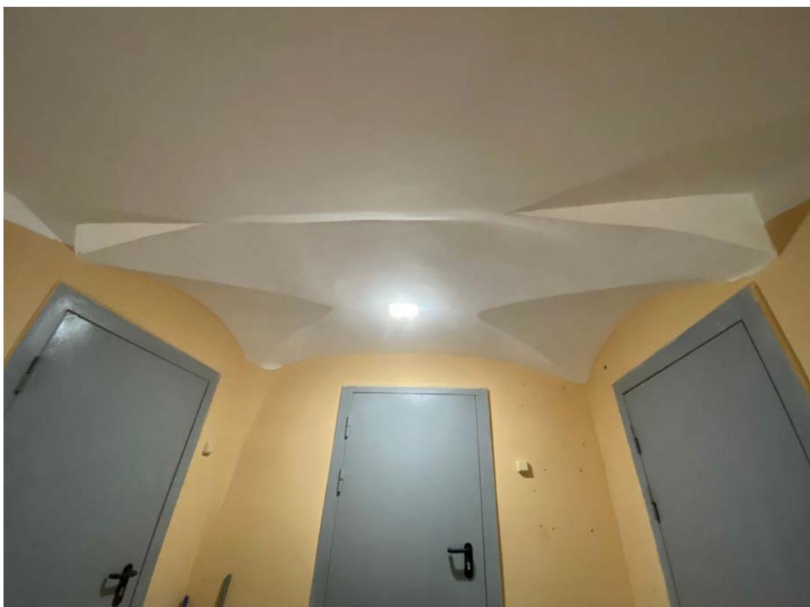
Фото 40. Уп্লощенный цилиндрический свод с распалубками на лестничной клетке в уровне технического этажа.
