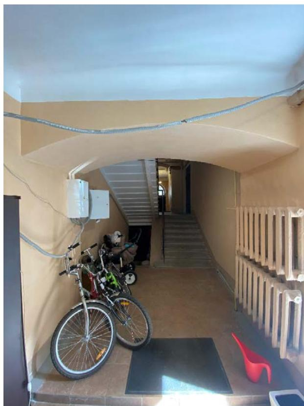
Фото 25. Арки с лучковыми перемычками на межэтажных площадках лестничной клетки.
