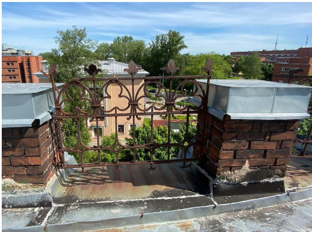
Фото 52. Парапетные тумбы с металлическим покрытием, парапетная кованая решетка ограждения кровли.
