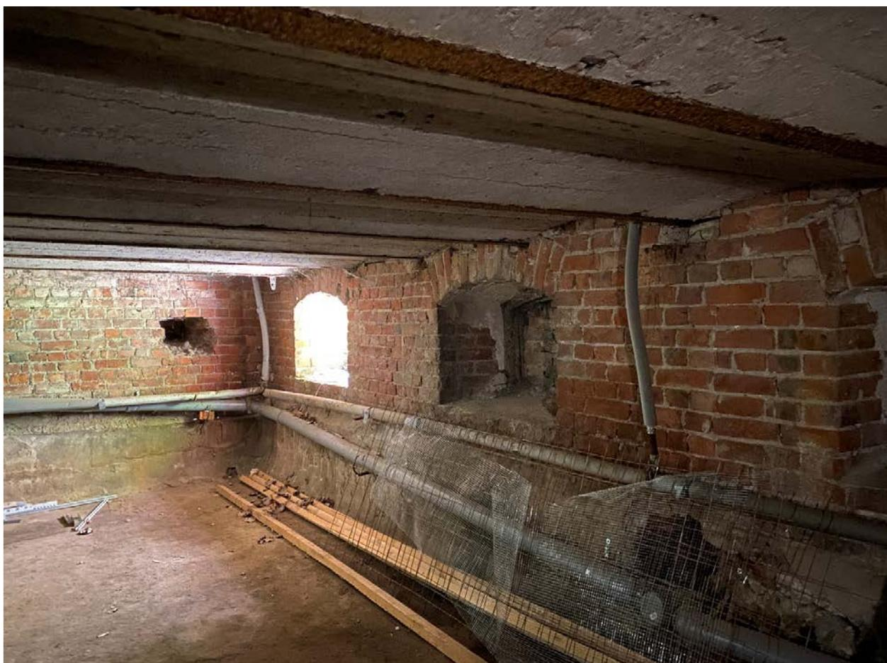
Фото 56. Подвальное помещение. Оконные проемы с лучковым завершением (в настоящее время в большей части заложены кирпичом).
