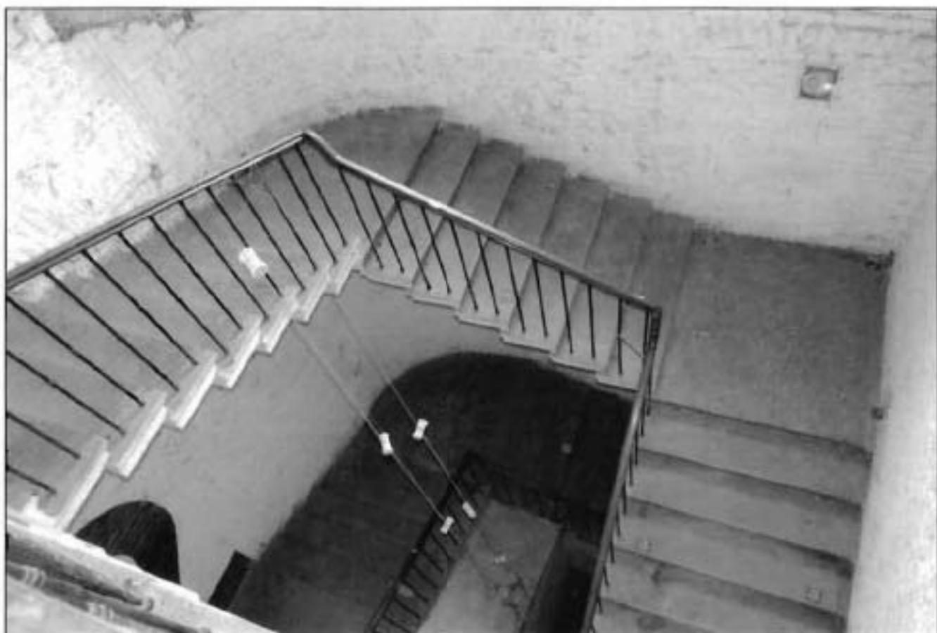
28. Интерьер объекта культурного наследия. Фрагмент. Пом. 3Н(61). Парадная лестница лицевого корпуса (фото от 11.05.2022).
