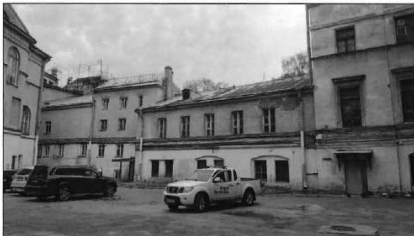
7. Фасады северных церковного и кухонного флигелей объекта культурного наследия (фото от 11.05.2022).
