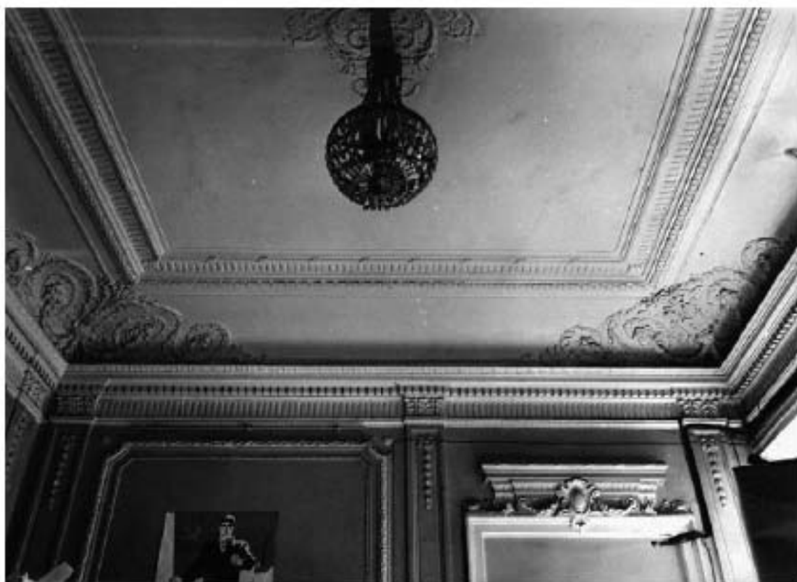
69. Главный корпус. Фрагмент интерьера бол. Приемной. Фото 1978. Архив КГИОП
