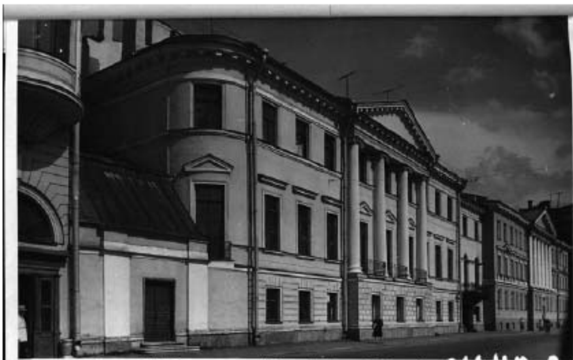
51. Главный (Юго-западный фасад). Фото 1992 г. Архив КГИОП
