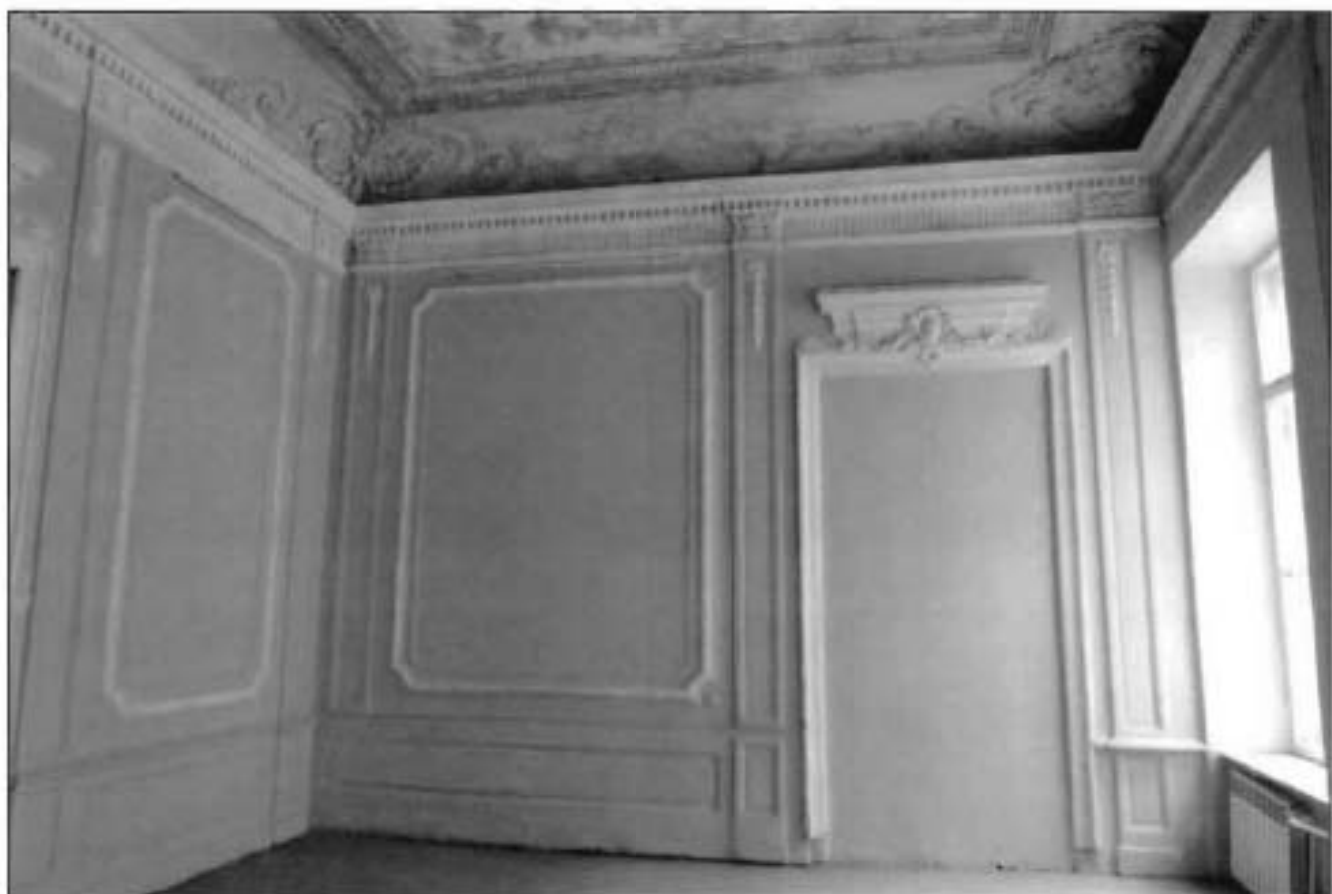
20. Интерьер объекта культурного наследия. Фрагмент. Интерьер объекта культурного наследия. Фрагмент. Пом. 3-Н(54). Лицевой корпус (фото от 11.05.2022).
