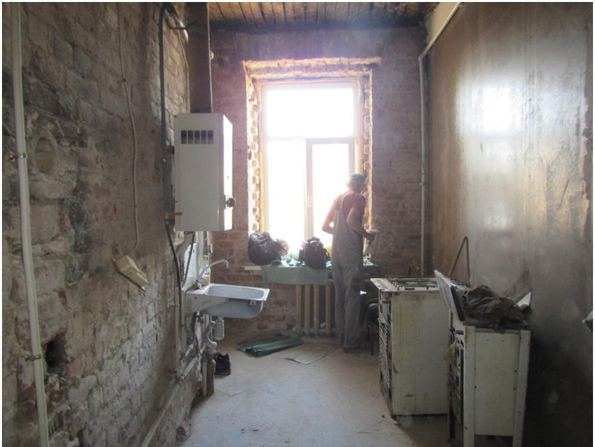
Фото 1. Помещение 9 (кухня). Общий вид от двери.
