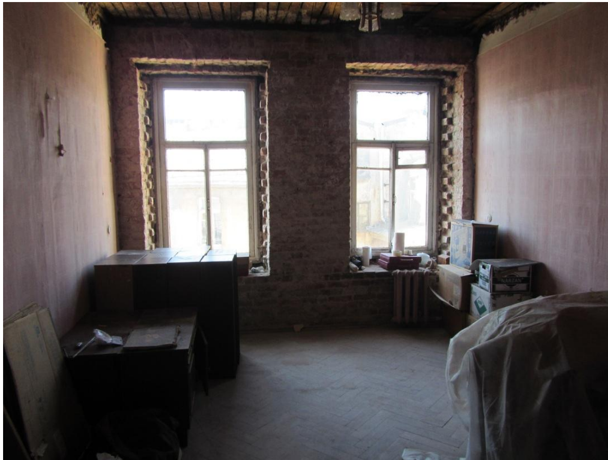
Фото 6. Помещение 5 (комната). Общий вид от двери
