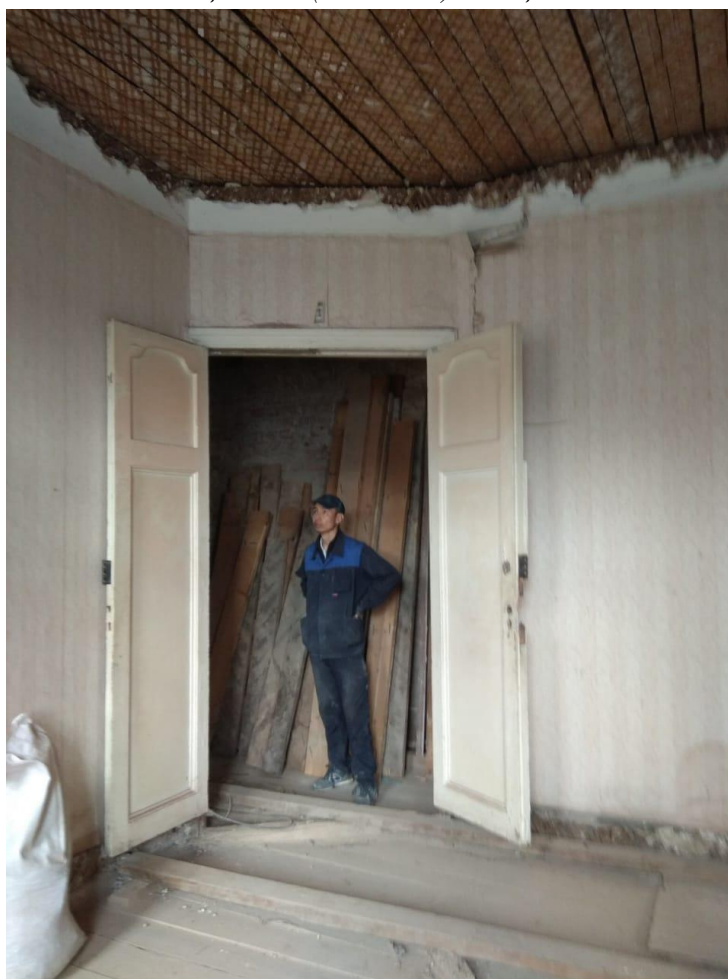
Фото 10. Помещение 3 (комната). Общий вид от окна.
