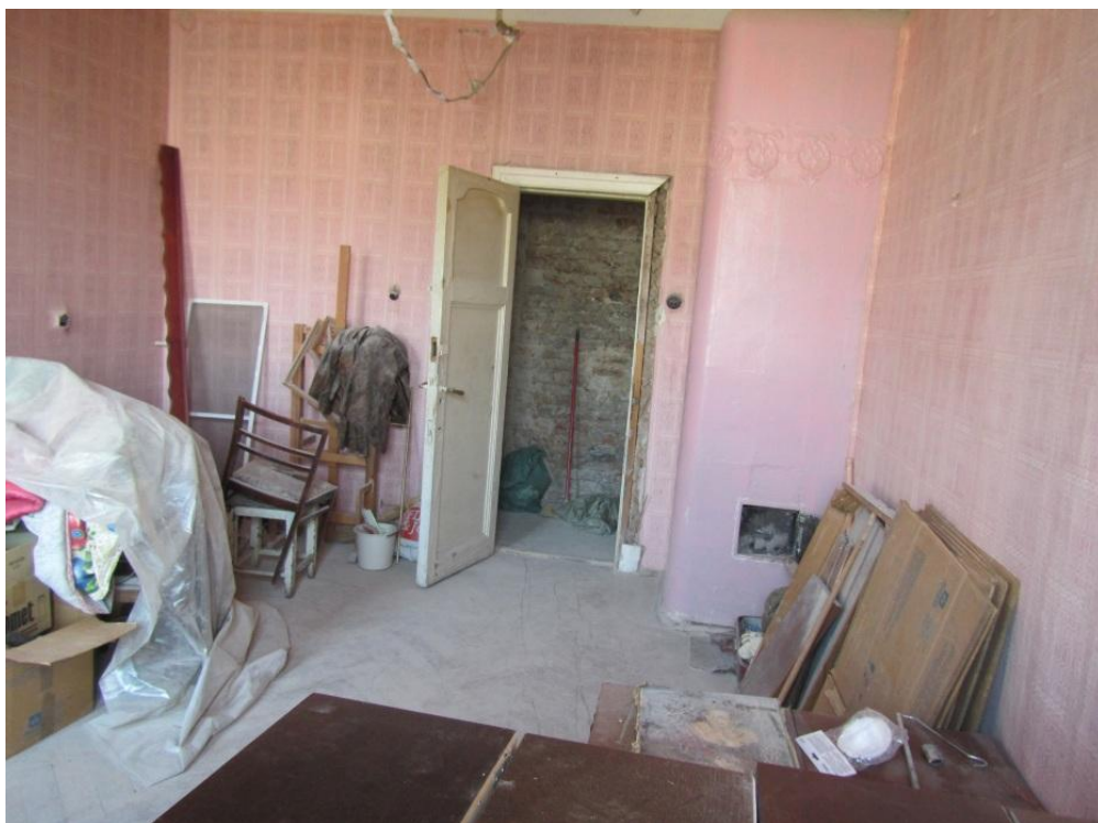
Фото 7. Помещение 5 (комната). Общий вид от окна.
