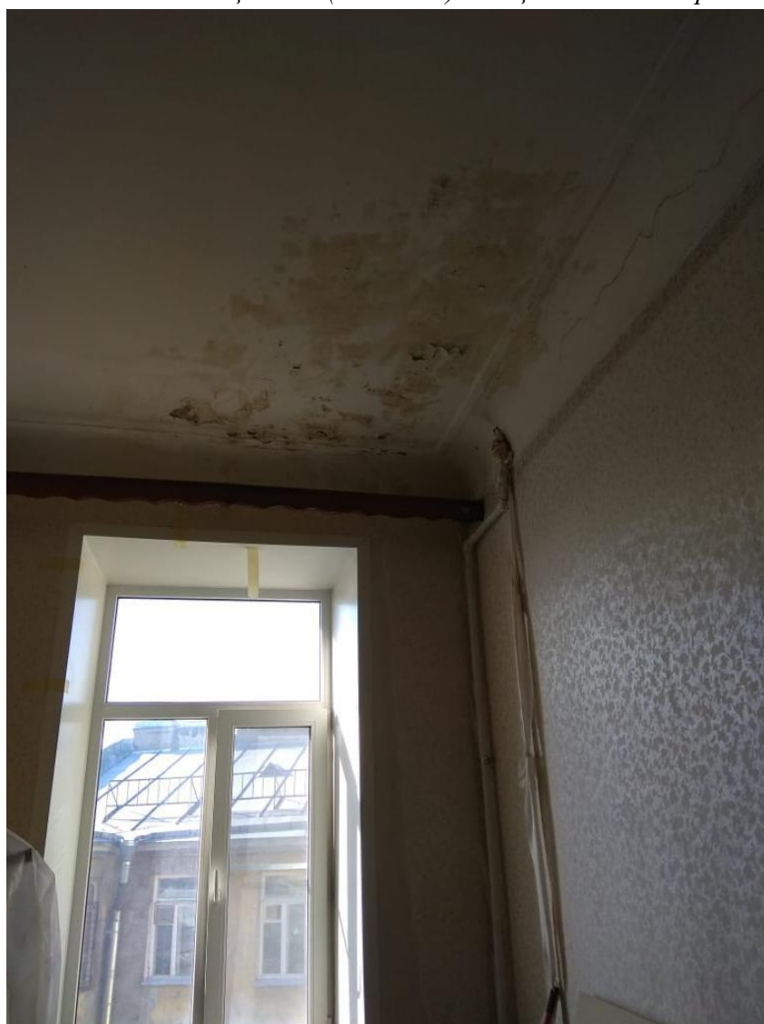
Фото 4. Помещение 6 (комната). Общий вид от двери.
