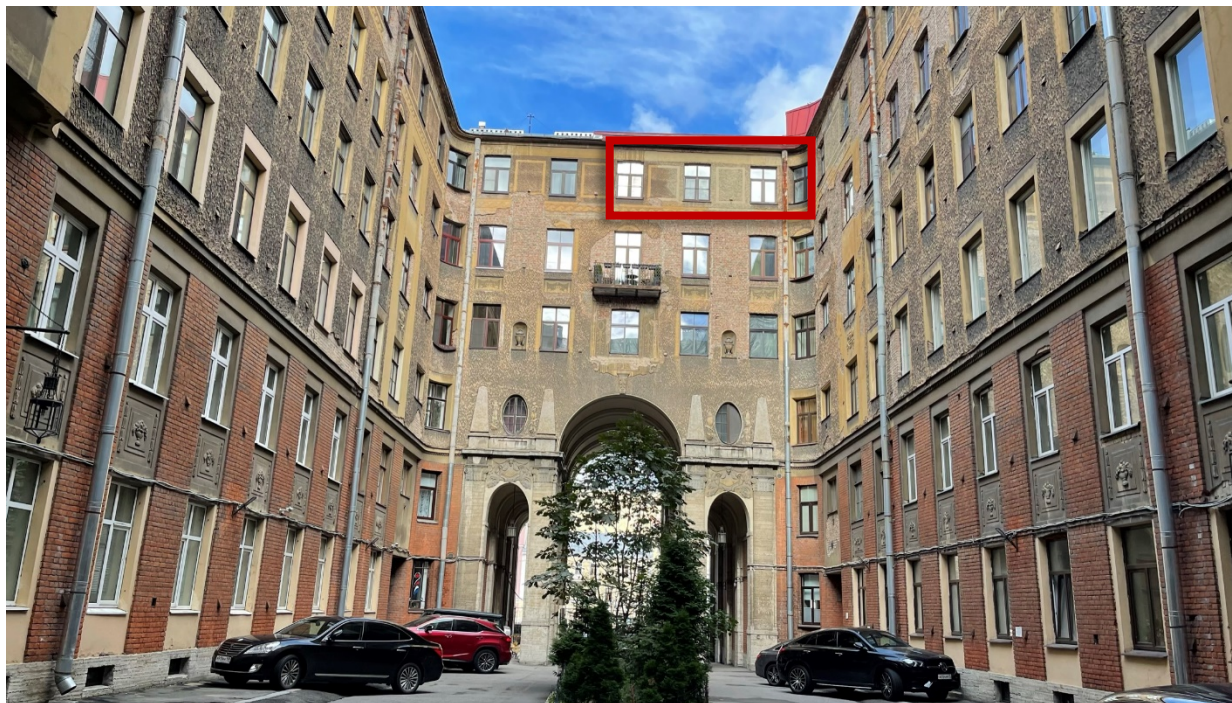
4. Вид на дворовой фасад и окна квартиры №633;
