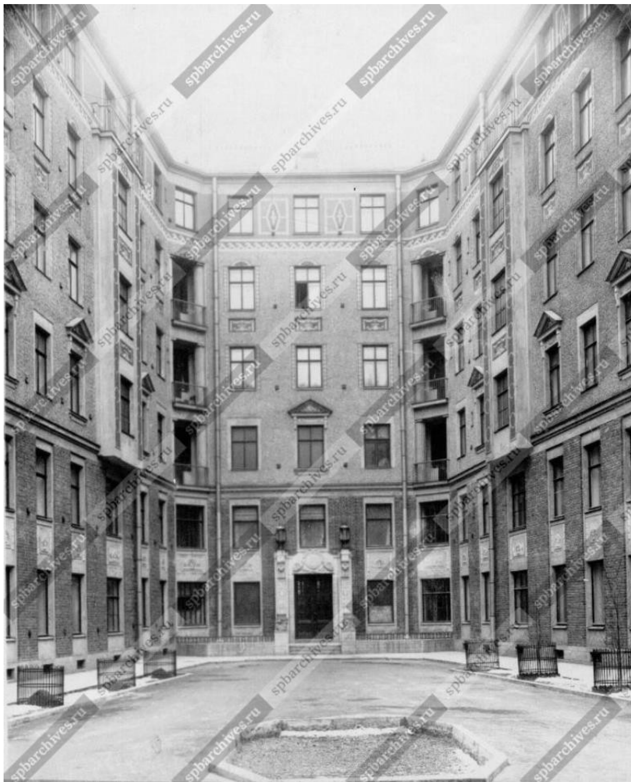
Илл. 49. Внутренний двор дома №15-17 по Троицкой улице – дом М.П. Толстого (архитектор Ф.И. Лидваль, 1910-1912). 1912 г. (источник: ЦГАКФФД СПб. Фотодокумент Е 12718).
