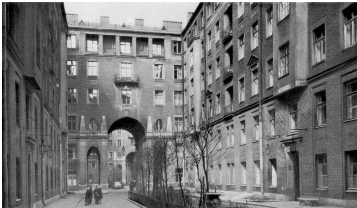
2796. Ф.И. Лидваль. Доходный дом на Фонтанке в Ленинграде. 1910—1912. Внутренний двор
