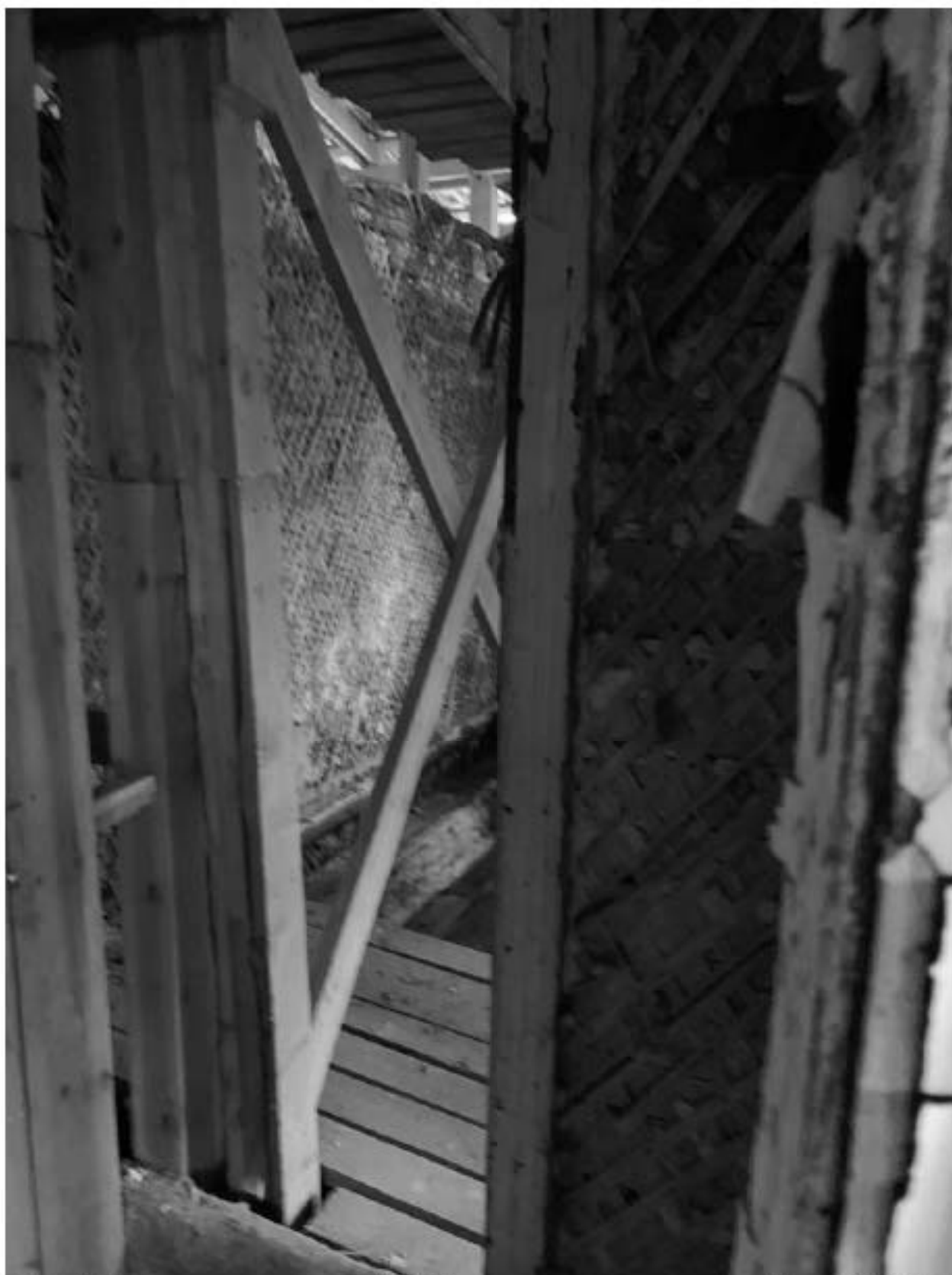
Фото 9. Вид из помещения в осях 4-5;И-Л под защитным сооружением. Фото 1.10.2022 г.
