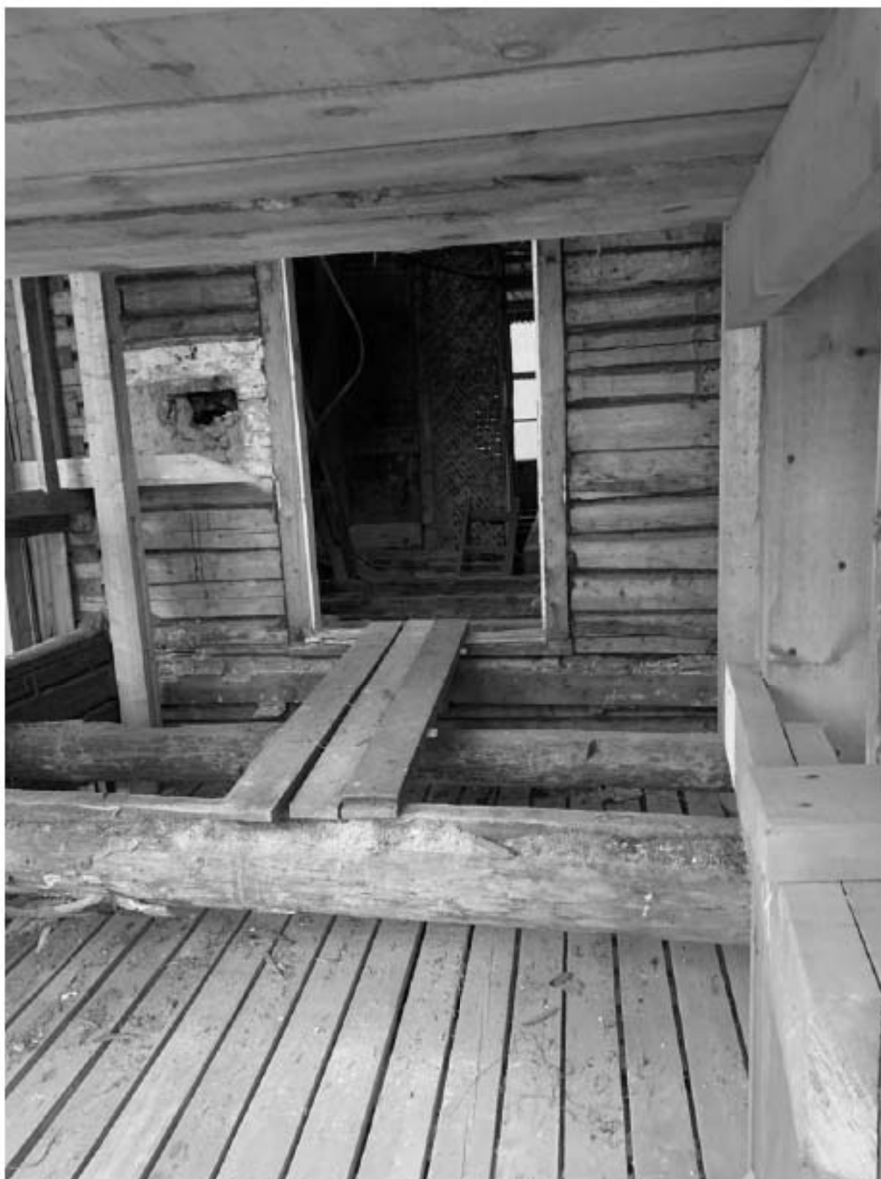
Фото 4. Вид с западной стороны на фрагмент фасада А-Н здания в защитном сооружении. Фото 1.10.2022 г.
