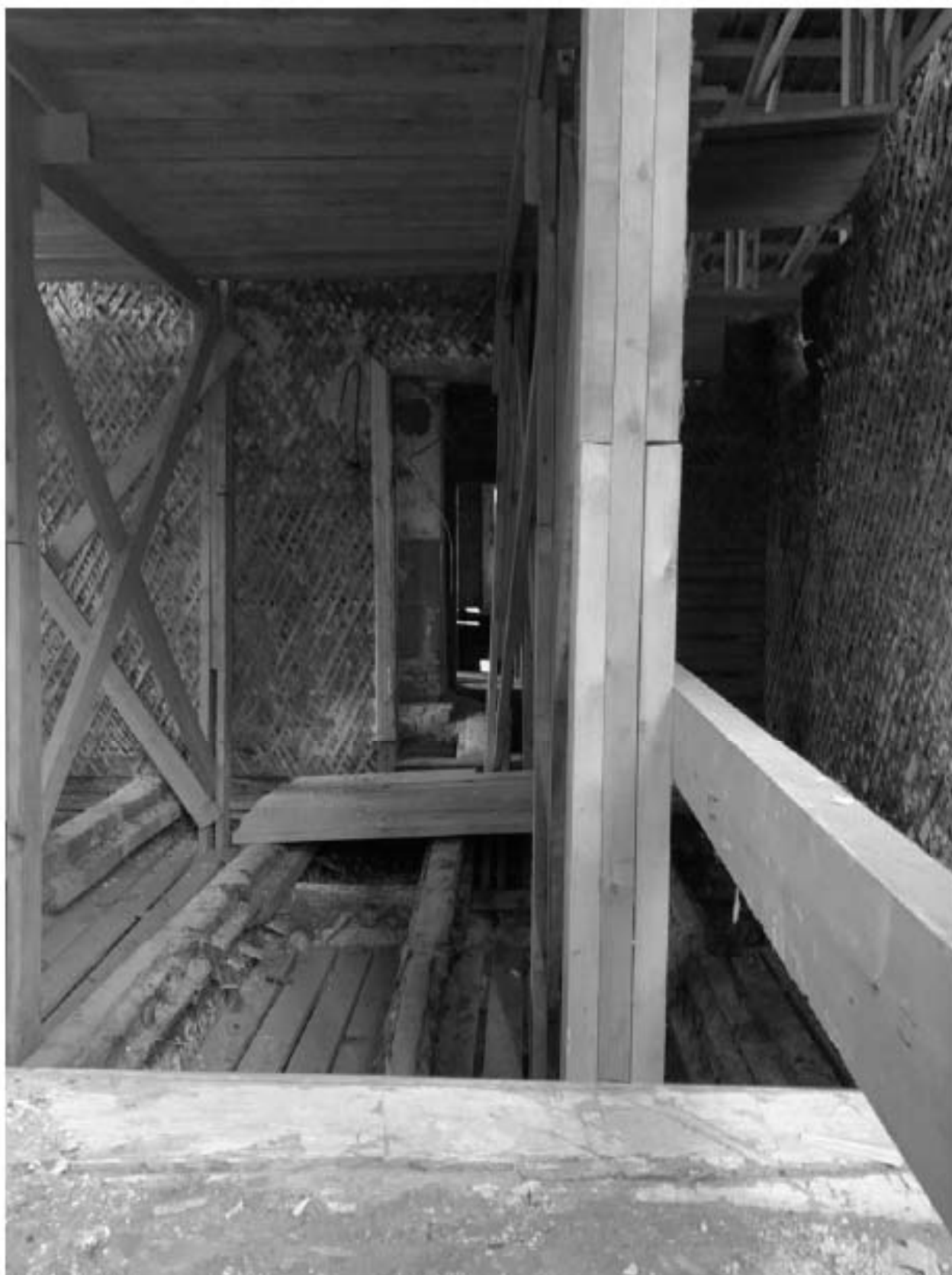
Фото 10. Вид из помещения в осях 7-8;Г-Е под защитным сооружением. Фото 1.10.2022 г.
