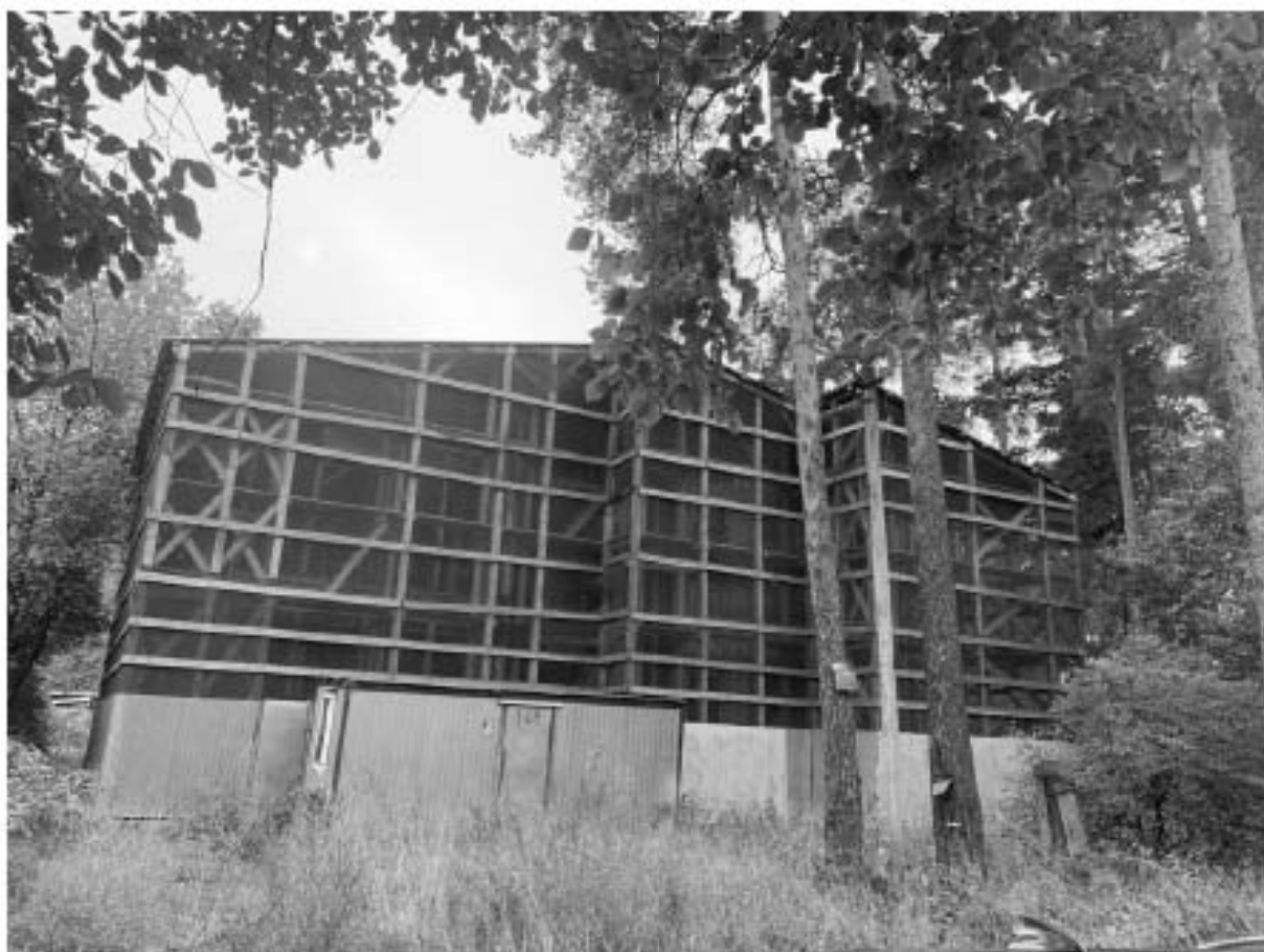
Фото 1. Общий вид здания в защитном сооружении с северной стороны. Фото 1.10.2022 г.
