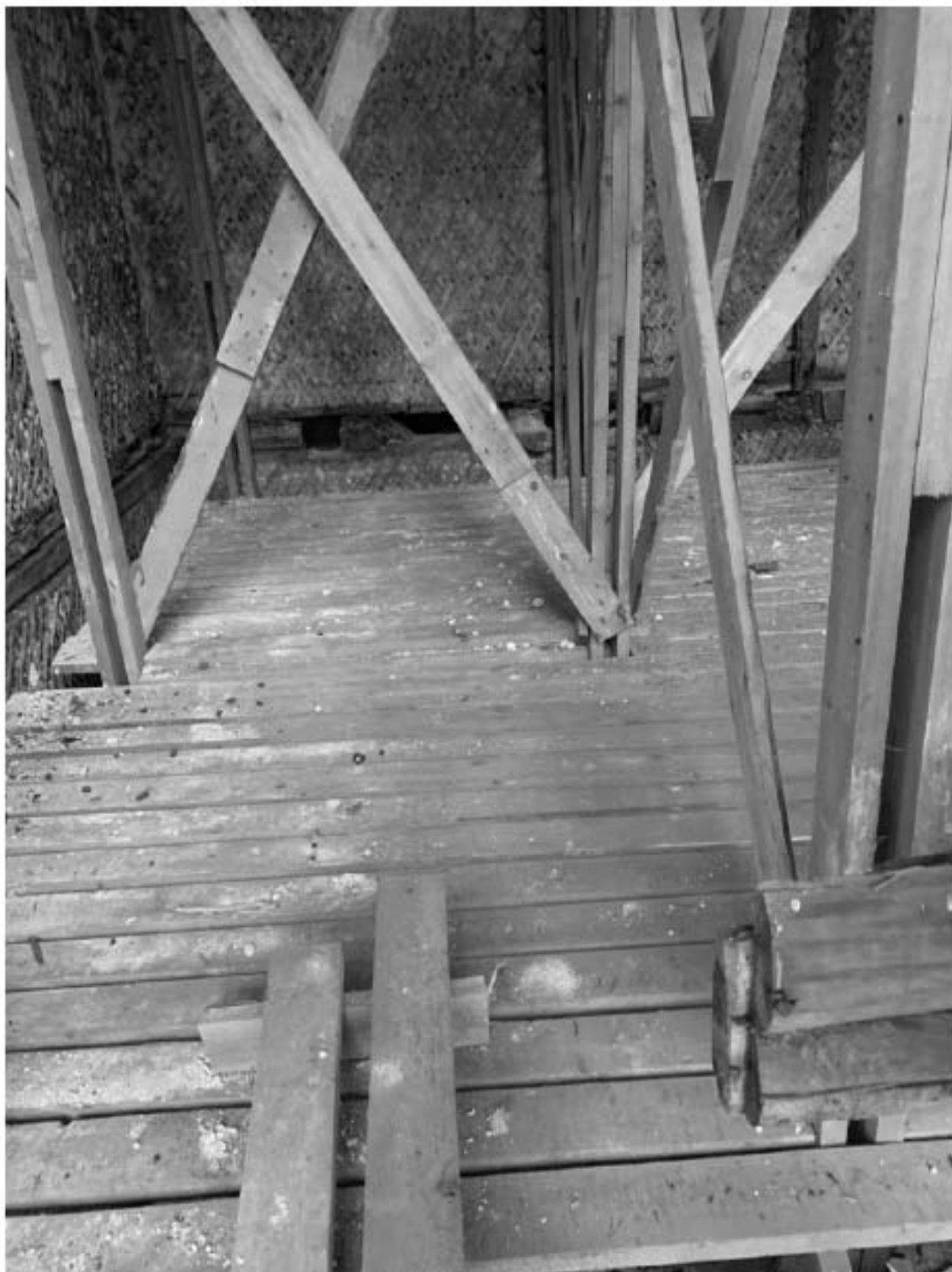
Фото 15. Вид из помещения в осях 2-4;К-Л под защитным сооружением. Фото 1.10.2022 г.
