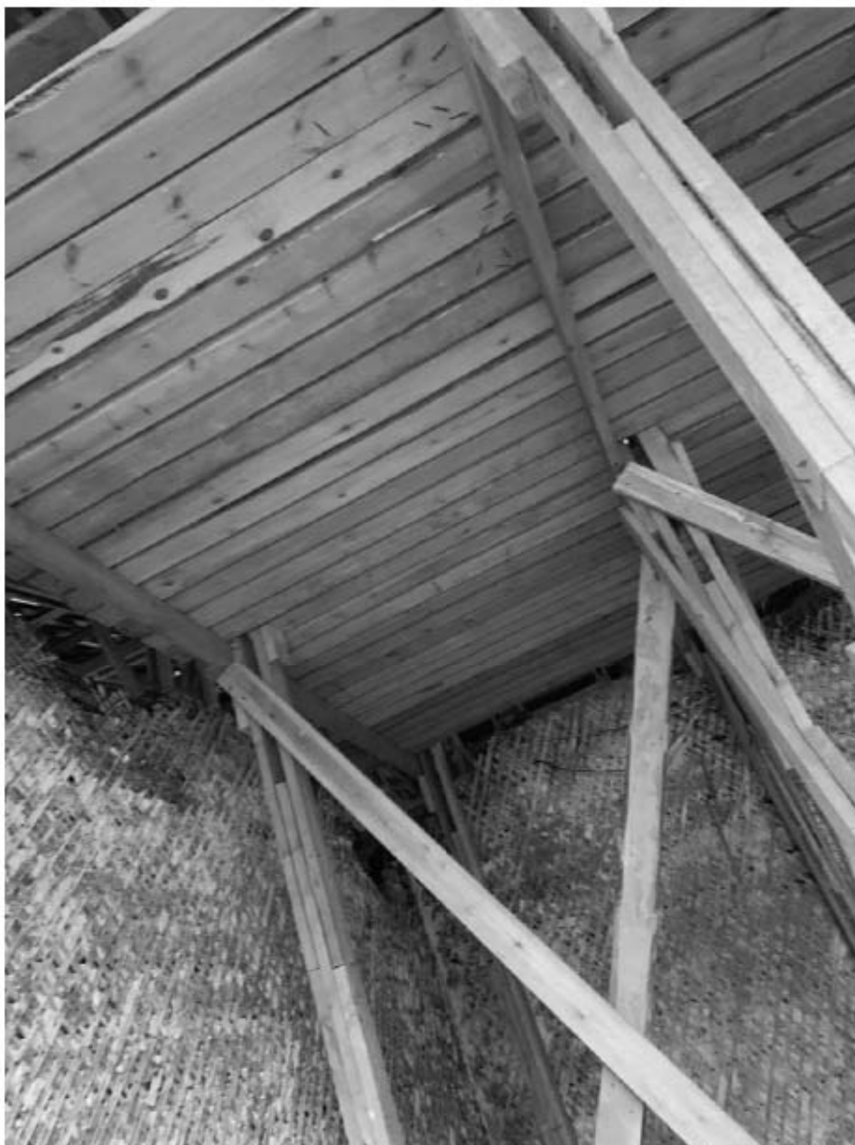
Фото 16. Вид из помещения в осях 2-4;К-Л под защитным сооружением. Фото 1.10.2022 г.
