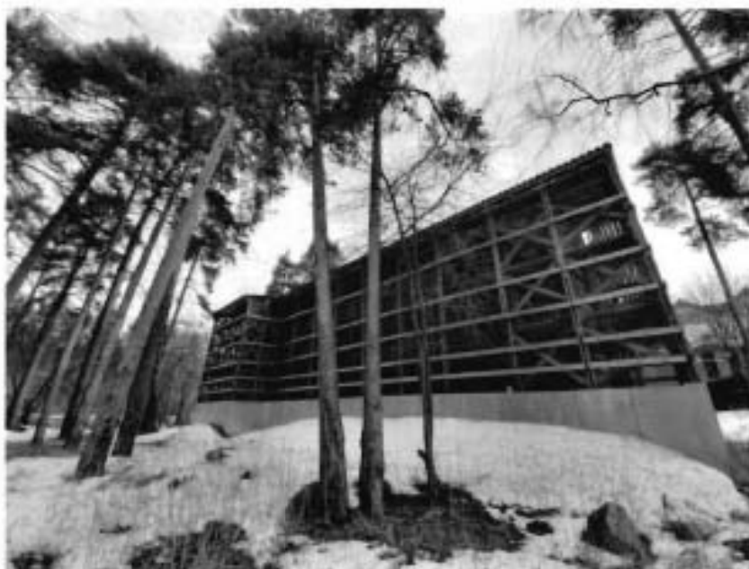
4. Общий вид на западный фасад объекта культурного наследия
