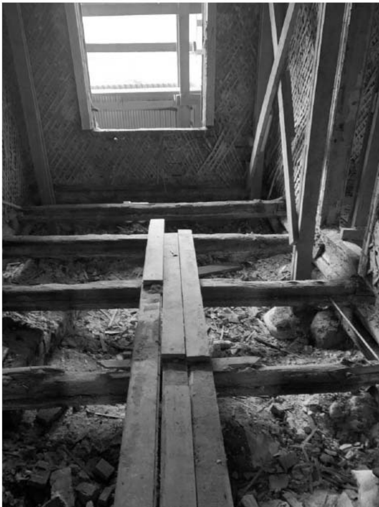
Фото 8. Вид из помещения в осях 7-8;Г-Е под защитным сооружением. Фото 1.10.2022 г.
