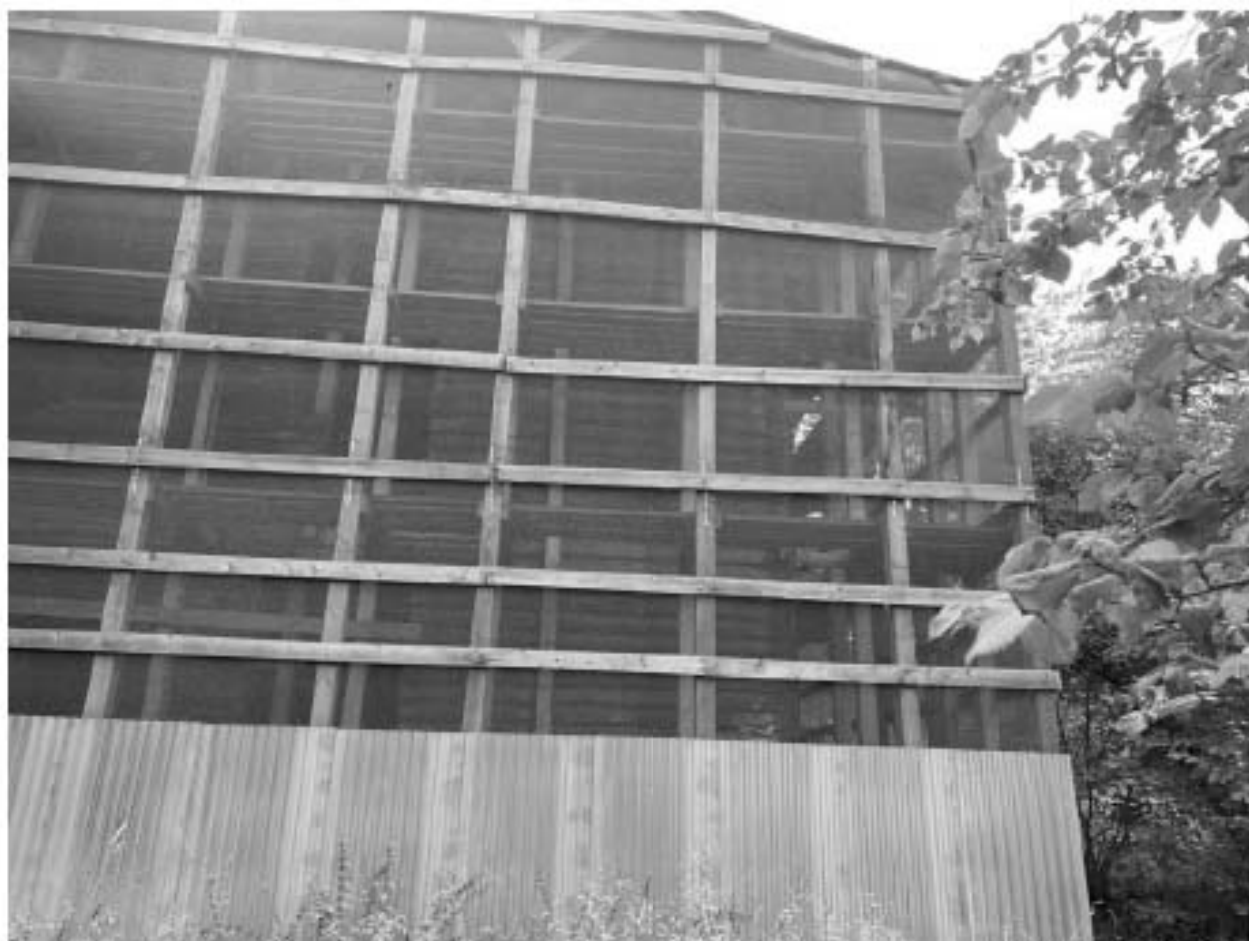
Фото 3. Вид с южной стороны на фасад 9-1 здания в защитном сооружении. Фото 1.10.2022 г.
