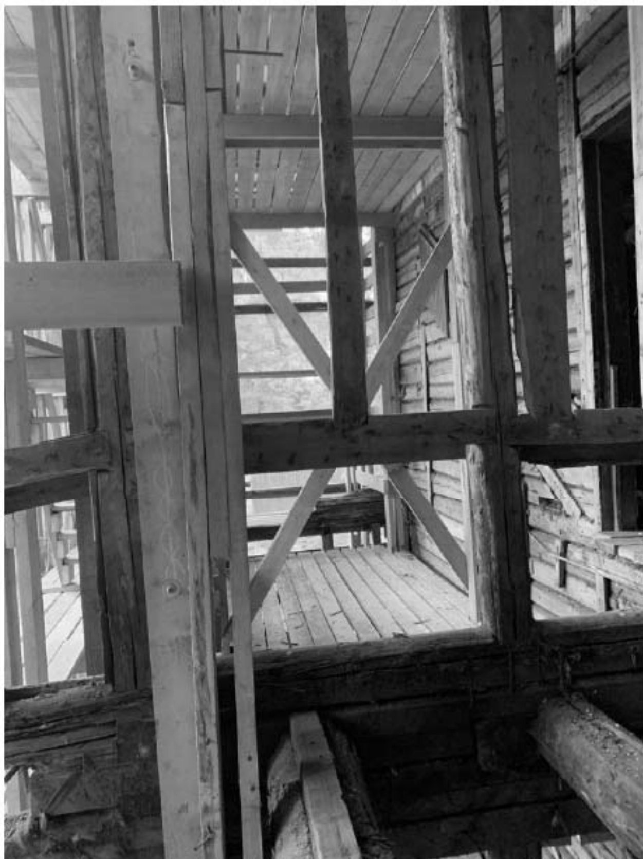
Фото 12. Вид на южную сторону из здания под защитным сооружением. Фото 1.10.2022 г.
