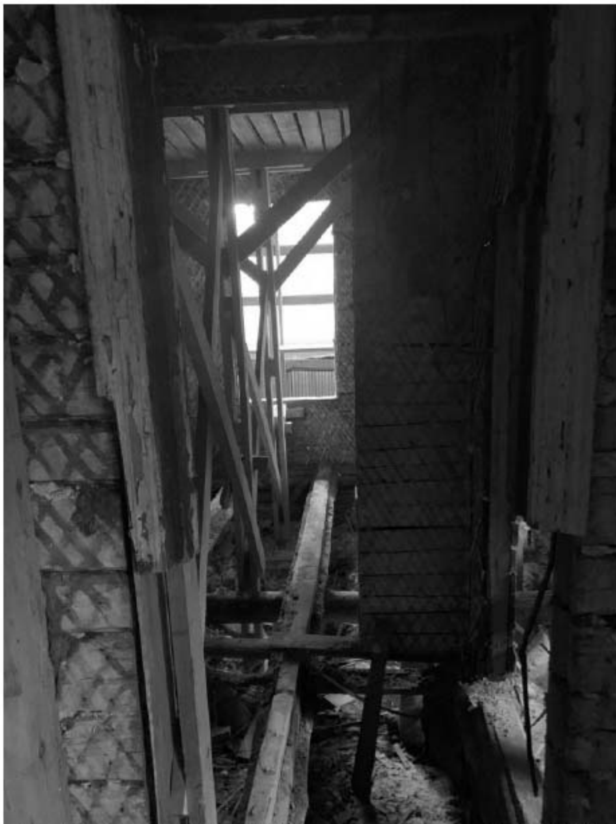
Фото 7. Вид помещения в осях 2-4;Е-Ж под защитным сооружением. Фото 1.10.2022 г.
