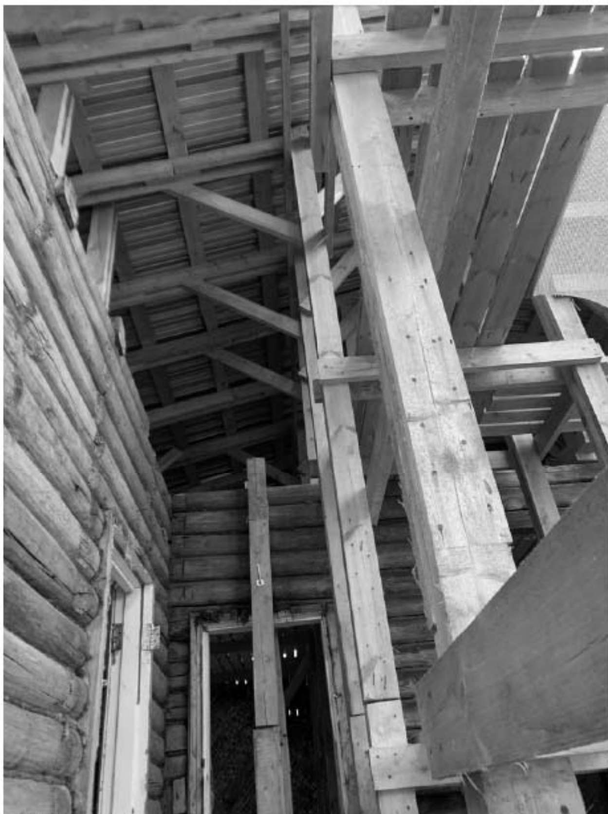
Фото 11. Вид с южной стороны на фрагмент фасада 9-1 здания под защитным сооружением. Фото 1.10.2022 г.
