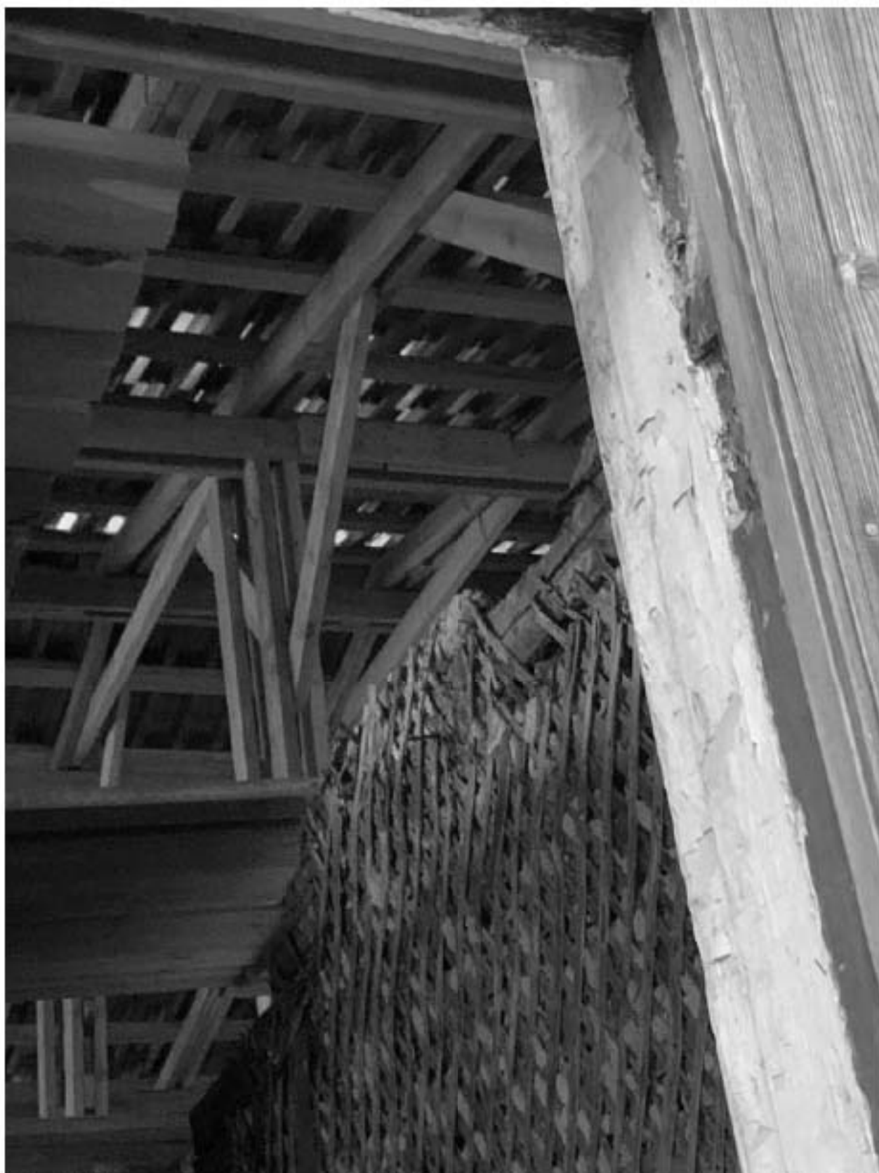
Фото 18. Вид из помещения в осях 4-5;Е-Ж под защитным сооружением. Фото 1.10.2022 г.
