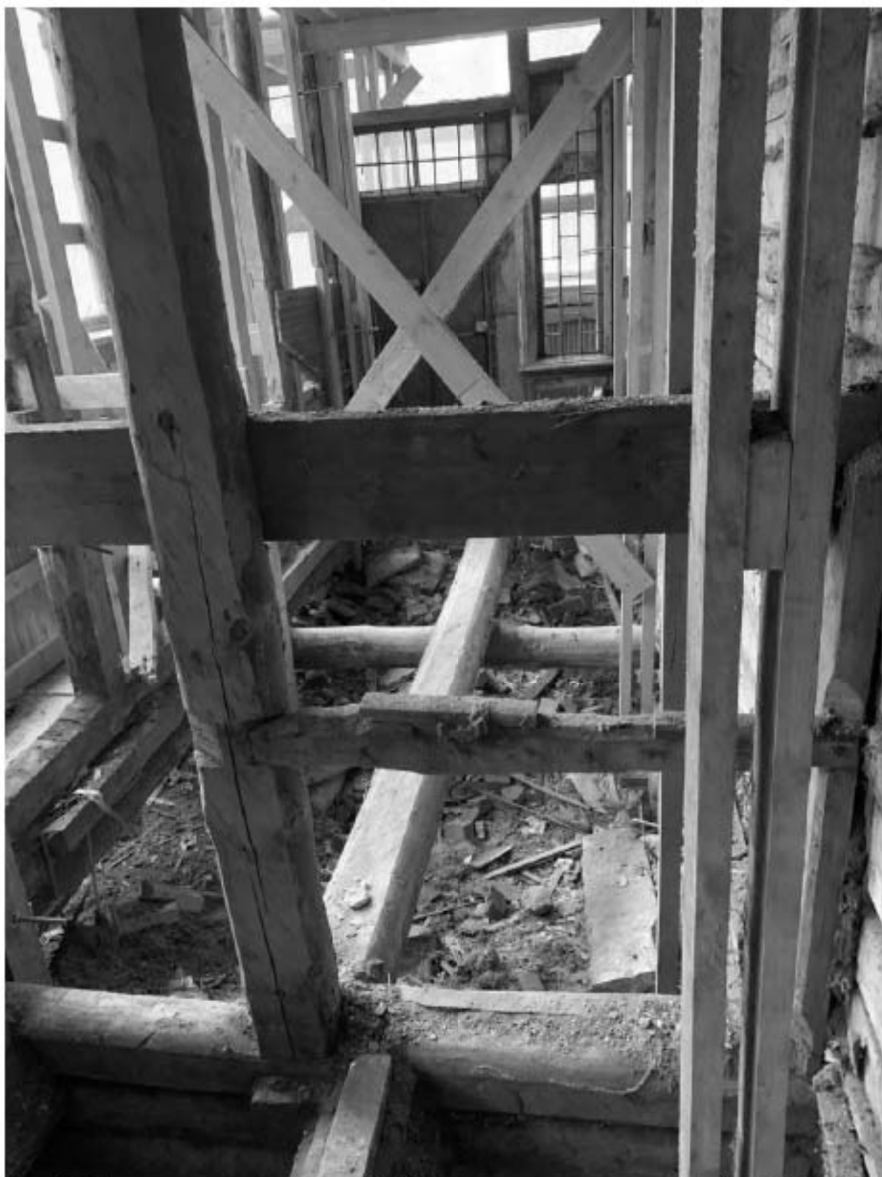
Фото 17. Вид из помещения в осях 8-10;Д-Е под защитным сооружением. Фото 1.10.2022 г.
