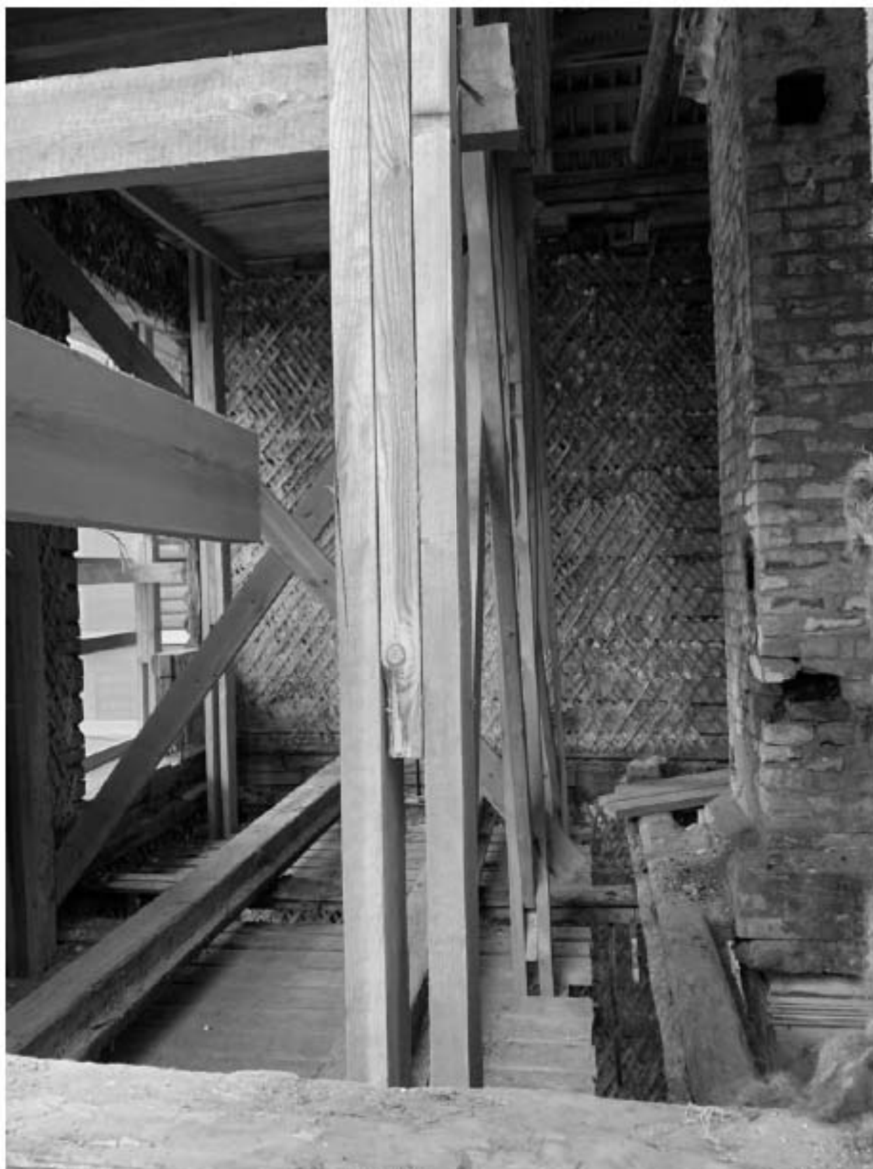
Фото 13. Вид из помещения в осях 1-2;Ж-К под защитным сооружением. Фото 1.10.2022 г.
