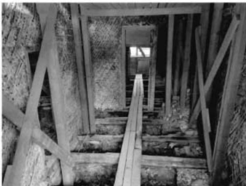
5. Интерьеры объекта культурного наследия
