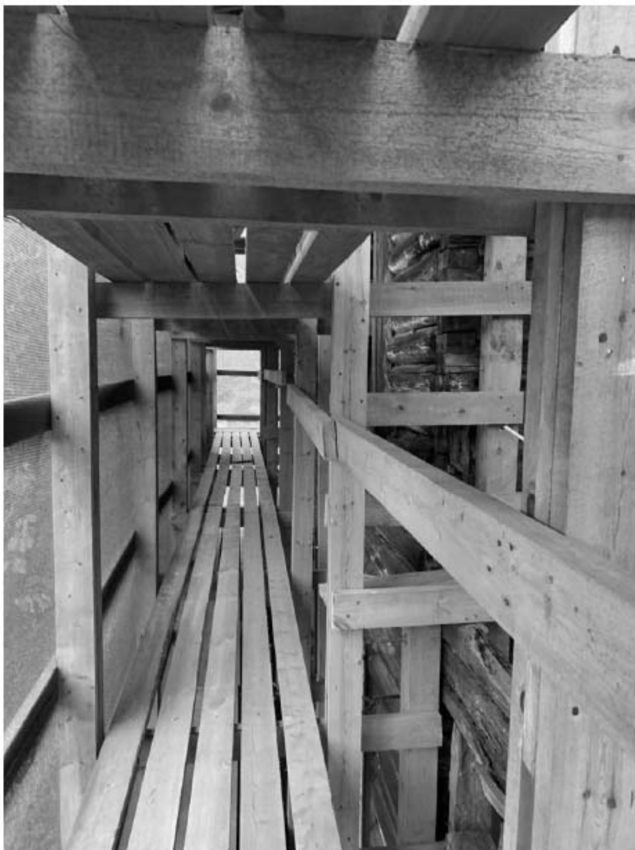
Фото 5. Вид на уровне второго этажа вдоль фасада Н-А здания под защитным сооружением. Фото 1.10.2022 г.
