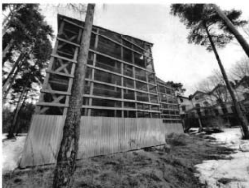
3. Общий вид на южный фасад объекта культурного наследия
