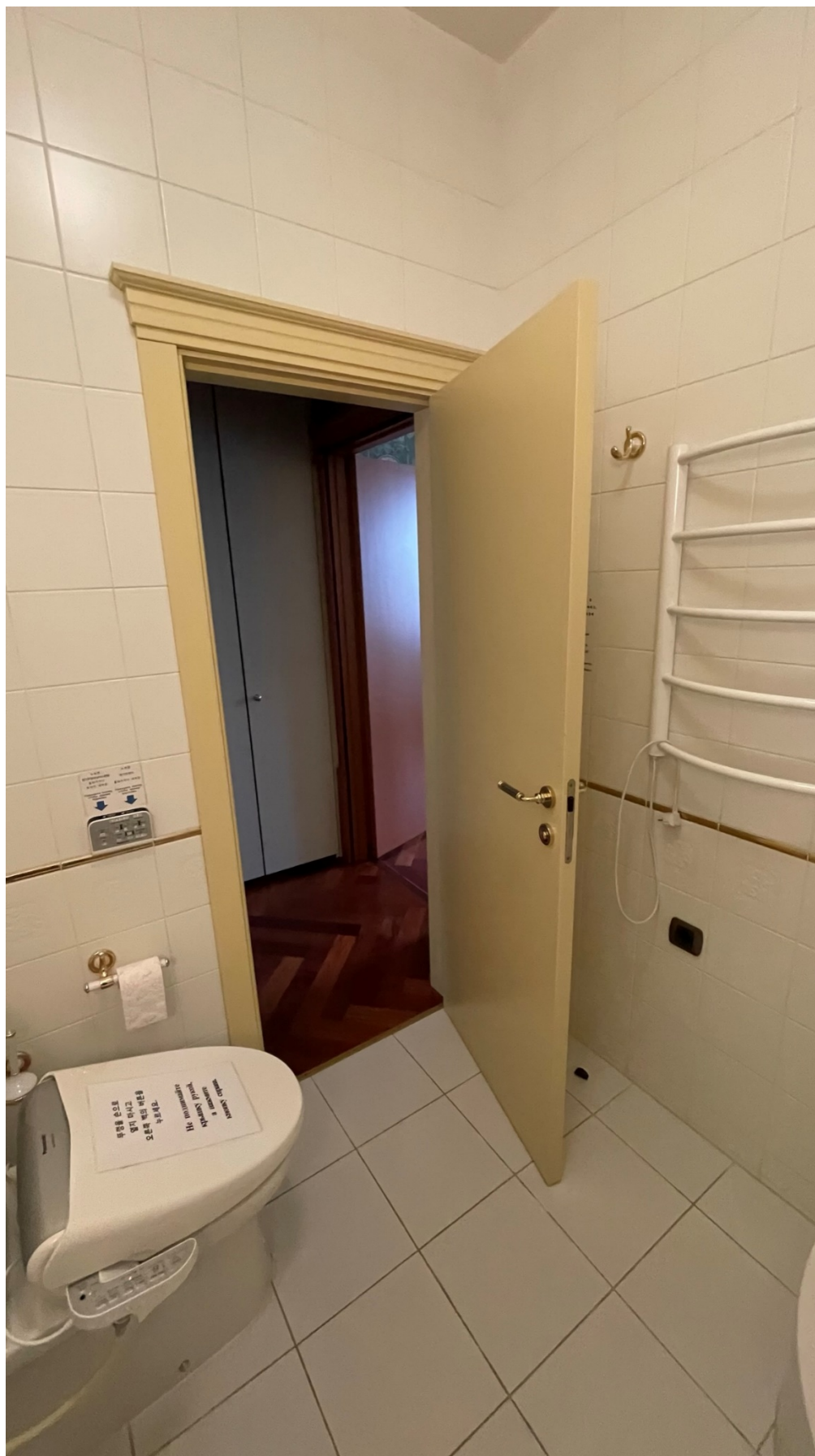
14. Фрагмент интеръера санузла (помещение №7);
