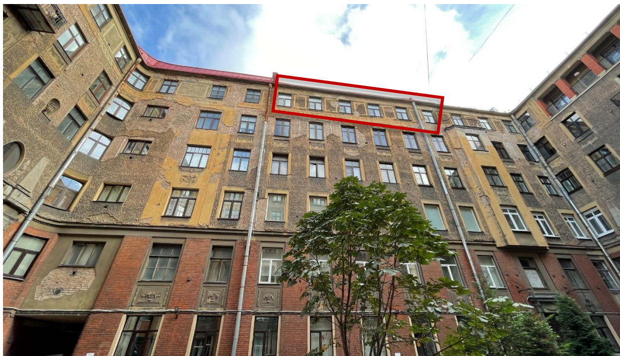
1. Вид на дворовой фасад и окна квартиры №632;
