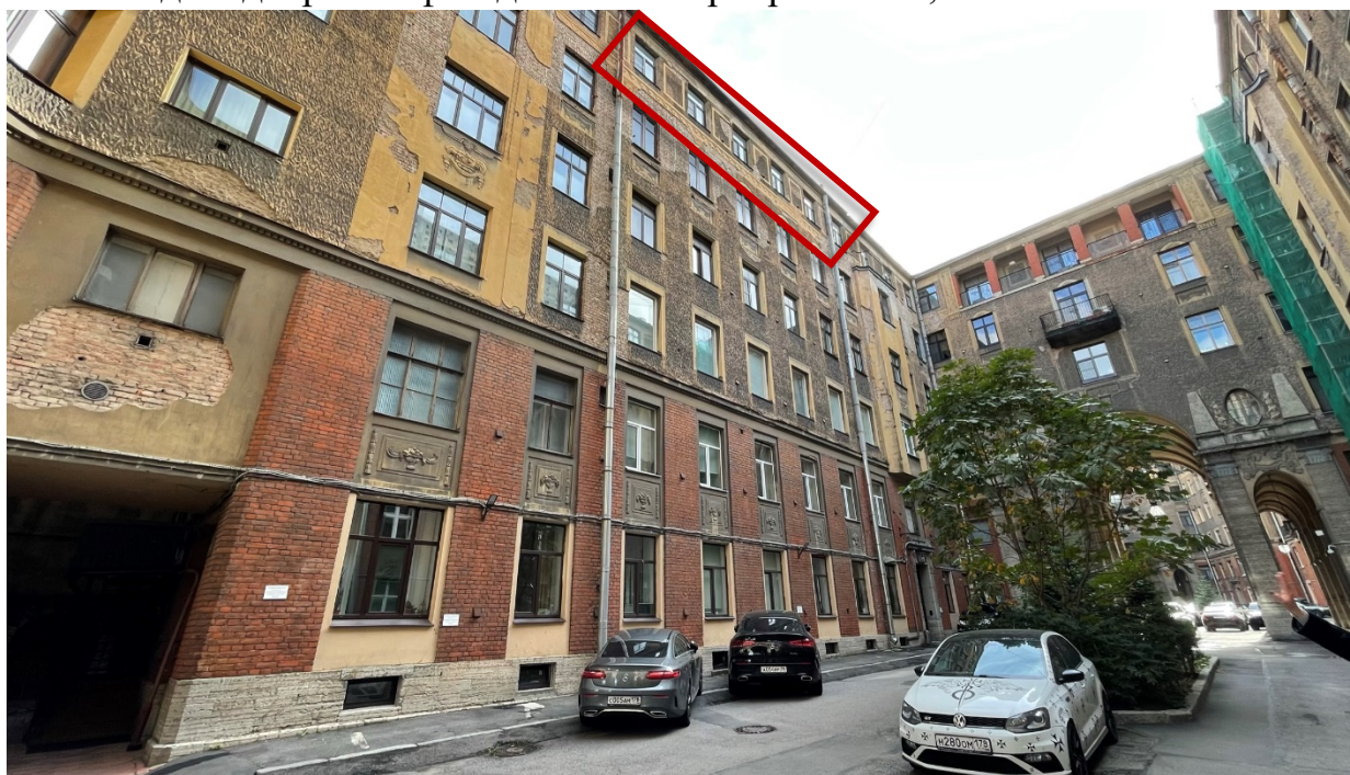
2. Вид на дворовой фасад и окна квартиры №632;
