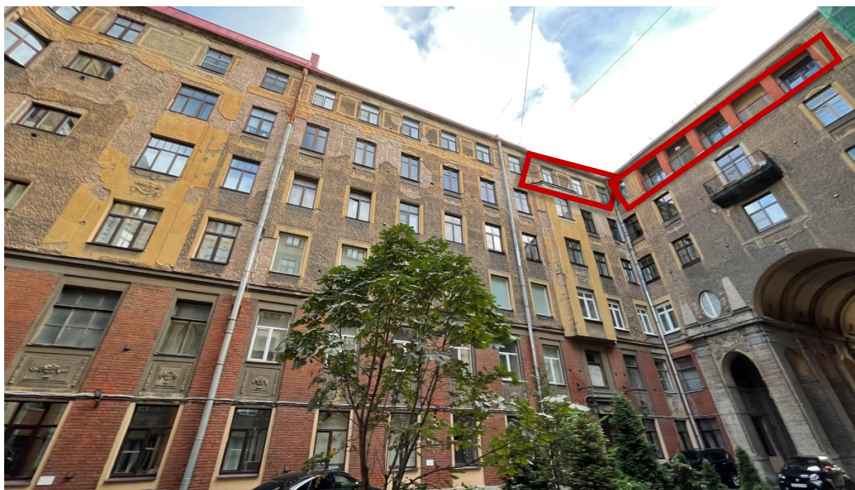
1. Вид на дворовой фасад и окна квартиры по адресу: г. Санкт-Петербург, ул. Рубинштейна, д. 15-17, лит. А.;
