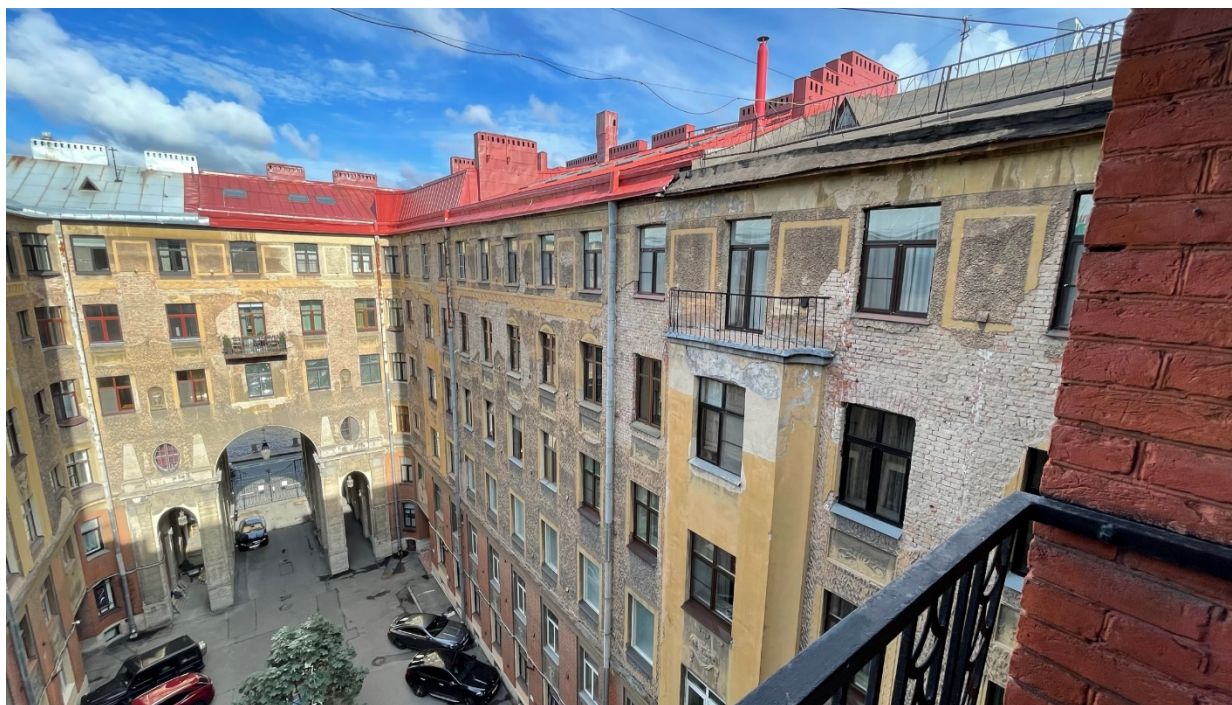
49. Общий вид с балкона на дворовую территорию;
