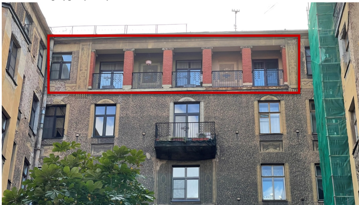
2. Вид на окна квартиры № 631;
