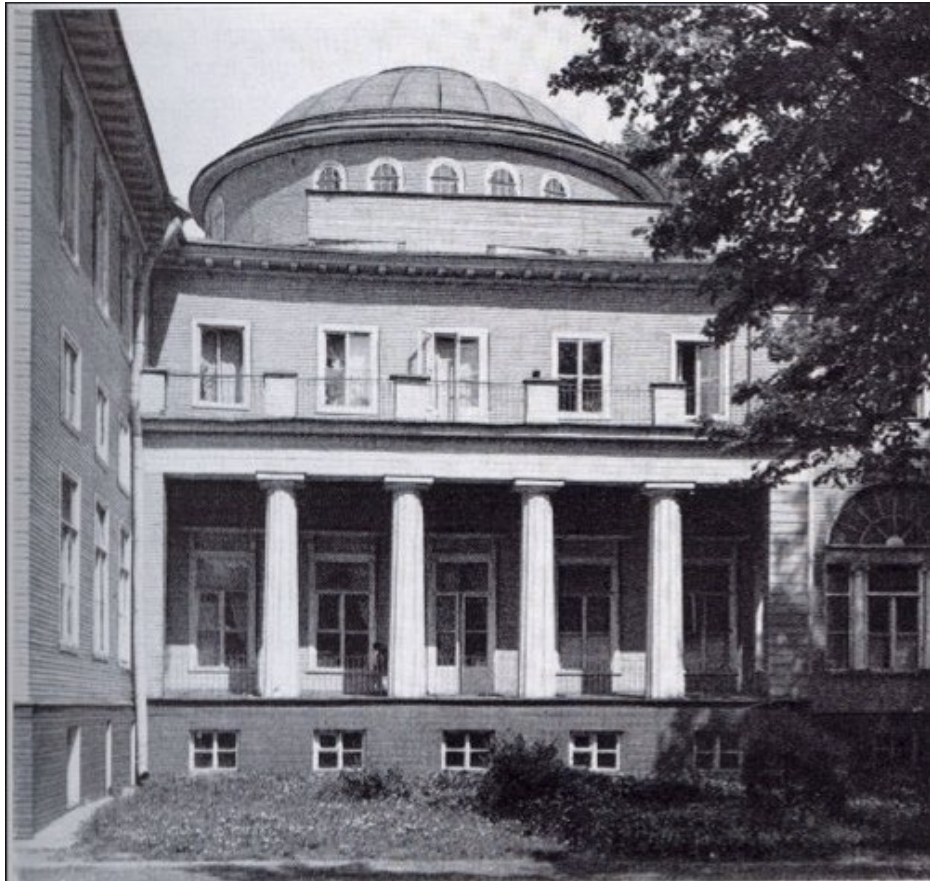
34. Дворовой фасад дачи принца Ольденбургского. 1975 г. https://vk.com/photo-632986_141393451 Памятники архитектуры Ленинграда. – Л. 1975 г.
