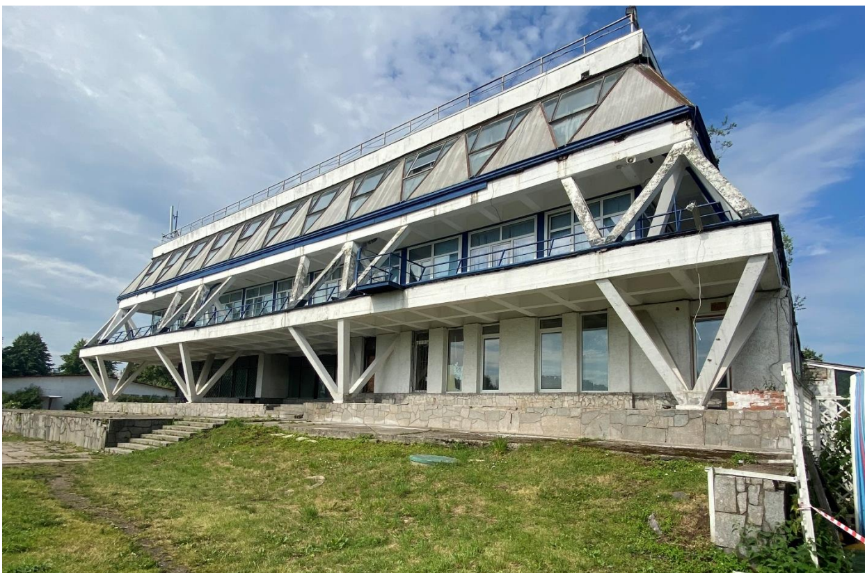
Фото 7. Восточный фасад Главного здания яхт-клуба, вид от причала.
