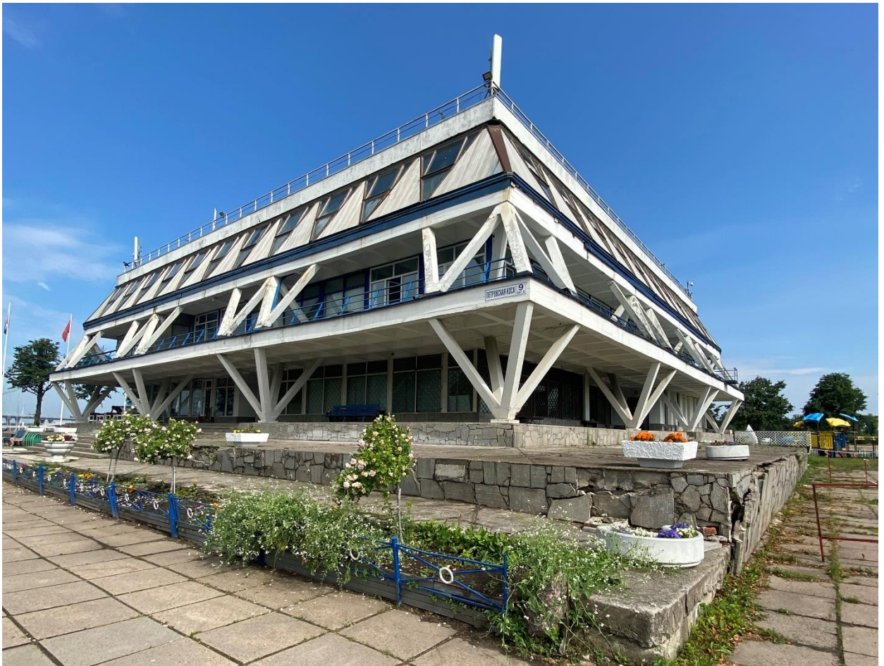
Фото 3. Вид на Главное здание яхт-клуба с юго-восточной стороны территории.
