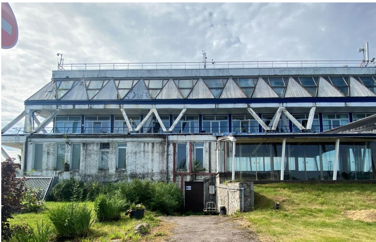
Фото 9. Восточная часть северного фасада Главного здания яхт-клуба (вход в подвал).
