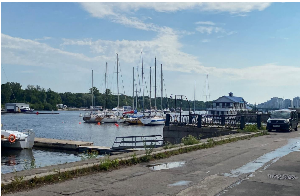
Фото 8. Причалное сооружение набережной левого берега М. Невки.
