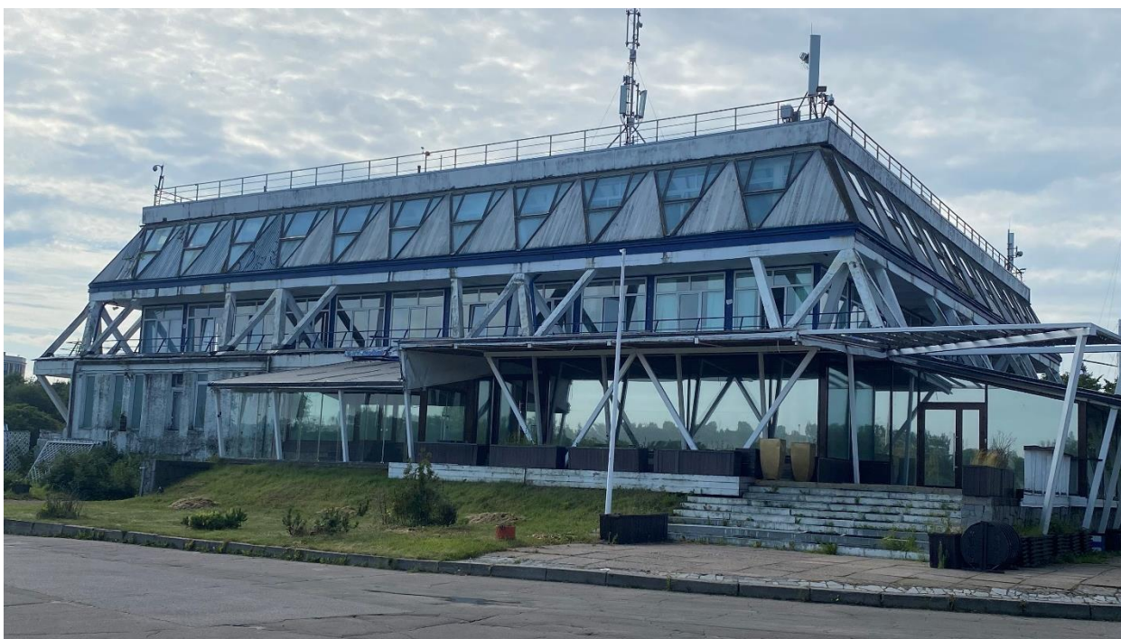
Фото 10. Северный фасад Главного здания яхт-клуба.
