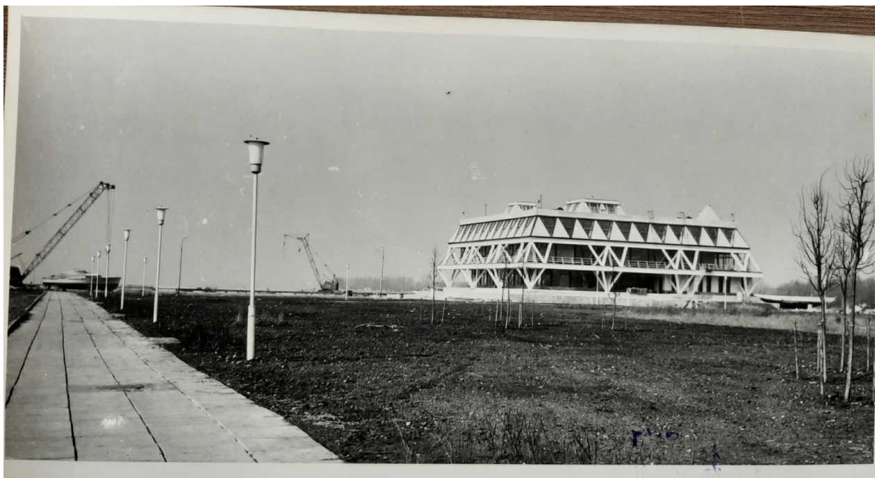
Илл. 41. Фотография. Восточный и южный фасады главного здания центрального яхт-клуба. На заднем плане видны краны, строившие мол (дамбу) Гостевой гавани. ЦГАНТД СПб. Ф. Р-427. Оп. 1. Д. 33. Л. 12.
