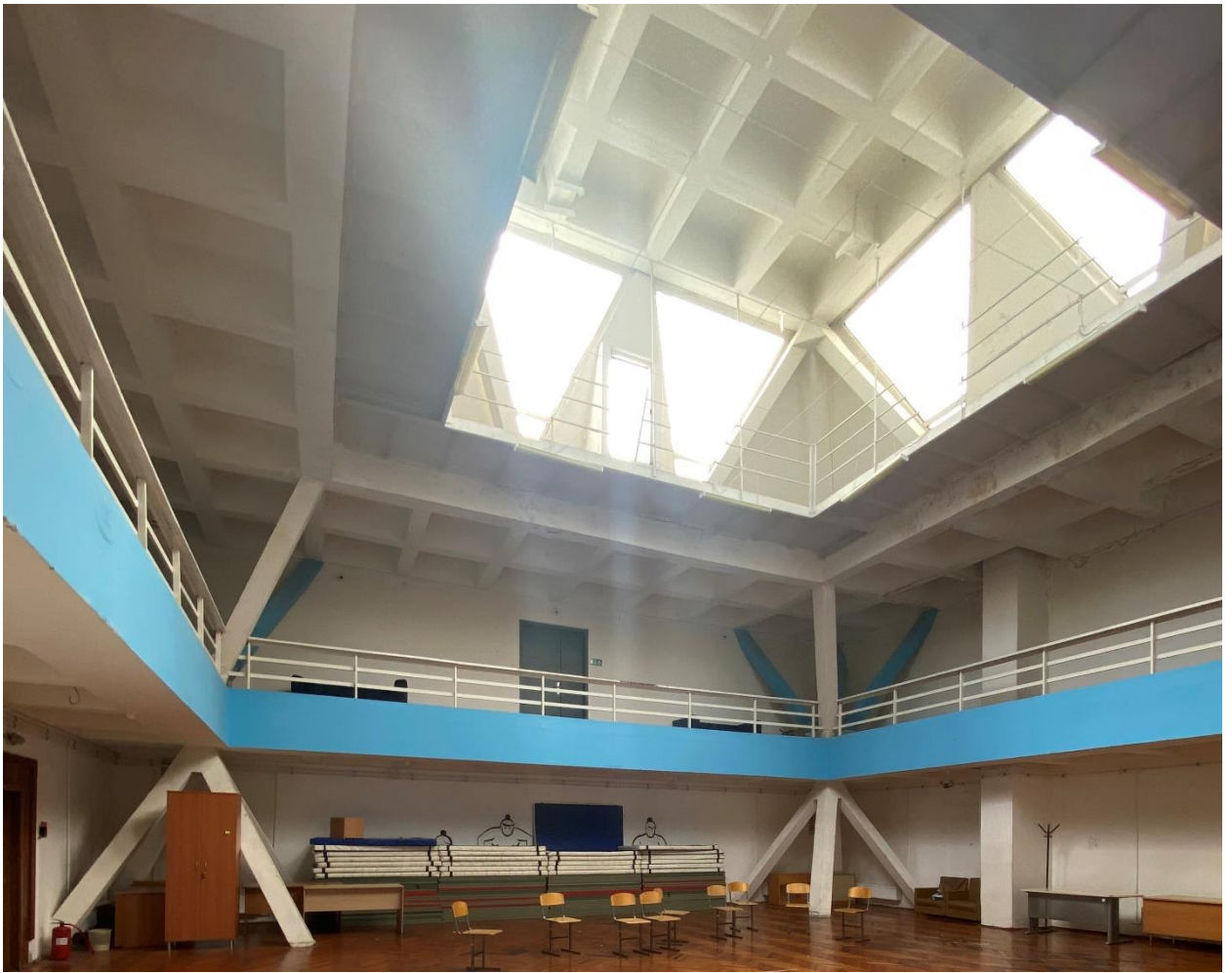
Фото 8. Пространственный каркас светового фонаря, кессонированные плиты перекрытия.
