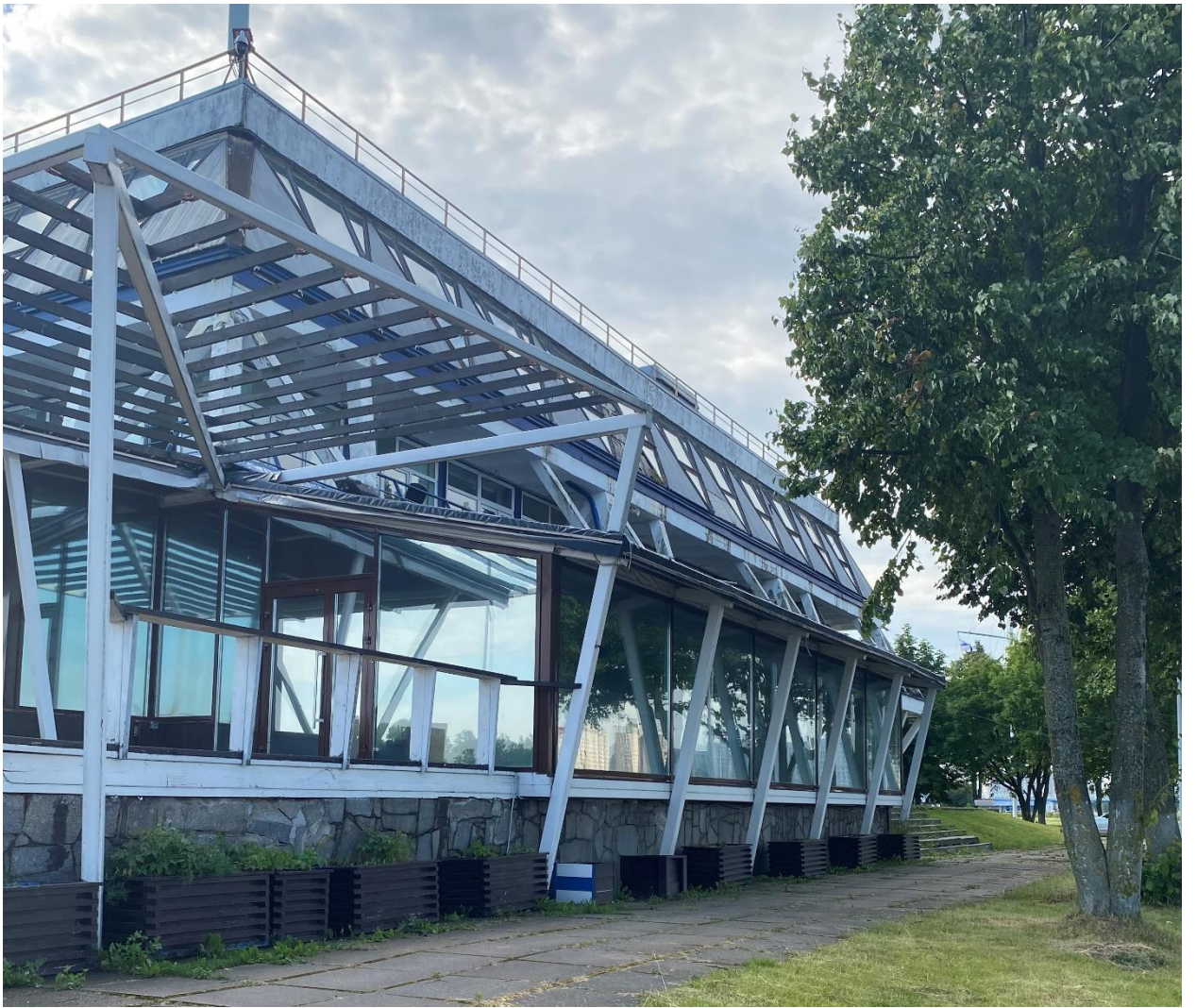
Фото 11. Западный фасад. Фрагмент. Поздние диссонирующие пристройки на террасе.
