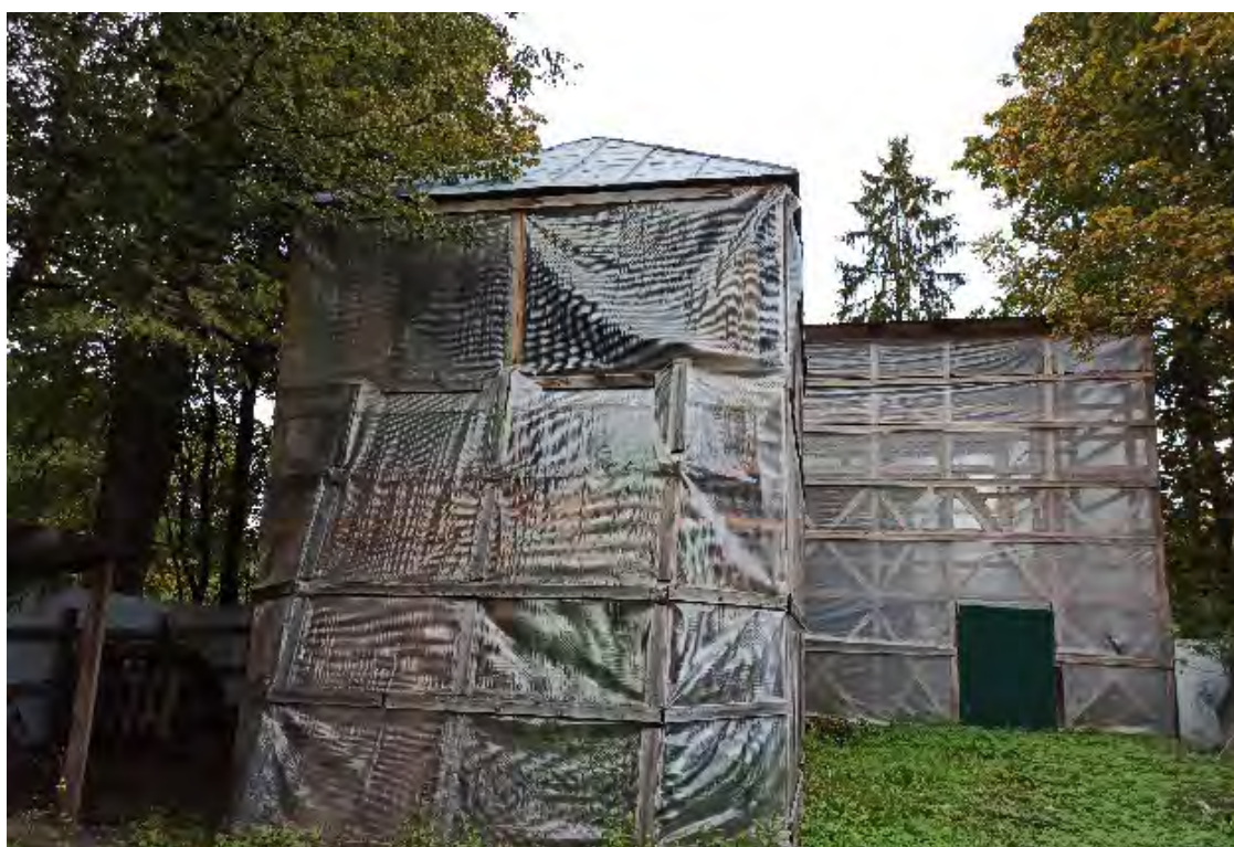
Фото 2. Вид на Краснодолинный павильон, проведены противоаварийные работы.
