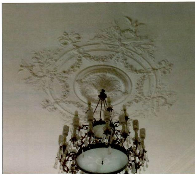
9. Лит. А. Оформление потолка. Второй этаж.
