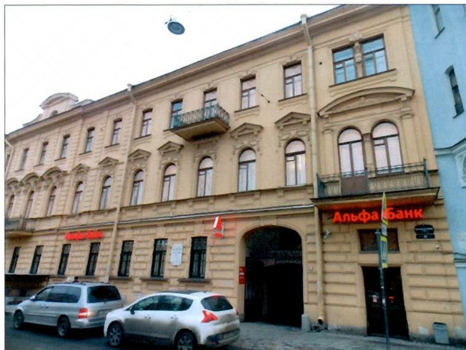
2. Лит. А. Южный фасад. Вид с юго-востока. Фрагмент.
