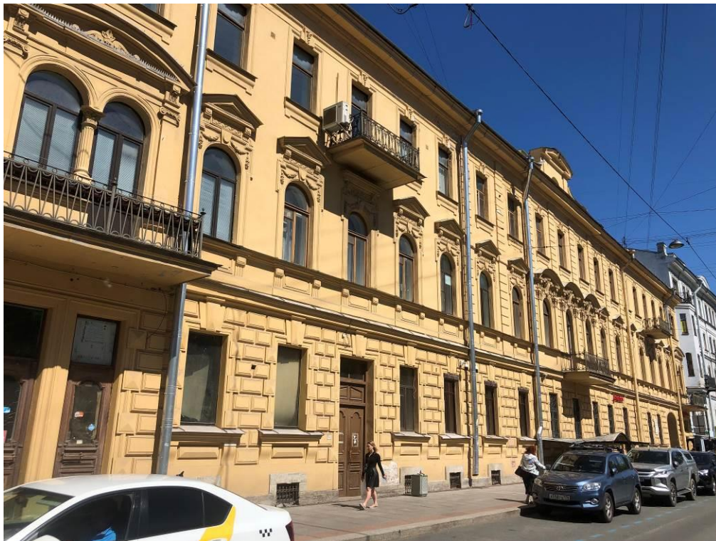
1. Объект культурного наследия регионального значения «Дом, где в 1917-1918гг. находилось центральное бюро петроградских профсоюзов», расположенный по адресу: г. Санкт-Петербург, ул. Фуриштатская, д. 40, лит. А, Б, В. Лицевой корпус (ул. Фуриштатская, д. 40, лит. А). Общий вид на Главный (лицевой) фасад со стороны Фуриштатской улицы.
