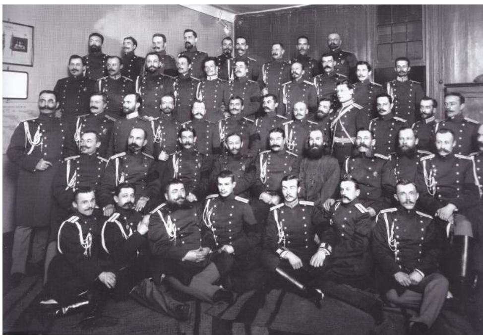
15. Здание штаба Отдельного корпуса жандармов. Фурштатская ул., д.40. Группа жандармов в одном из помещений штаба корпуса. Фотография. 1915 г. Опубликовано в: Ю.Б. Шелаев, Е.П. Шелаева «Санкт-Петербург накануне крушения империи». СПб., 2011.
