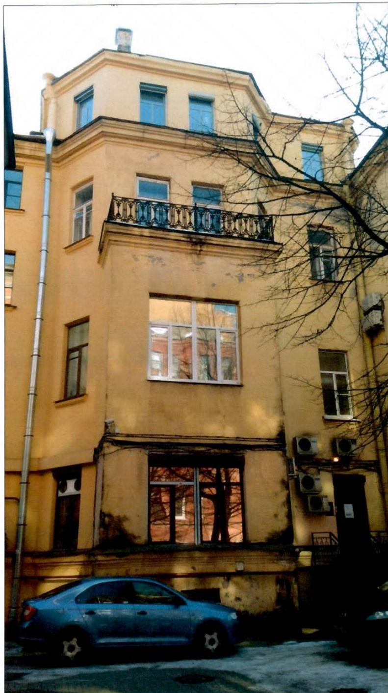
7. Лит. А. Ризалит дворового фасада.
