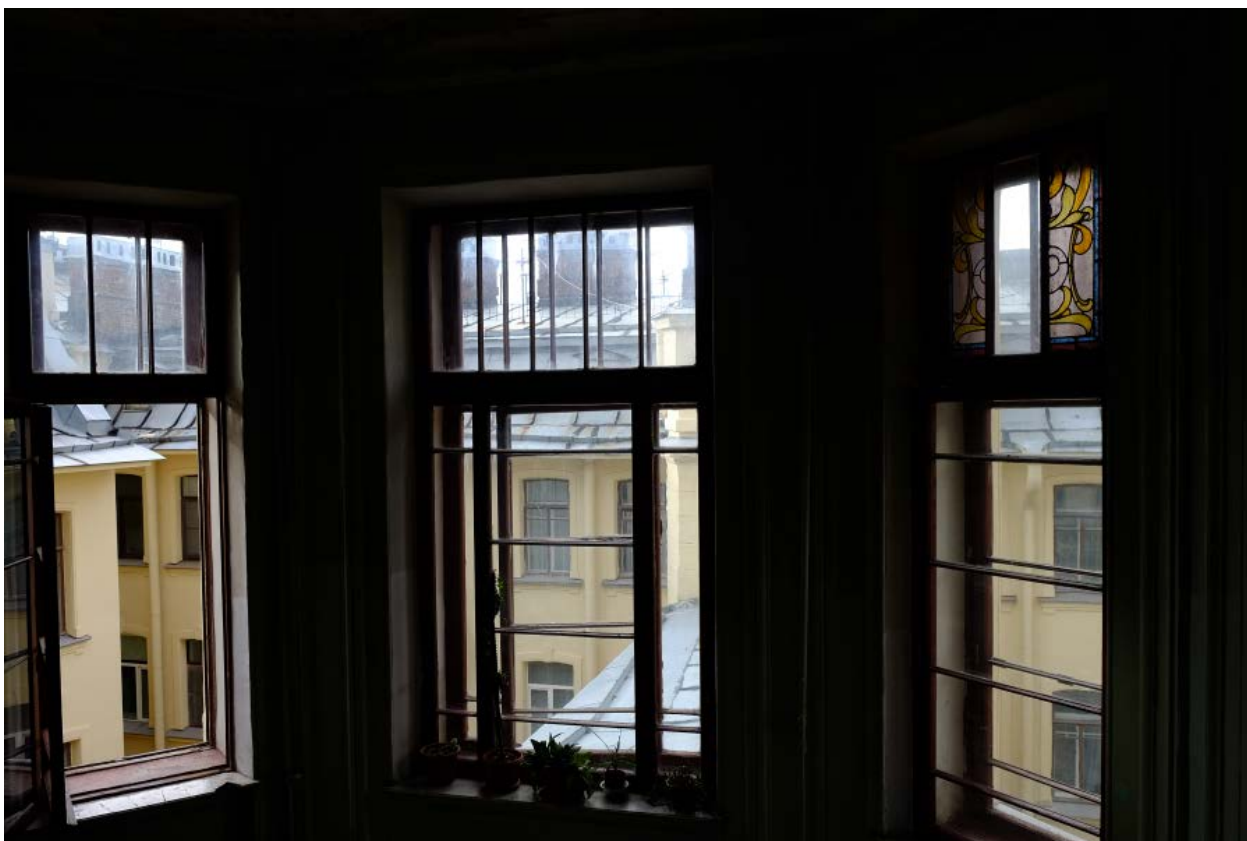
59. Кирочная улица, дом 24, литера А. «Дом Ю.Бака». Парадная лестница № 2. Шестой этаж. Общий вид оконных проемов.
