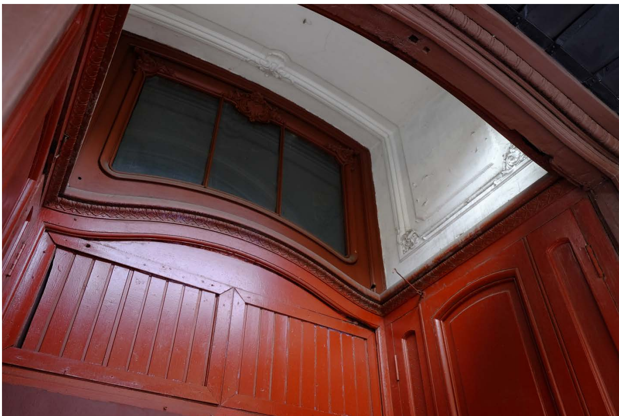
35. Кирочная улица, дом 24, литера А. «Дом Ю.Бака». Парадная лестница № 2. Тамбур. Вид верхней части.
