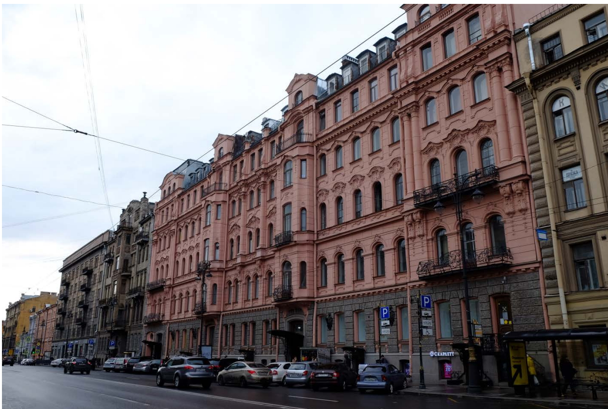
1. Кирочная улица, дом 24, литера А. «Дом Ю.Бака». Лицевой фасад. Общий вид.
