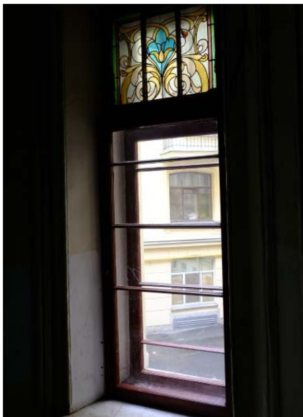
48. Кировская улица, дом 24, литера А. «Дом Ю.Бака». Парадная лестница № 2. Второй этаж. Правое оконное заполнение.
