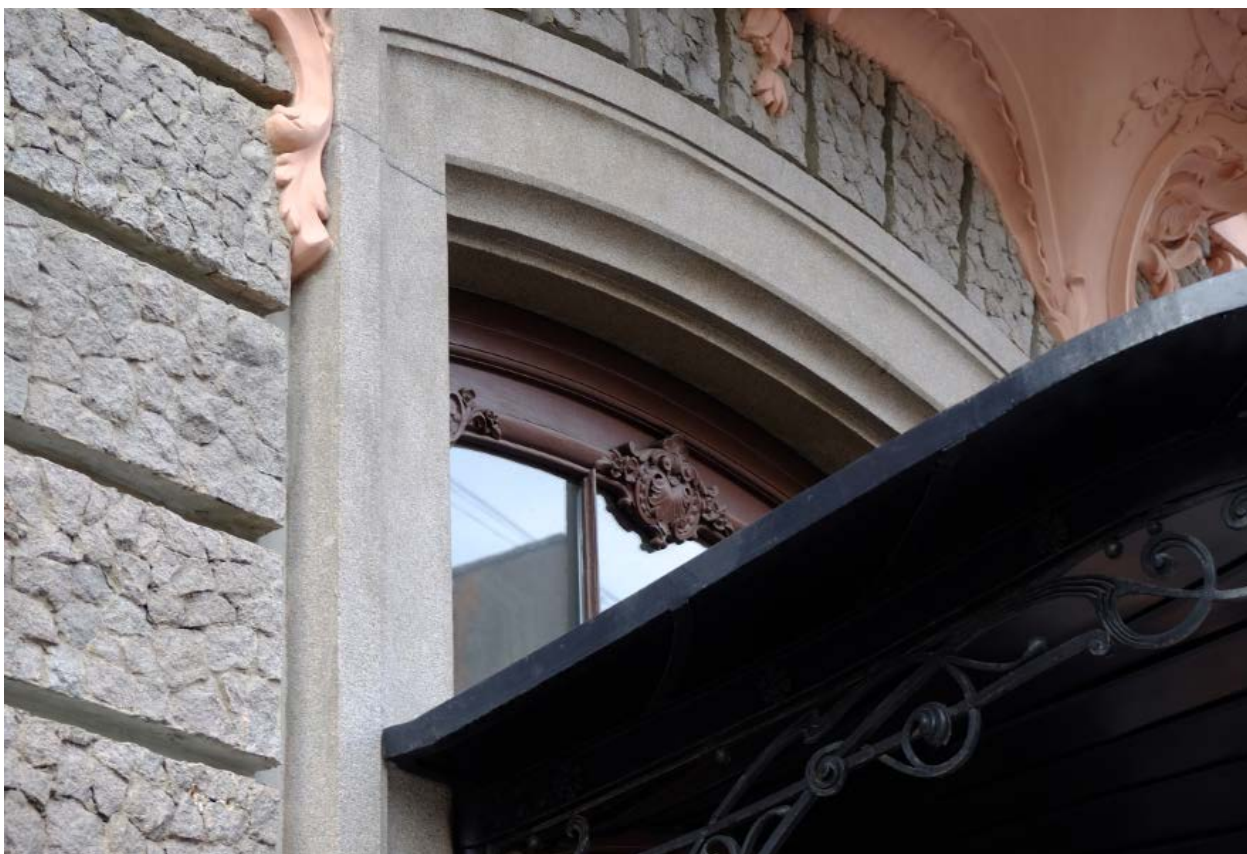
34. Кирочная улица, дом 24, литера А. «Дом Ю.Бака». Парадная лестница № 2. Фрамуга. Вид с улицы.
