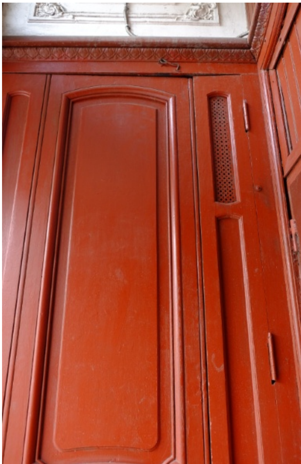
43. Кирочная улица, дом 24, литера А. «Дом Ю.Бака». Парадная лестница № 2. Тамбур. Левая боковая панель.Фрагмент.
