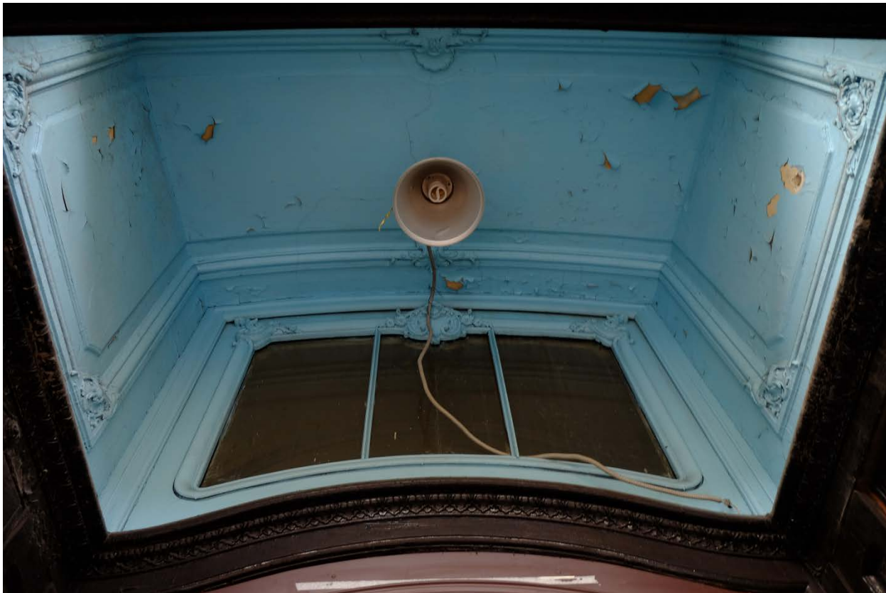
9. Кирочная улица, дом 24, литера А. «Дом Ю.Бака». Тамбур парадной лестницы № 1. Фрамуга со стороны лестницы.
