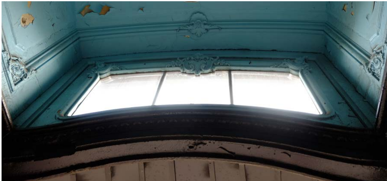
7. Кирочная улица, дом 24, литера А. «Дом Ю.Бака». Тамбур парадной лестницы № 1. Фрамуга.
