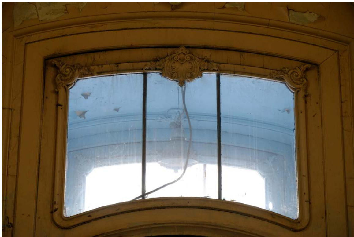
17. Кирочная улица, дом 24, литера А. «Дом Ю.Бака». Тамбур парадной лестницы № 1. Фрамуга со стороны лестницы.
