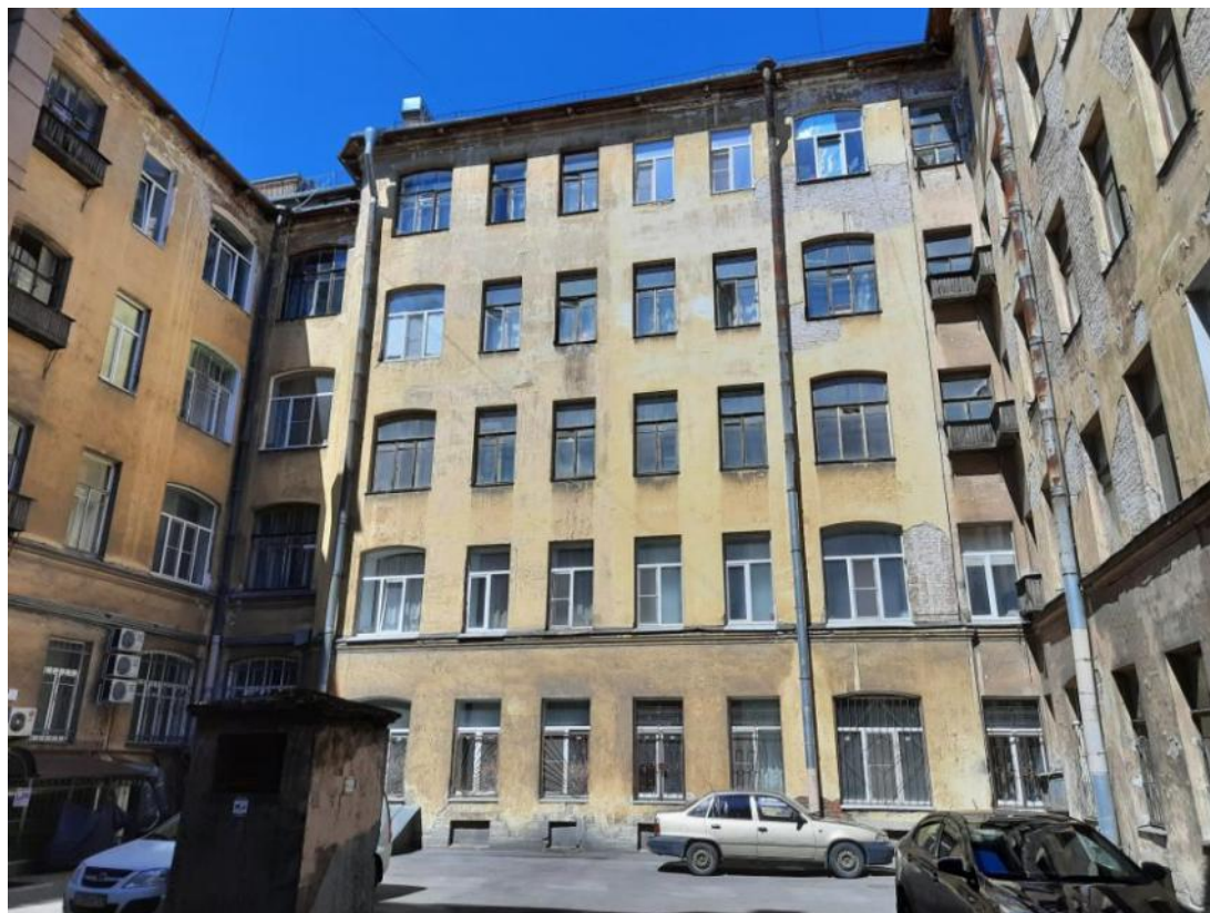
Фото 8 Фрагмент дворового фасада выявленного объекта культурного наследия «Дом Ф.Ф. Шпринга» расположенного по адресу: Санкт-Петербург, пер. Тучков, дом 11/5, литера А (Тучков пер., 11; Волховский пер., 5)
