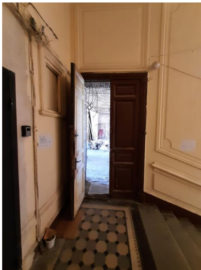
Фото 13 Интерьер квартиры №39 выявленного объекта культурного наследия «Дом Ф.Ф. Шпринга» расположенного по адресу: Санкт-Петербург, пер. Тучков, дом 11/5, литера А
