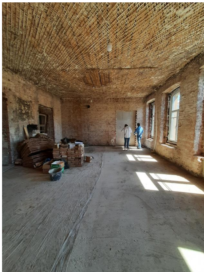
Фото 16 Интерьер квартиры №39 выявленного объекта культурного наследия «Дом Ф.Ф. Шпринга» расположенного по адресу: Санкт-Петербург, пер. Тучков, дом 11/5, литера А
