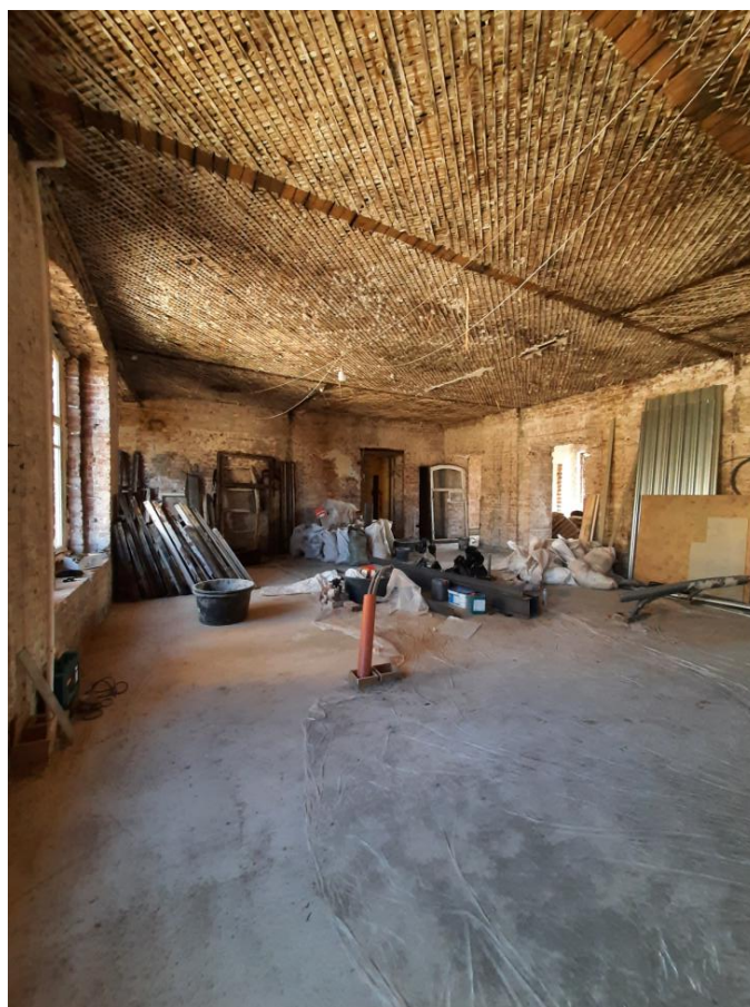
Фото 18 Интерьер квартиры №39 выявленного объекта культурного наследия «Дом Ф.Ф. Шпринга» расположенного по адресу: Санкт-Петербург, пер. Тучков, дом 11/5, литера А
