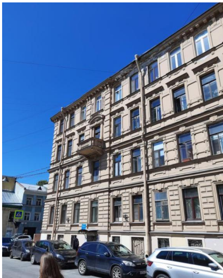
Фото 2 Фрагмент лицевого фасада выявленного объекта культурного наследия «Дом Ф.Ф. Шпринга» расположенного по адресу: Санкт-Петербург, пер. Тучков, дом 11/5, литера А (Тучков пер., 11; Волховский пер., 5)
