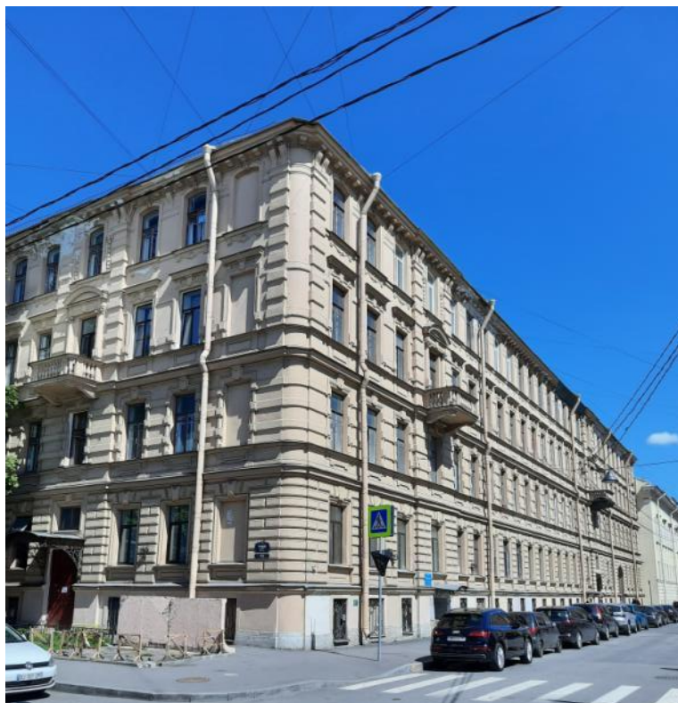
Фото 1 Фрагмент лицевого фасада выявленного объекта культурного наследия «Дом Ф.Ф. Шпринга» расположенного по адресу: Санкт-Петербург, пер. Тучков, дом 11/5, литера А (Тучков пер., 11; Волховский пер., 5)
