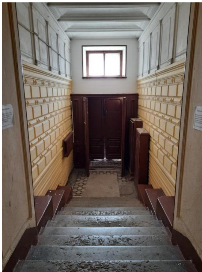
Фото 11 Интерьер выявленного объекта культурного наследия «Дом Ф.Ф. Шпринга» расположенного по адресу: Санкт-Петербург, пер. Тучков, дом 11/5, литера А (Тучков пер., 11; Волховский пер., 5)
