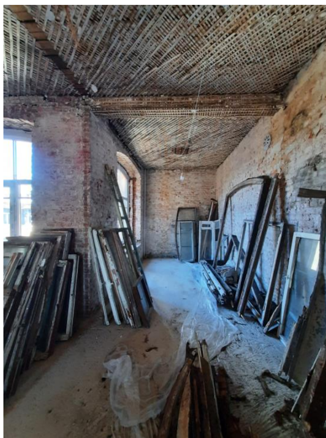
Фото 14 Интерьер квартиры №39 выявленного объекта культурного наследия «Дом Ф.Ф. Шпринга» расположенного по адресу: Санкт-Петербург, пер. Тучков, дом 11/5, литера А
