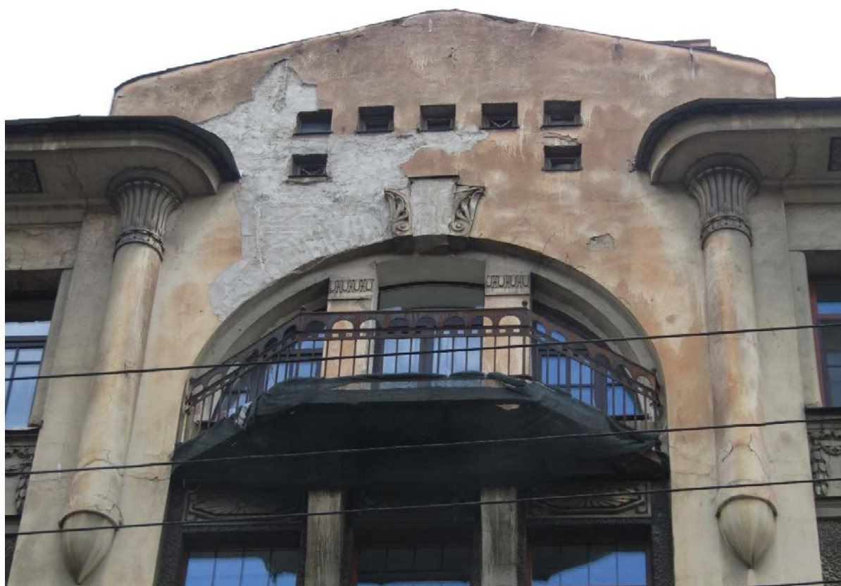
Фото 10. Вид на балкон в уровне 5-го этажа.
