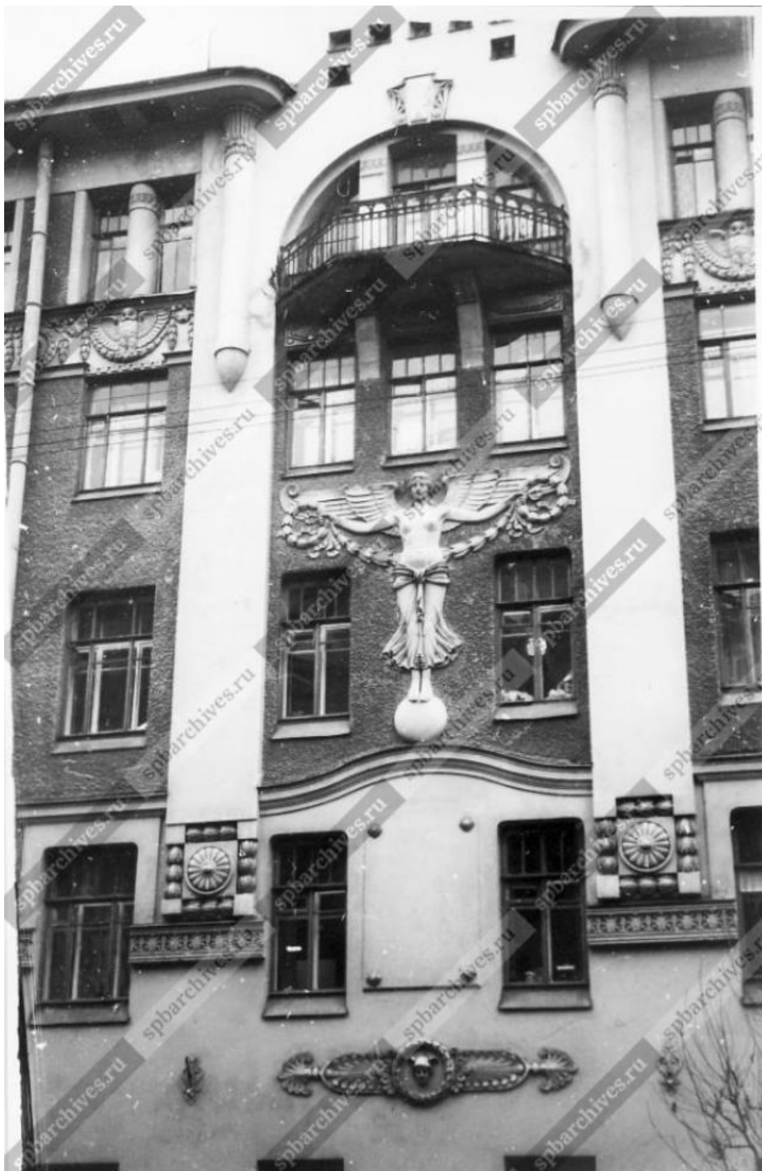
Илл. 34. Вид части фасада дома № 32 по проспекту Щорса, украшенного барельефом расправившего крылья ангела (бывший дом Товарищества для устройства жилищ при обществе воспитанников Петровского коммерческого училища (архитектор А.И. Владовский 1907-1908 гг.) (источник: ЦГАФФД СПб. Фотодокумент Ар 222481).
