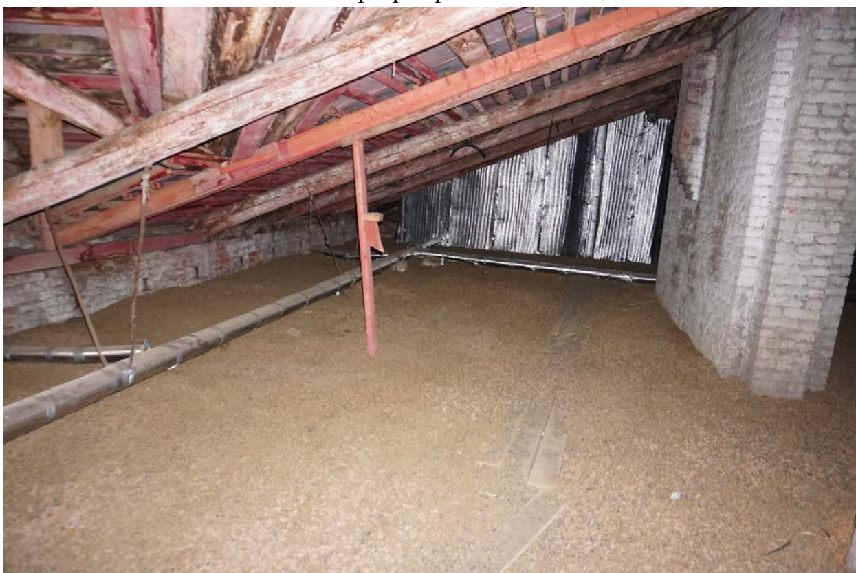
Фото 72. Интерьер чердачных помещений.
