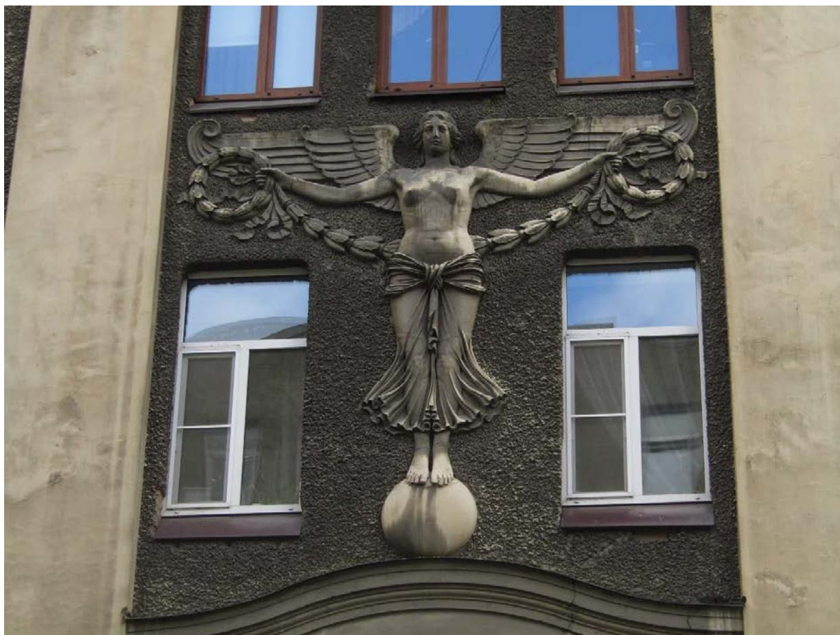
Фото 9. Лепная композиция в центральной части северного фасада.
