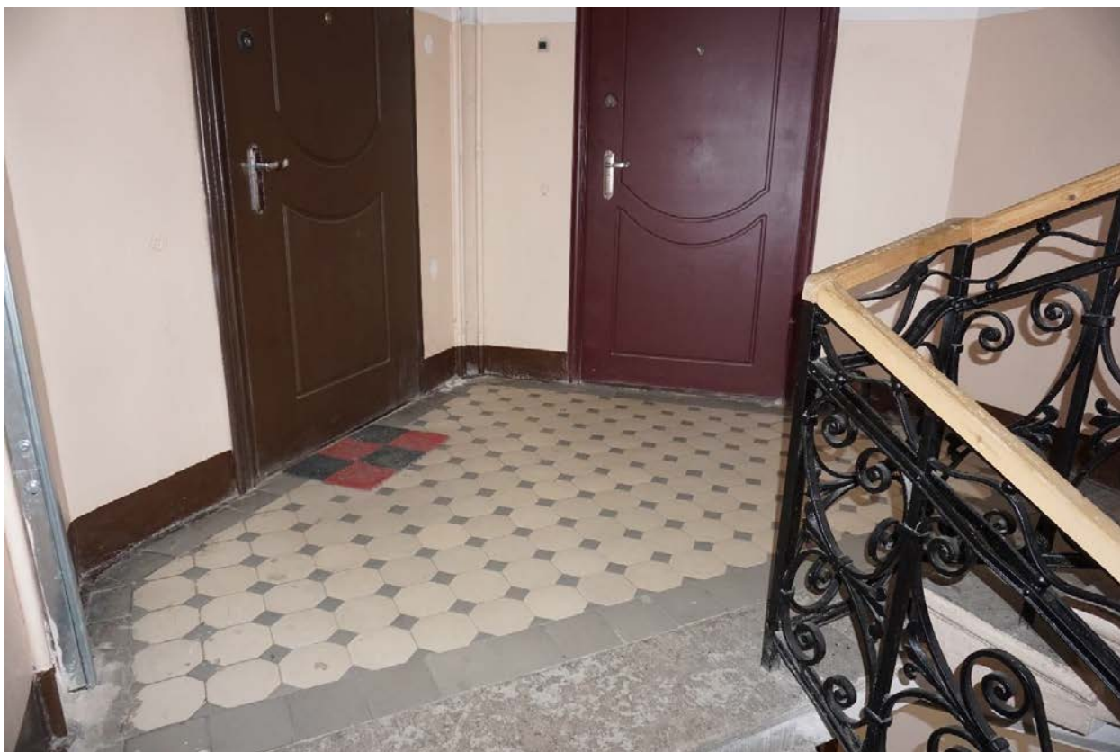
Фото 41. Вид на лестничную площадку Л-1 в уровне 2-го этажа.
