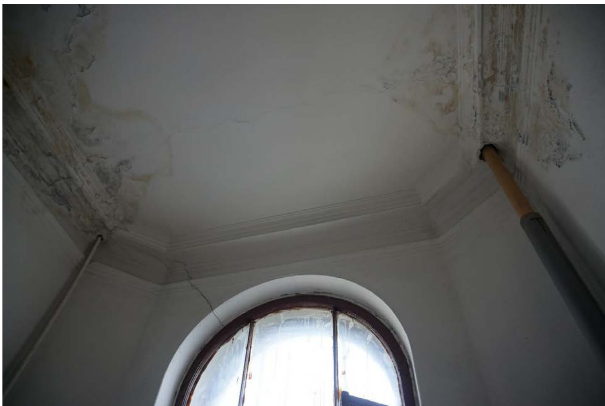
Фото 59. Вид на потолок Л-2 в уровне 5-го этажа.
