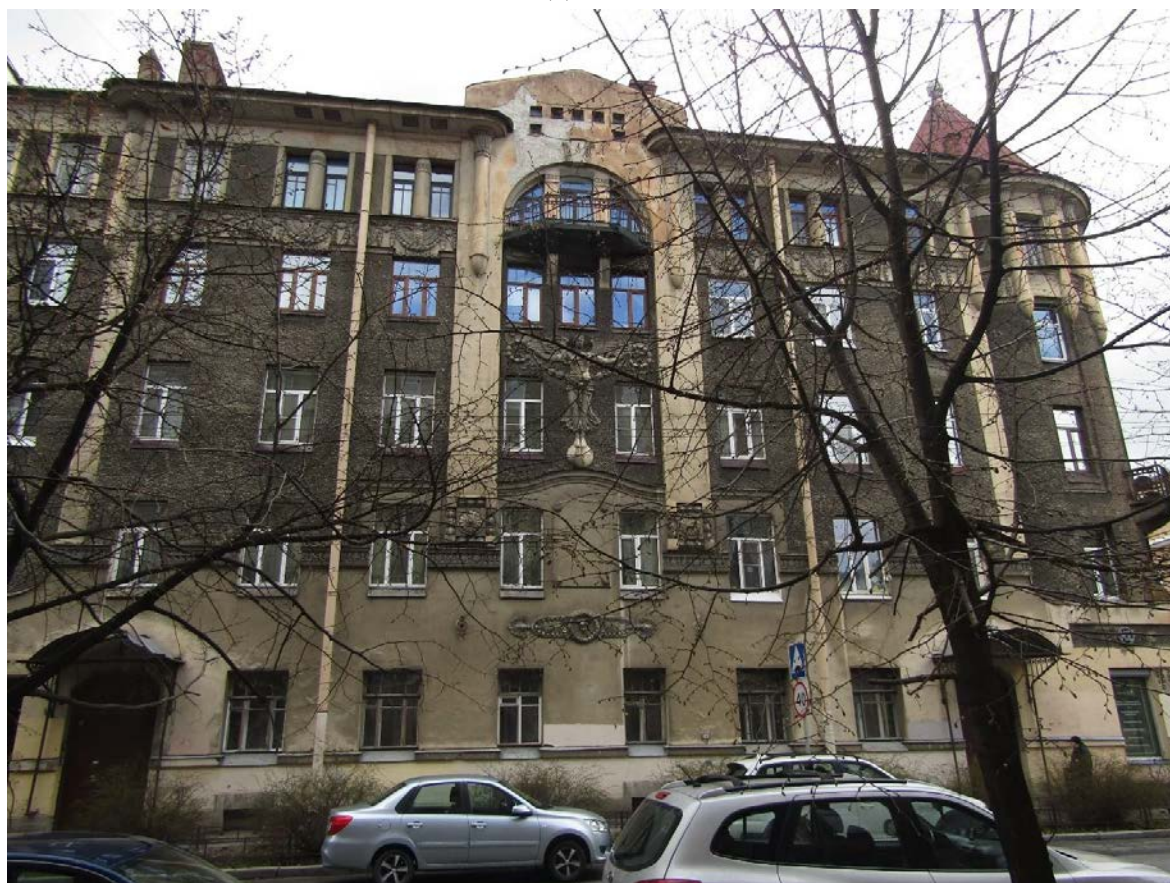
Фото 4. Вид на северный фасад.
