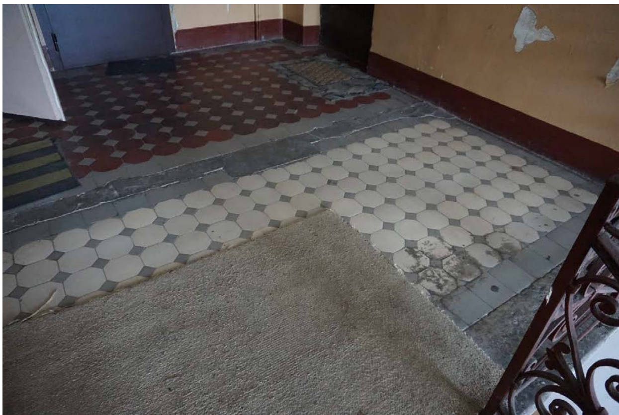
Фото 57. Вид на пол лестничной площадки Л-2 в уровне 5-го этажа.
