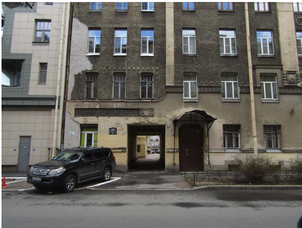
Фото 3. Северный фасад, вид на арку воротного проезда в восточной части здания.
