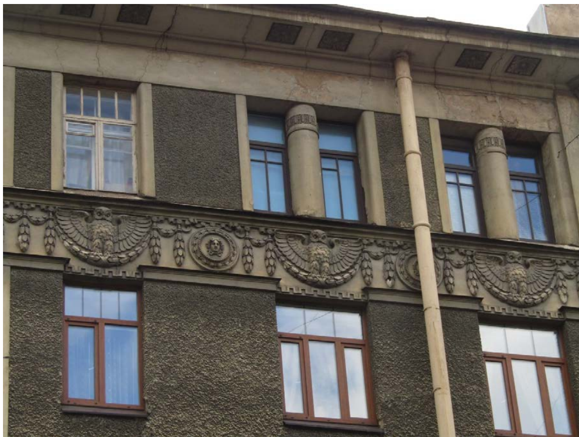
Фото 11. Вид на фриз, расположенный между оконными проемами 4-го и 5-го этажей.
