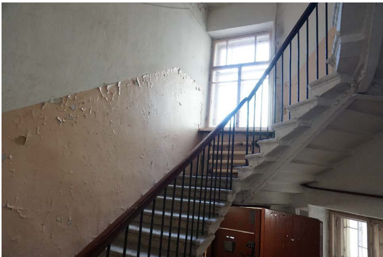
Фото 63. Вид на лестницу Л-4 в уровне 1-го этажа.
