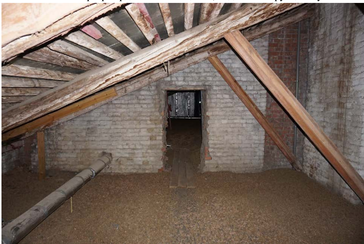
Фото 70. Интерьер чердачных помещений.
