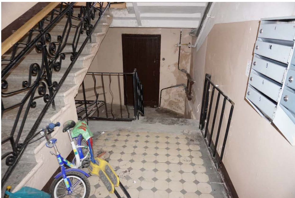
Фото 37. Лестничная клетка Л-1 в уровне 1-го этажа.
