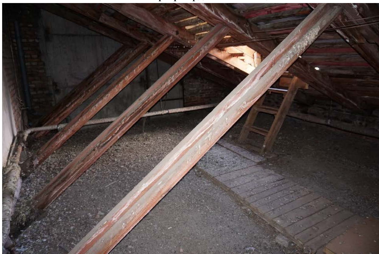
Фото 74. Интерьер чердачных помещений.
