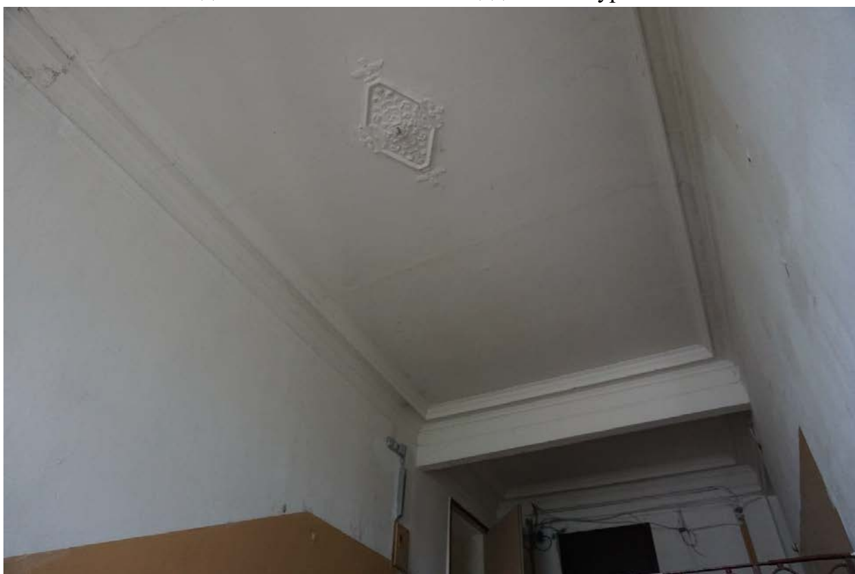
Фото 58. Вид на потолок Л-2 в уровне 5-го этажа.
