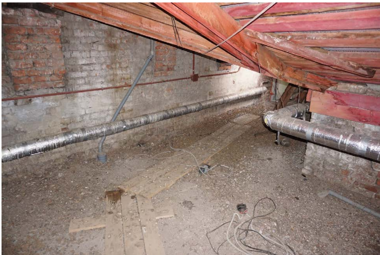
Фото 73. Интерьер чердачных помещений.
