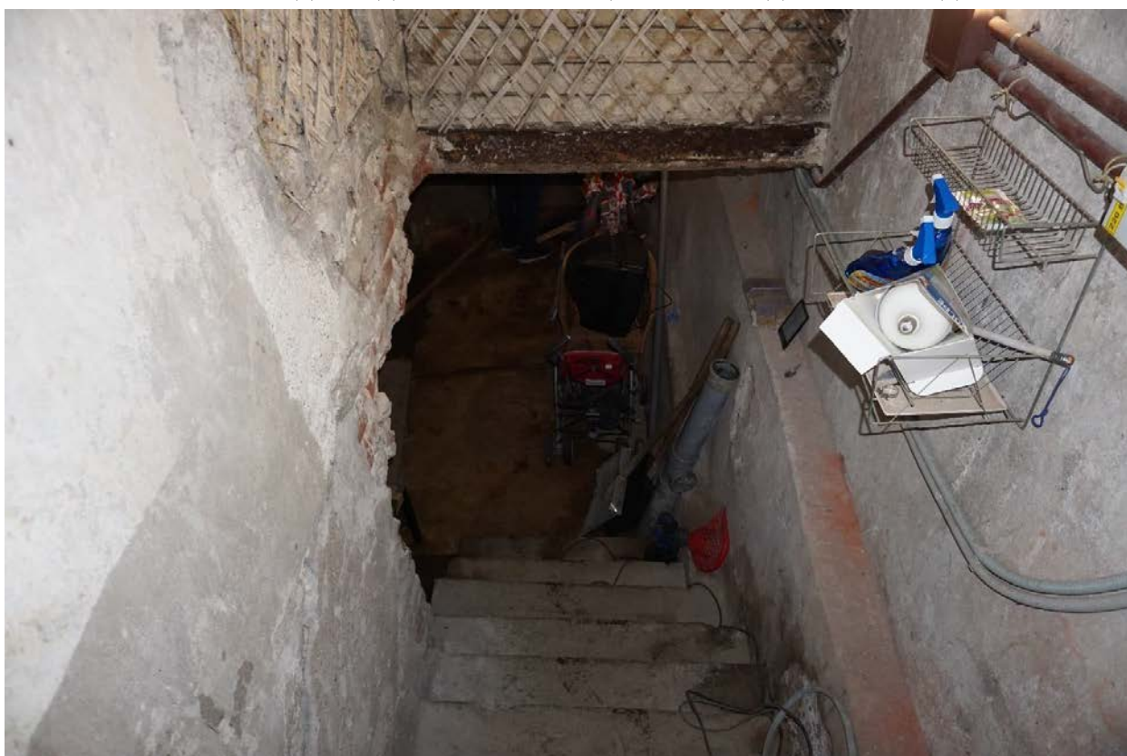
Фото 24. Спуск в подвальные помещения лестничного ризалита в центральной части здания.
