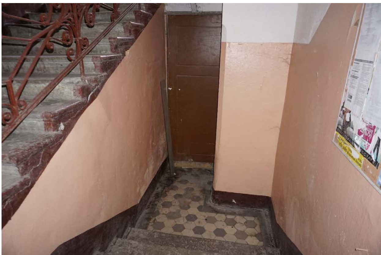
Фото 52. Интерьер лестничной клетки Л-2 в уровне 1-го этажа.
