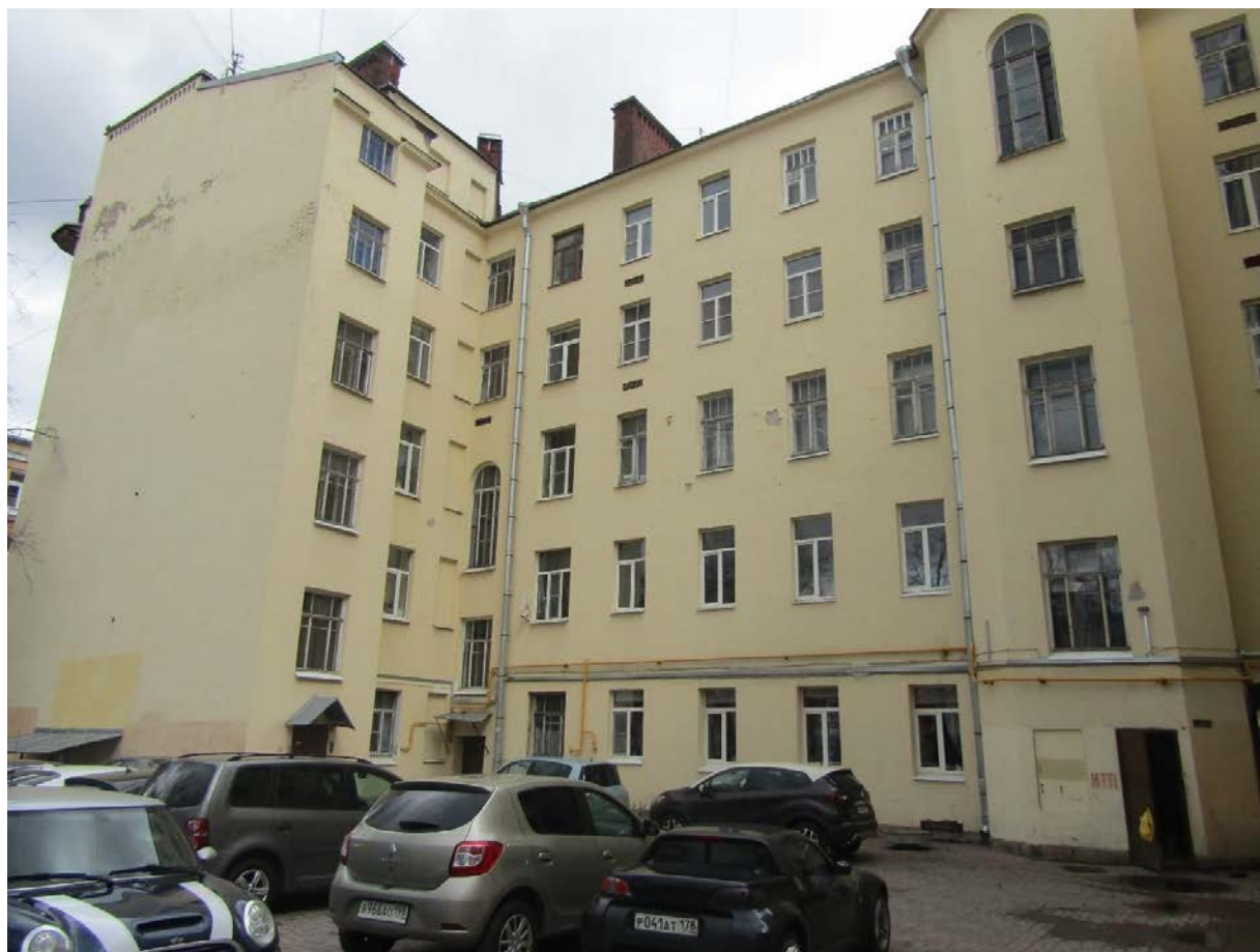
Фото 21. Вид на дворовые фасады, западная часть здания.
