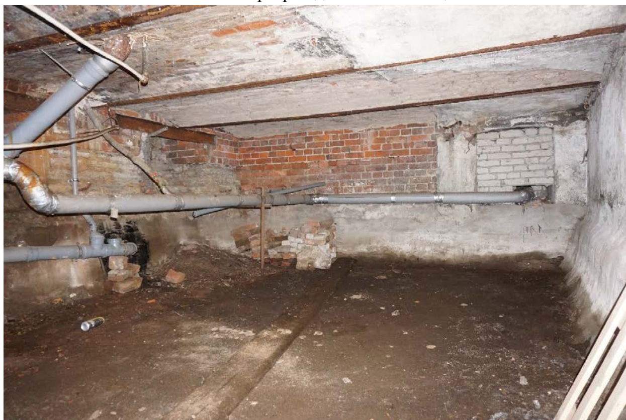
Фото 26. Интерьер подвальных помещений.
