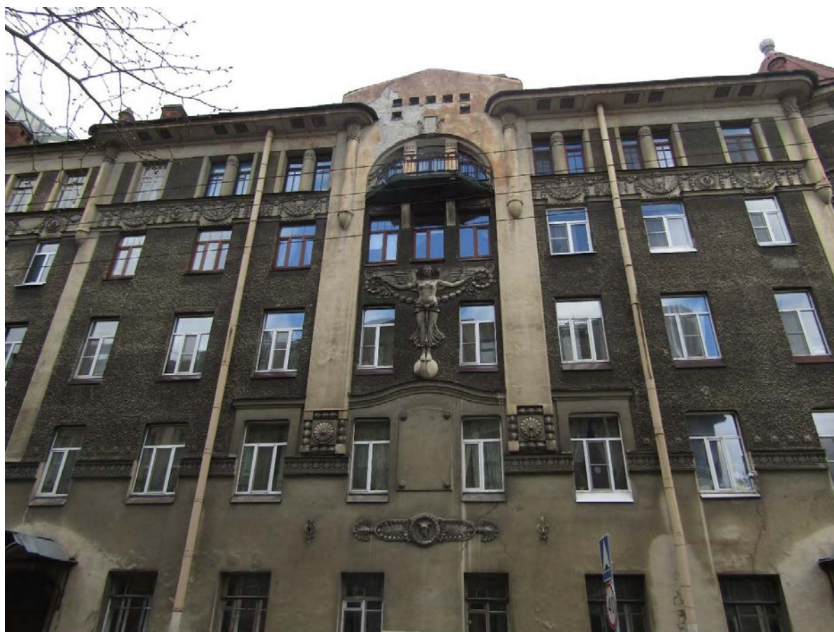
Фото 7. Северный фасад, центральная часть.
