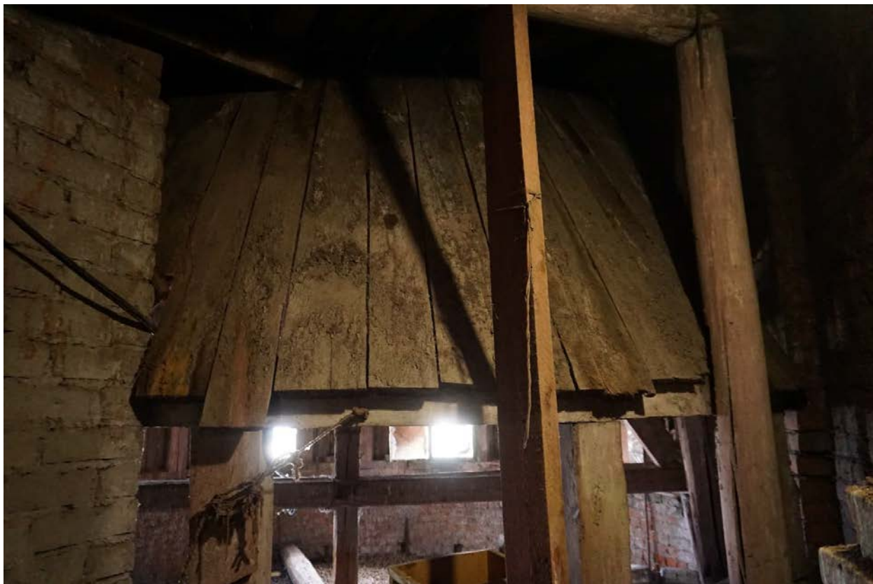
Фото 67. Интерьер чердачных помещений, вид на купол.
