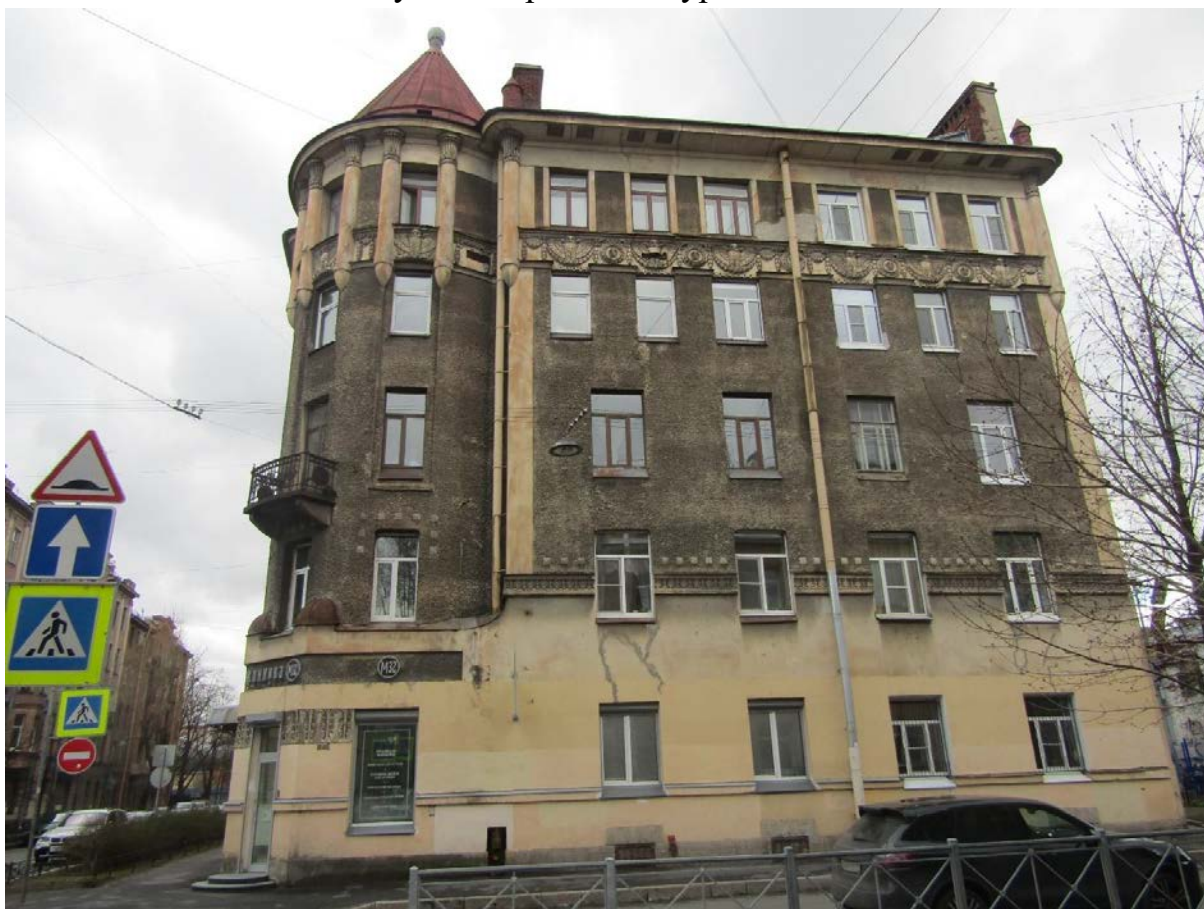
Фото 16. Вид на западный фасад.
