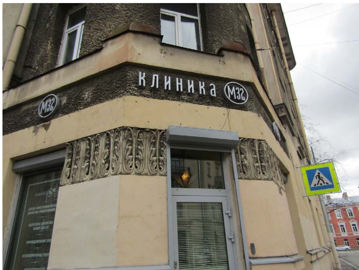
Фото 13. Вид на угловой ризалит в уровне 1-го – 2-го этажей.
