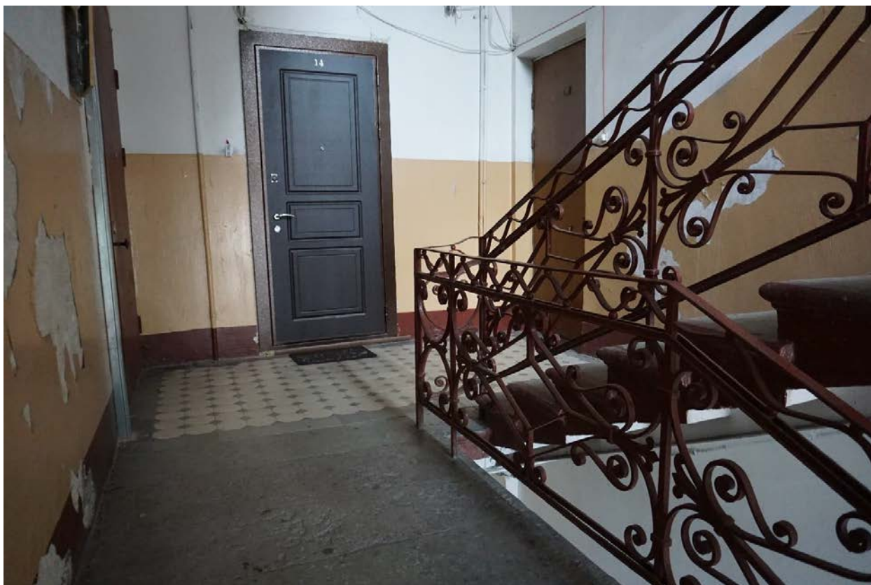
Фото 55. Вид на лестничную площадку Л-2 в уровне 2-го этажа.
