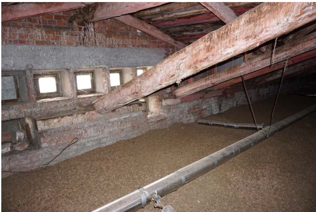
Фото 71. Интерьер чердачных помещений.
