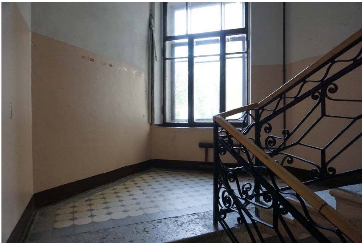
Фото 39. Вид на междуэтажную площадку Л-1 в уровне 1-го и 2-го этажей.
