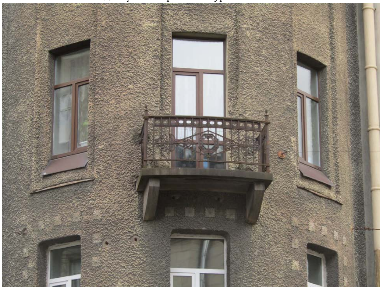
Фото 14. Вид на балкон в уровне 3-го этажа углового ризалита.
