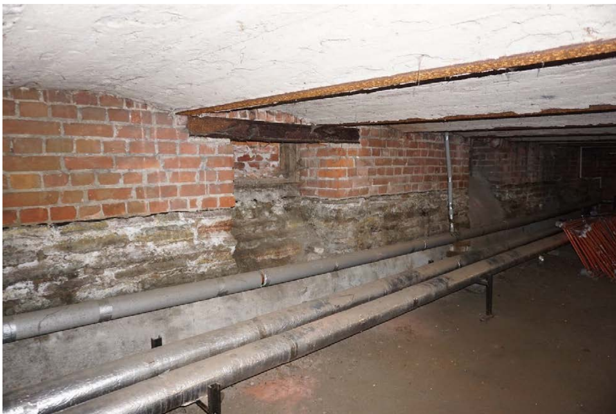
Фото 25. Интерьер подвальных помещений.
