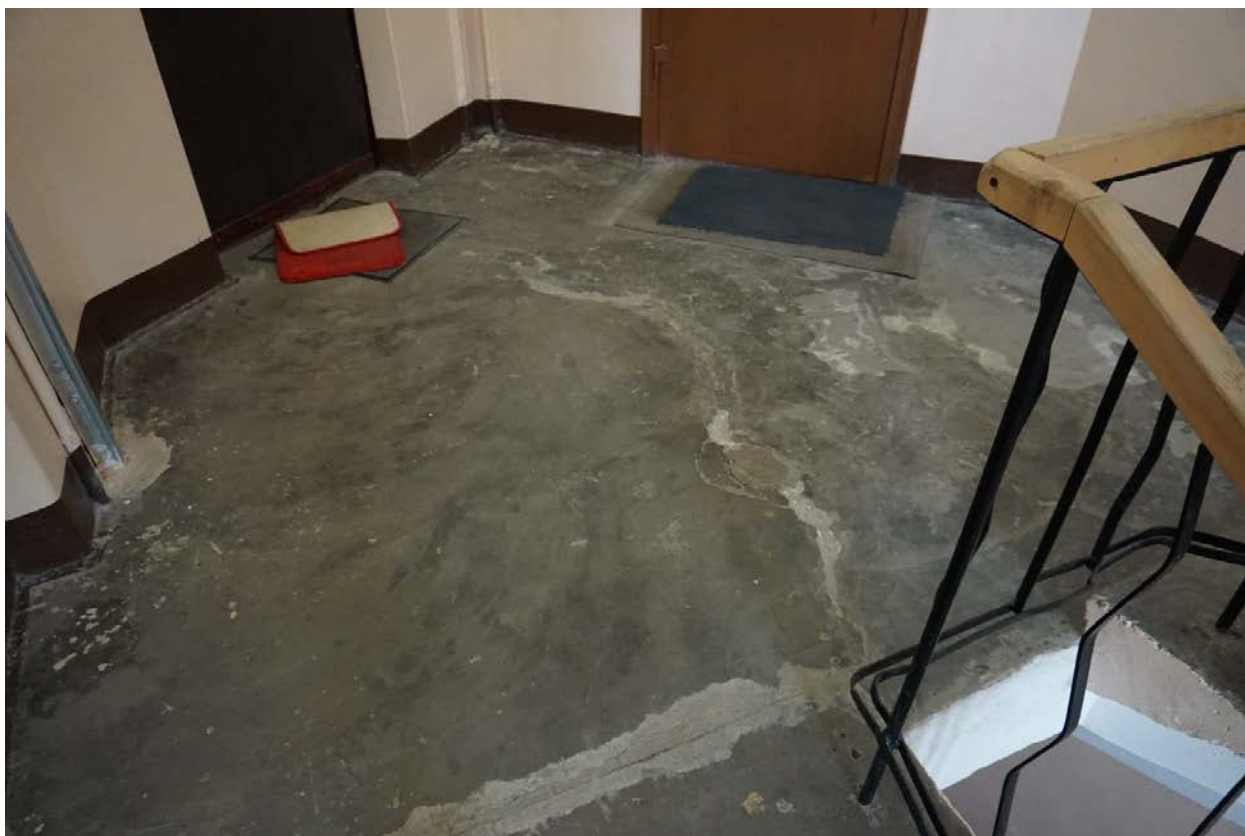
Фото 45. Вид на лестничную площадку Л-1 в уровне 4-го этажа.
