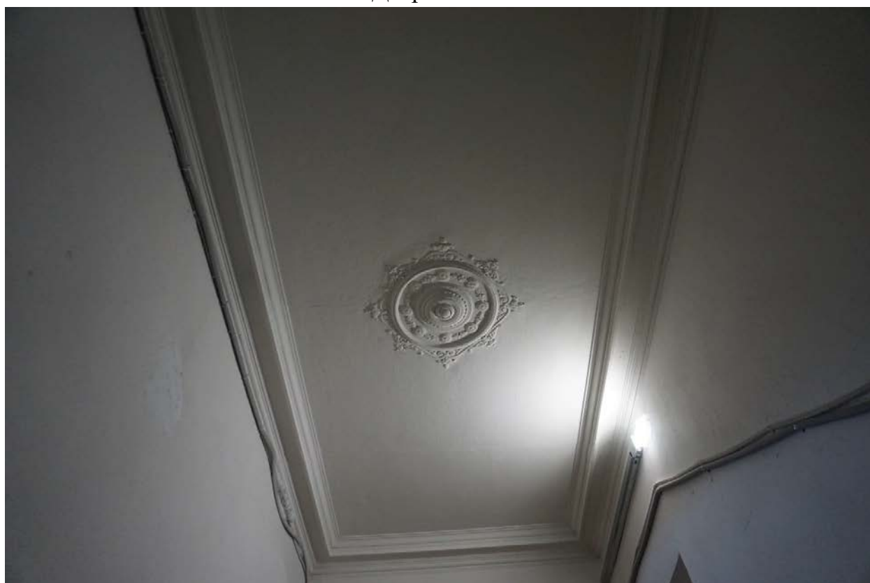
Фото 34. Потолок вестибюля Л-1.
