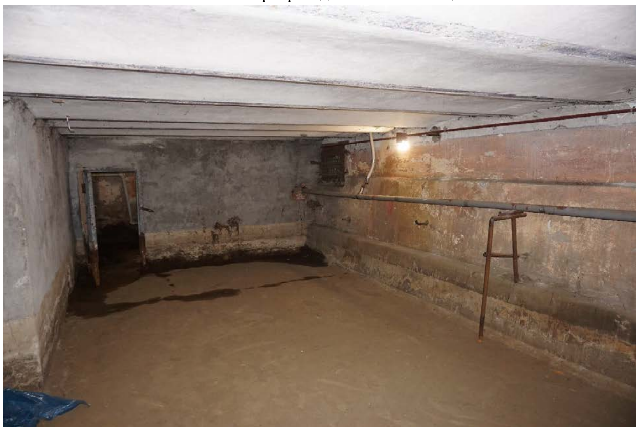
Фото 30. Интерьер подвальных помещений.
