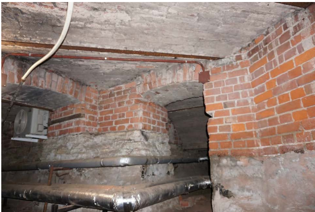
Фото 27. Интерьер подвальных помещений.
