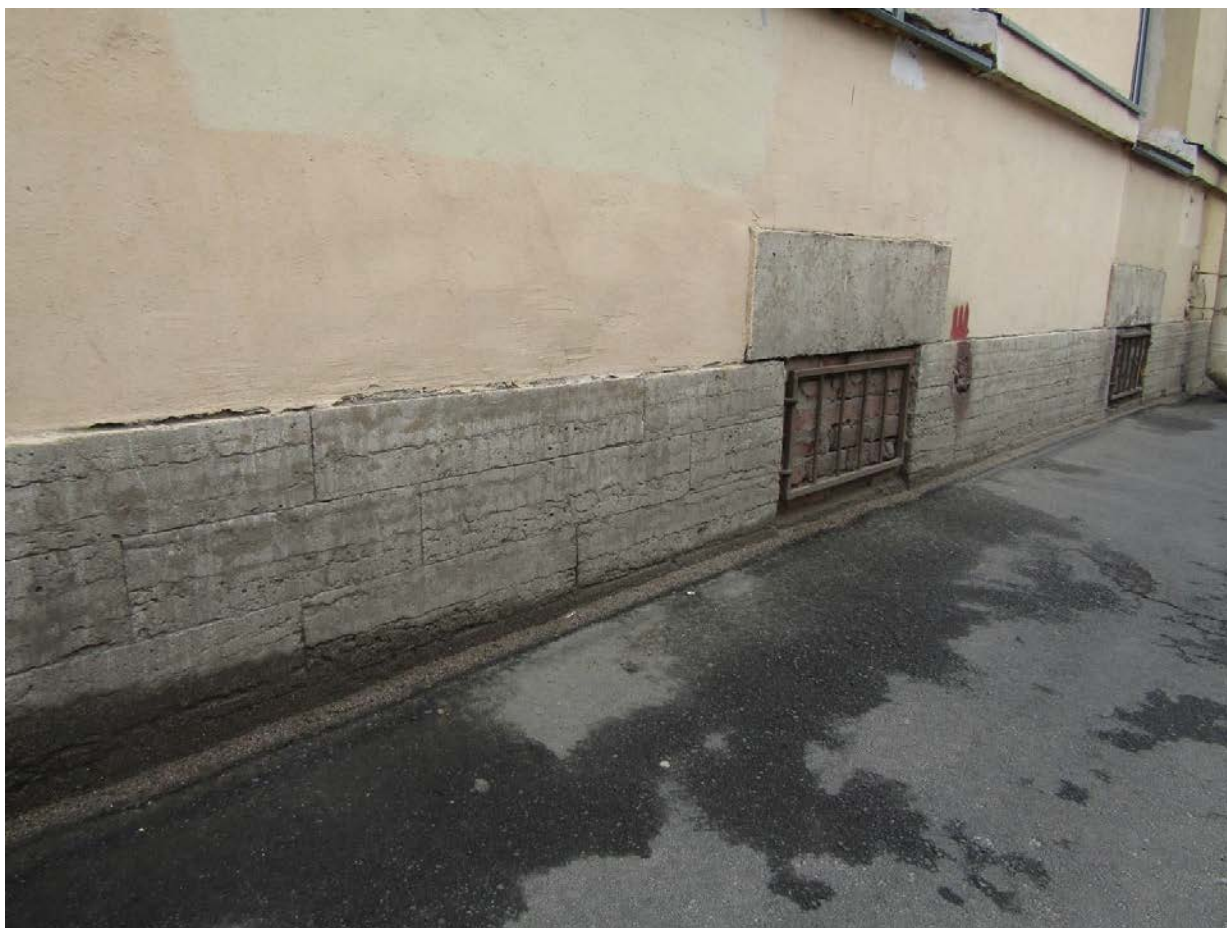
Фото 17. Вид на цоколь западного фасада.
