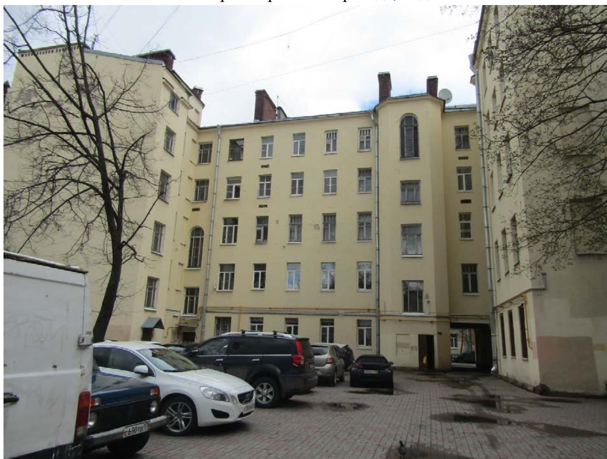
Фото 20. Дворовые фасады, общий вид.
