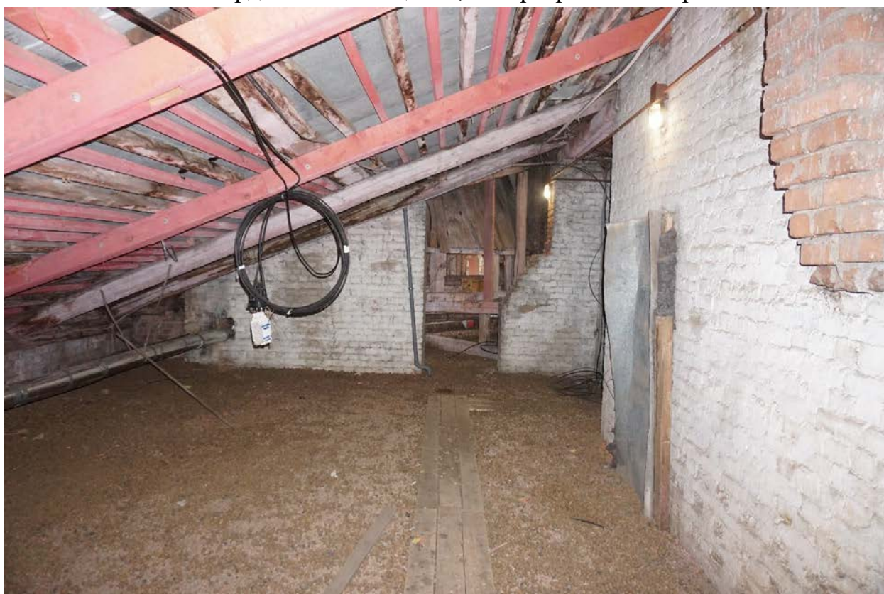
Фото 66. Интерьер чердачных помещений.
