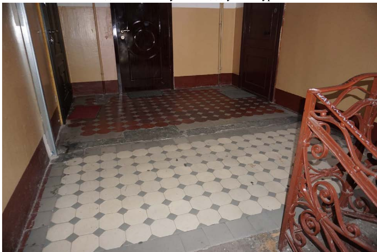
Фото 56. Вид на пол лестничной площадки Л-2 в уровне 4-го этажа.
