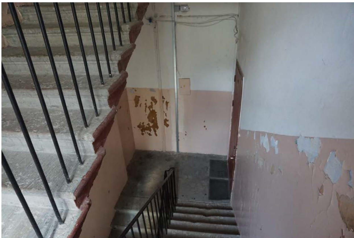
Фото 61. Вид на лестничную площадку Л-3 в уровне 3-го этажа.
