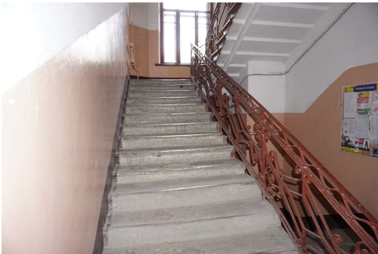
Фото 53. Вид на лестницу Л-2 в уровне 1-го этажа.
