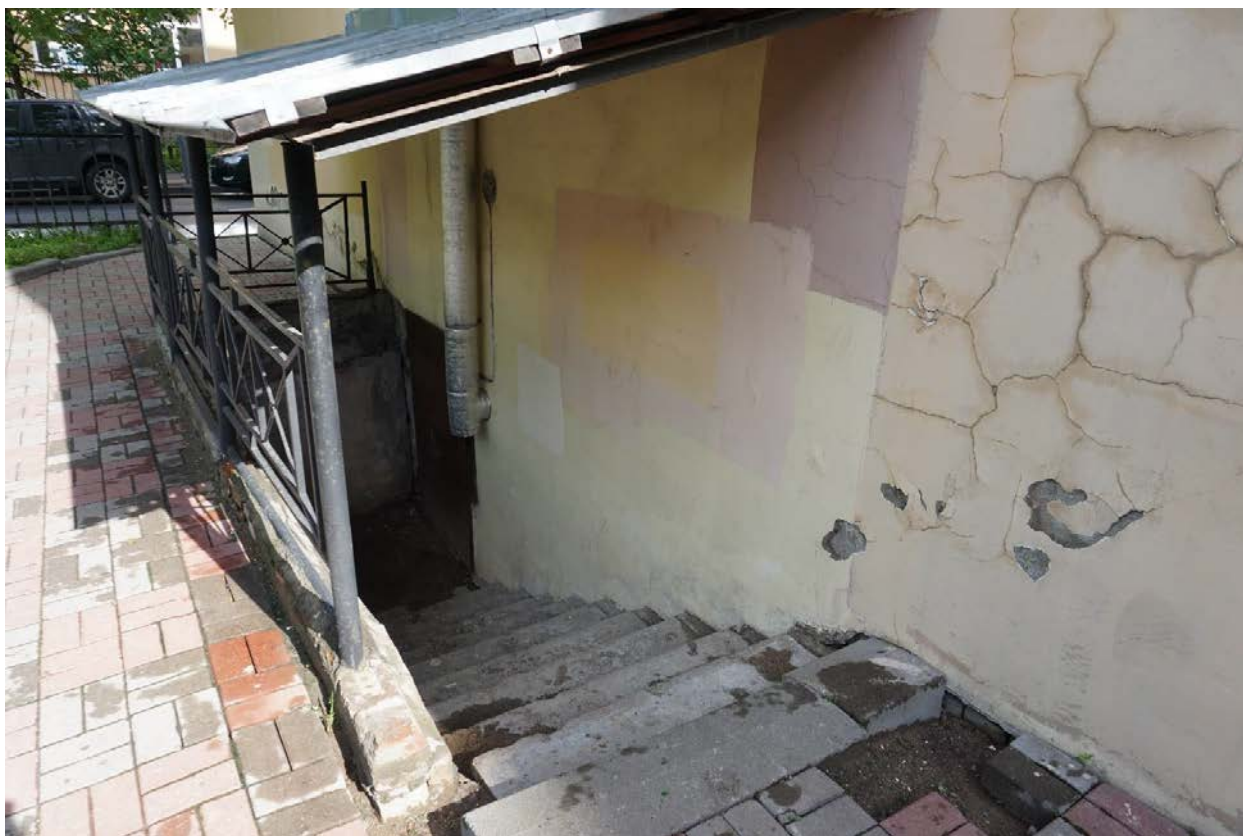
Фото 23. Вход в подвальные помещения в западной части здания.
