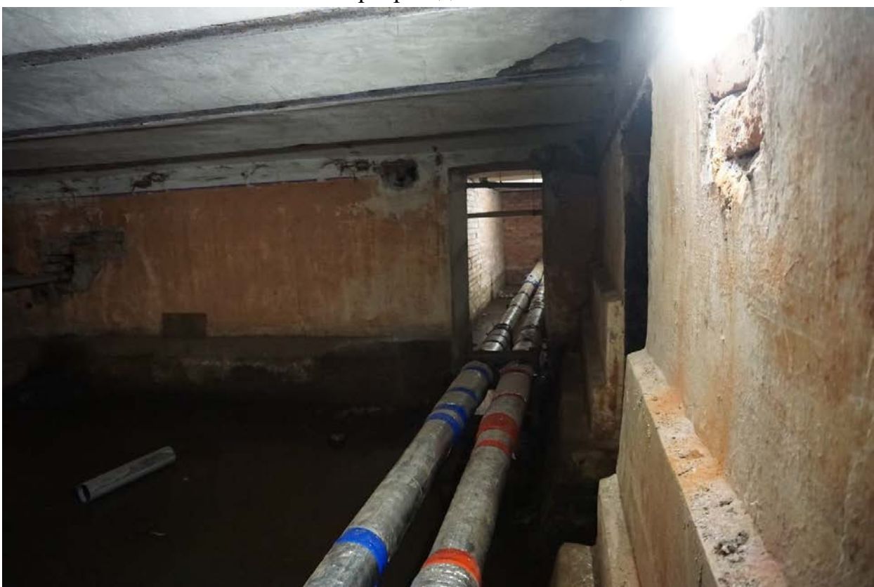
Фото 28. Интерьер подвальных помещений.
