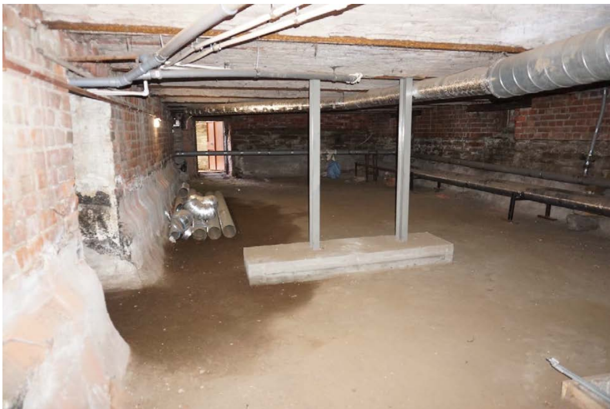
Фото 29. Интерьер подвальных помещений.
