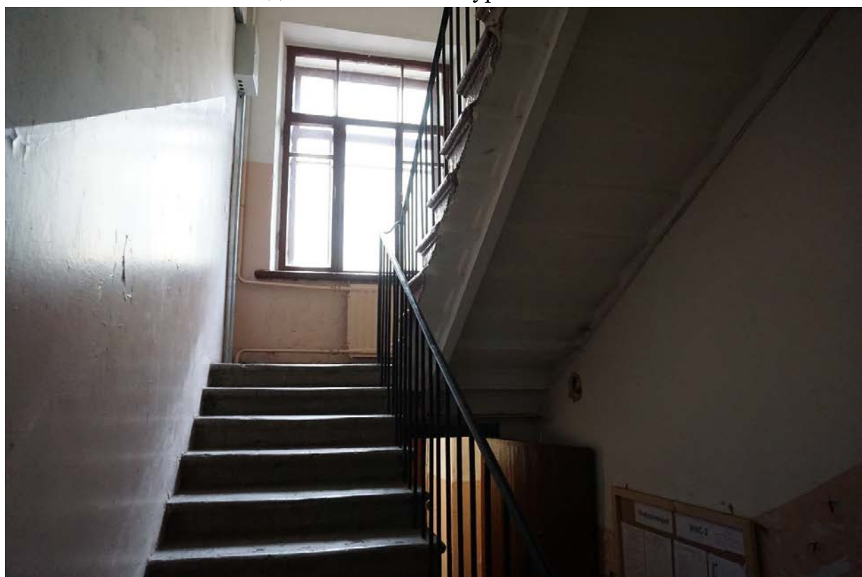
Фото 60. Вид на лестницу Л-3 в уровне 1-го этажа.
