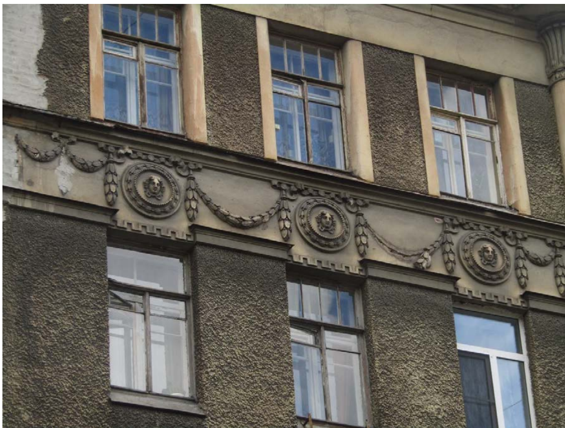
Фото 12. Вид на фриз, расположенный между оконными проемами 4-го и 5-го этажей в восточной части северного фасада.
