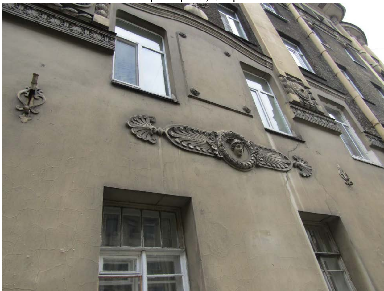
Фото 8. Северный фасад, центральная часть в уровне 1-го – 2-го этажей.
