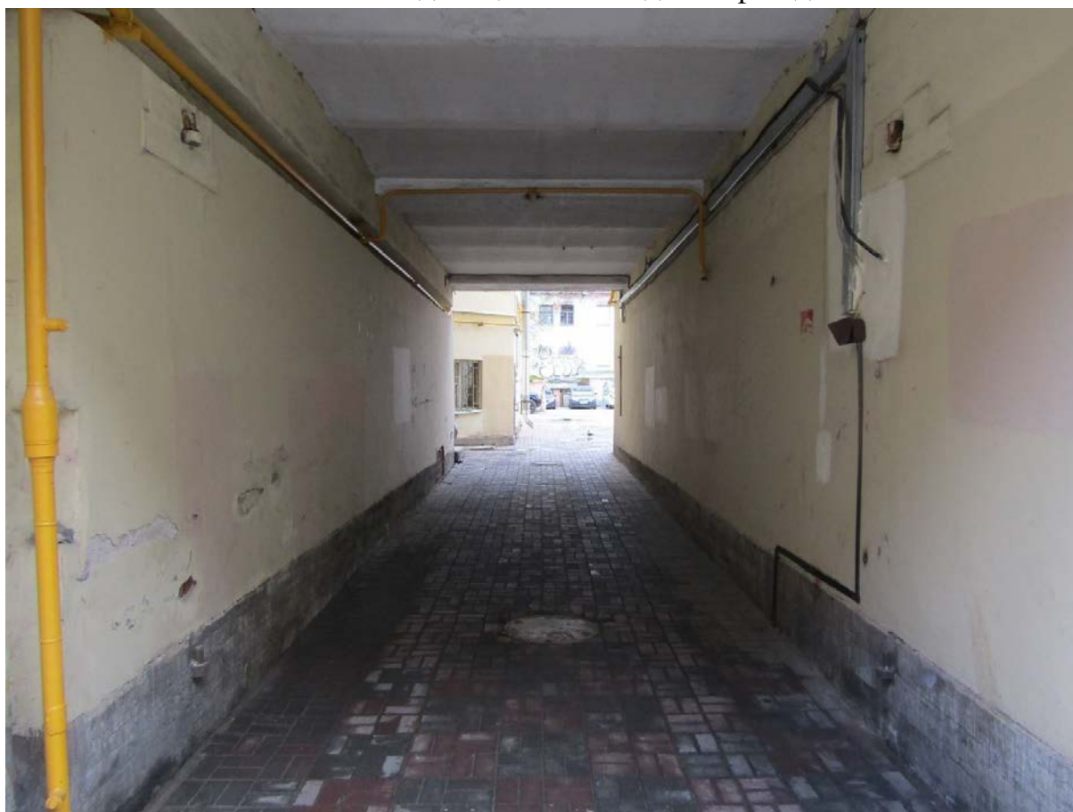
Фото 18. Арка воротного проезда, вид с севера.
