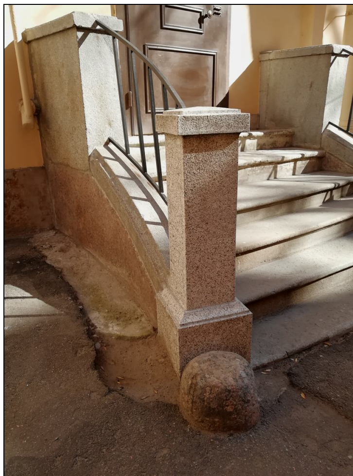
19. Двор. Крыльцо с боковыми устоями из гранита (вход на лестницу 3-ЛК). Дата съемки: 20 октября 2020 г. Фотограф: В. П. Орлов.
