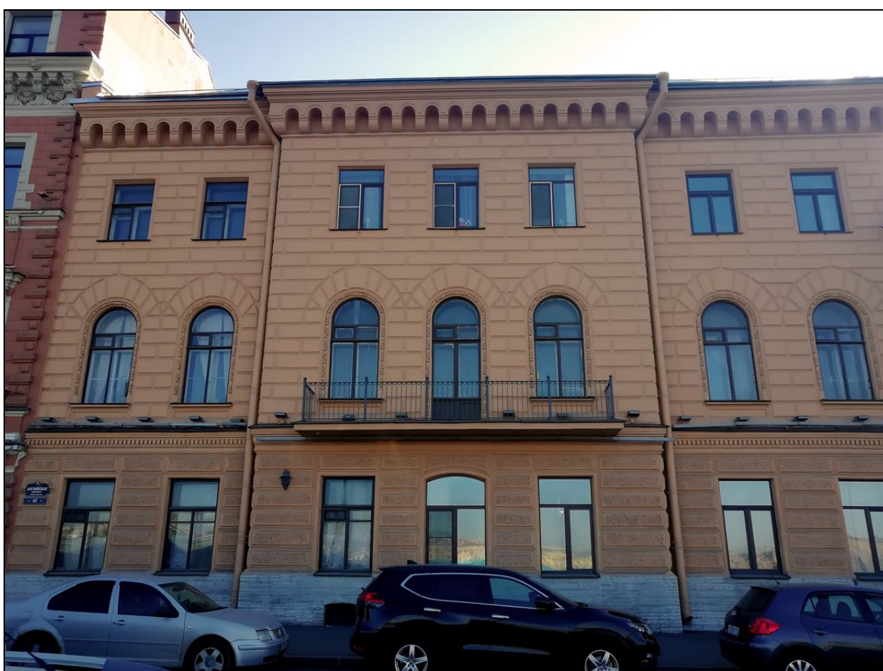
3. Лицевой фасад дома по Английской набережной. Дата съемки: 20 октября 2020 г. Фотограф: В. П. Орлов.
