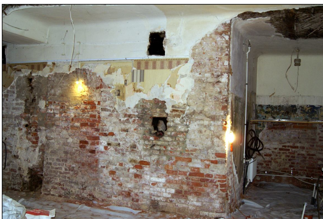
25. Квартира № 28. Вид на санузел (пом. 2/5,1 и 3/1,3) после демонтажа перегородки. Дата съемки: 20 октября 2020 г. Фотограф: В. П. Орлов.
