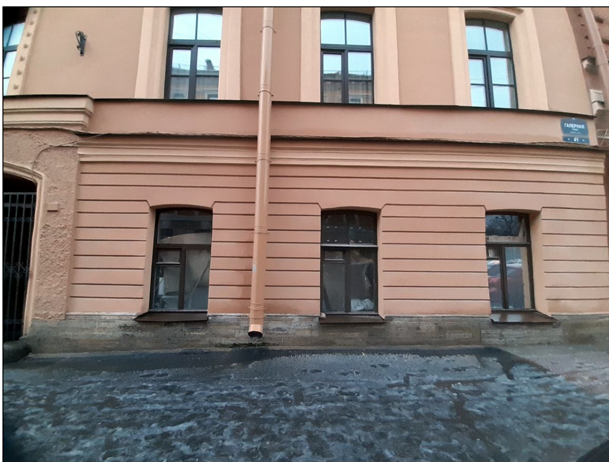
11. Восточная часть 1-го этажа лицевого фасада по Галерной улице. Дата съемки: 20 октября 2020 г. Фотограф: В. П. Орлов.
