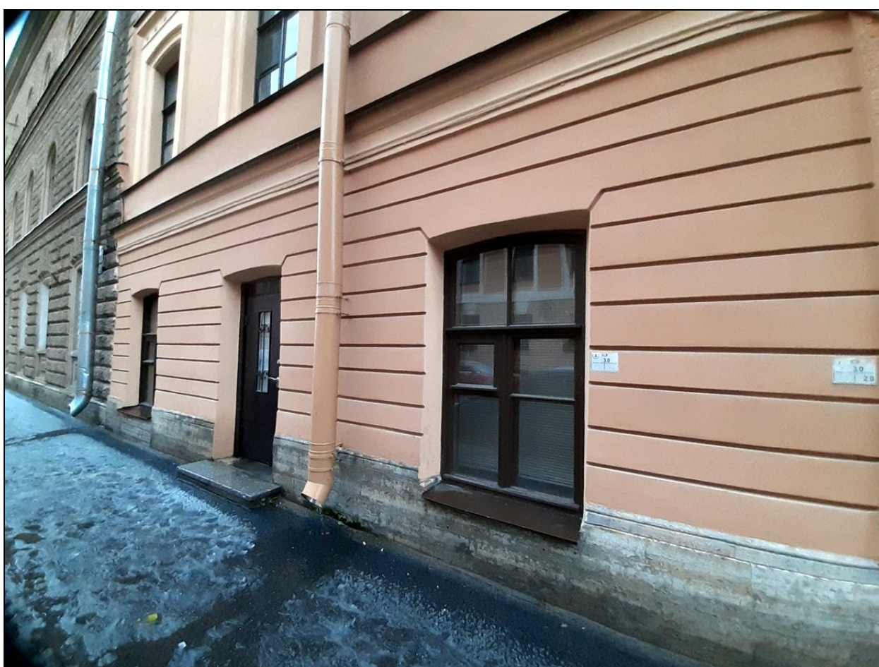
10. Западная часть 1-го этажа лицевого фасада по Галерной улице. Дата съемки: 20 октября 2020 г. Фотограф: В. П. Орлов.
