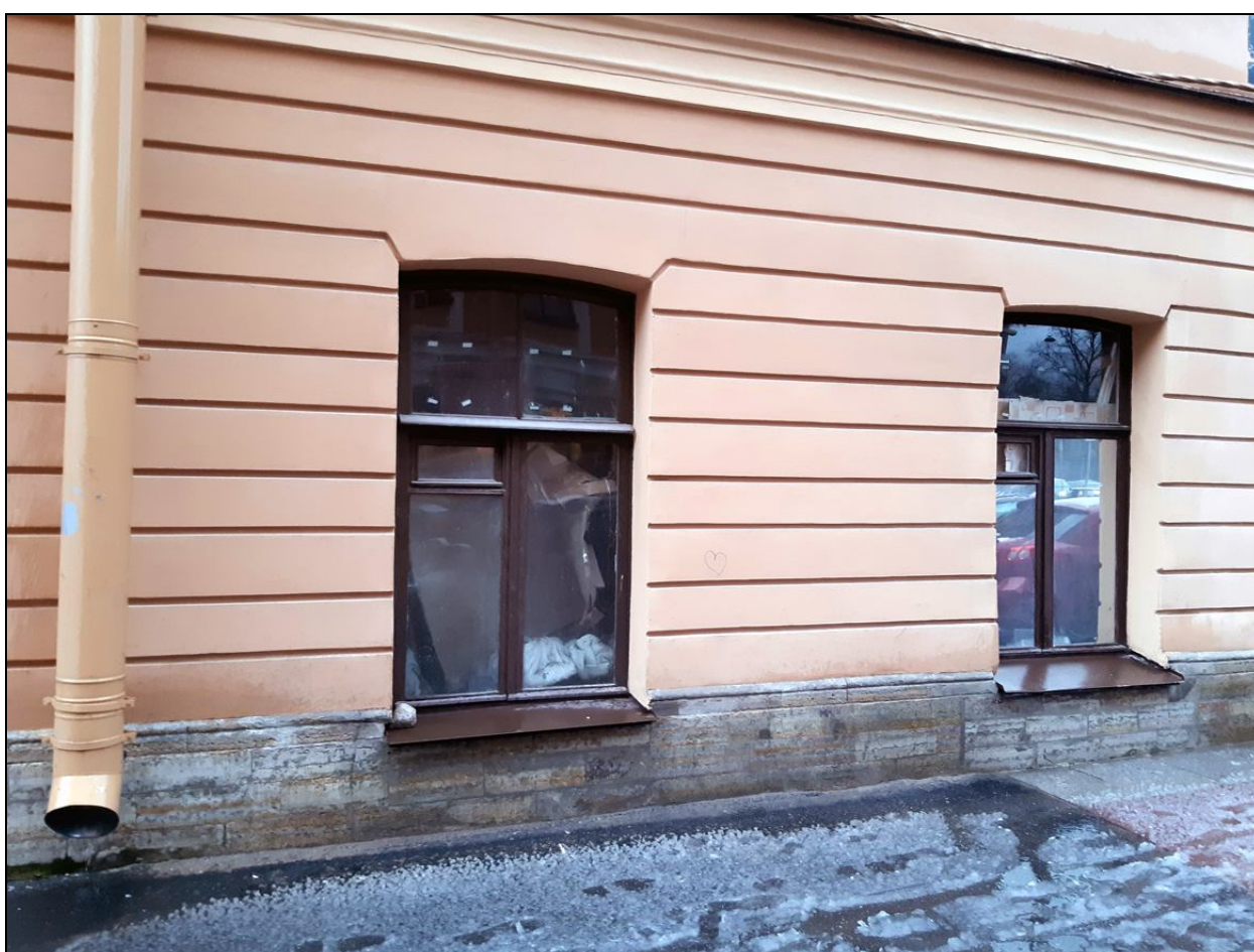
12. Лицевой фасад по Галерной улице. Оконные проемы 1-го этажа по 6-й и 7-й оконным осям. Дата съемки: 20 октября 2020 г. Фотограф: В. П. Орлов.
