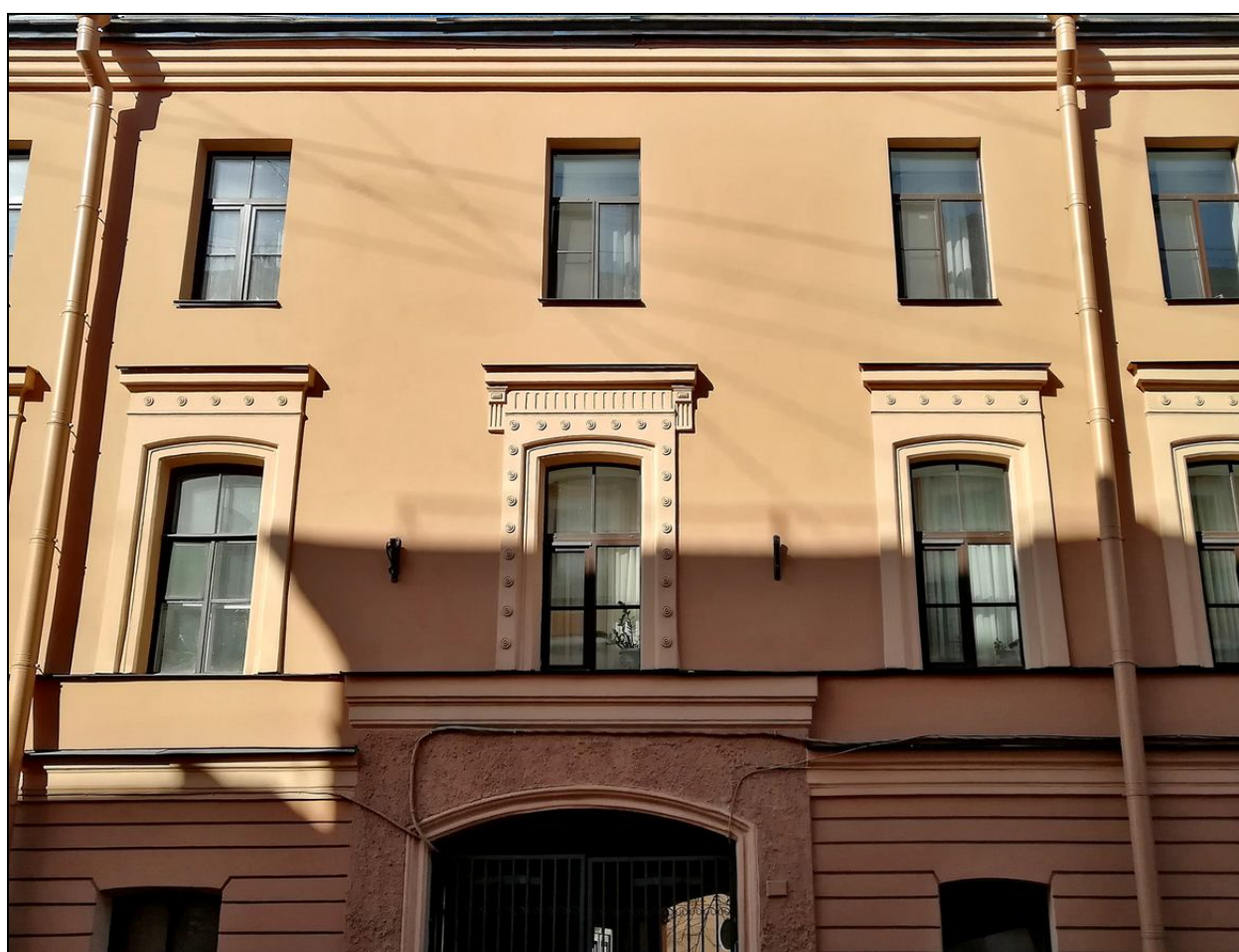
13. Центральная часть лицевого фасада по Галерной улице в уровне 2–3 этажей. Дата съемки: 20 октября 2020 г. Фотограф: В. П. Орлов.
