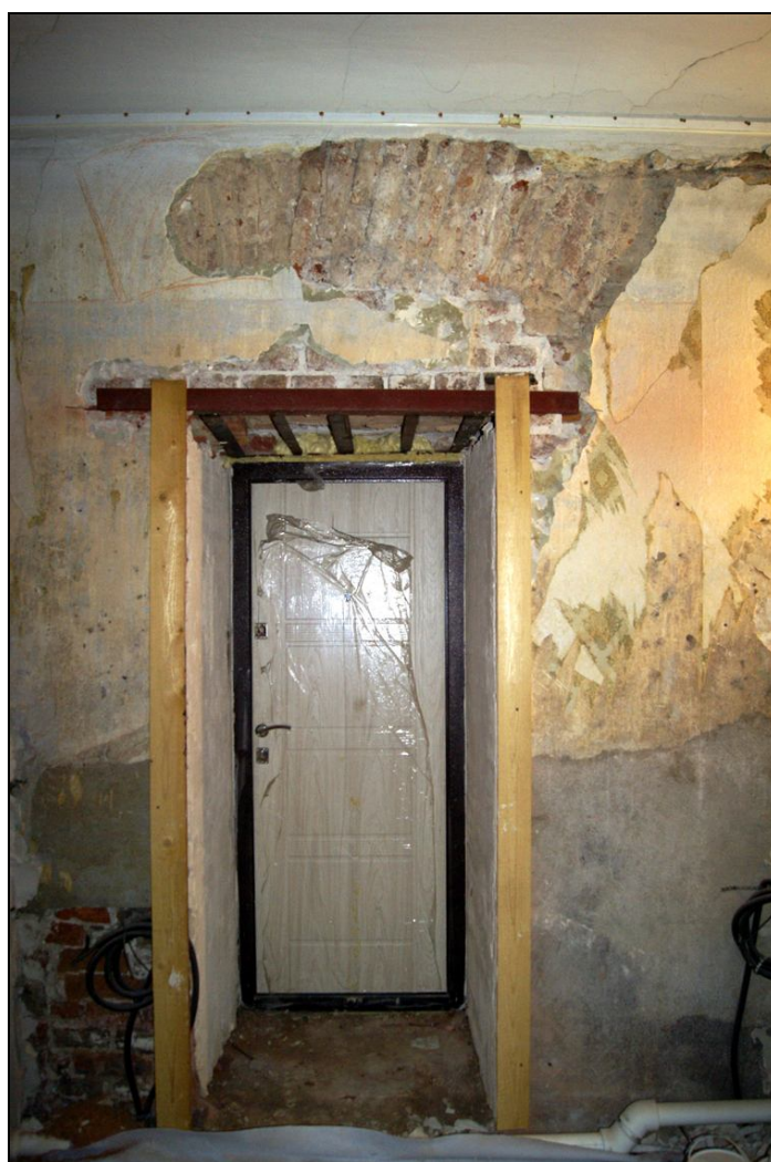
27. Квартира № 28. Пом. 6/13,3. Вновь раскрытый дверной проем. Над стальной перемычкой виден арочный кирпичный свод исторического проема. Дата съемки: 20 октября 2020 г. Фотограф: В. П. Орлов.
