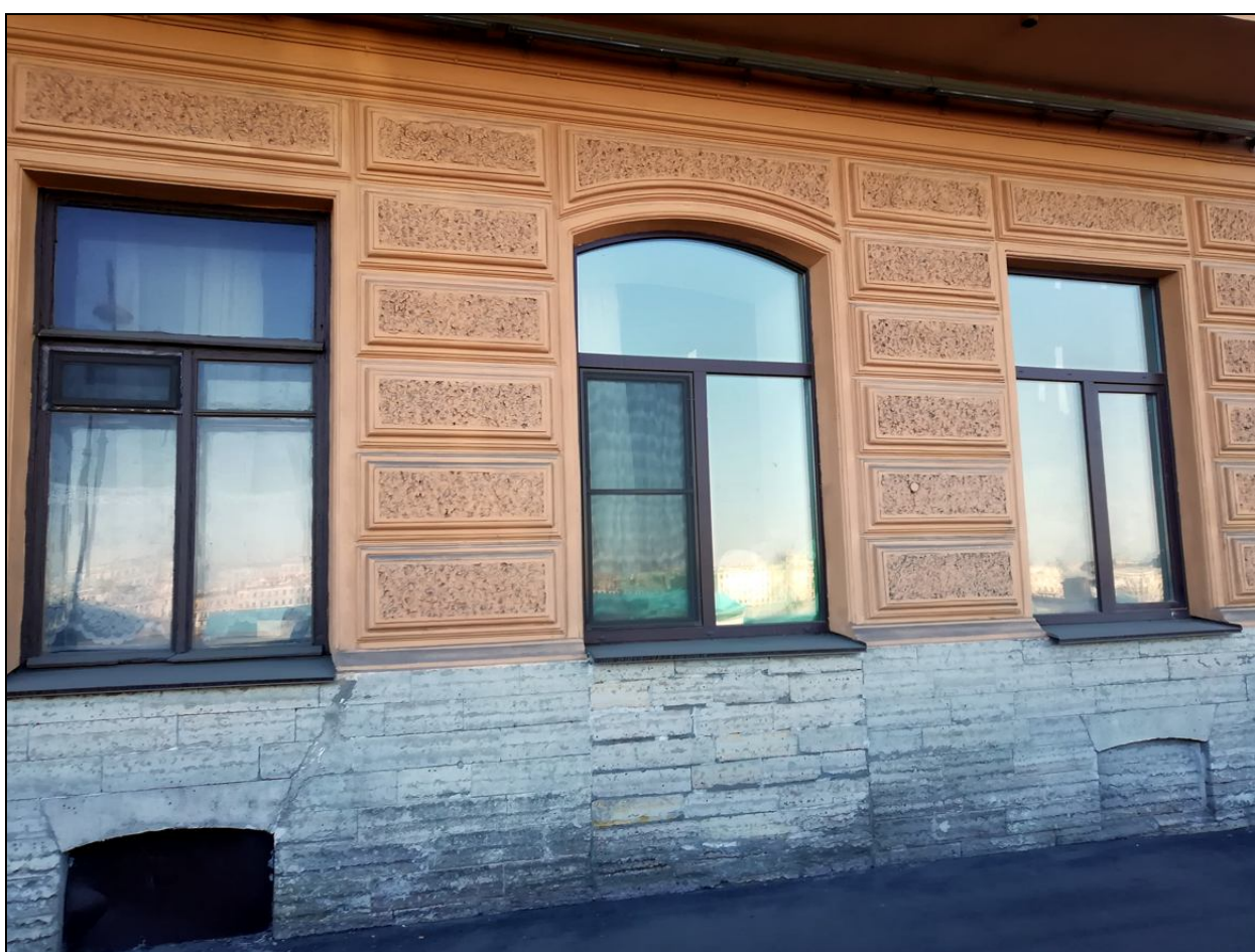
5. Фрагмент 1-го этажа лицевого фасада по Английской набережной (по 3–5-й оконным осям). Дата съемки: 20 октября 2020 г. Фотограф: В. П. Орлов.
