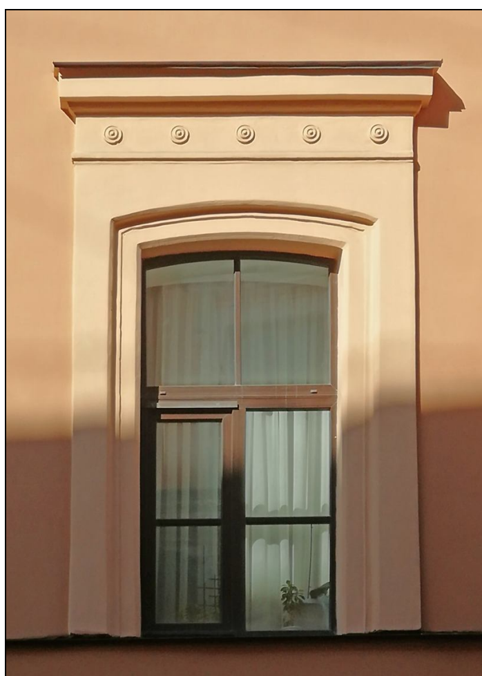
15. Лицевой фасад по Галерной улице. Оформление оконного проема 2-го этажа по 5-й оконной оси. Дата съемки: 20 октября 2020 г. Фотограф: В. П. Орлов.
