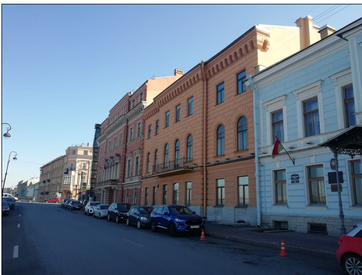
1. Вид объекта культурного наследия регионального значения «Дом Г. Томсена (В. И. Асташева)», расположенного по адресу: Санкт-Петербург, Галерная ул., 41, литера А; Английская наб., 40, в застройке Английской набережной. Дата съемки: 20 октября 2020 г. Фотограф: В. П. Орлов.
