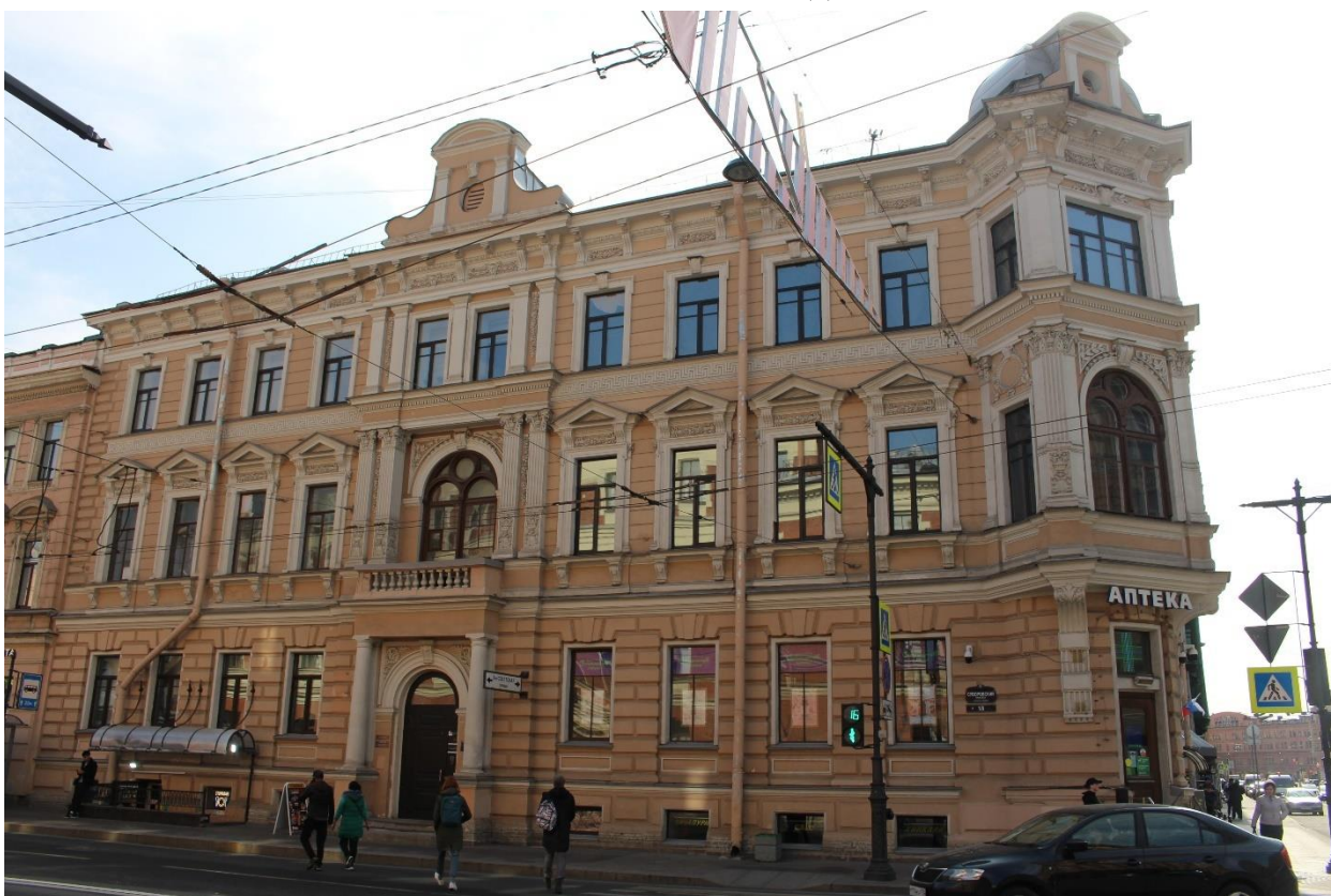
Фото 2. Вид на лицевой (северо-западный) фасад.
