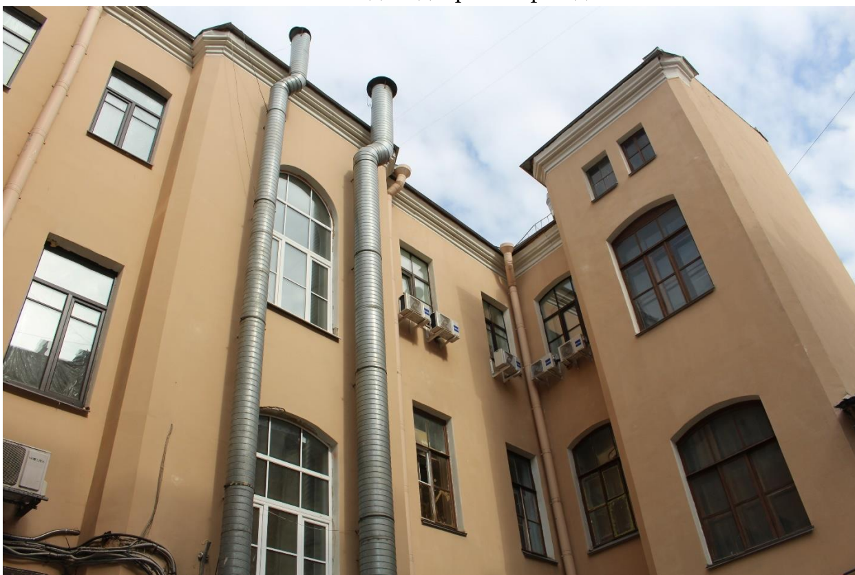
Фото 6. Вид на оконные проемы квартиры № 6 со стороны дворового фасада.
