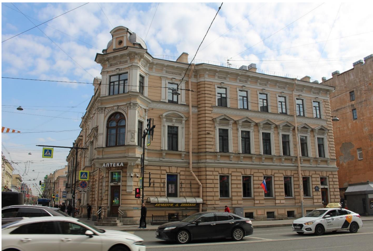
Фото 3. Вид на лицевой (юго-западный) фасад.
