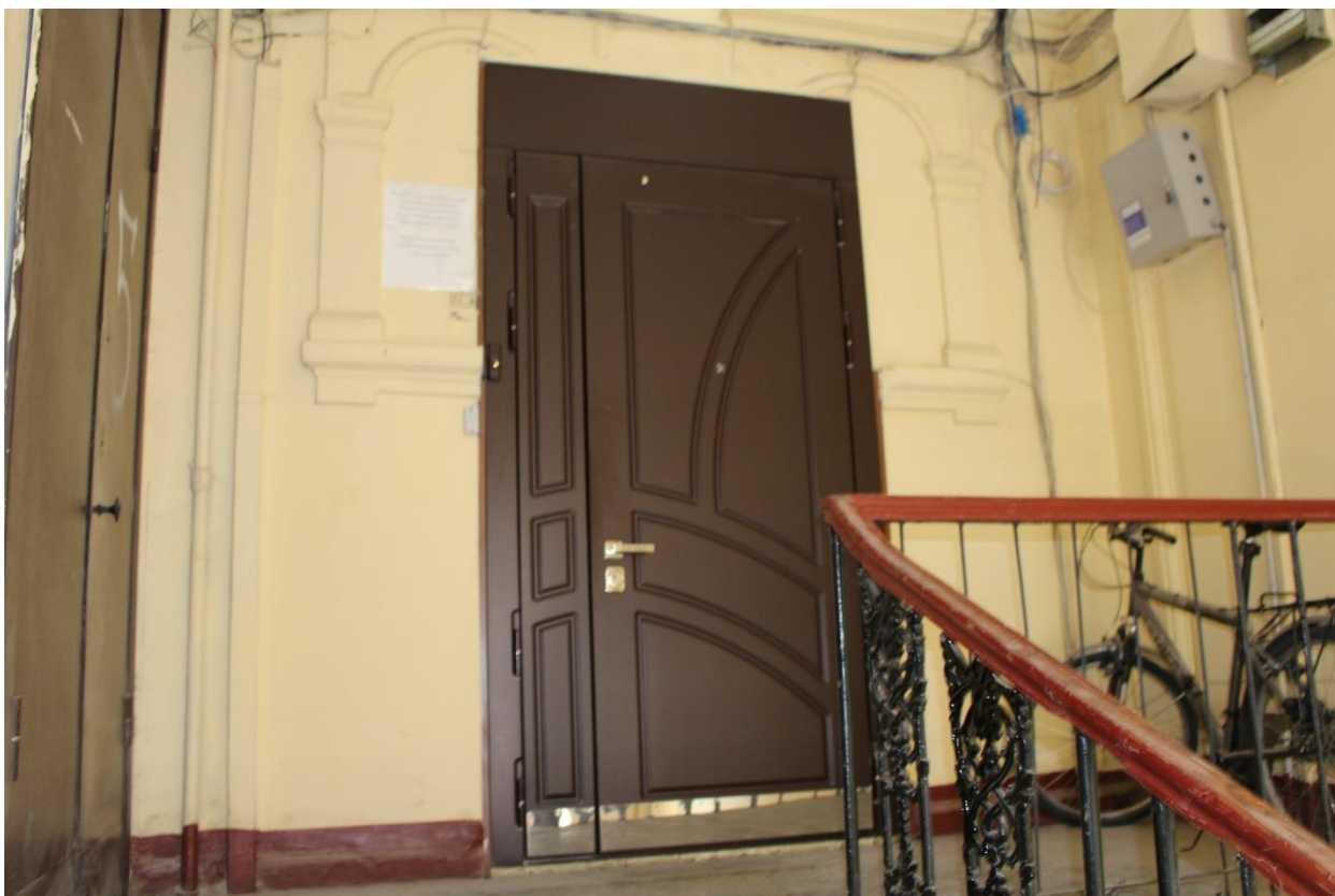
Фото 7. Вид на вход в квартиру № 6 из лестничной клетки 1ЛК.
