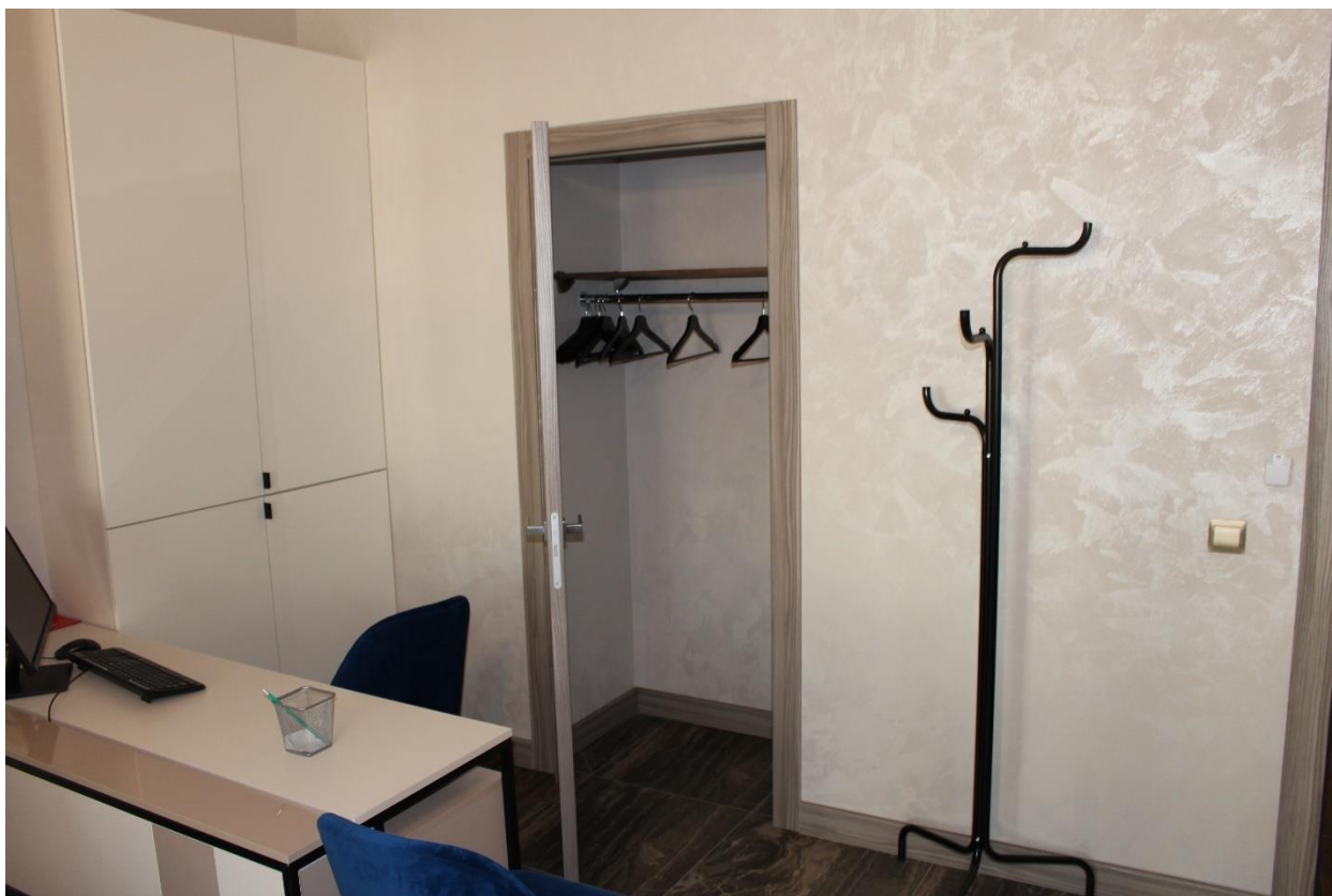
Фото 18. Вид на встроенный шкаф в бывшем дверном проеме помещения № 5.
