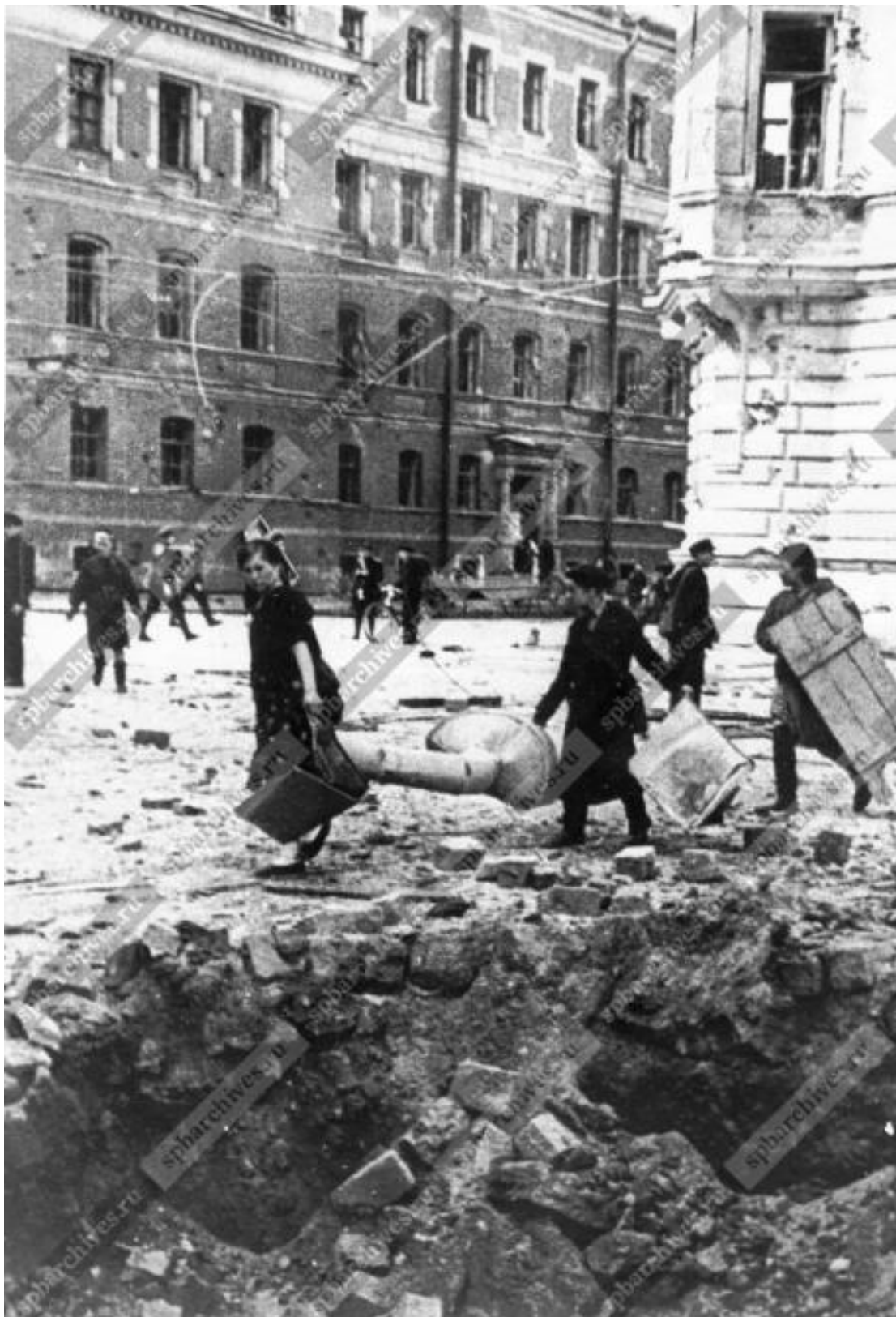
Илл. 24. Бойцы 8-го, 9-го и 23-го батальонов МПВО Смольнинского района за расчисткой улицы от обломков разрушенного авиабомбой дома на углу Советского проспекта и 2-ой Советской улицы. 25.05.1943 г. (источник: ЦГАКФФД СПб. Фотодокумент Ар 22697).
