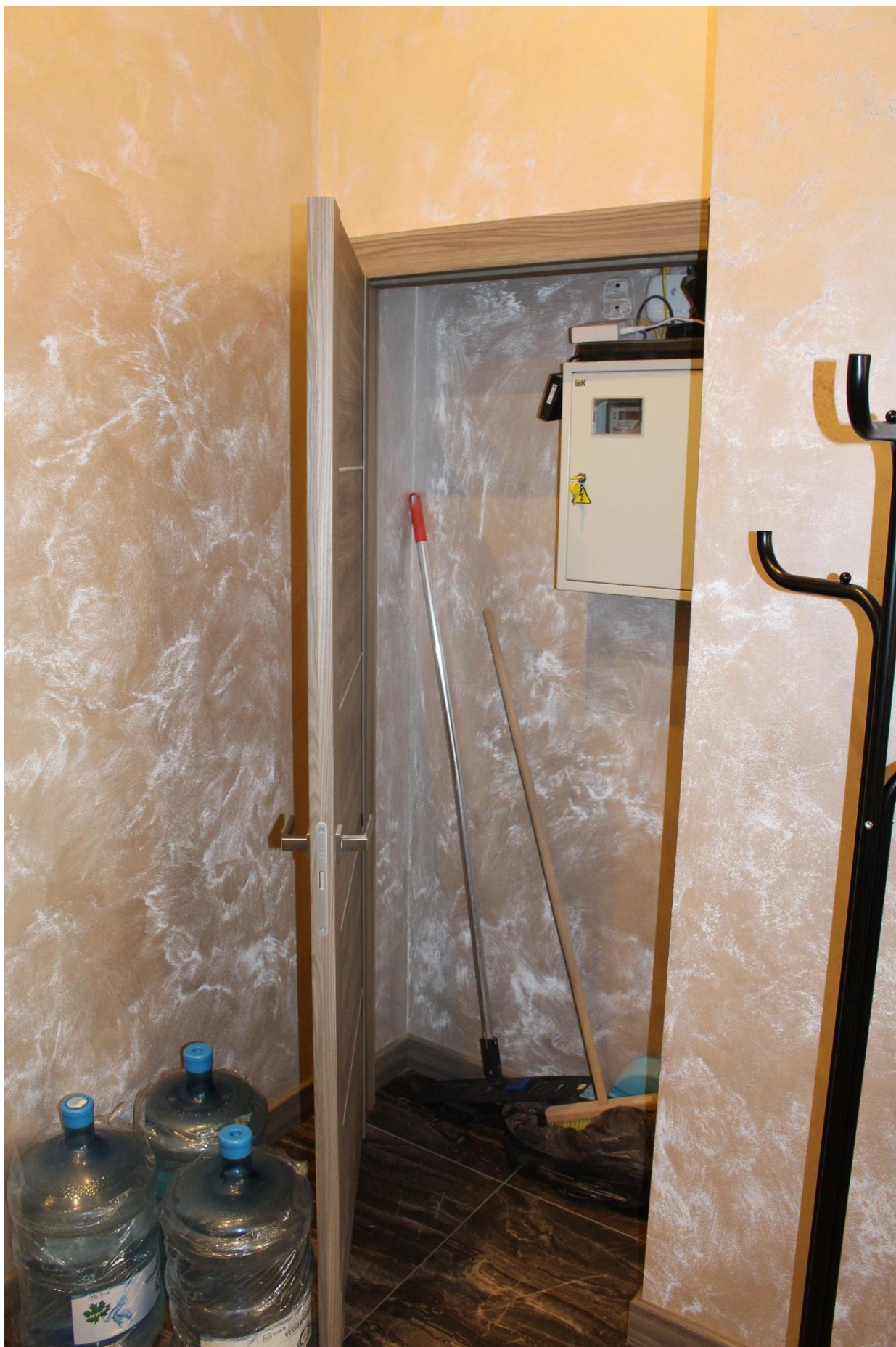
Фото 10. Помещение № 1. Вид на встроенный шкаф.
