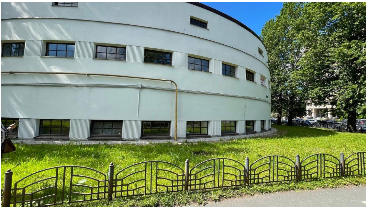
7. Вид на восточный фасад здания;
