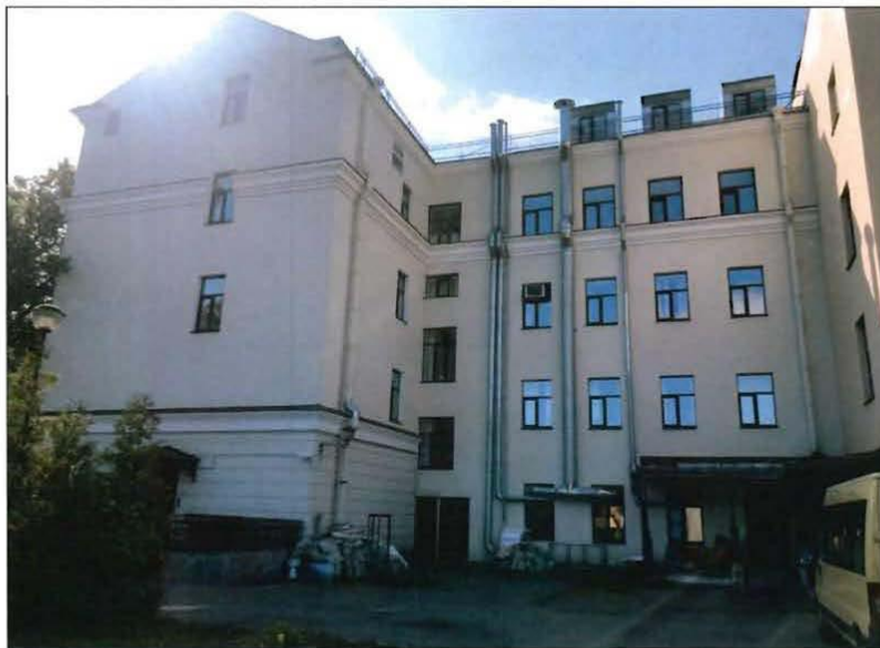
4. Вид на дворовый фасад с северо-западной стороны.
