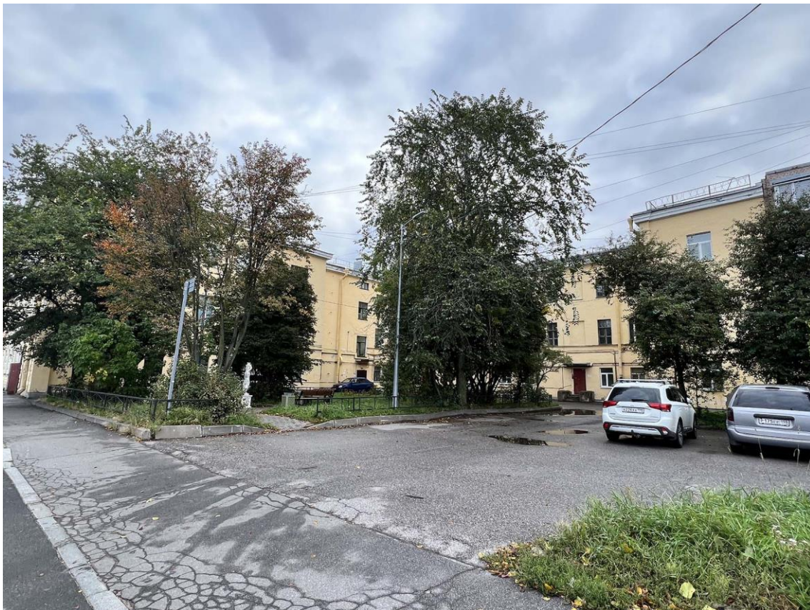
Фото 9. Объект культурного наследия регионального значения «Жилой дом купца Дружинина», Санкт-Петербург, г. Кронштадт, Интернациональная ул. 10/Аммермана ул., 15. Общий вид дворовых фасадов здания с юго-запада. Дата съемки: 21.09.2022 г. Автор съемки: Куваева Ю.П.
