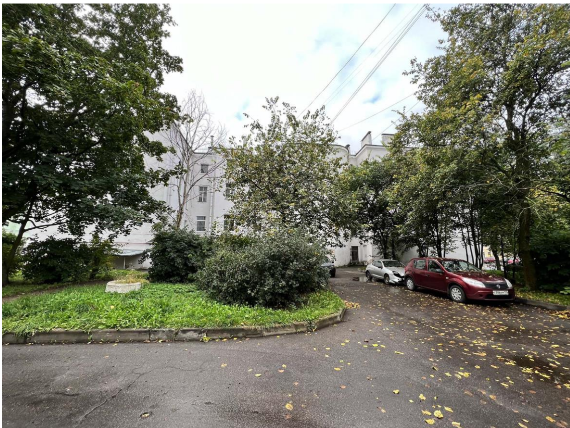
Фото 14. Выявленный объект культурного наследия «Жилой дом», Санкт-Петербург, г. Кронштадт, Пролетарская ул., 17/Аммермана ул. 24/Интернациональная ул. 11. Общий вид дворовых фасадов здания с севера. Дата съемки: 21.09.2022 г. Автор съемки: Куваева Ю.П.
