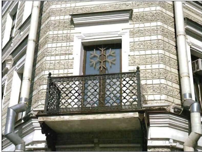
3. Балкон со стороны лицевого юго-восточного фасада.
