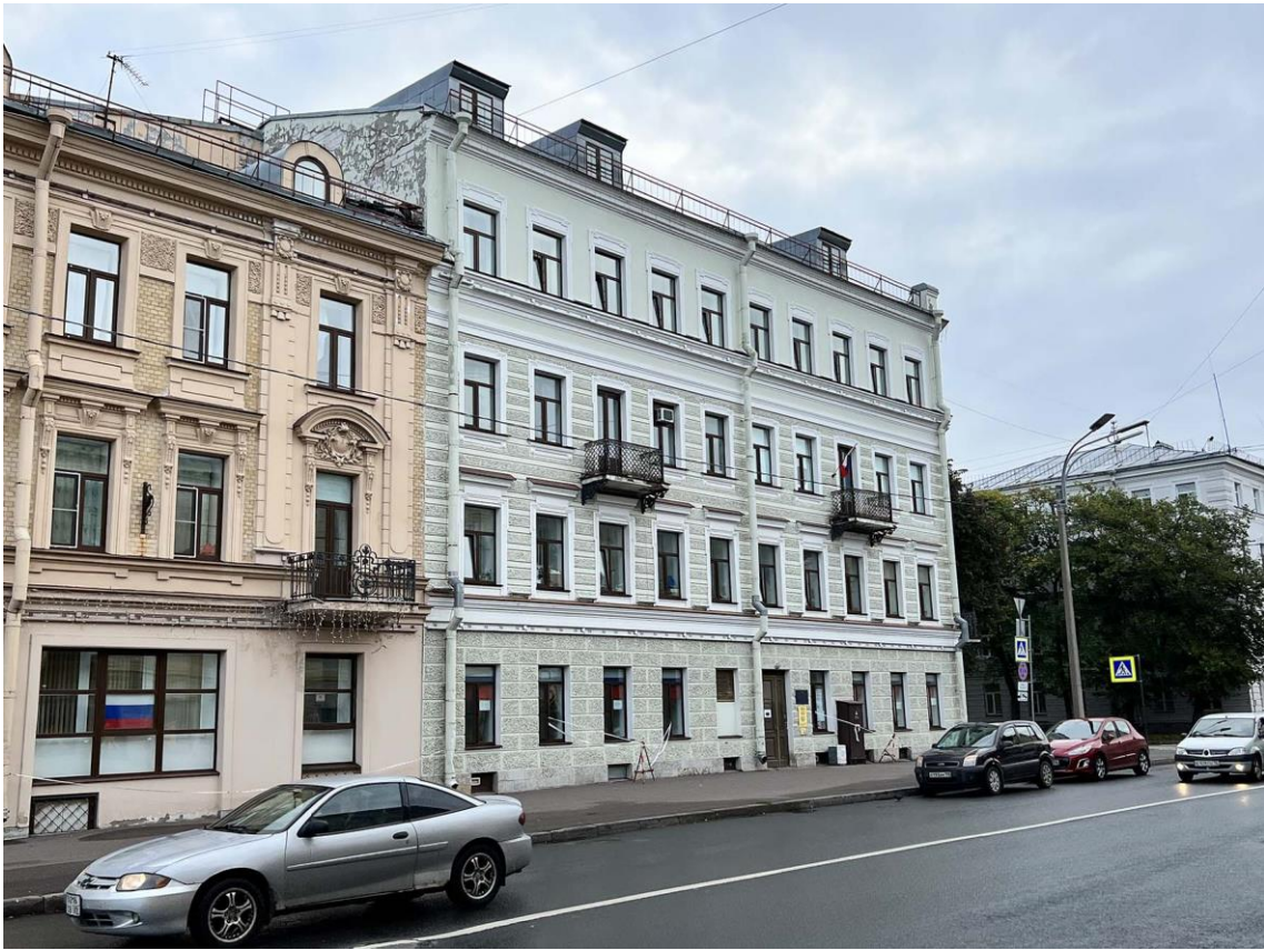
Фото 1. Объект культурного наследия регионального значения «Жилой дом», Санкт-Петербург, г. Кронштадт, Интернациональная ул., 13/Аммермана ул., 13. Общий вид здания с ул. Интернациональная, с юго-запада. Дата съемки: 21.09.2022 г. Автор съемки: Куваева Ю.П.
