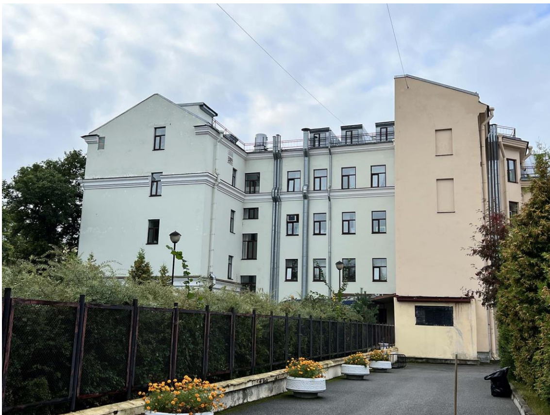
Фото 5. Объект культурного наследия регионального значения «Жилой дом», Санкт-Петербург, г. Кронштадт Интернациональная ул., 13/Аммермана ул., 13. Общий вид дворовых фасадов здания с севера. Дата съемки: 21.09.2022 г. Автор съемки: Куваева Ю.П.
