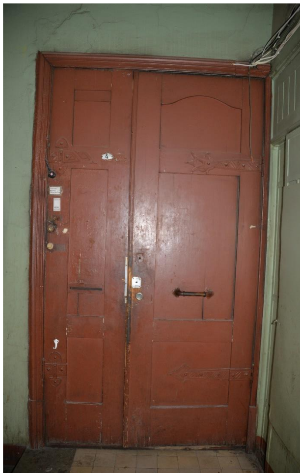
56. Дверь в квартиру №4
