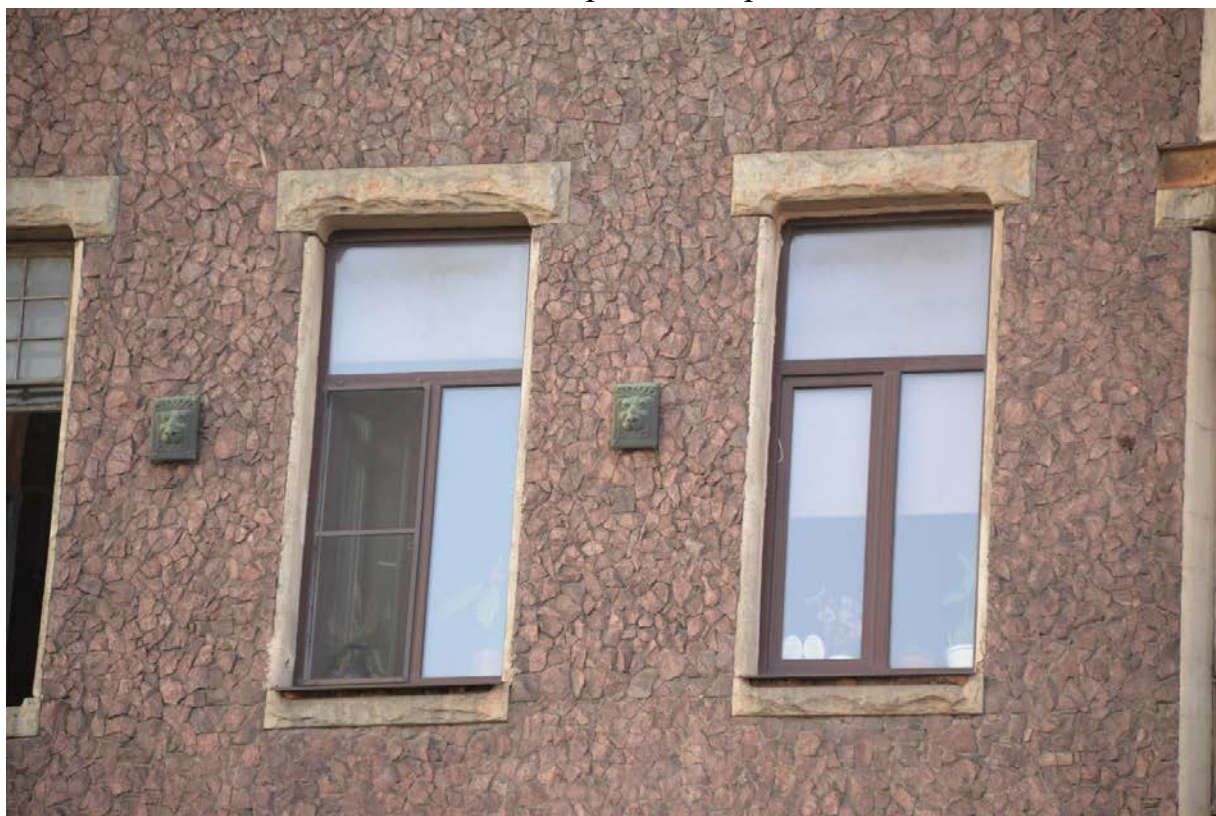
7. Оконные проемы третьего этажа
