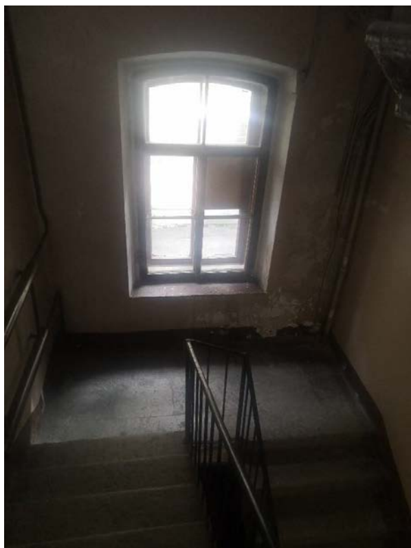
60. Интерьер лестницы 2ЛК в уровне межэтажной площадки 1-2 этажей
