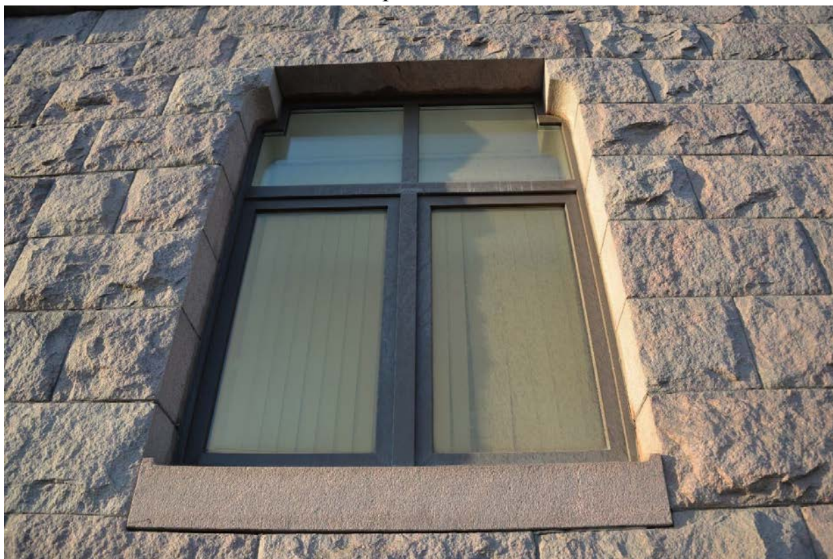
5. Оконный проем первого этажа
