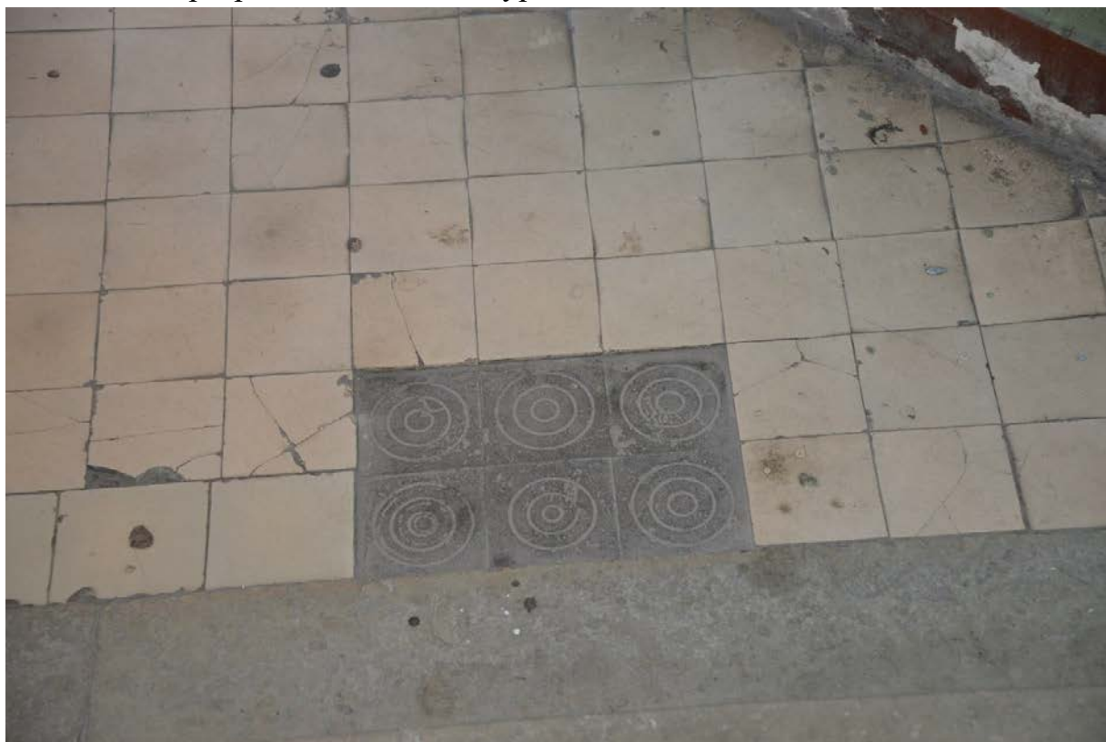
53. Фрагмент напольного покрытия в уровне межэтажной площадки 3-4 этажей
