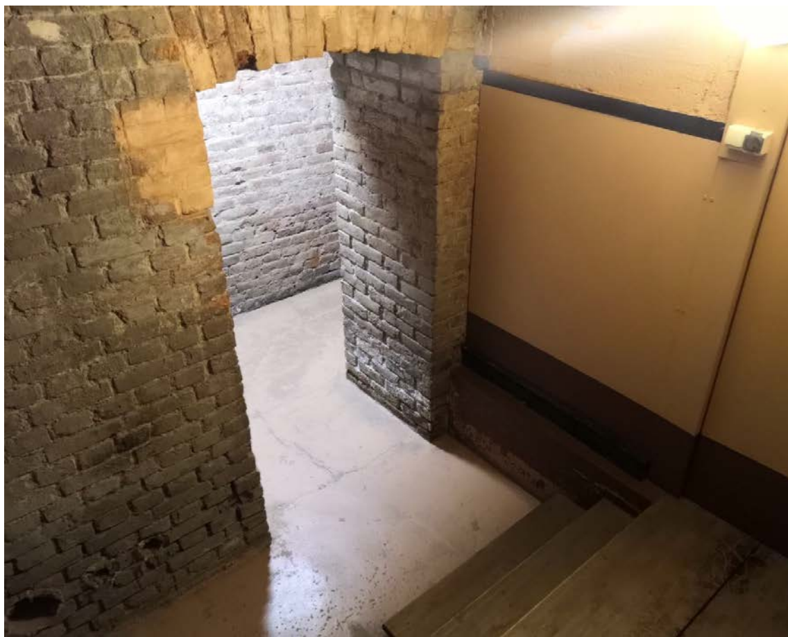
29. Вид на дверной проем в помещение 2-Н
