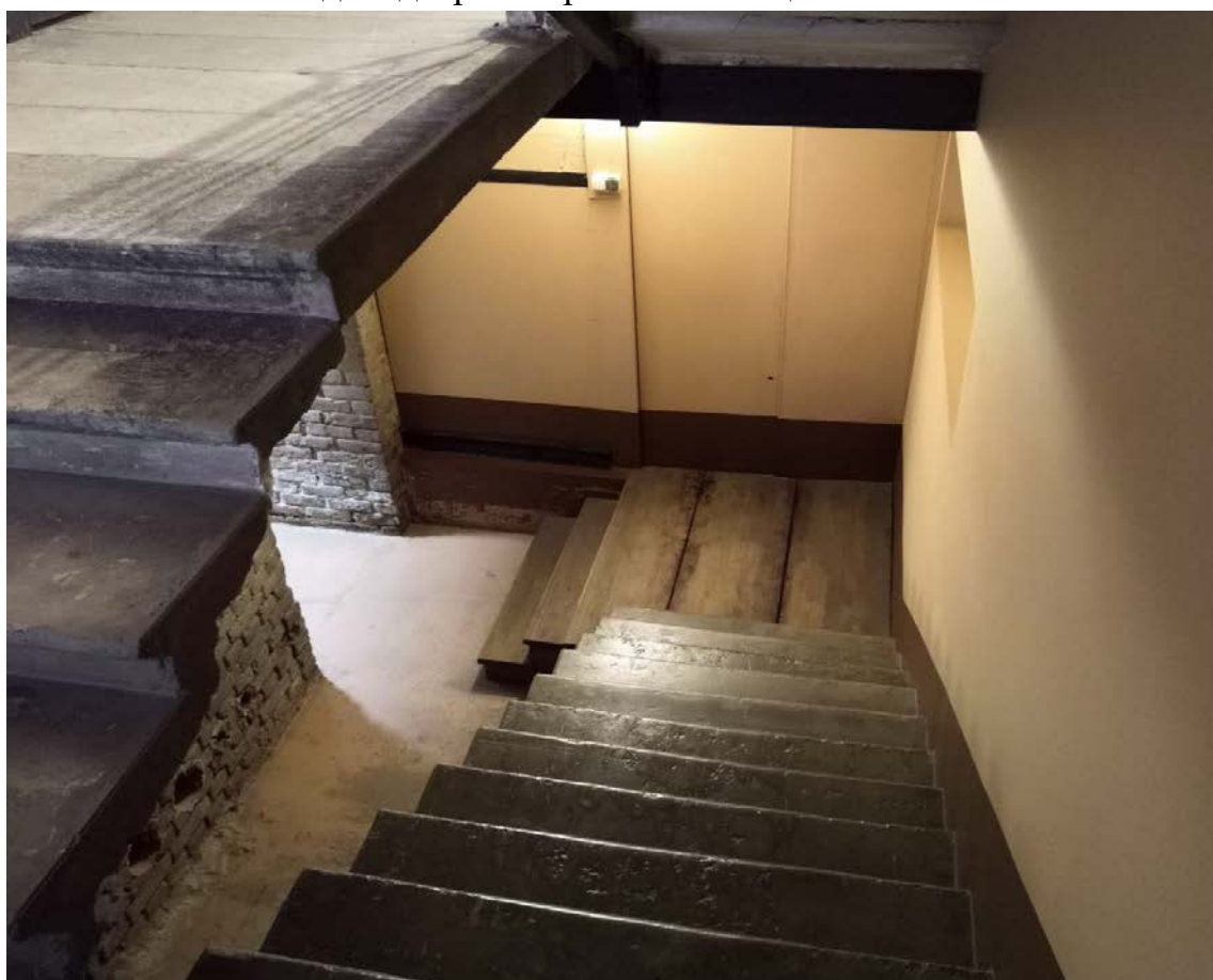
30. Лестница 1 ЛК в уровне подвала
