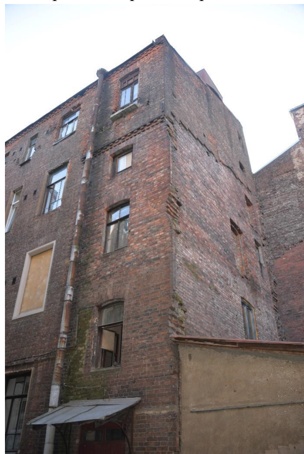
18. Фрагмент дворового фасада
