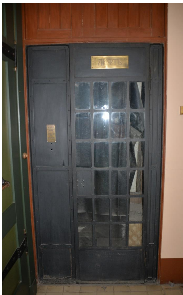
39. Лифт в уровне первого этажа
