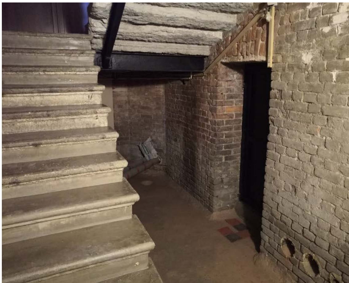
31. Лестница 1 ЛК в уровне подвала
