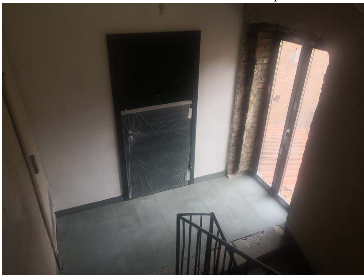
62. Интерьер лестницы 1 ЛК в уровне второго этажа
