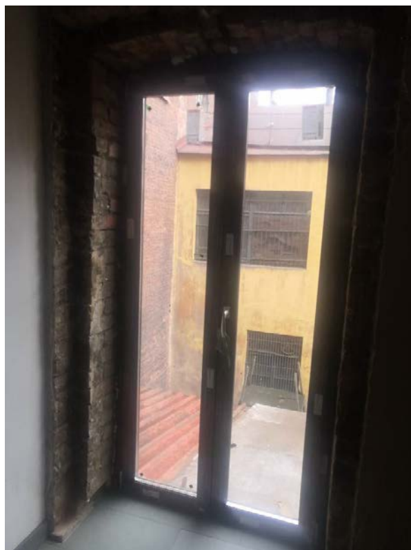
61. Дверной проем с лестницы 2ЛК на крышу пристройки в уровне второго этажа
