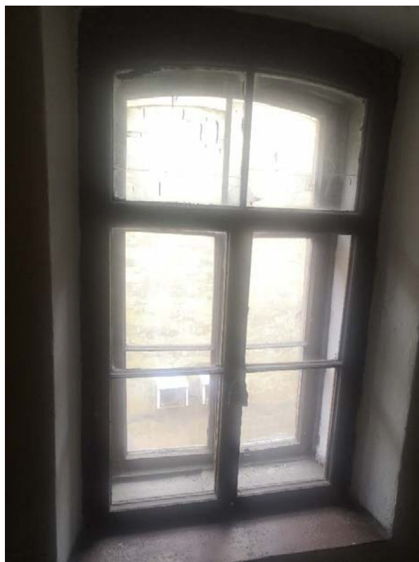
65. Окно в уровне межэтажной площадки 2-3 этажей
