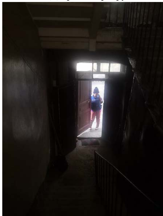
58. Вход на лестницу 2ЛК
