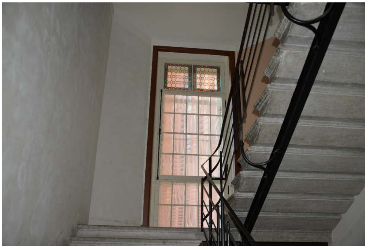
48. Интерьер лестницы 1ЛК в уровне межэтажной площадки 2-3 этажей
