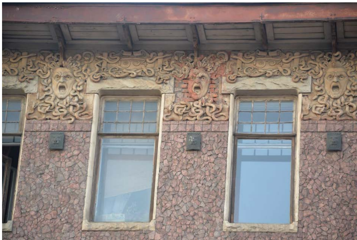
8. Оконные проемы и декор четвертого этажа
