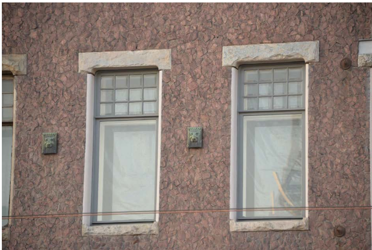
6. Оконные проемы второго этажа
