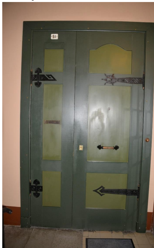
40. Дверь в квартиру №1
