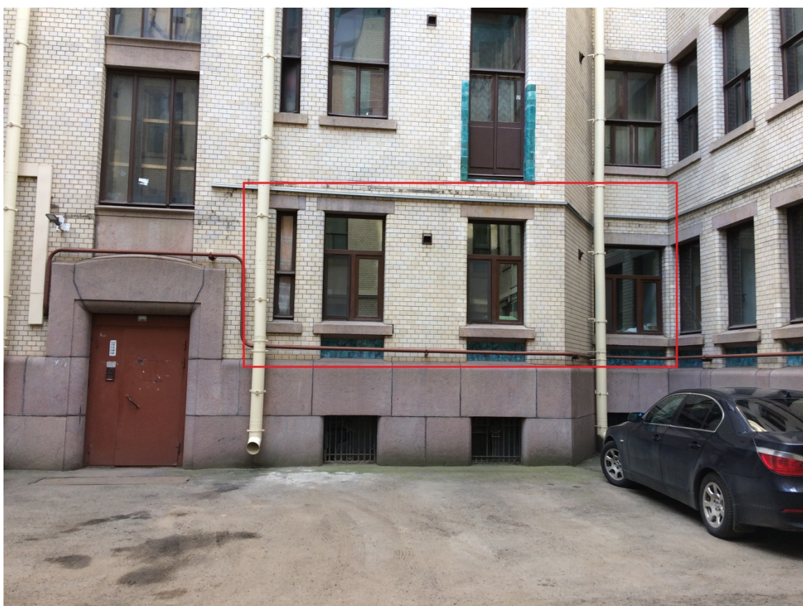
Фото 2. Вид на дворовой фасад. Оконные проемы квартиры 20.
