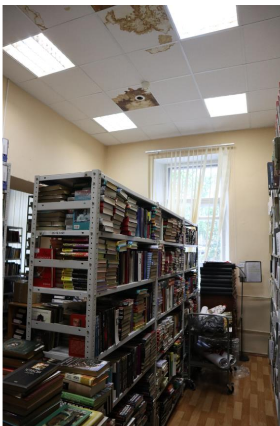
Фото 2.20. 2 этаж, фондохранилище в центральной части здания
