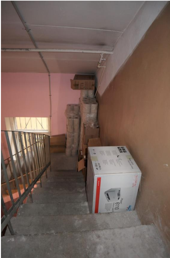
Фото ч.3. Чердак, лестница
