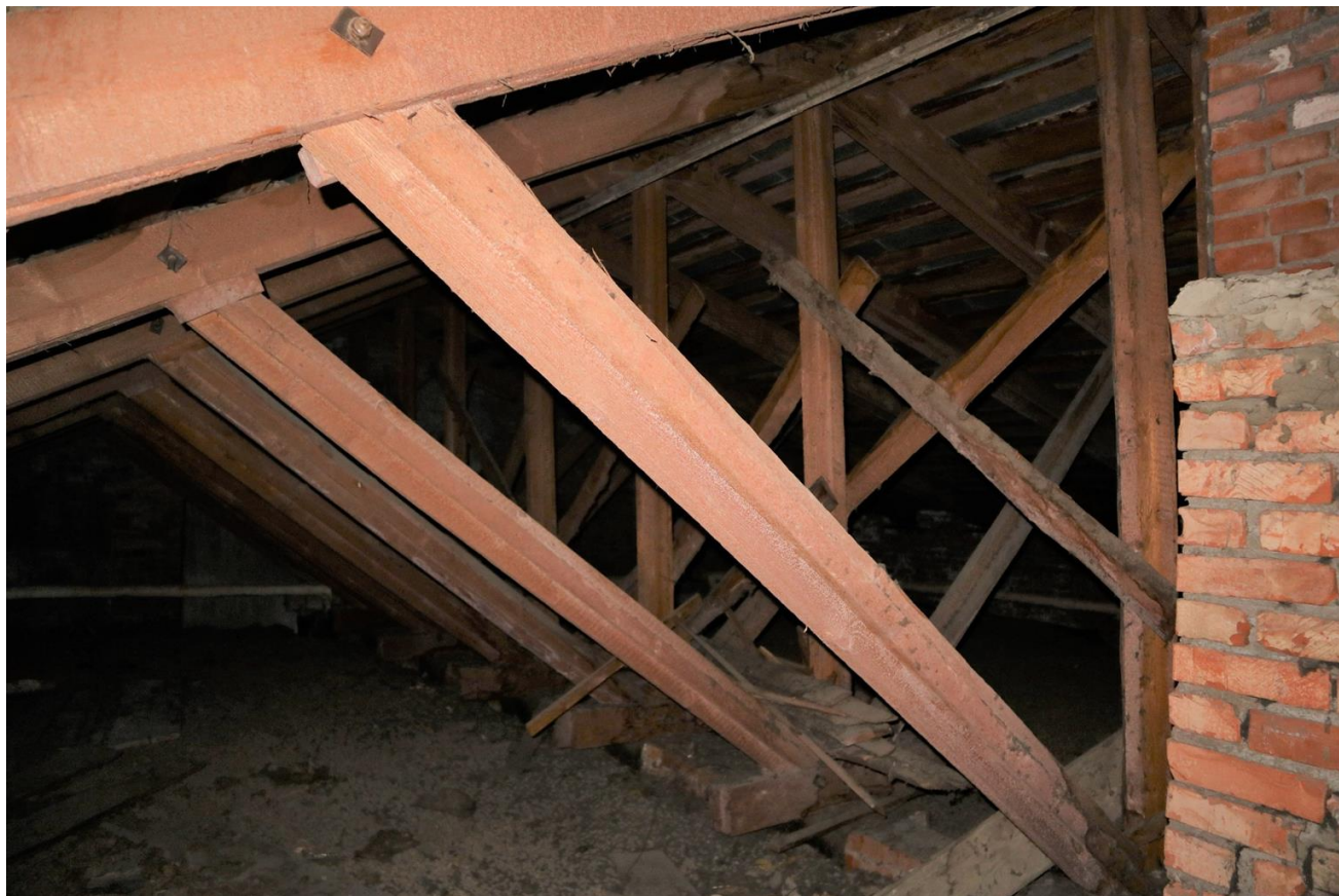
Фото ч.6. Чердачное помещение в юго-восточной части здания
