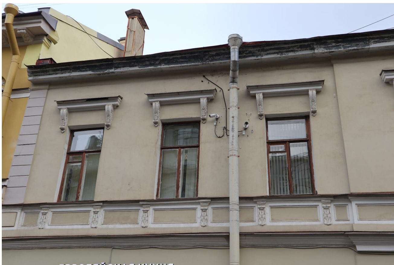
Фото 4. Фрагмент лицевого фасада, оконные проемы второго этажа.
