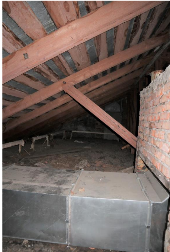
Фото ч.4. Чердачное помещение в юго-восточной части здания
