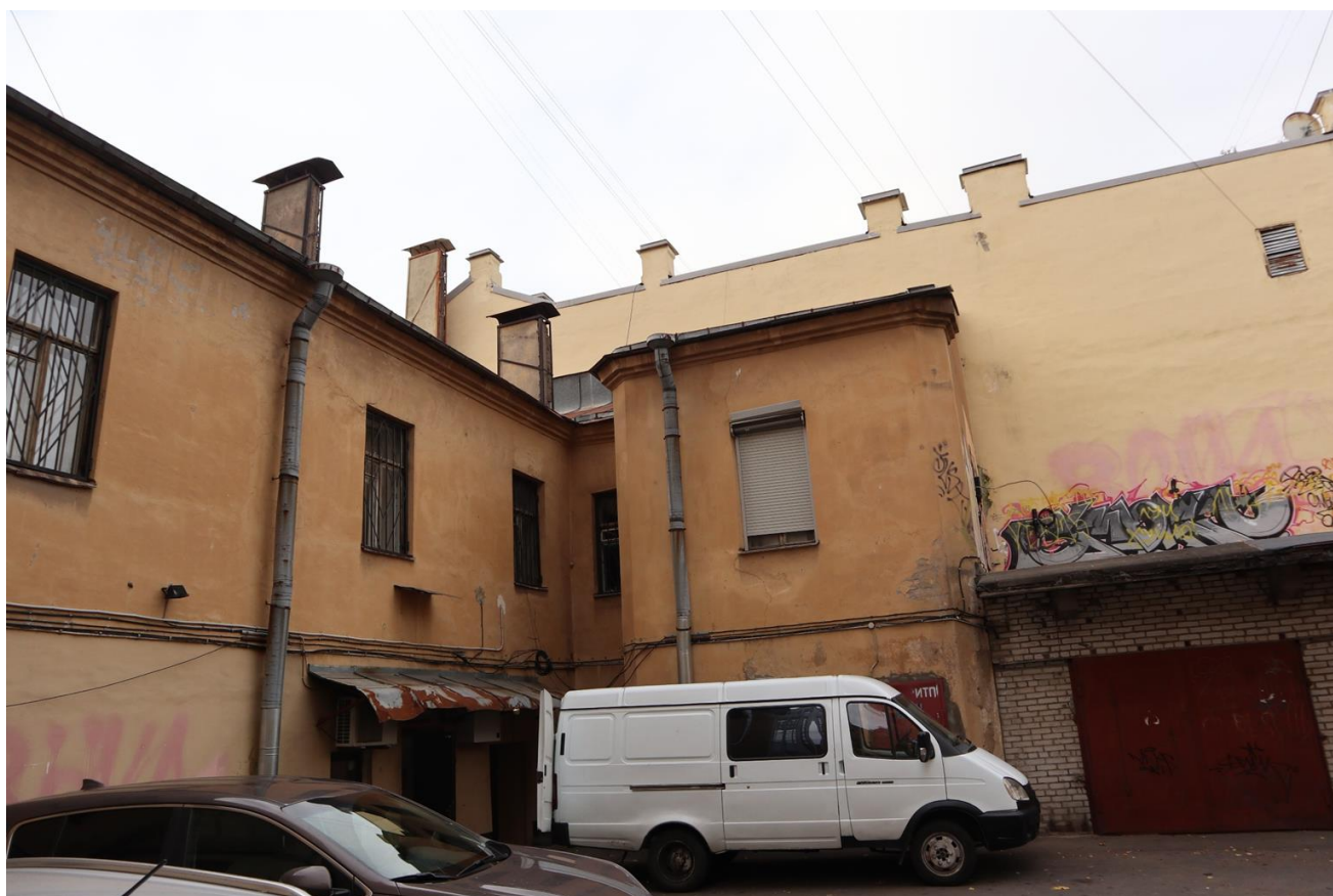
Фото 6. Дворовый фасад, вид с юго-востока
