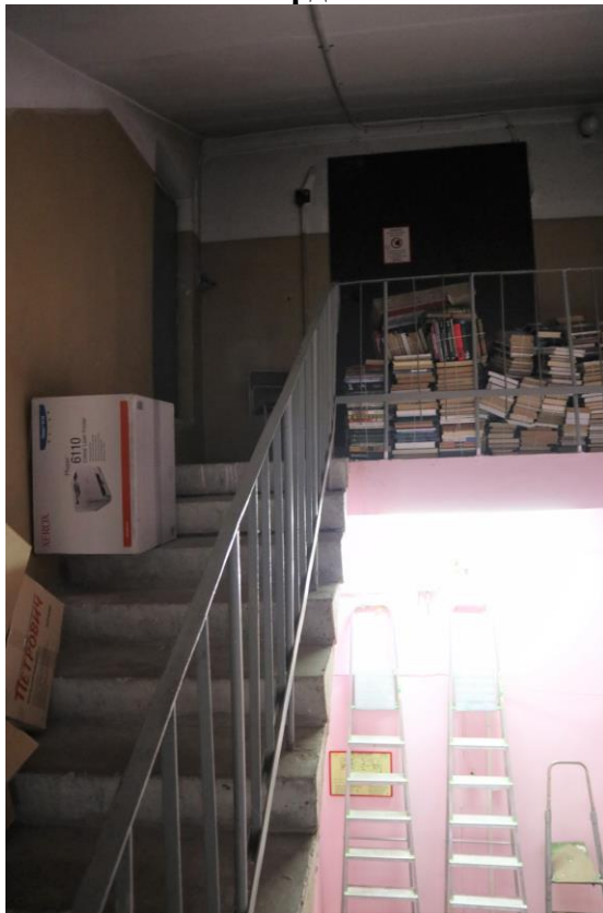
Фото ч.1. Чердак, лестница
