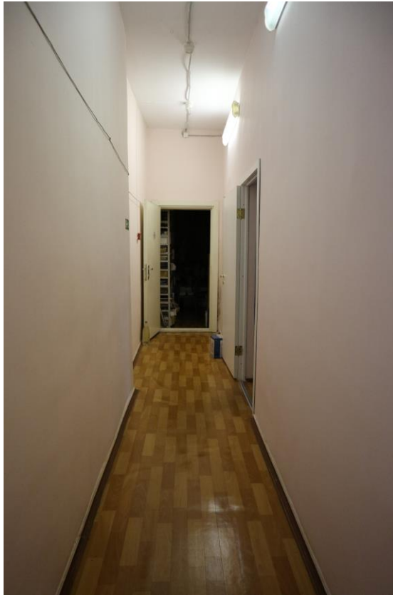
Фото 2.15. 2 этаж, коридор в северной части здания
