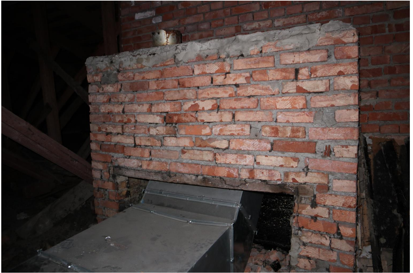
Фото ч.8. Чердачное помещение в юго-восточной части здания
