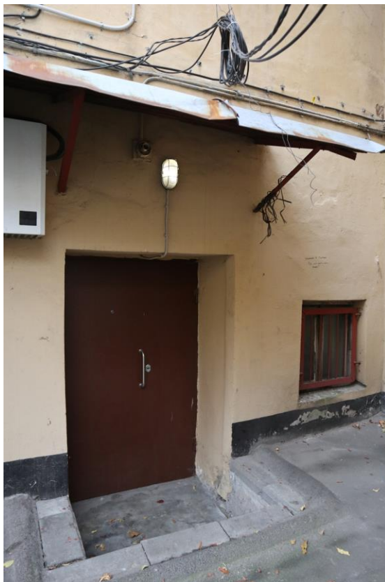
Фото 9. Фрагмент дворового фасада
