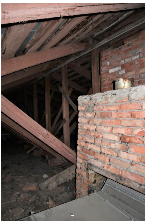
Фото ч.7. Чердачное помещение в юго-восточной части здания
