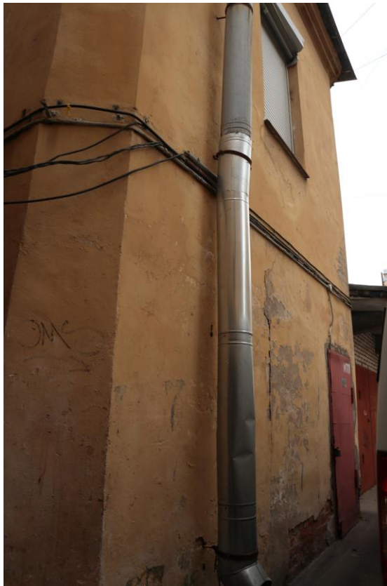
Фото 8. Фрагмент дворового фасада
