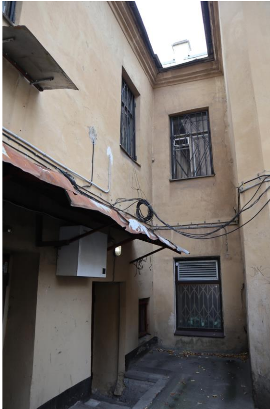
Фото 7. Фрагмент дворового фасада
