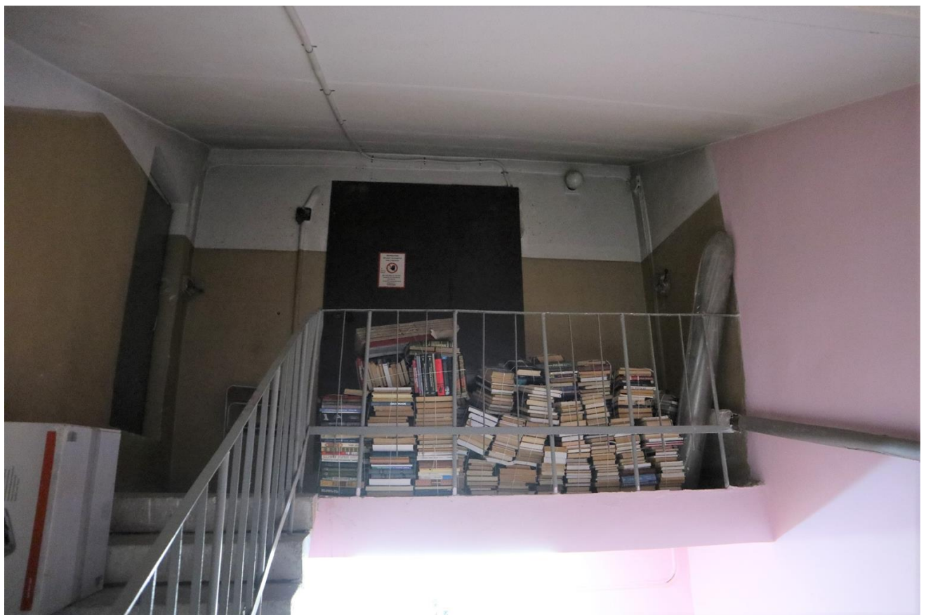
Фото ч.2. Чердак, лестница
