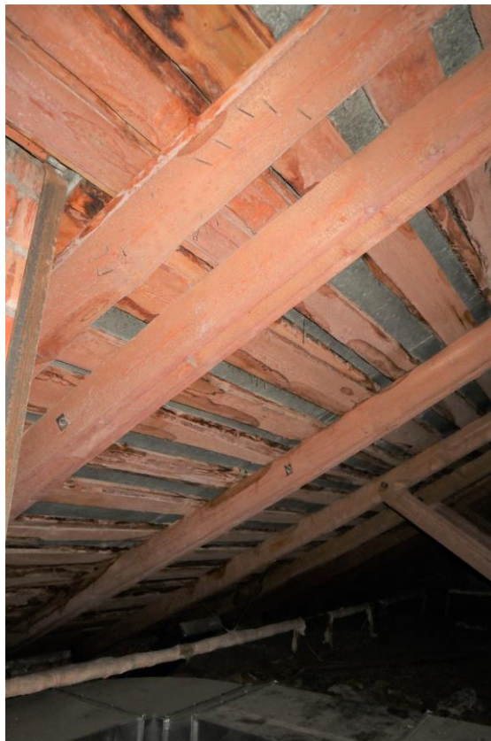
Фото ч.5. Чердачное помещение в юго-восточной части здания
