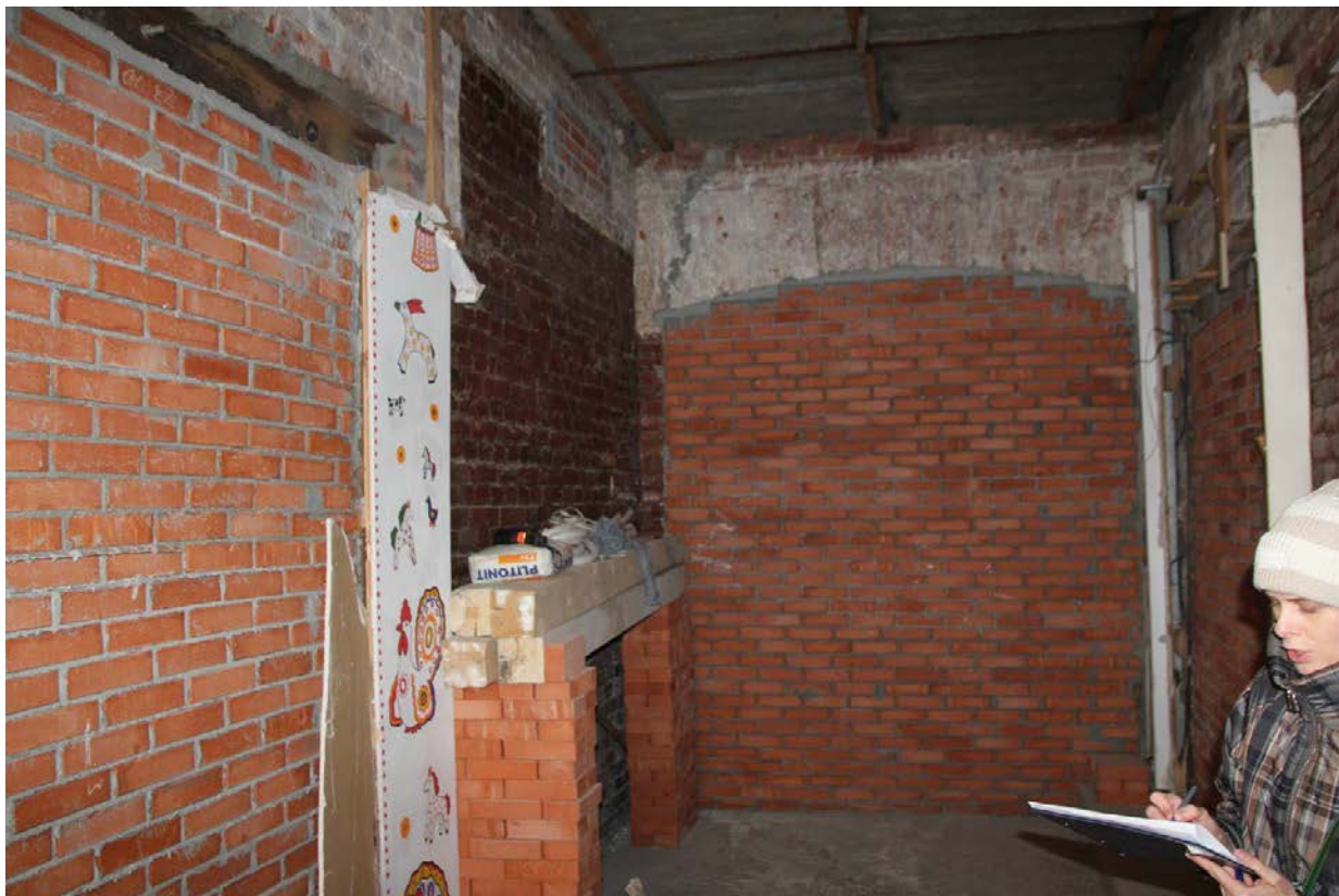
Фото №1. Общий вид помещения 15-Н
