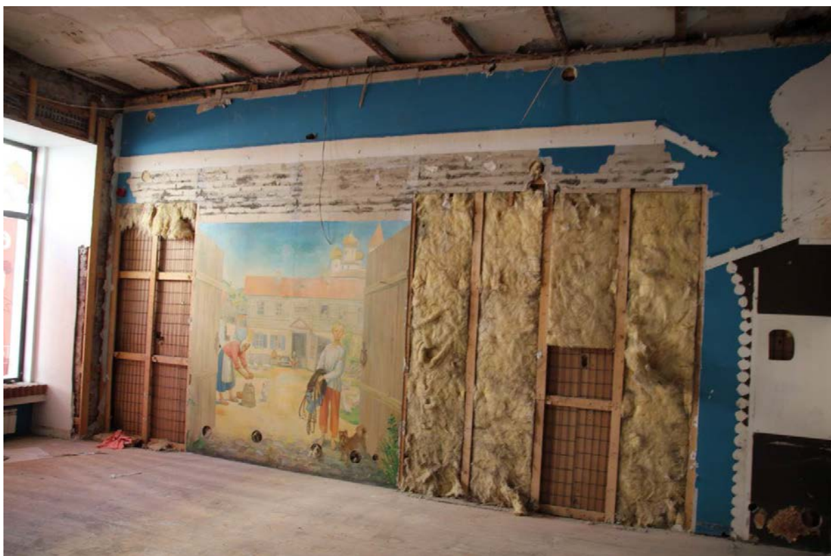
Фото №19. Общий вид помещения 11-Н (16)
