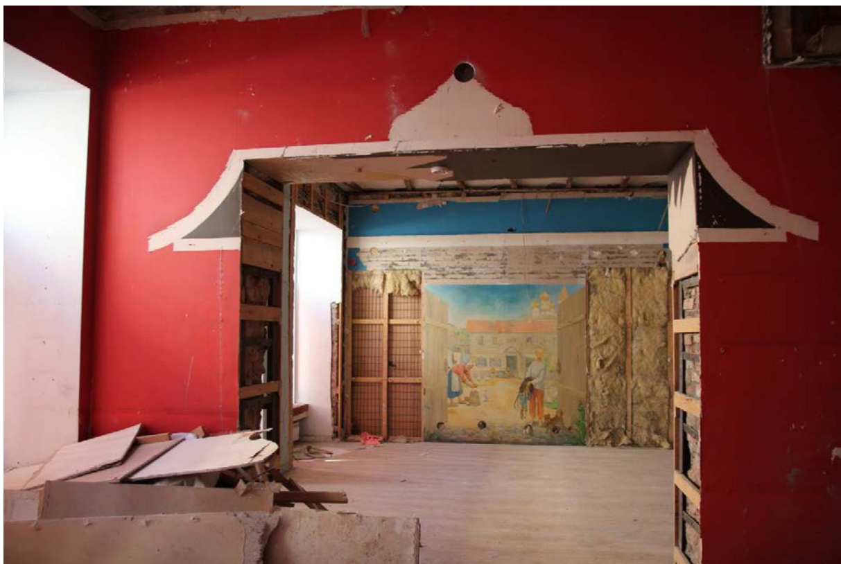
Фото №18. Вид на помещение 11-Н (16)
