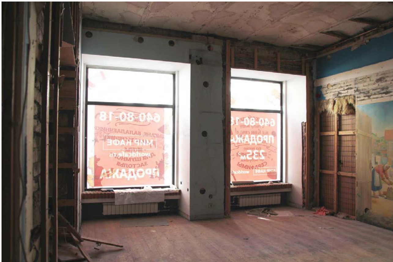
Фото №22. Общий вид помещения 11-Н (16)
