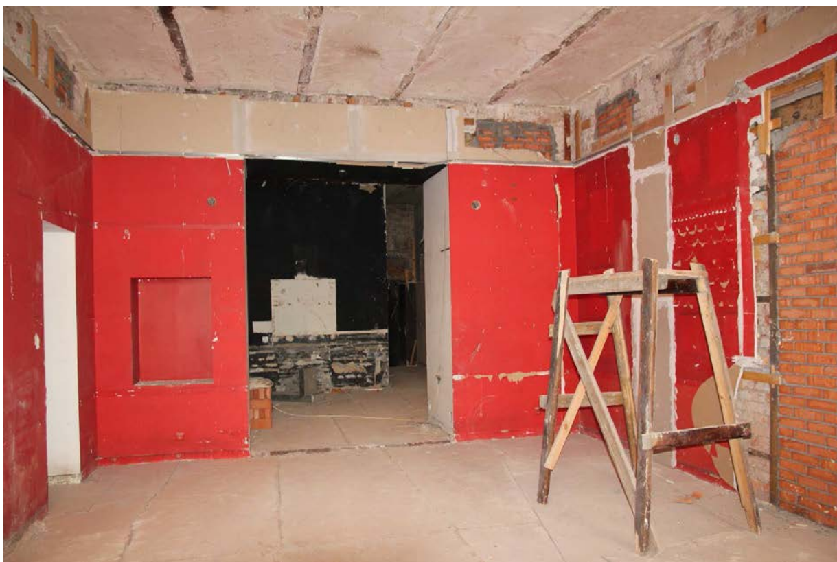
Фото №17. Общій вид помещения 11-Н (15). Вид на помещение 11-Н (14)
