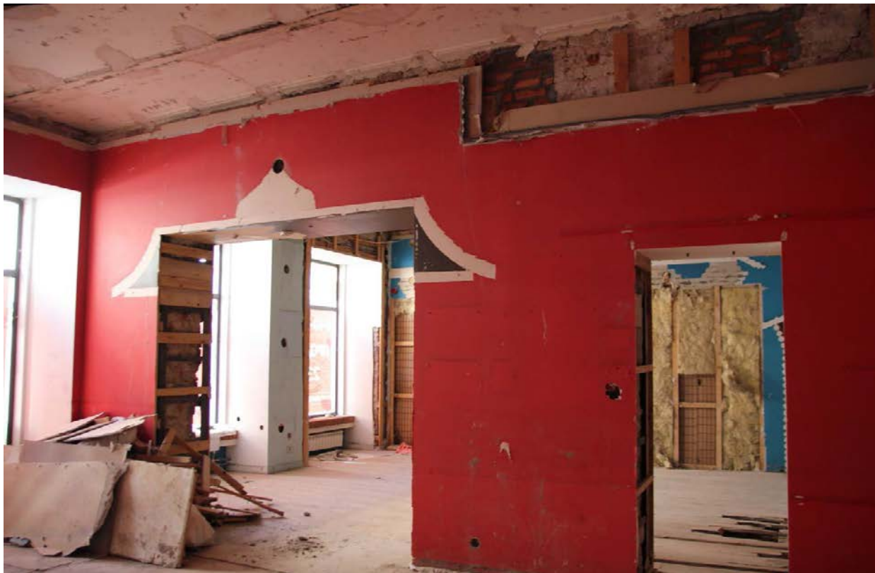
Фото №16. Общій вид помещения 11-Н (15). Вид на помещение 15-Н (16)
