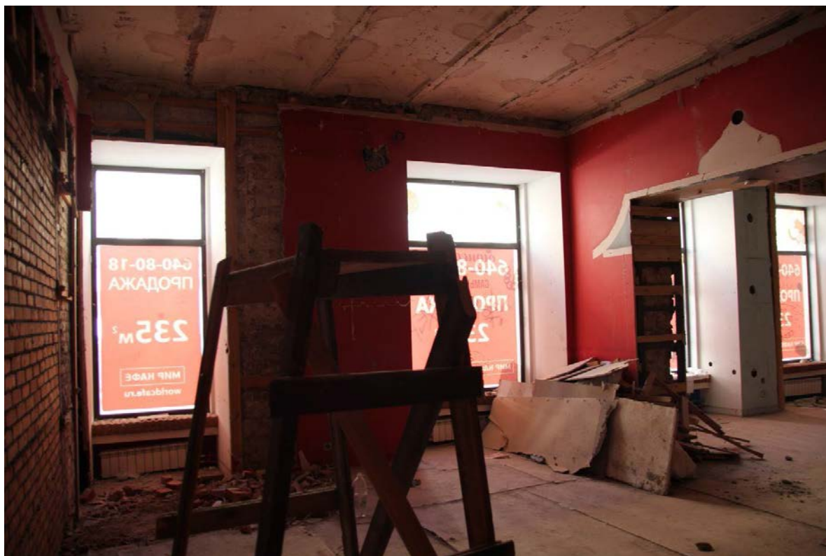
Фото №14. Общий вид помещения 11-Н (15)
