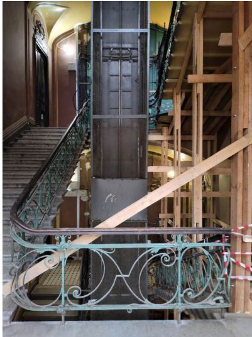
33. ОКН регионального значения «Жилой дом страхового общества «Россия» с садом и оградой» (г. Санкт-Петербург, Моховая ул., 27-29) №17 ЛК. 3 этаж
