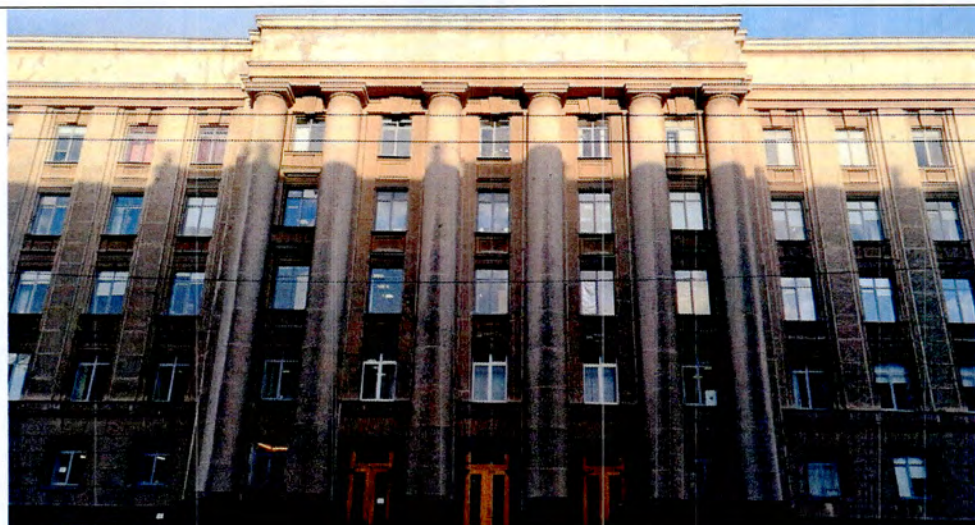
4. Фрагмент южного фасада
