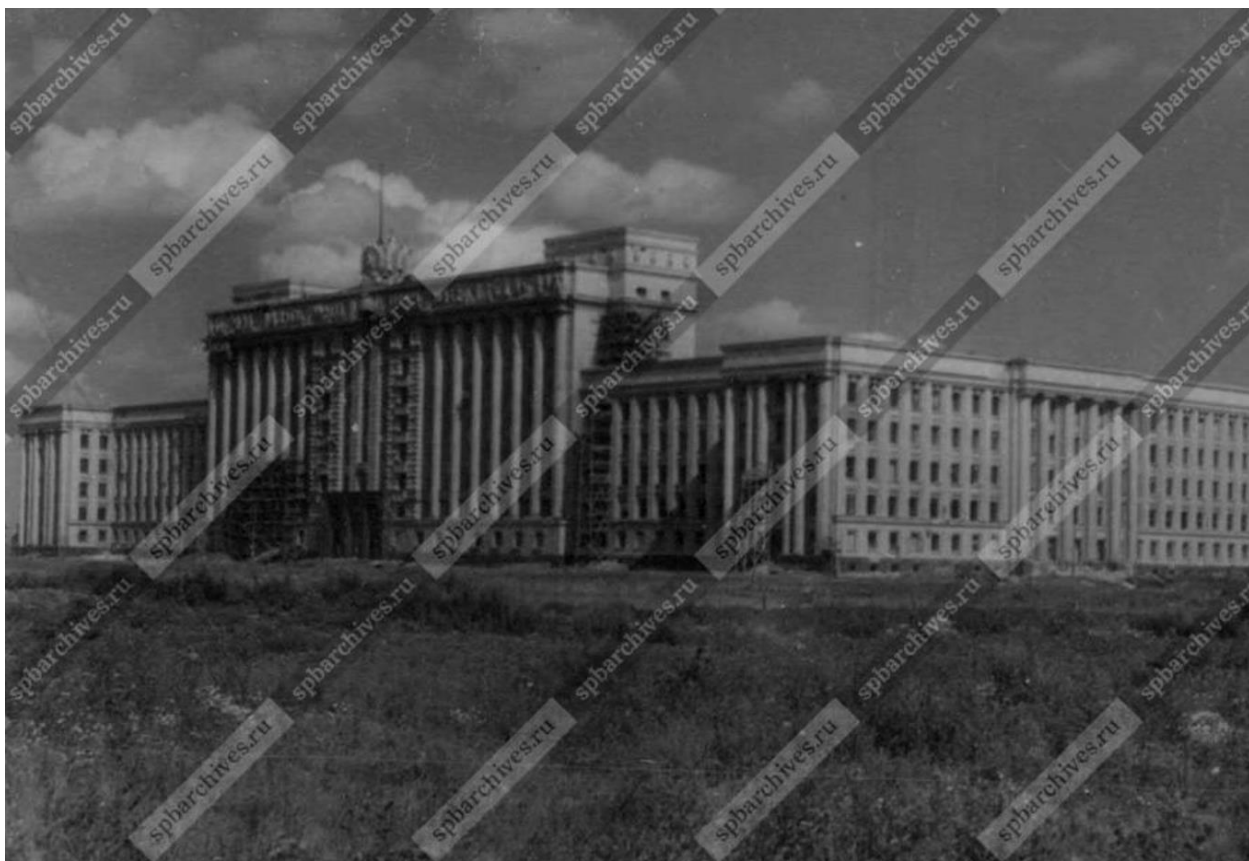
Илл. 59. Вид фасада здания Ленинградского Дома Советов (1936-1941 гг. - архитекторы Н.А. Троцкий; Я.Н. Лукин, Я.О. Свирский, Л.М. Тверской, М.А. Шепилевский; инженер С.С. Голушкевич). Дата съёмки: 1936-1941 гг. // ЦГАКФФД СПб. Архивный шифр: Бр 30310
