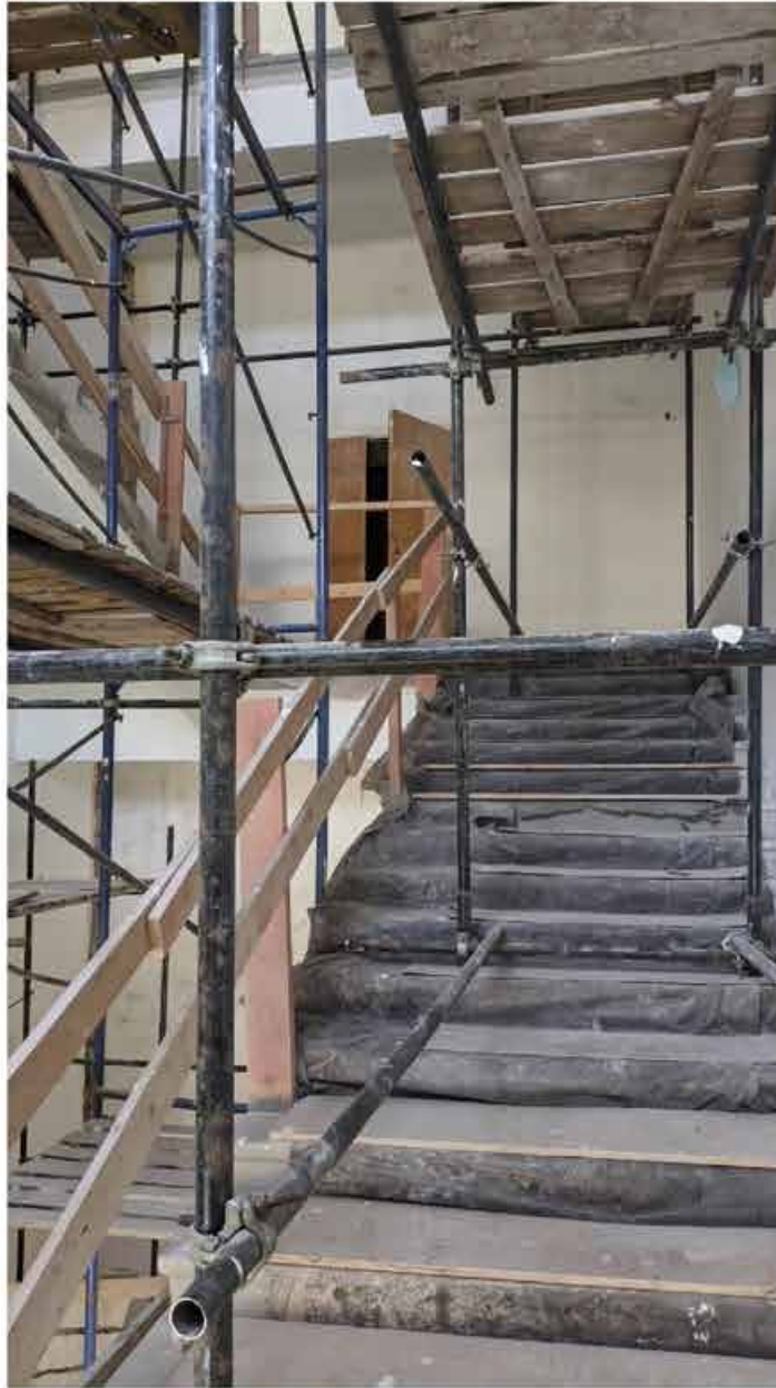
182. Вид на лестничную клетку зоны «Консерватория» в уровне 3-го этажа западного корпуса.
