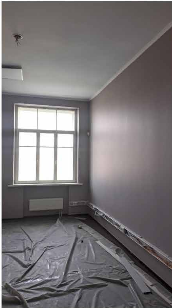
101. Вид в интерьере зоны «РВИО» в уровне 4-го этажа северного корпуса.
