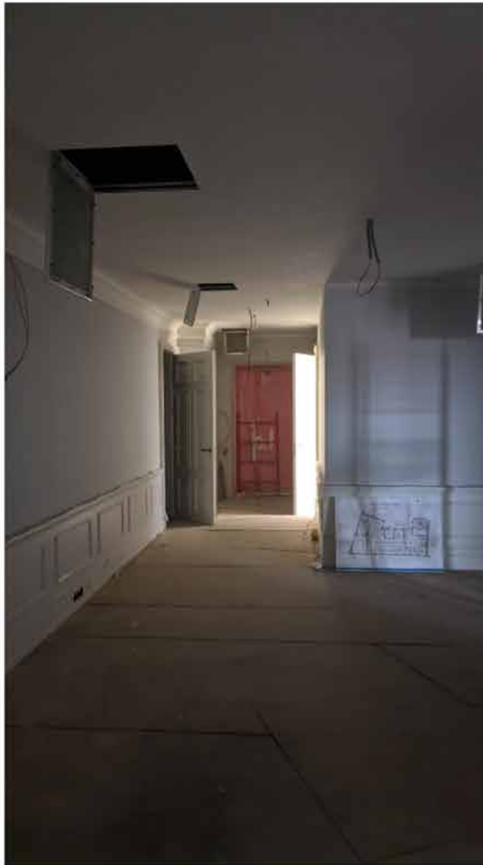
127. Вид в интерьере зоны «РВИО» в уровне 5-го этажа северного корпуса.
