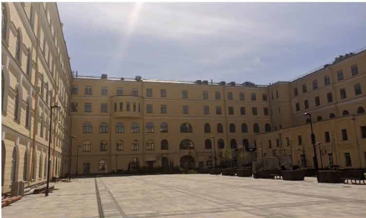
17. Вид на южный корпус со стороны внутреннего двора (дополнительная фотофиксация от 26.04.2022г.).
