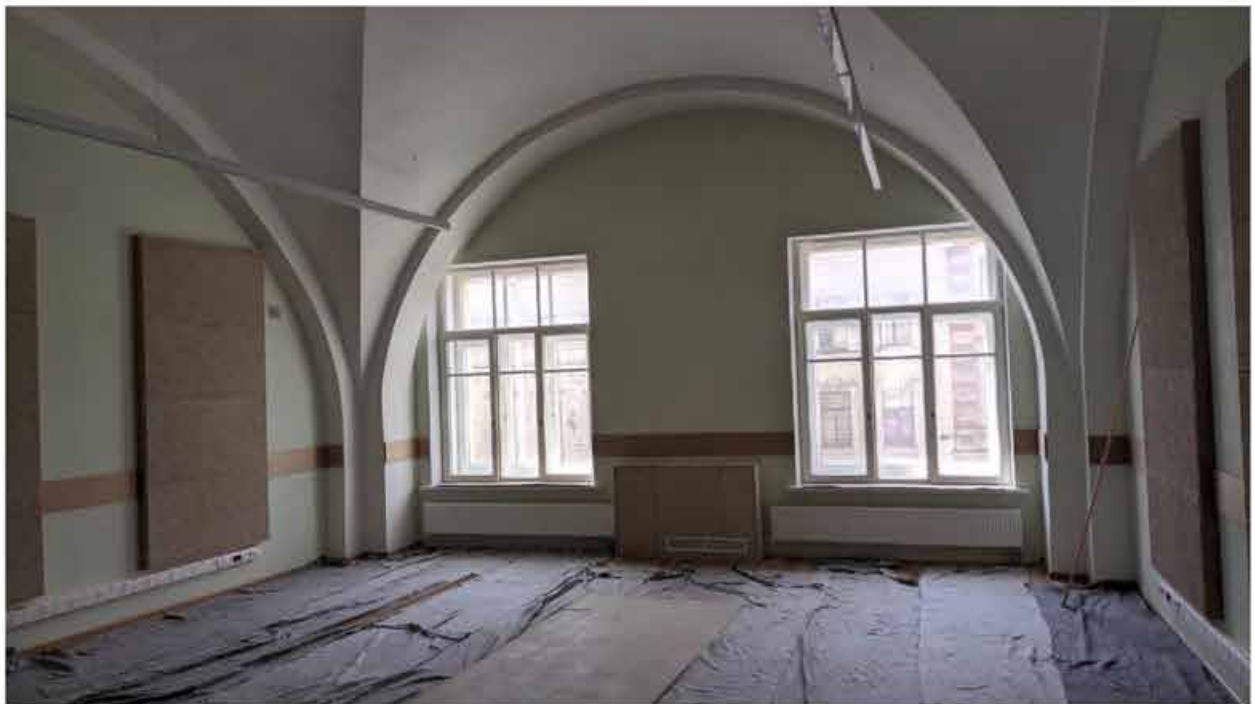
170. Вид в интерьере зоны «Консерватория» в уровне 3-го этажа западного корпуса.
