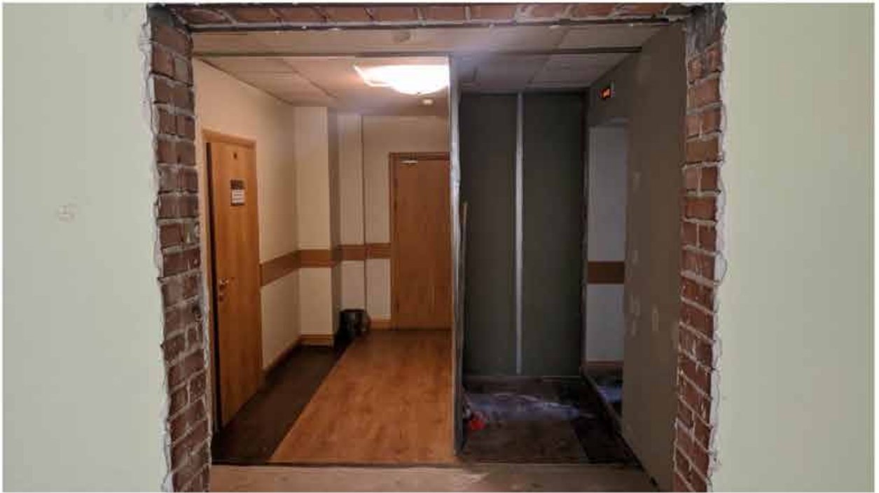
187. Вид в коридоре зоны «Консерватория» в уровне 4-го этажа западного корпуса.
