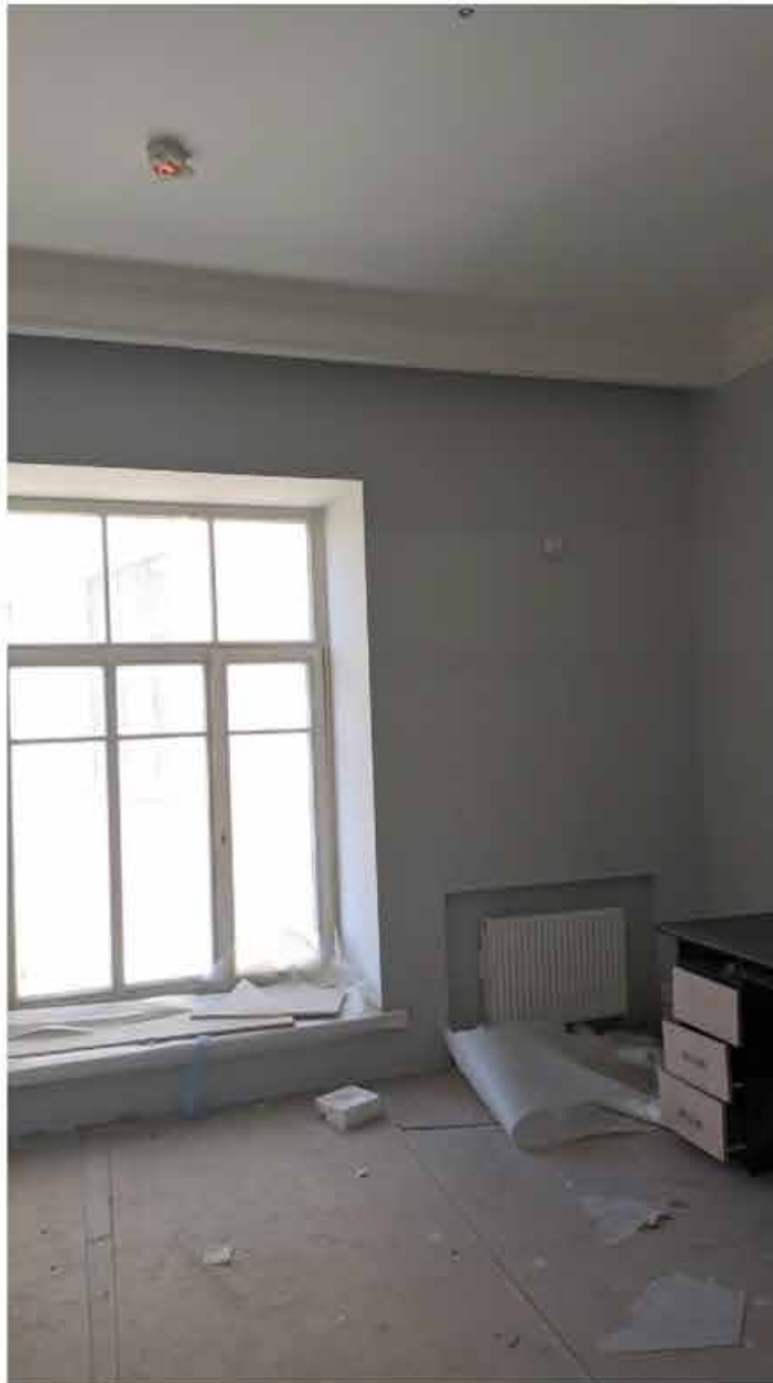
129. Вид в интерьере зоны «РВИО» в уровне 5-го этажа северного корпуса.
