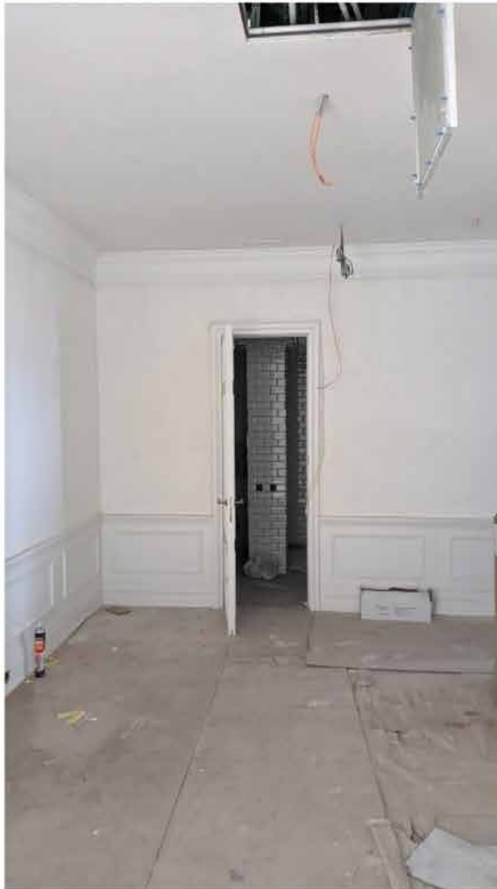
112. Вид в интерьере зоны «РВИО» в уровне 5-го этажа северного корпуса.
