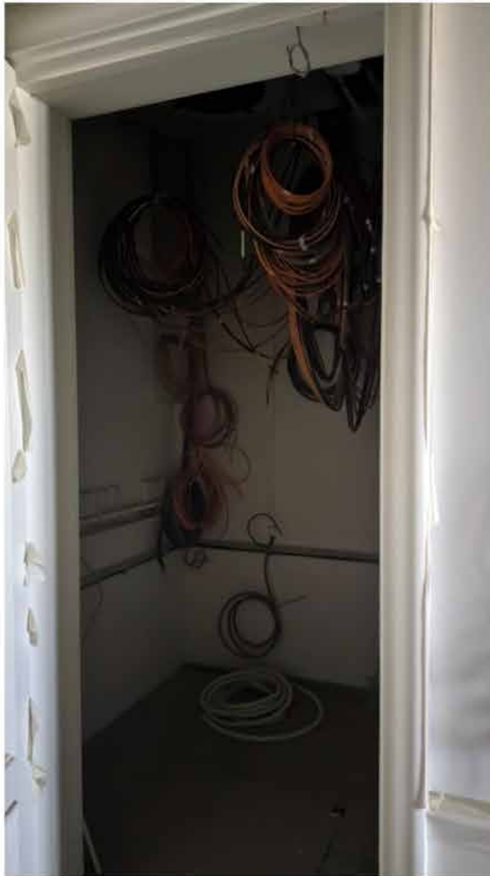
130. Вид в интерьере зоны «РВИО» в уровне 5-го этажа северного корпуса.
