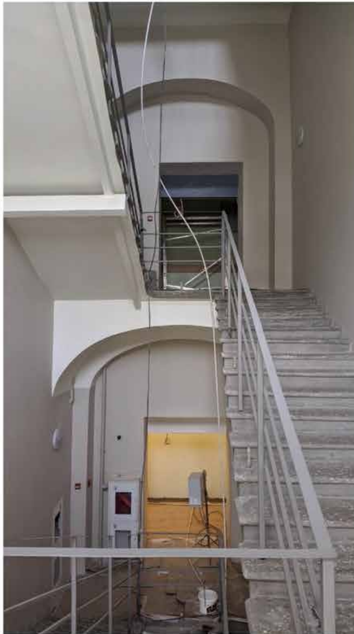
141. Виды в интерьере лестницы зоны «Консерватория» в уровне 1-2-го этажей западного корпуса.
