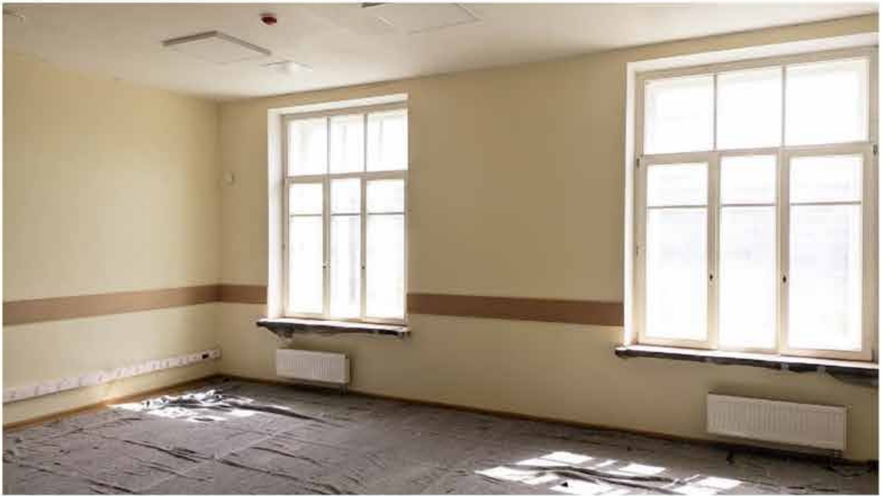
214. Вид в интерьере зоны «Консерватория» в уровне 4-го этажа западного корпуса.
