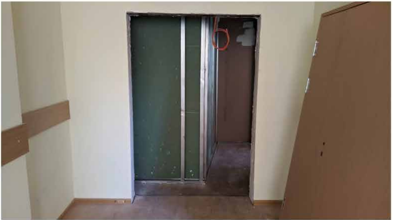
314. Вид в интерьере коридора зоны «Консерватория» в уровне 5-го этажа западного корпуса.
