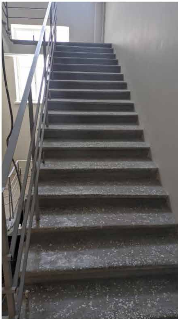
156. Вид на лестничную клетку зоны «Консерватория» в уровне 2-го этажа западного корпуса.
