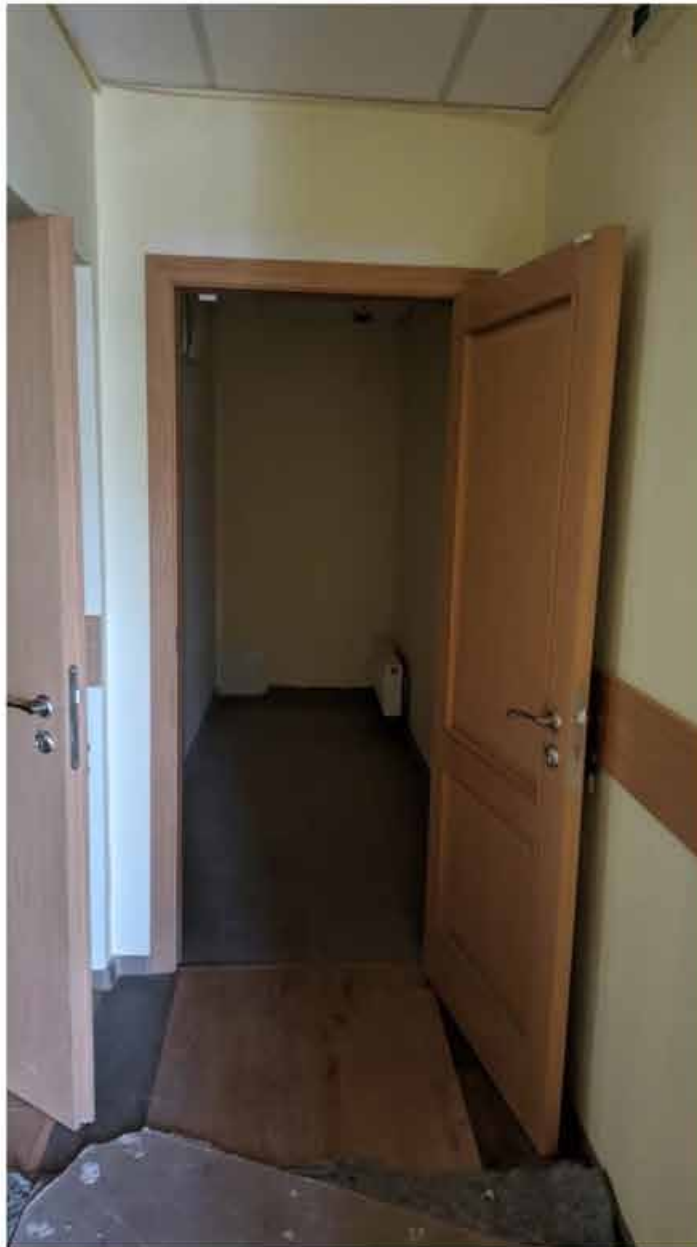
280. Вид в интерьере коридора зоны «Консерватория» в уровне 5-го этажа южного корпуса.
