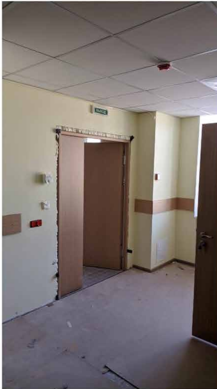
287. Вид в интерьере коридора зоны «Консерватория» в уровне 5-го этажа южного корпуса.
