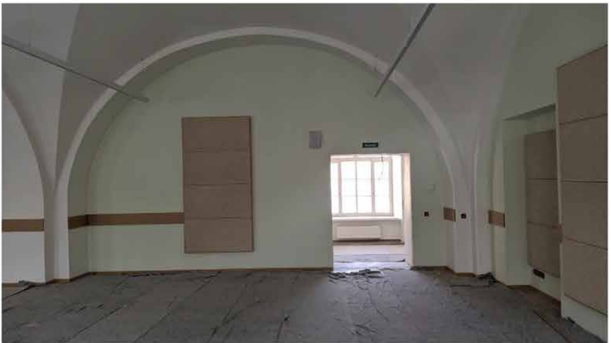
176. Вид в интерьере зоны «Консерватория» в уровне 3-го этажа западного корпуса.
