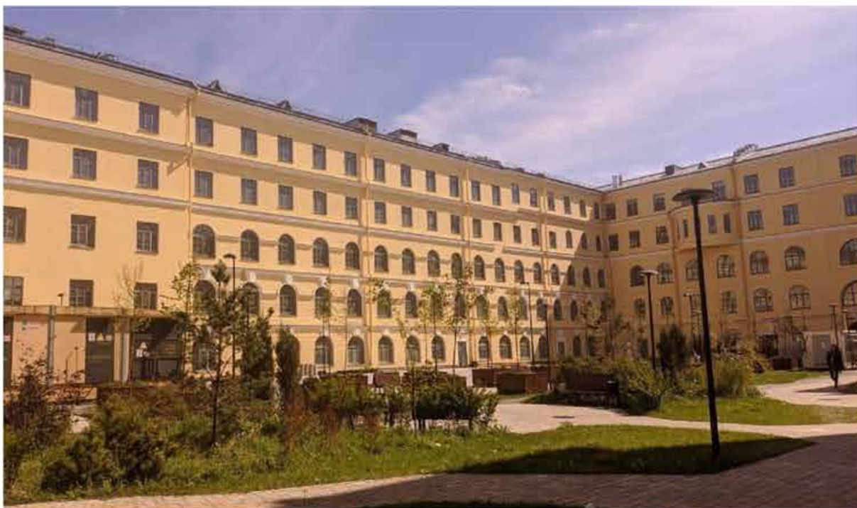
25. Вид на восточный и южный корпус со стороны внутреннего двора (дополнительная фотофиксация от 26.04.2022г.).
