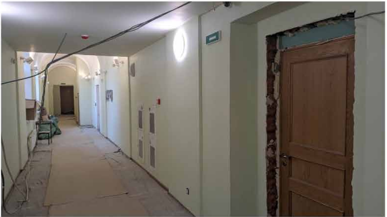
153. Вид в интерьере коридора зоны «Консерватория» в уровне 2-го этажа западного корпуса.
