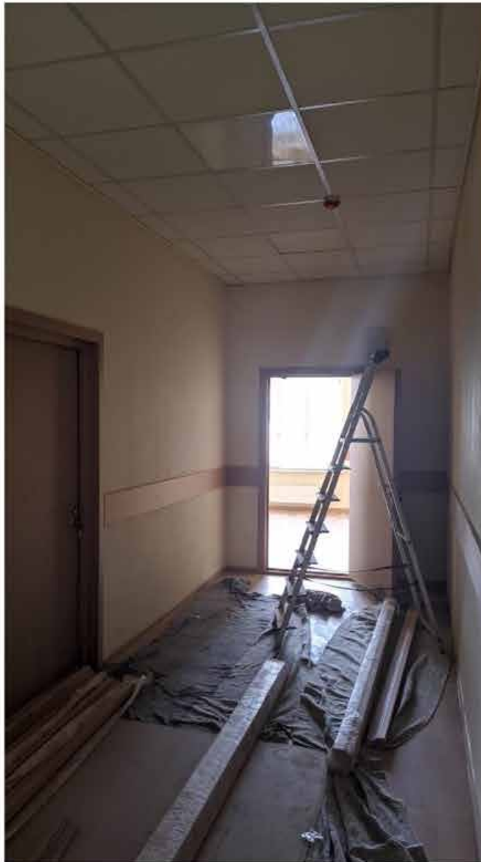
212. Вид в интерьере коридора зоны «Консерватория» в уровне 4-го этажа западного корпуса.
