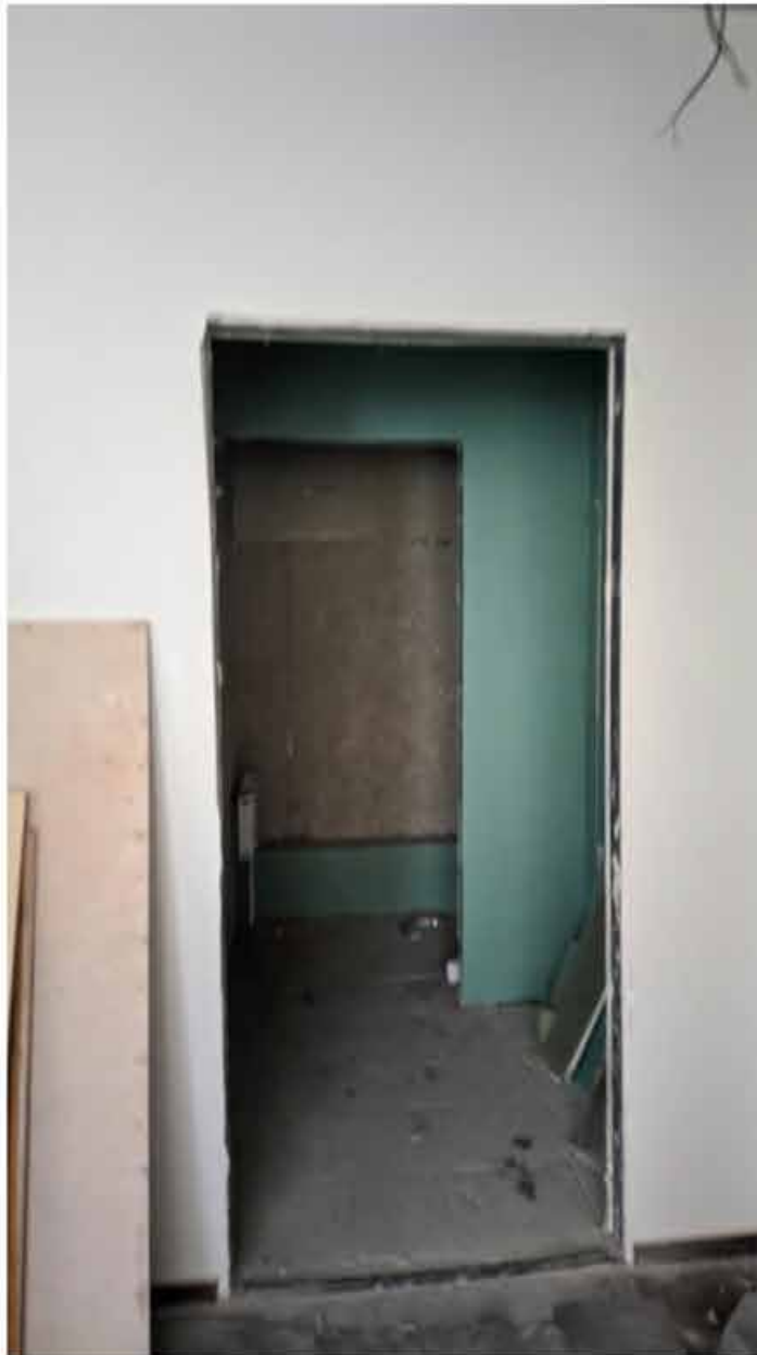
106. Вид в интерьере зоны «РВИО» в уровне 4-го этажа северного корпуса.
