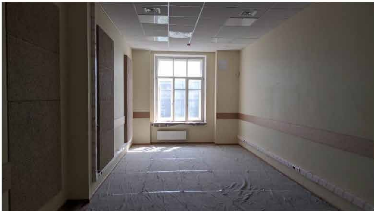
222. Вид в интерьере зоны «Консерватория» в уровне 4-го этажа южного корпуса.
