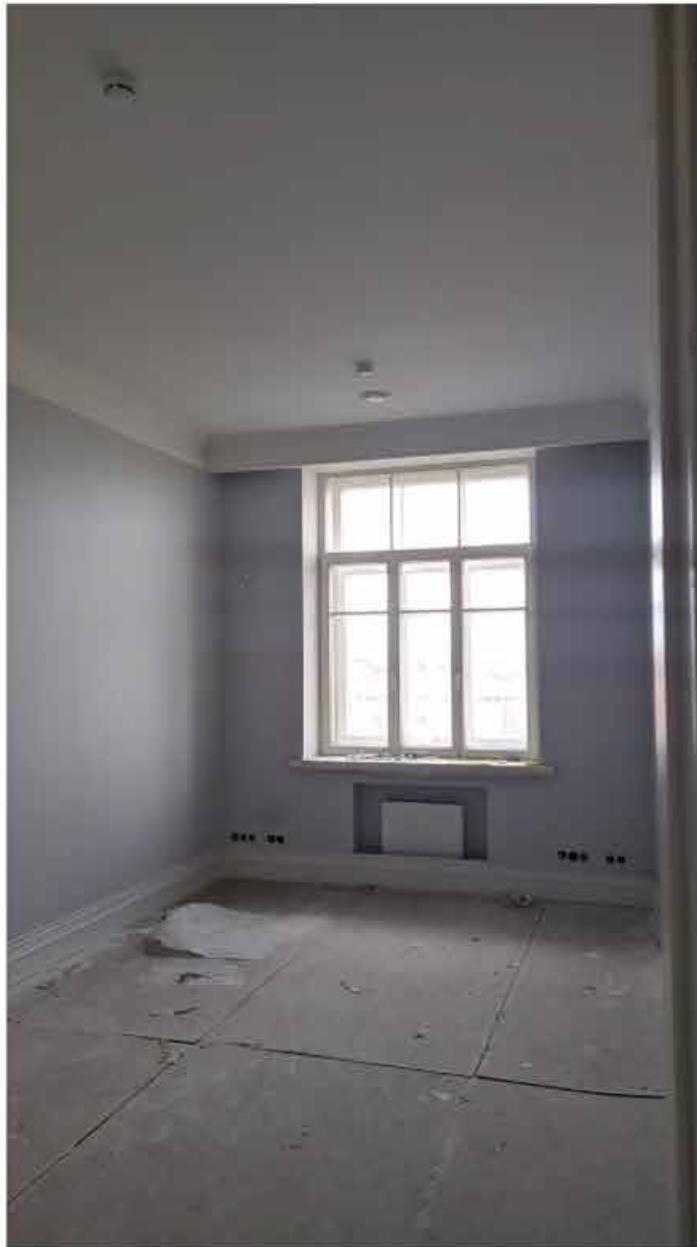
116. Вид в интерьере зоны «РВИО» в уровне 5-го этажа северного корпуса.
