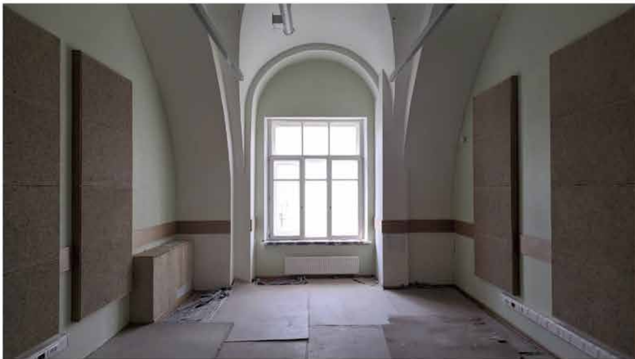
164. Вид в интерьере зоны «Консерватория» в уровне 3-го этажа западного корпуса.
