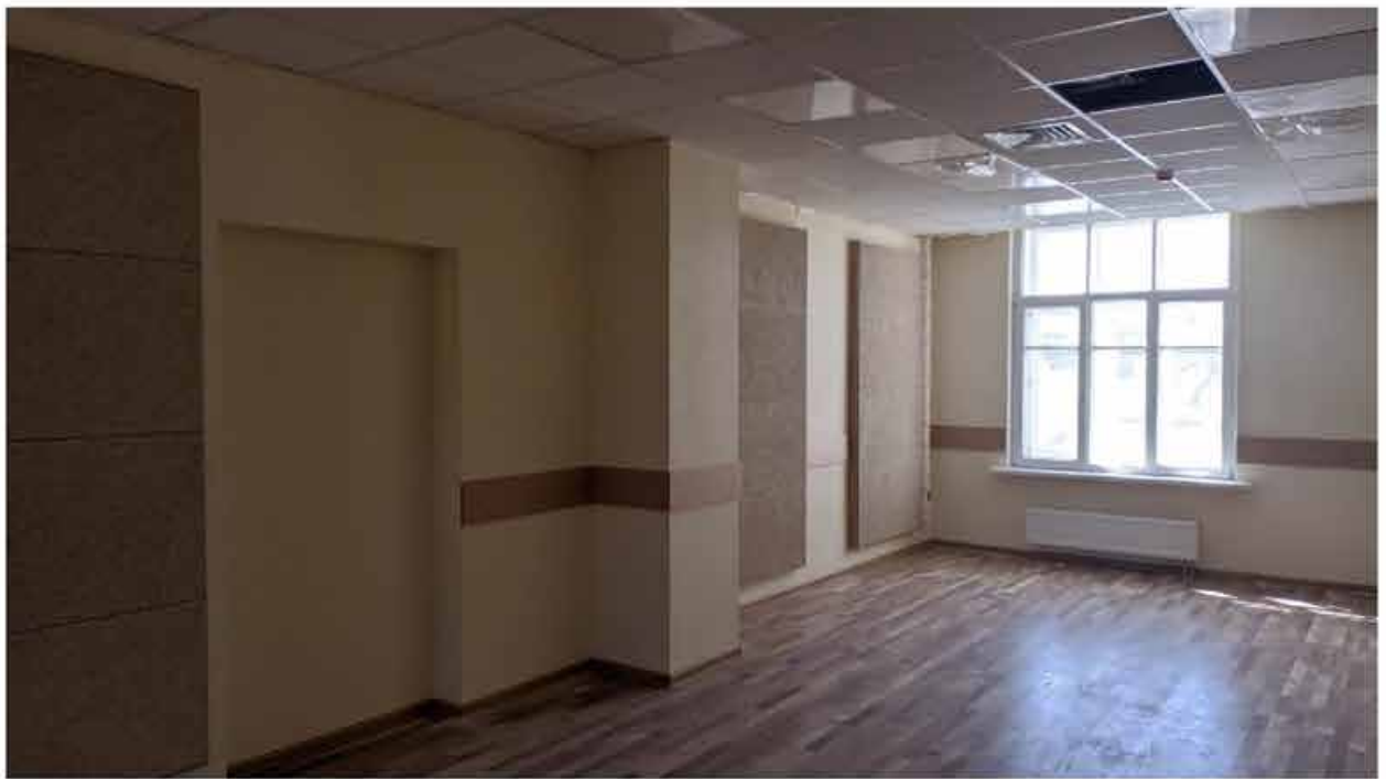
305. Вид в интерьере зоны «Консерватория» в уровне 5-го этажа западного корпуса.
