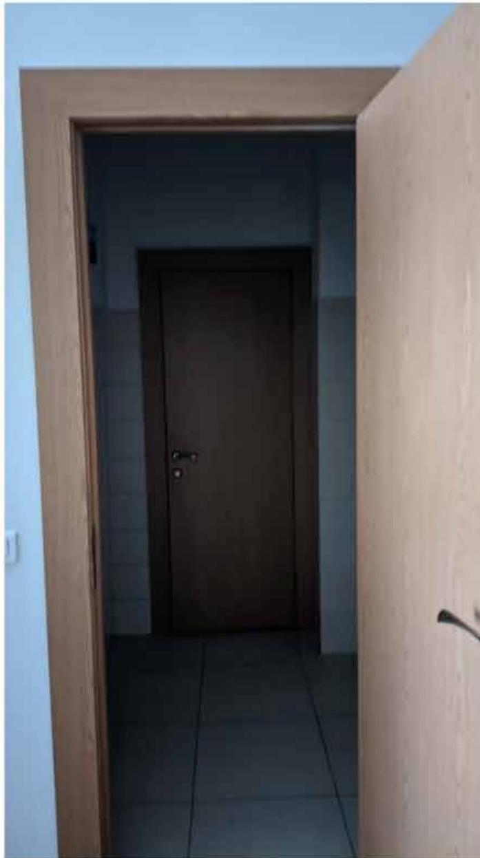
66. Вид в интерьере санузла зоны «СЗД» в уровне 3-го этажа южного корпуса.
