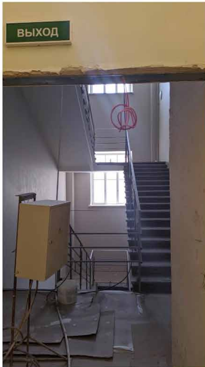
155. Вид на лестничную клетку зоны «Консерватория» в уровне 2-го этажа западного корпуса.
