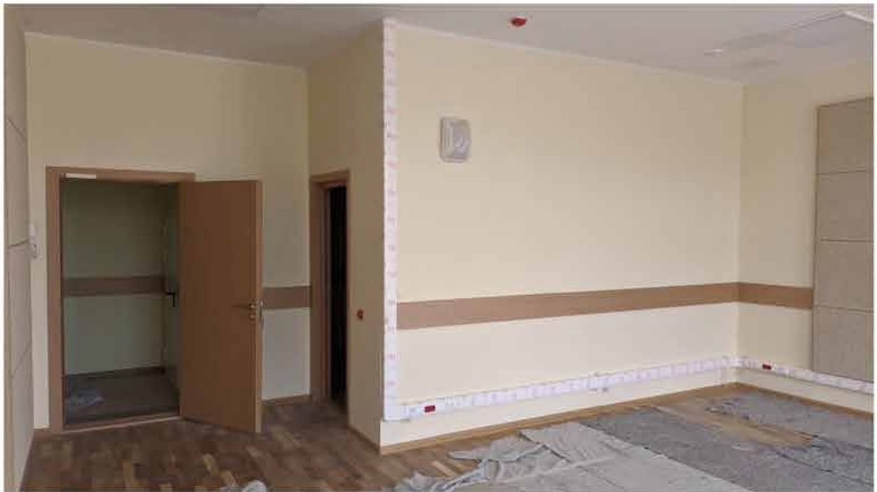
252. Вид в интерьере зоны «Консерватория» в уровне 4-го этажа южного корпуса.
