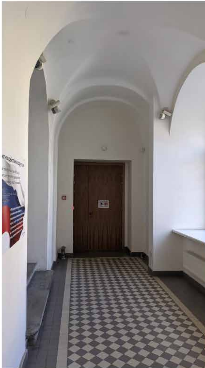
37. Вид в интерьере зоны «СЗД» в уровне 2-го этажа южного корпуса.
