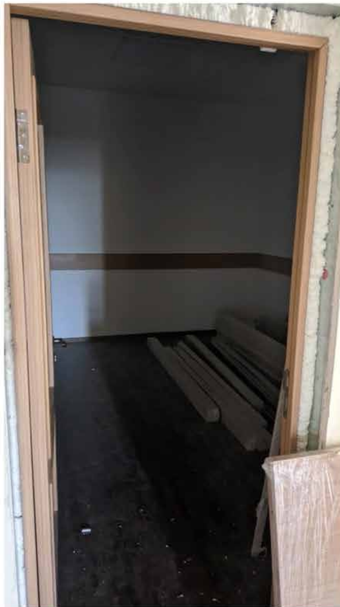
213. Вид в интерьере зоны «Консерватория» в уровне 4-го этажа западного корпуса.
