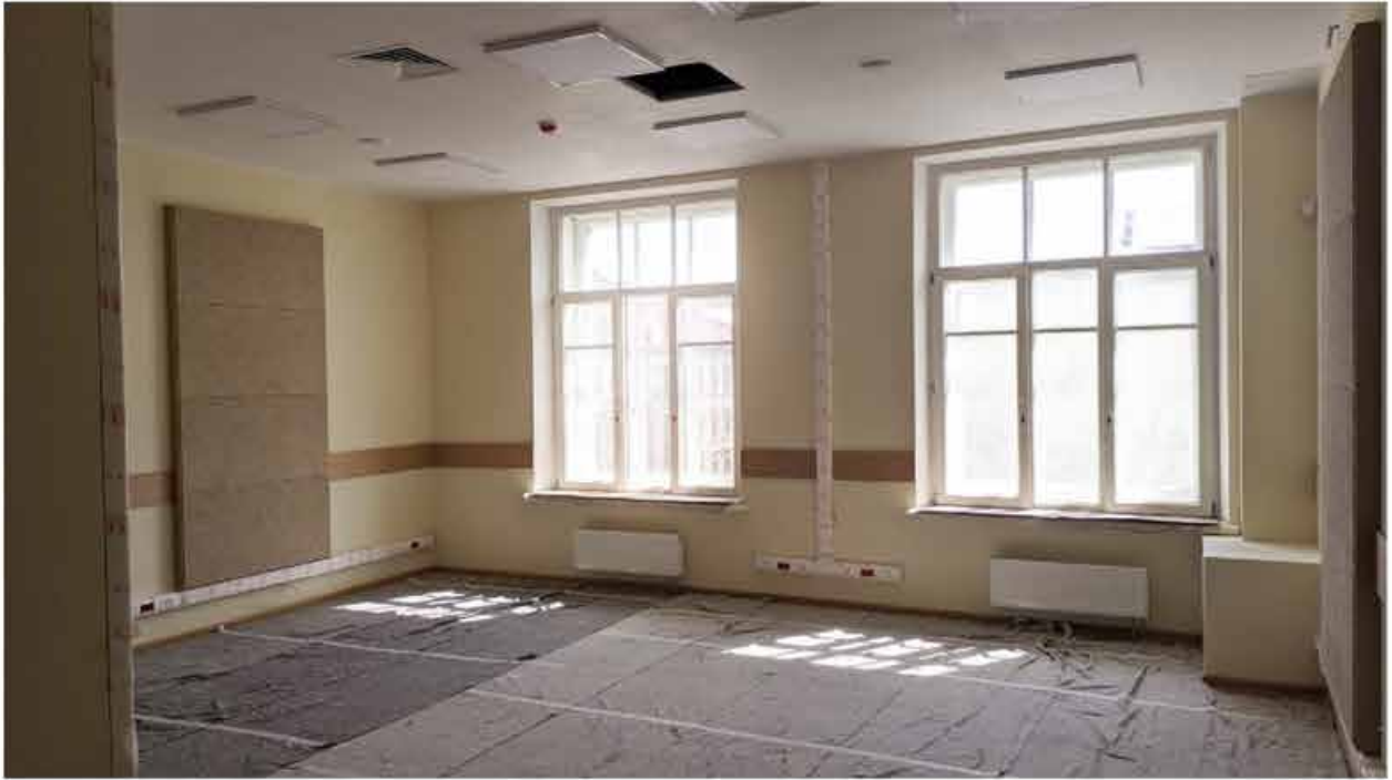
251. Вид в интерьере зоны «Консерватория» в уровне 4-го этажа южного корпуса.
