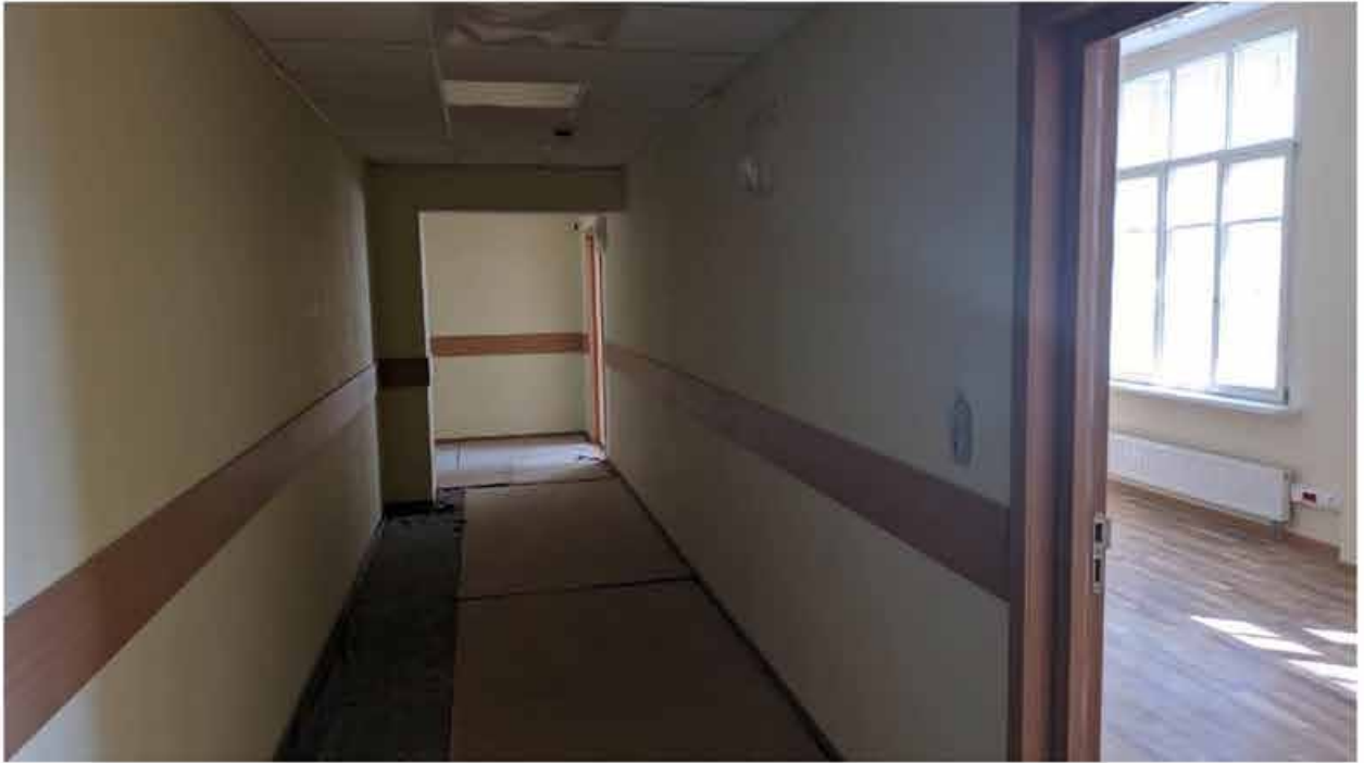
281. Вид в интерьере коридора зоны «Консерватория» в уровне 5-го этажа южного корпуса.
