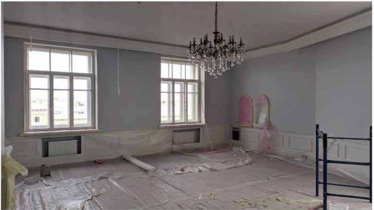
124. Вид в интерьере зоны «РВИО» в уровне 5-го этажа северного корпуса.
