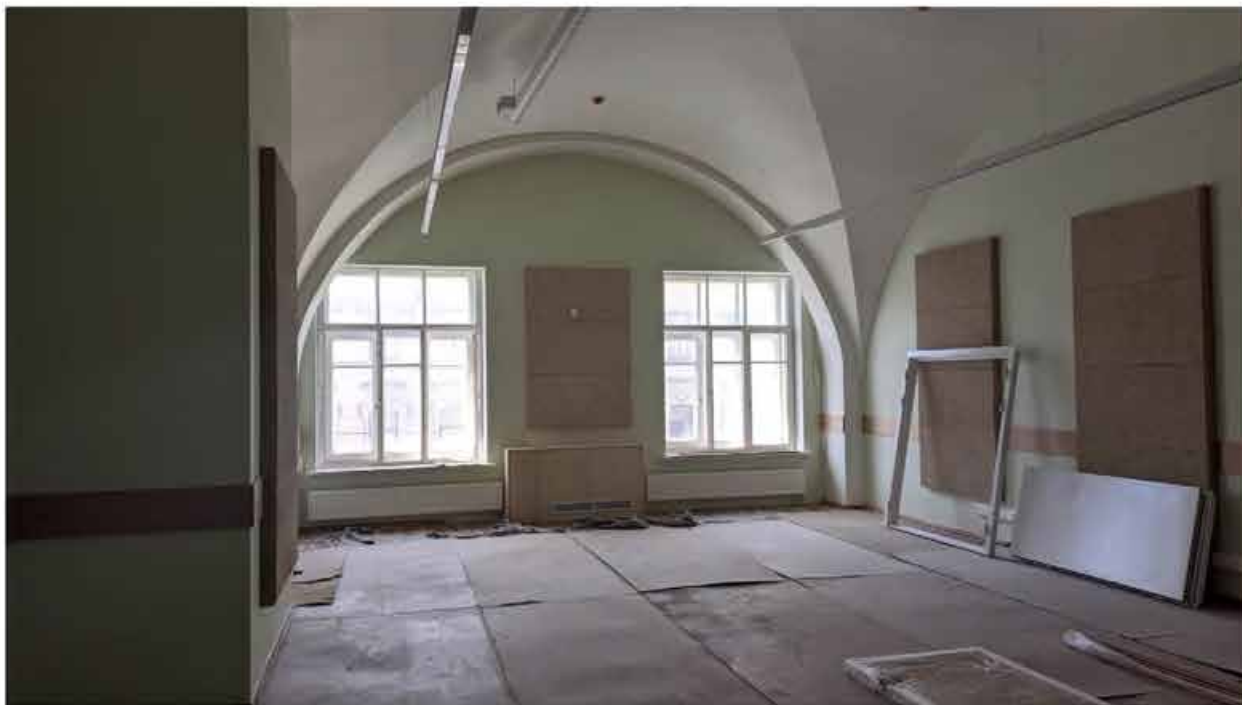
161. Вид в интерьере зоны «Консерватория» в уровне 3-го этажа западного корпуса.
