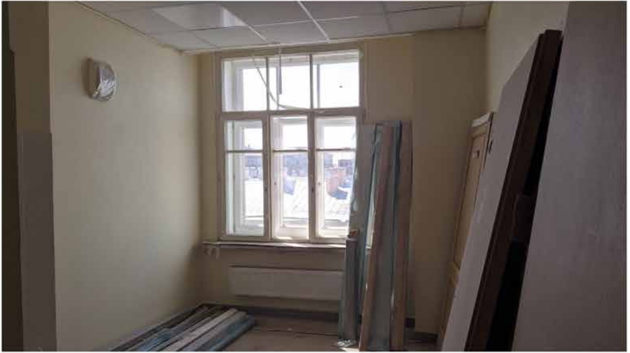
313. Вид в интерьере зоны «Консерватория» в уровне 5-го этажа западного корпуса.
