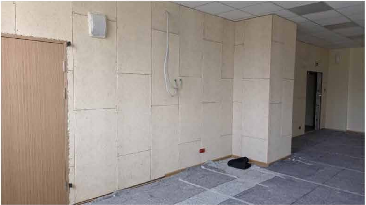
256. Вид в интерьере балкона репетиционного зала зоны «Консерватория» в уровне 5-го этажа южного корпуса.
