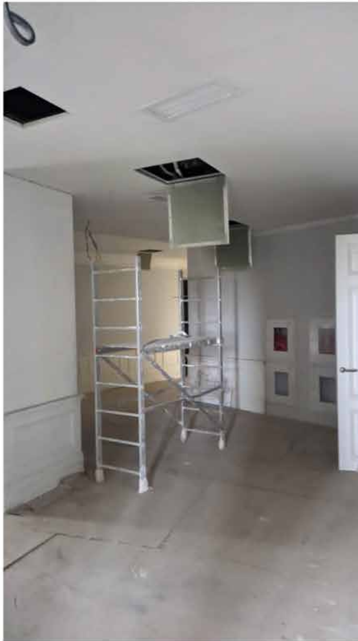
122. Вид в интерьере зоны «РВИО» в уровне 5-го этажа северного корпуса.
