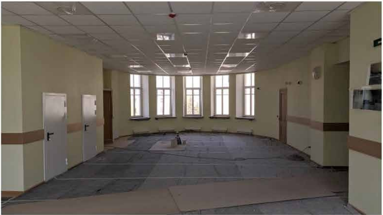
237. Вид в интерьере зоны «Консерватория» в уровне 4-го этажа южного корпуса.
