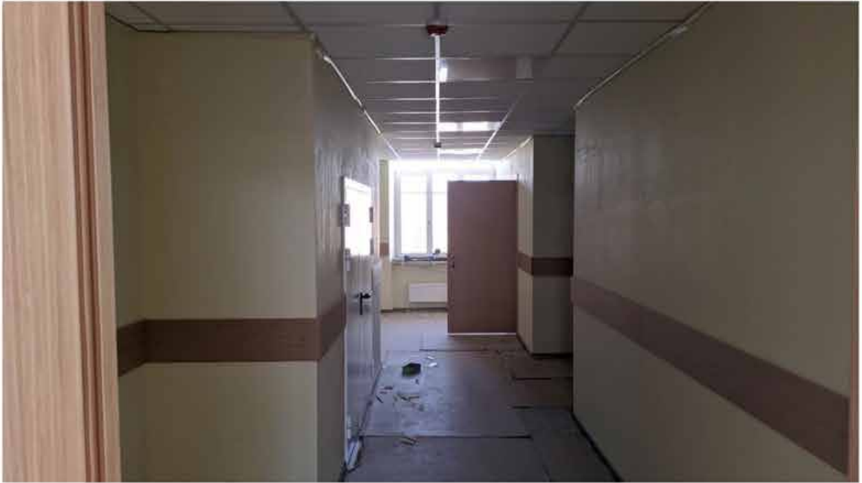
283. Вид в интерьере коридора зоны «Консерватория» в уровне 5-го этажа южного корпуса.
