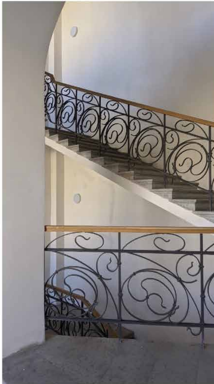
39. Виды в интерьере парадной лестницы зоны «СЗД» в уровне 2-го этажа южного корпуса.
