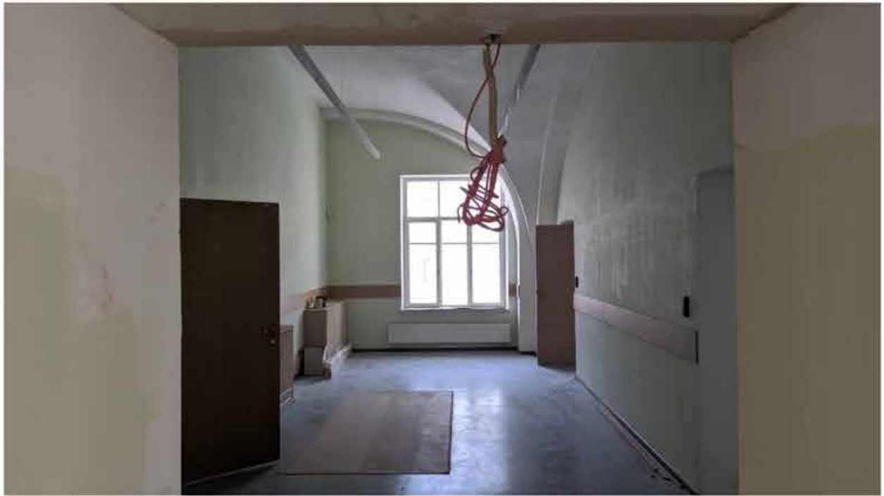
147. Вид в интерьере зоны «Консерватория» в уровне 2-го этажа западного корпуса.
