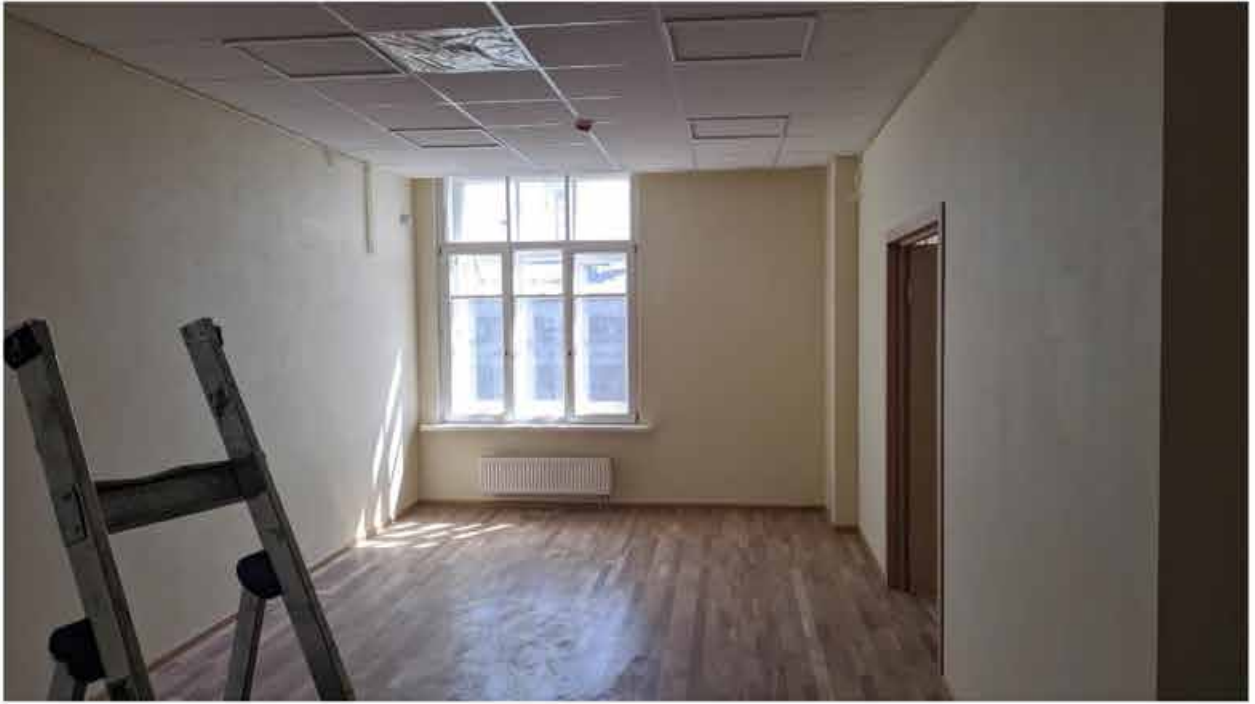
261. Вид в интерьере зоны «Консерватория» в уровне 5-го этажа южного корпуса.
