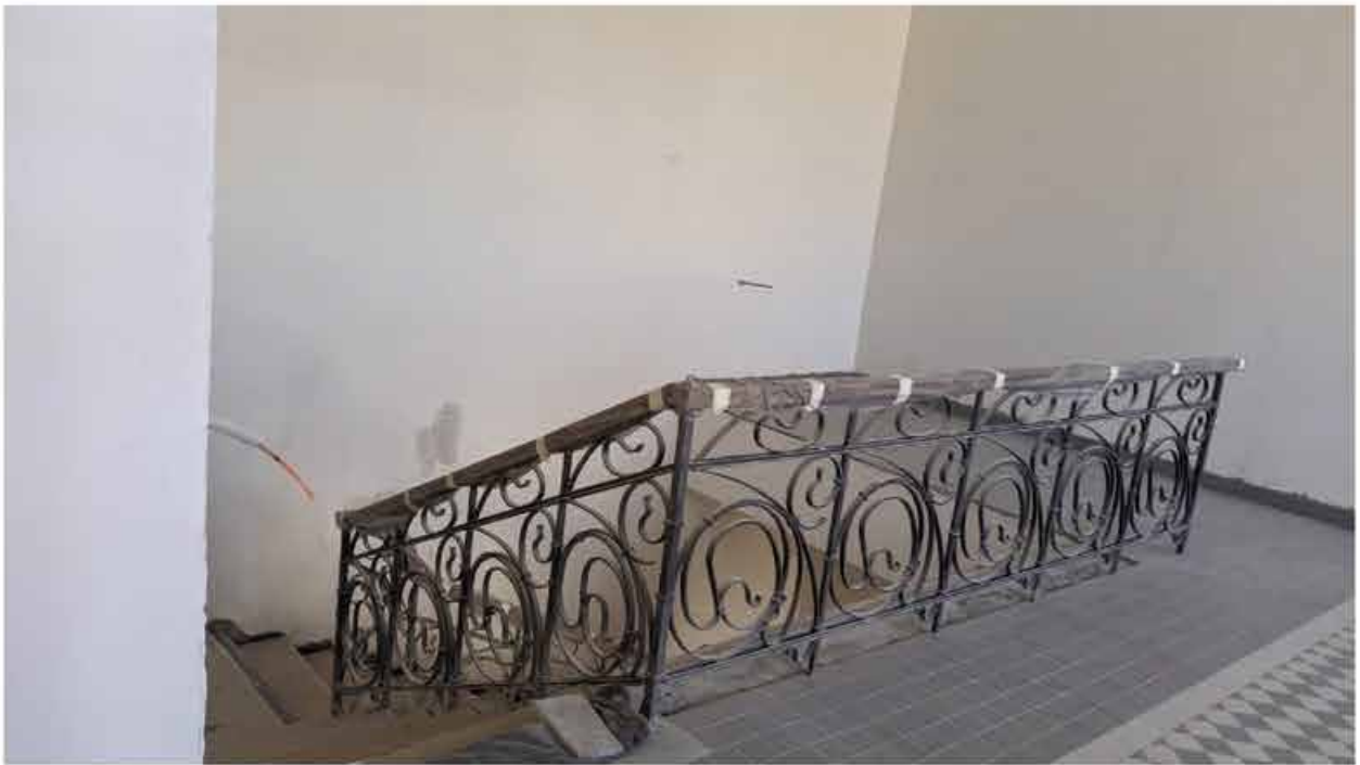
288.2. Вид в интерьере лестничной клетки зоны «Консерватория» в уровне 5-го этажа южного корпуса.
