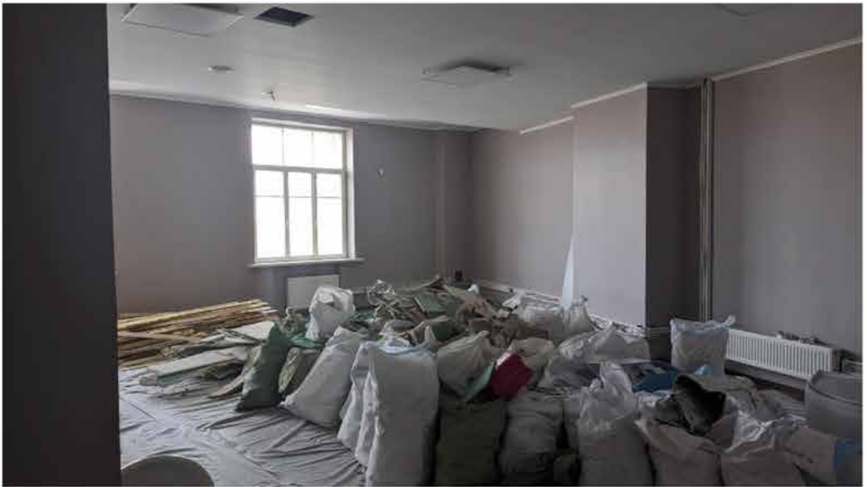
104. Вид в интерьере зоны «РВИО» в уровне 4-го этажа северного корпуса.
