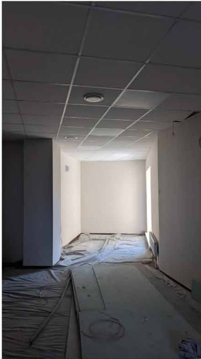
102. Вид в интерьере зоны «РВИО» в уровне 4-го этажа северного корпуса.
