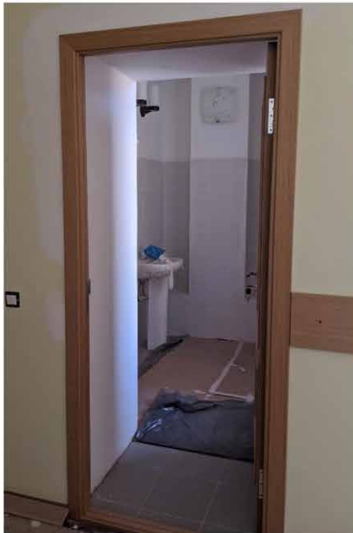
221. Вид в интерьере санузла зоны «Консерватория» в уровне 4-го этажа западного корпуса.
