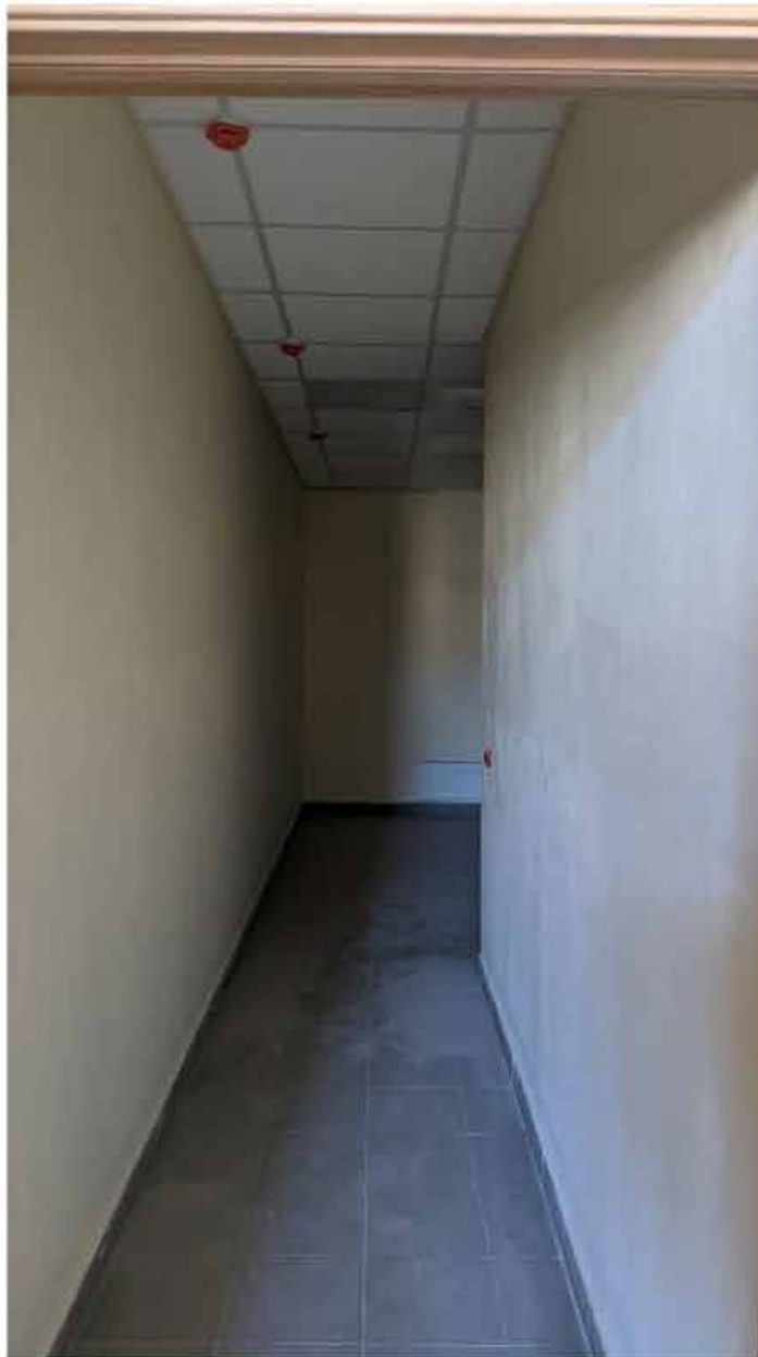
309. Вид в интерьере зоны «Консерватория» в уровне 5-го этажа западного корпуса.
