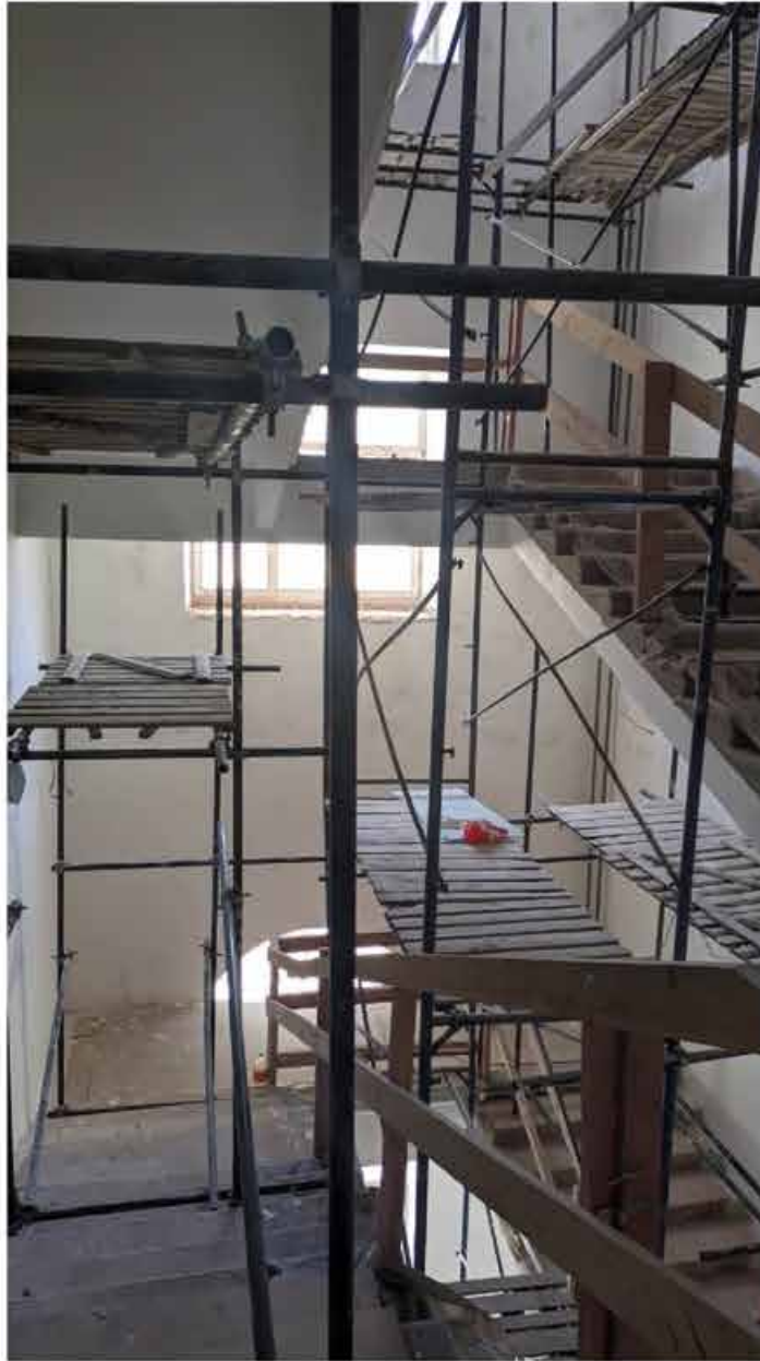
184. Вид на лестничную клетку зоны «Консерватория» в уровне 4-го этажа западного корпуса.
