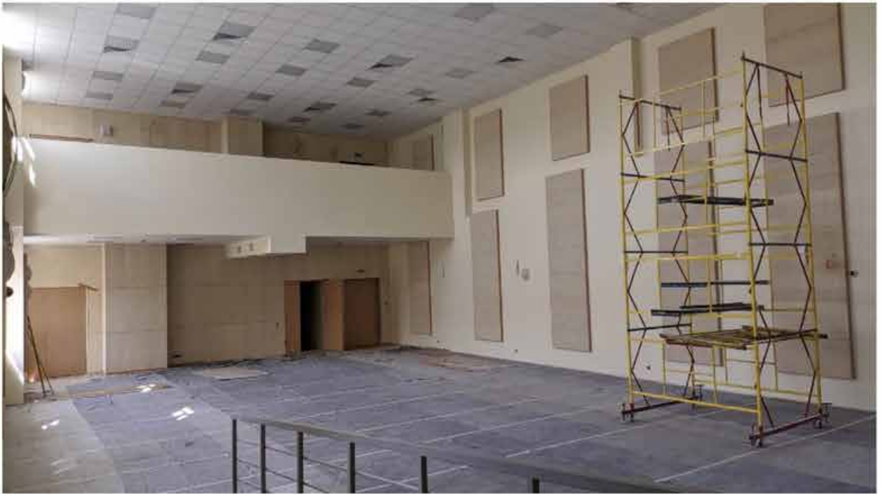
247. Вид в интерьере репетиционного зала зоны «Консерватория» в уровне 4-го этажа южного корпуса.
