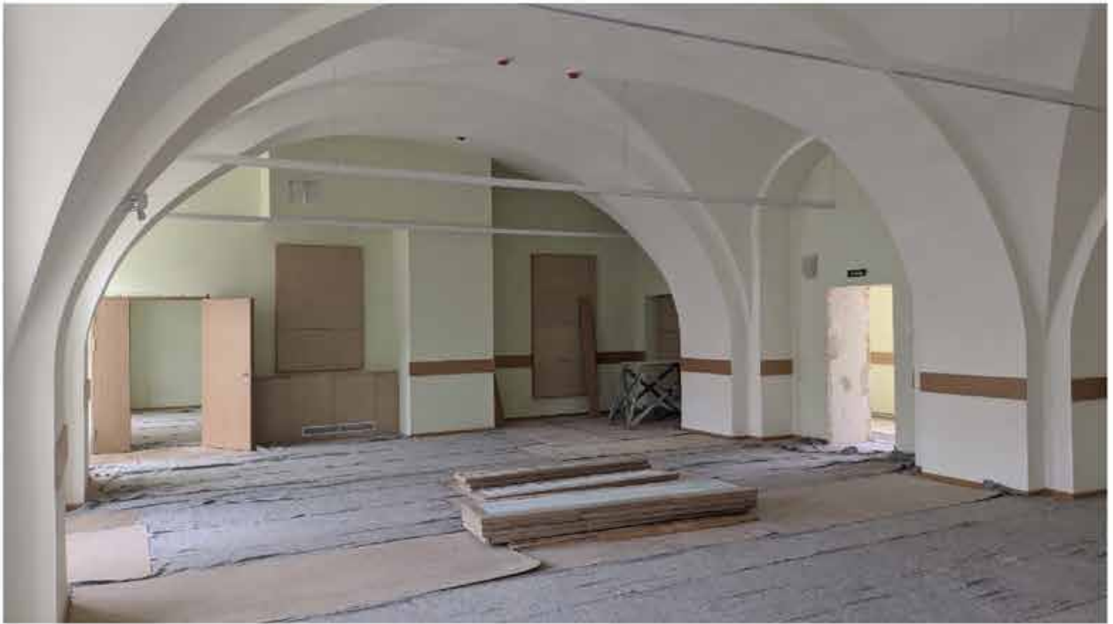
175. Вид в интерьере зоны «Консерватория» в уровне 3-го этажа западного корпуса.
