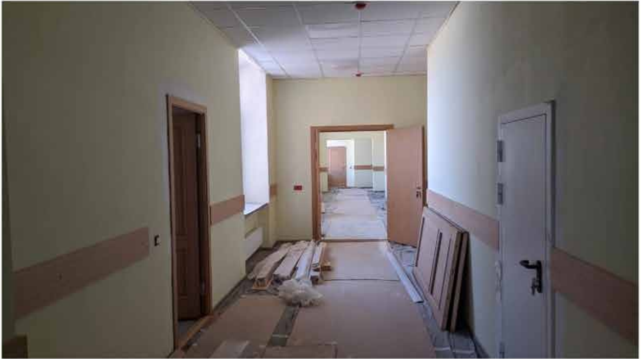
220. Вид в интерьере коридора зоны «Консерватория» в уровне 4-го этажа западного корпуса.
