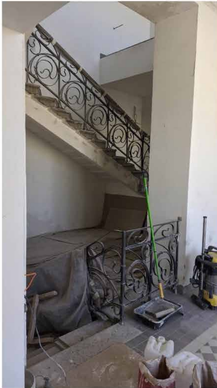
240. Вид в интерьере лестничной клетки зоны «Консерватория» в уровне 4-го этажа южного корпуса.
