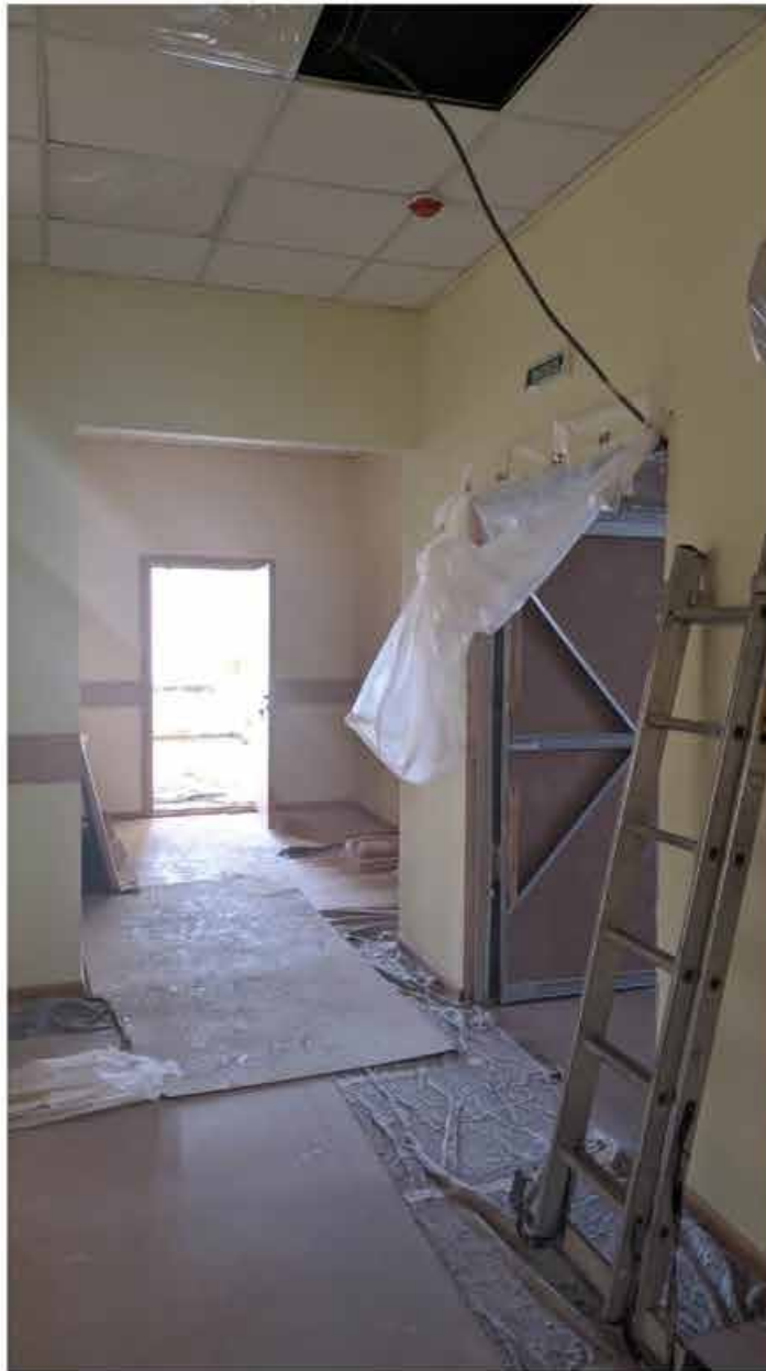
211. Вид в интерьере коридора зоны «Консерватория» в уровне 4-го этажа западного корпуса.
