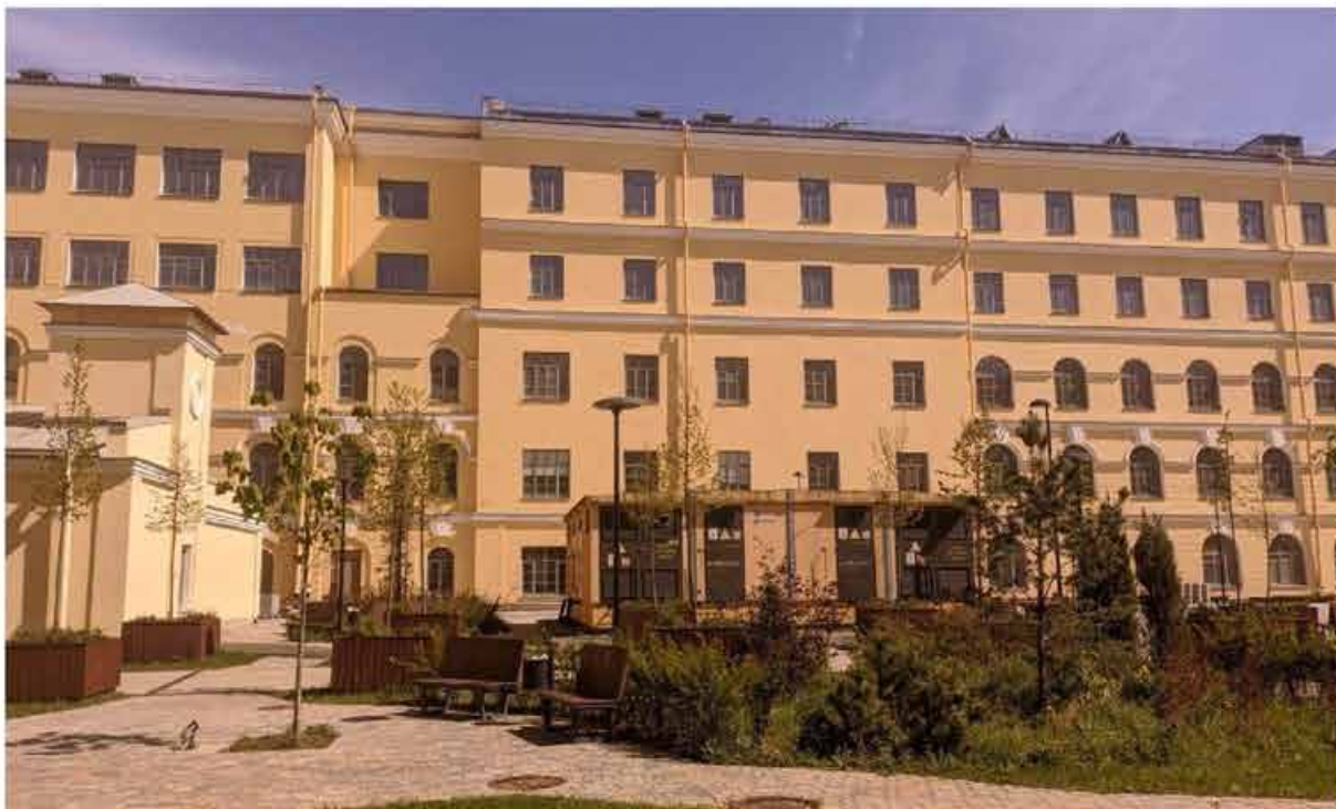
24. Вид на восточный корпус со стороны внутреннего двора (дополнительная фотофиксация от 26.04.2022г.).
