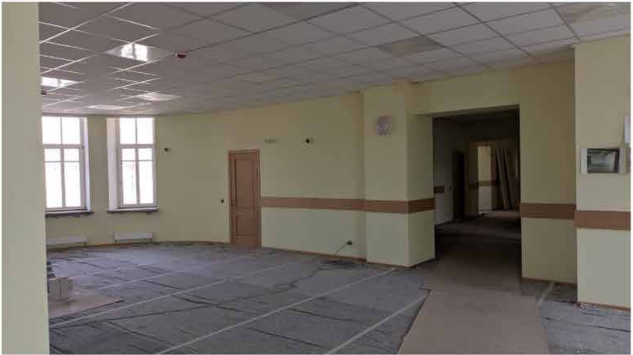
236. Вид в интерьере зоны «Консерватория» в уровне 4-го этажа южного корпуса.
