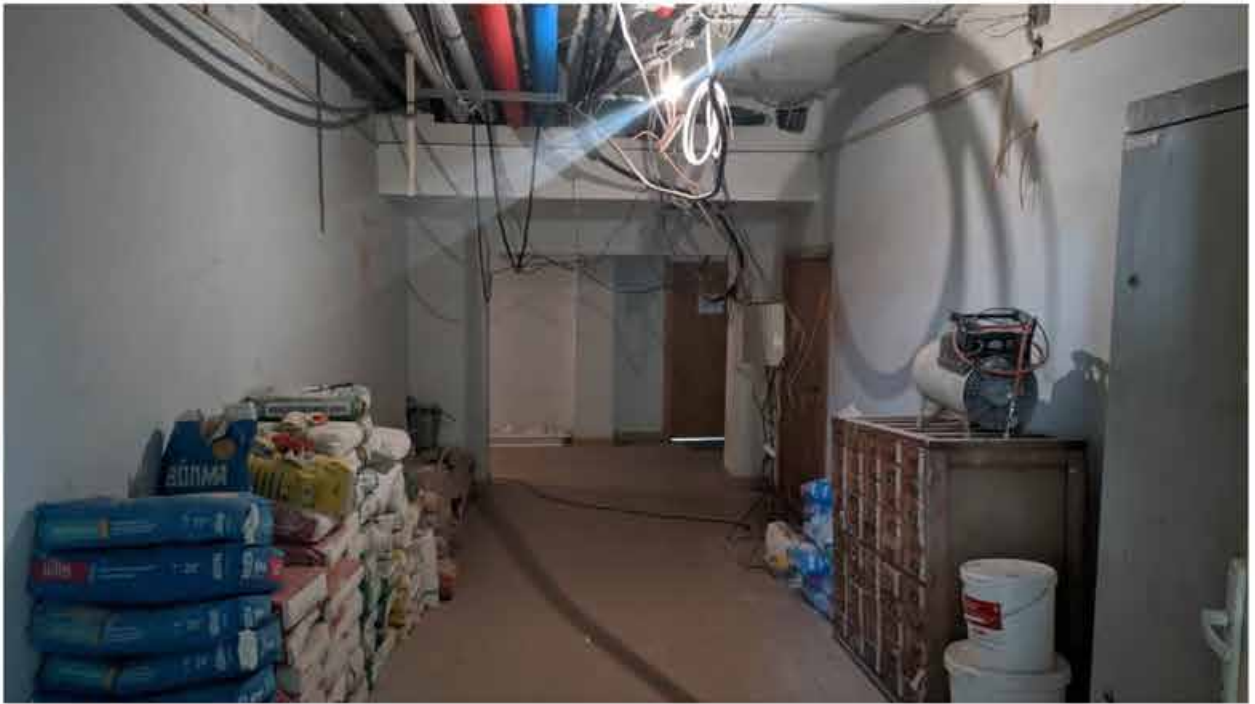
152. Вид в интерьере зоны «Консерватория» в уровне 2-го этажа западного корпуса.
