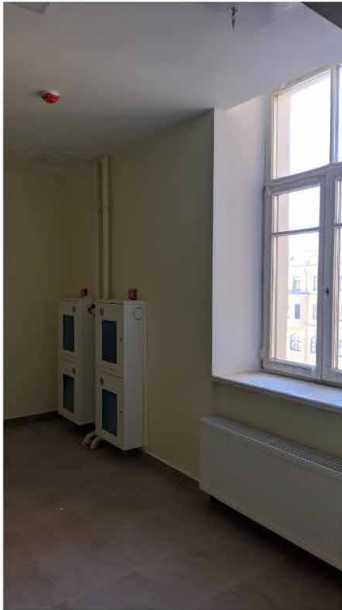
310. Вид в интерьере коридора зоны «Консерватория» в уровне 5-го этажа западного корпуса.
