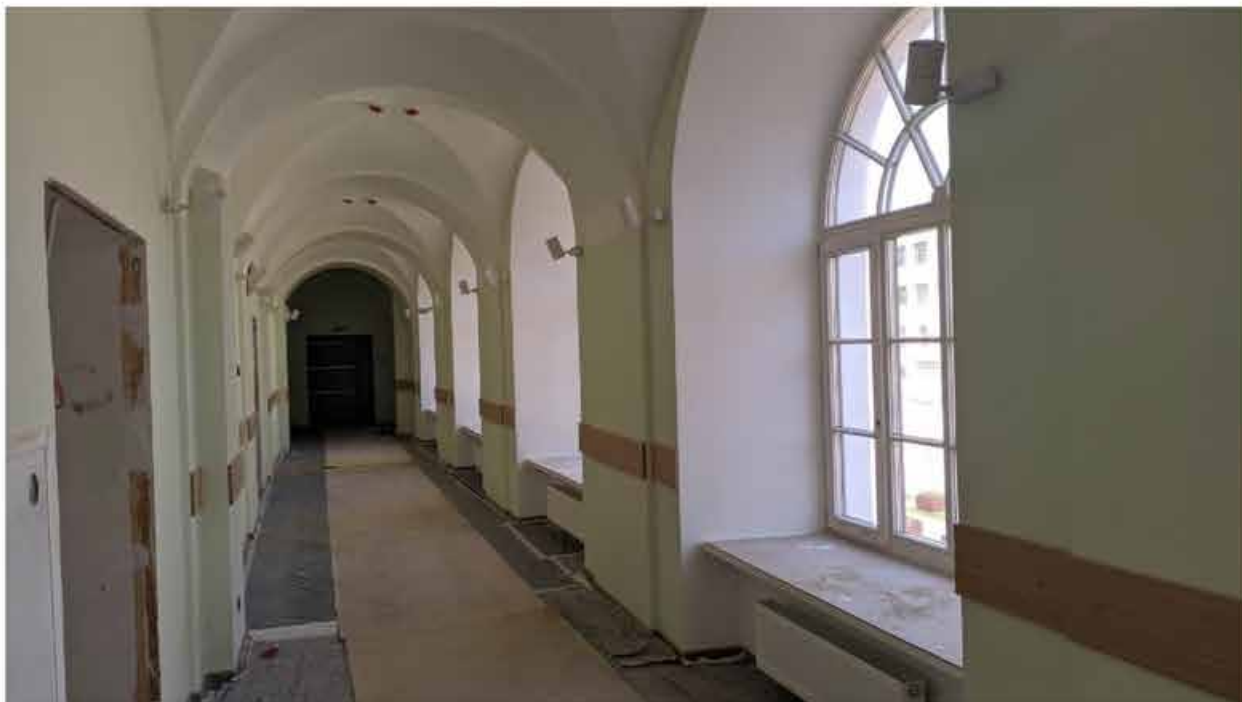
171. Вид в интерьере коридора зоны «Консерватория» в уровне 3-го этажа западного корпуса.
