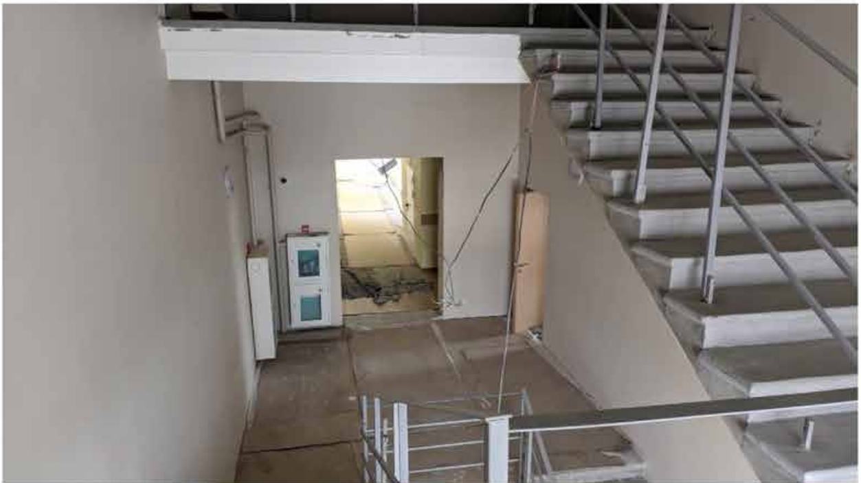
259.2. Вид в интерьере лестничной клетки зоны «Консерватория» в уровне 5-го этажа западного корпуса.
