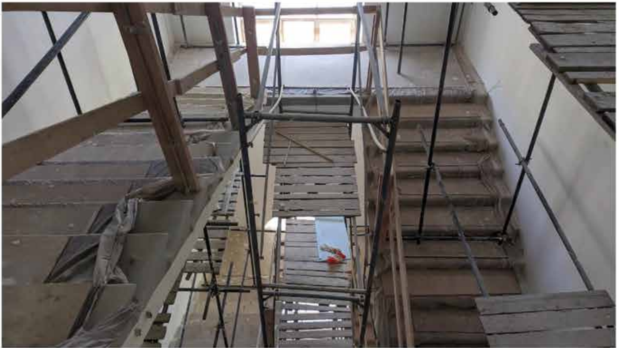
319. Вид в интерьере лестничной клетки зоны «Консерватория» в уровне 5-го этажа западного корпуса.
