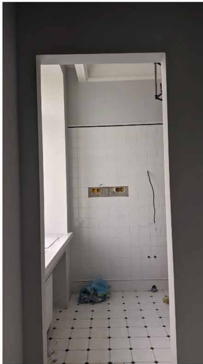
126. Вид в интерьере зоны «РВИО» в уровне 5-го этажа северного корпуса.
