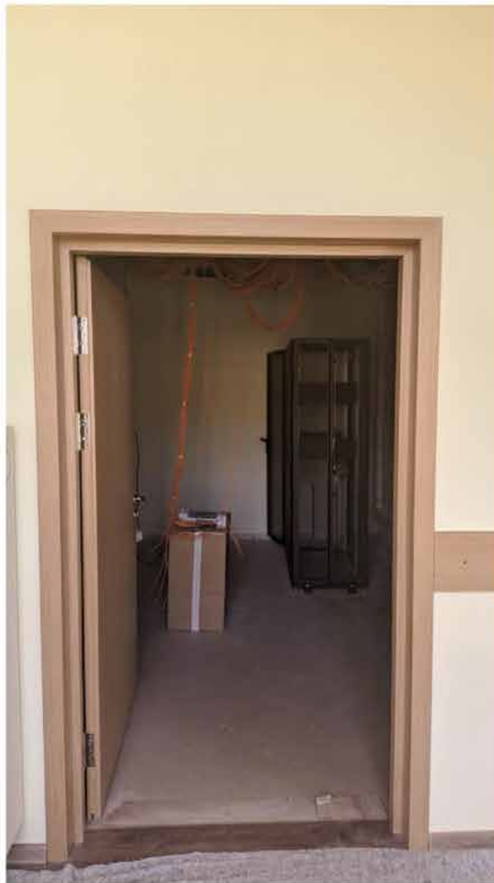
200. Вид в интерьере зоны «Консерватория» в уровне 4-го этажа западного корпуса.
