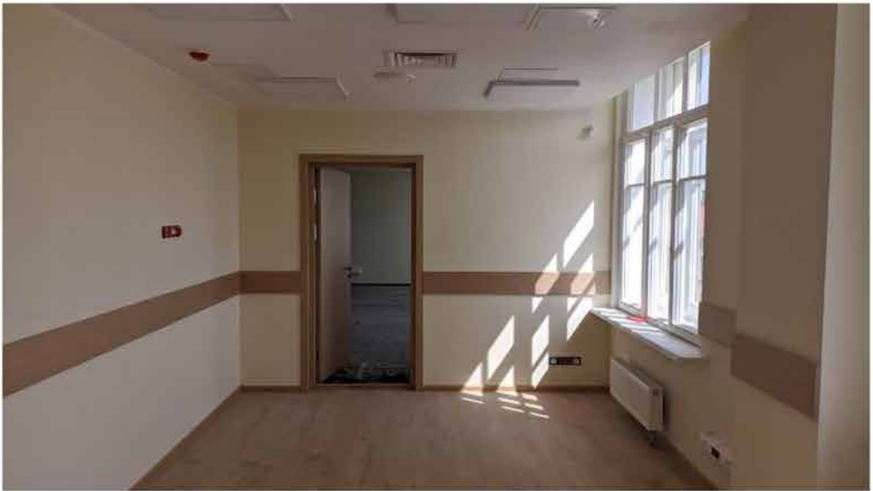
284. Вид в интерьере зоны «Консерватория» в уровне 5-го этажа южного корпуса.
