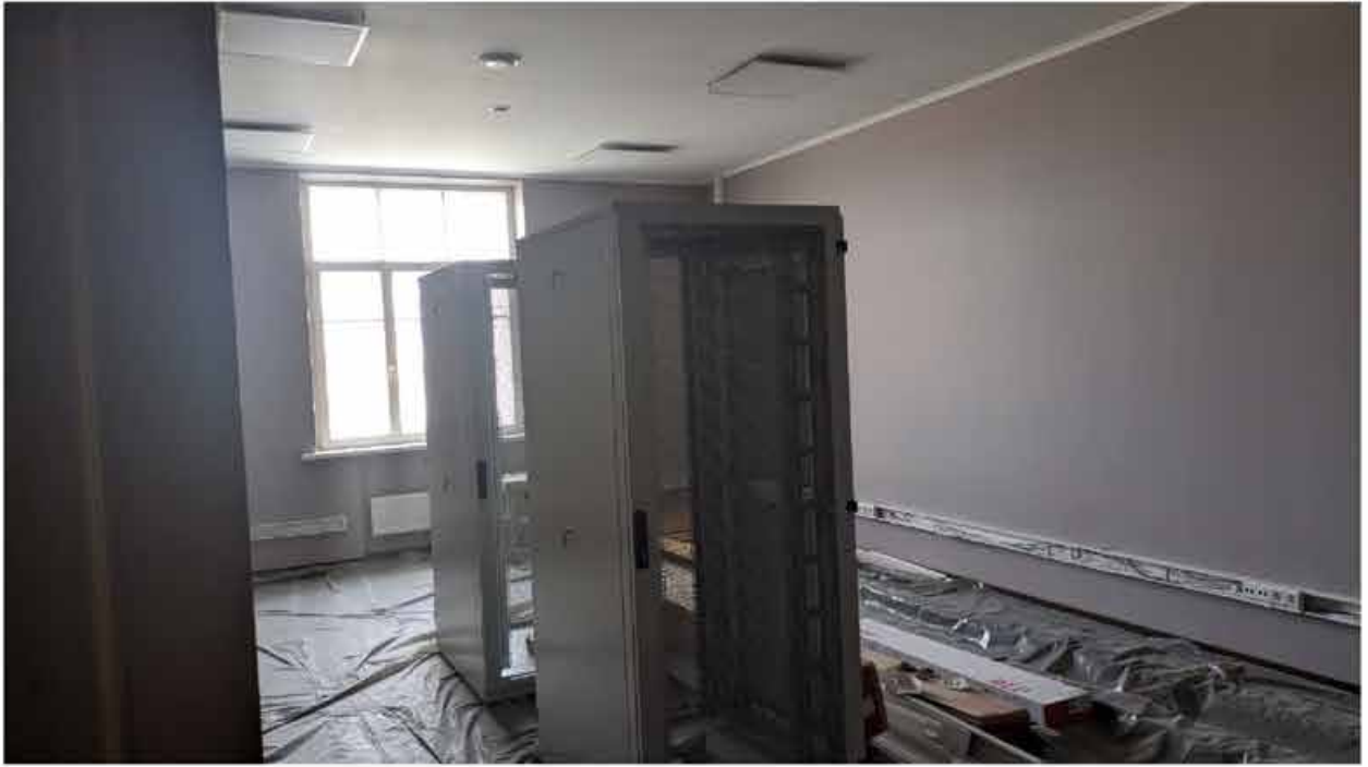
103. Вид в интерьере зоны «РВИО» в уровне 4-го этажа северного корпуса.
