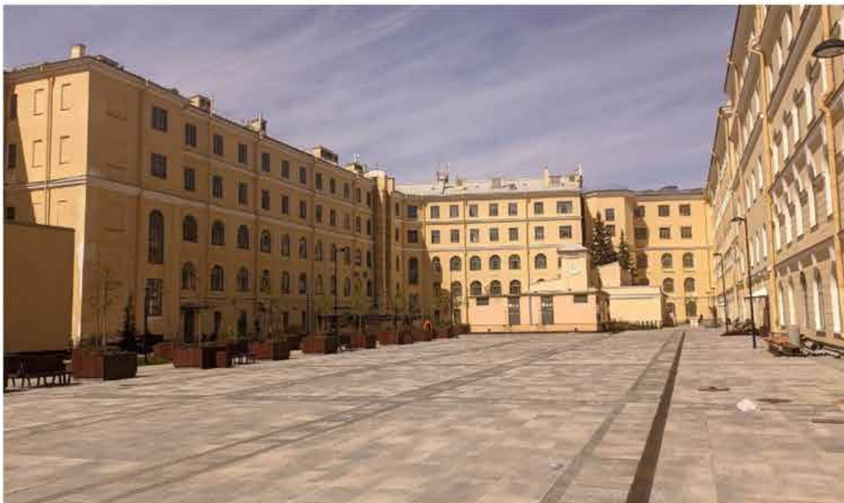
13. Вид на западный и северный корпус со стороны внутреннего двора (дополнительная фотофиксация от 26.04.2022г.).
