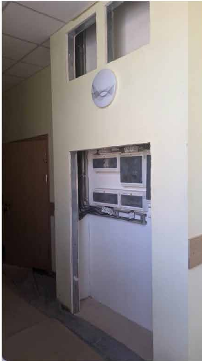
208. Вид в интерьере коридора зоны «Консерватория» в уровне 4-го этажа западного корпуса.
