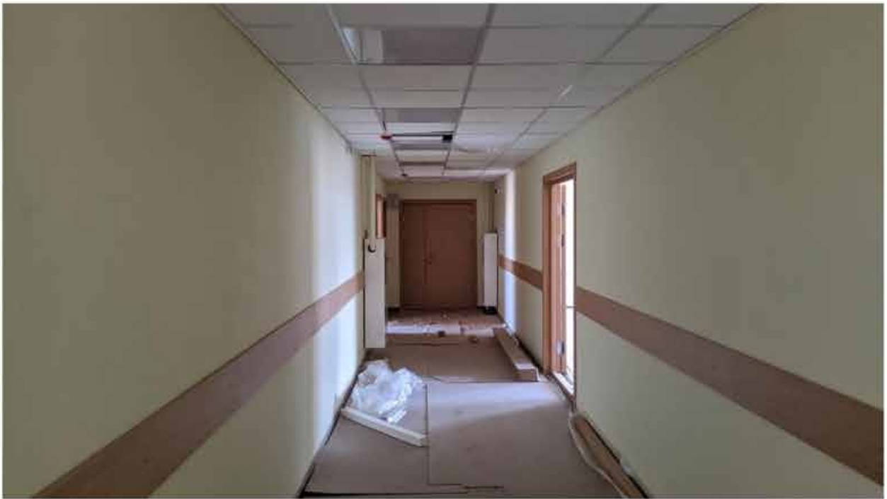
291. Вид в интерьере коридора зоны «Консерватория» в уровне 5-го этажа южного корпуса.
