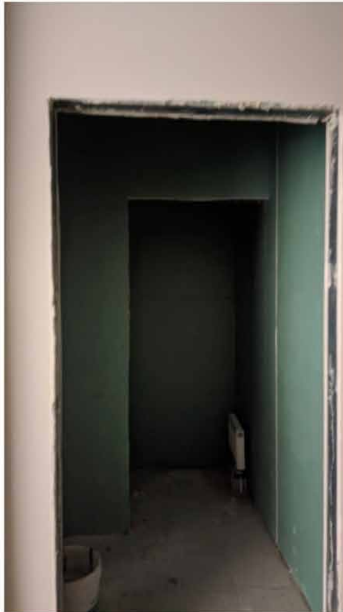
107. Вид в интерьере зоны «РВИО» в уровне 4-го этажа северного корпуса.
