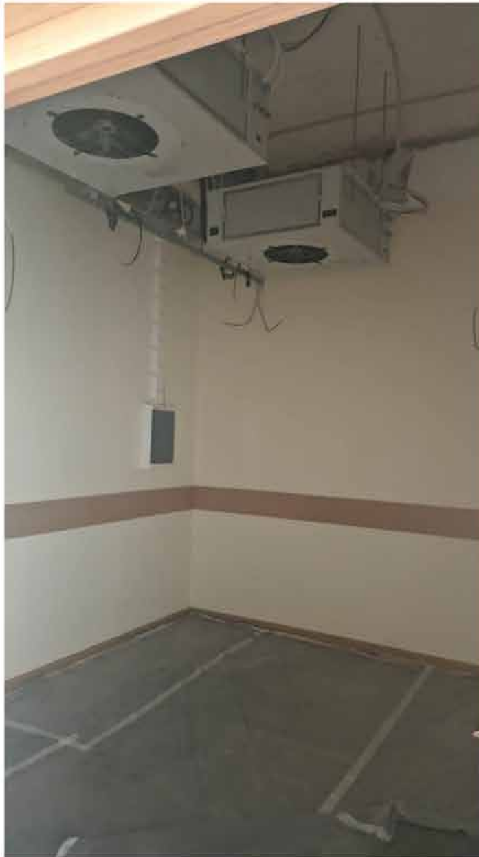
253. Вид в интерьере зоны «Консерватория» в уровне 4-го этажа южного корпуса.
