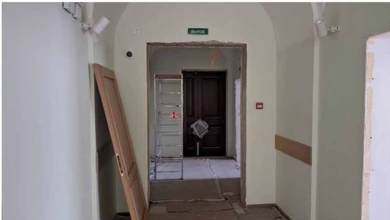
163. Вид в интерьере коридора зоны «Консерватория» в уровне 3-го этажа западного корпуса.
