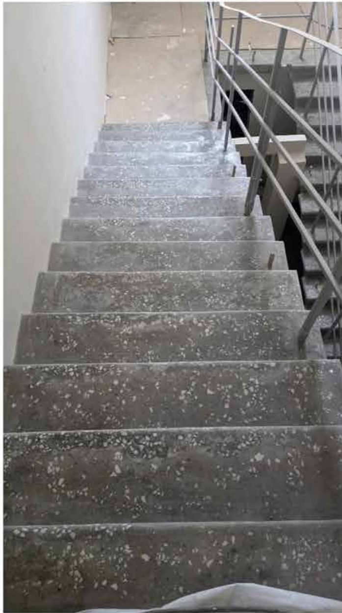
158. Вид в интерьере зоны «Консерватория» в уровне 2-го этажа западного корпуса.
