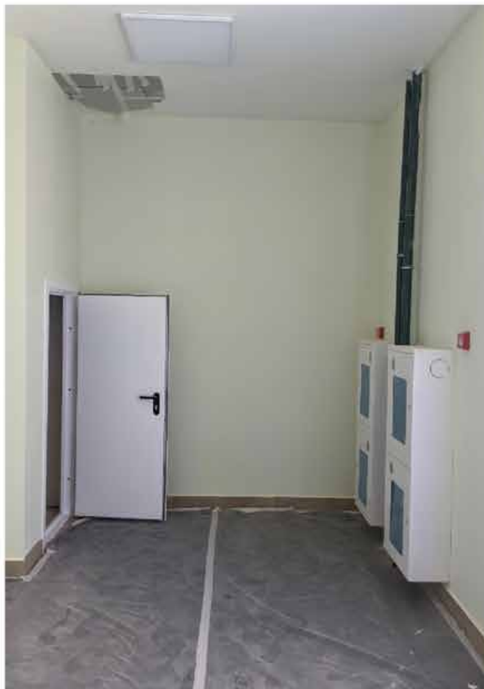
179. Вид в интерьере коридора зоны «Консерватория» в уровне 3-го этажа западного корпуса.
