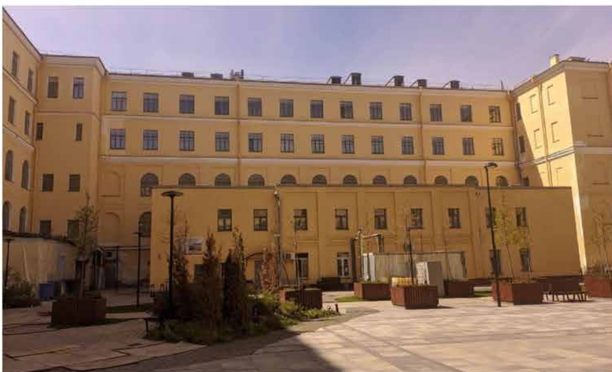
14. Вид на западный корпус со стороны внутреннего двора (дополнительная фотофиксация от 26.04.2022г.).
