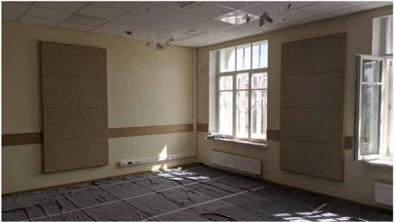
243. Вид в интерьере зоны «Консерватория» в уровне 4-го этажа южного корпуса.
