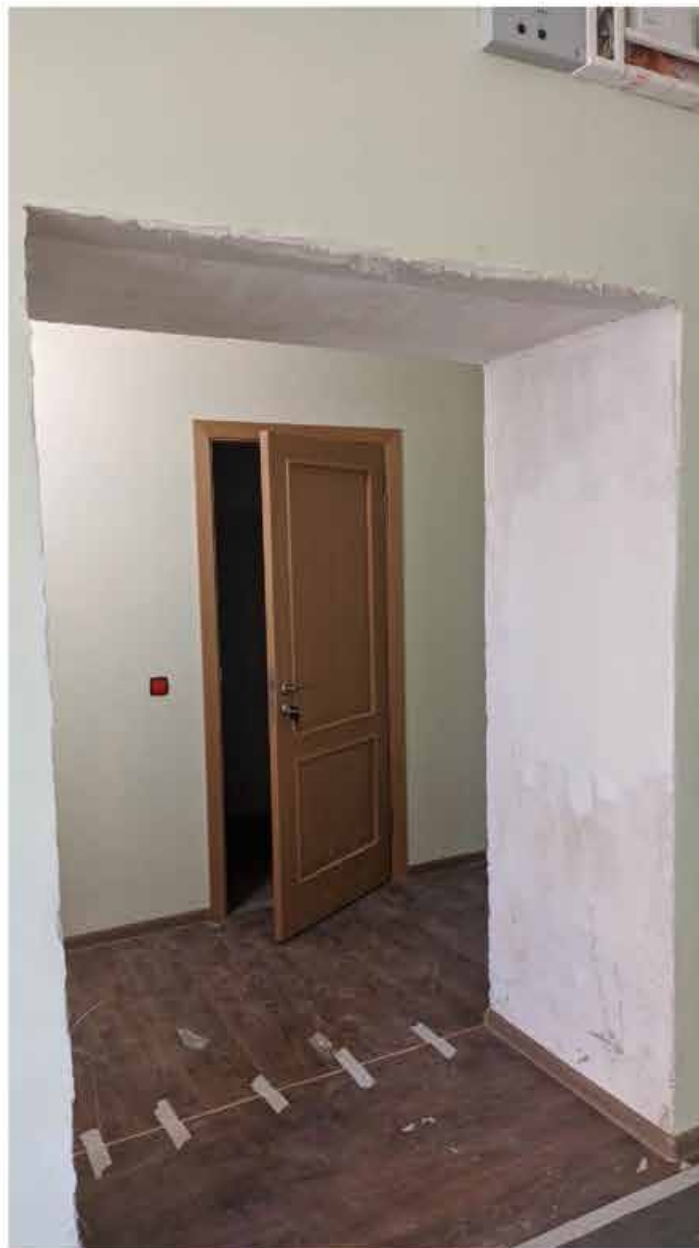
177. Вид в интерьере коридора зоны «Консерватория» в уровне 3-го этажа западного корпуса.
