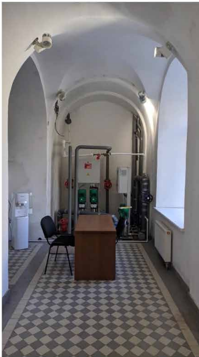
29. Вид в интерьере зоны «СЗД» в уровне 1-го этажа южного корпуса.
