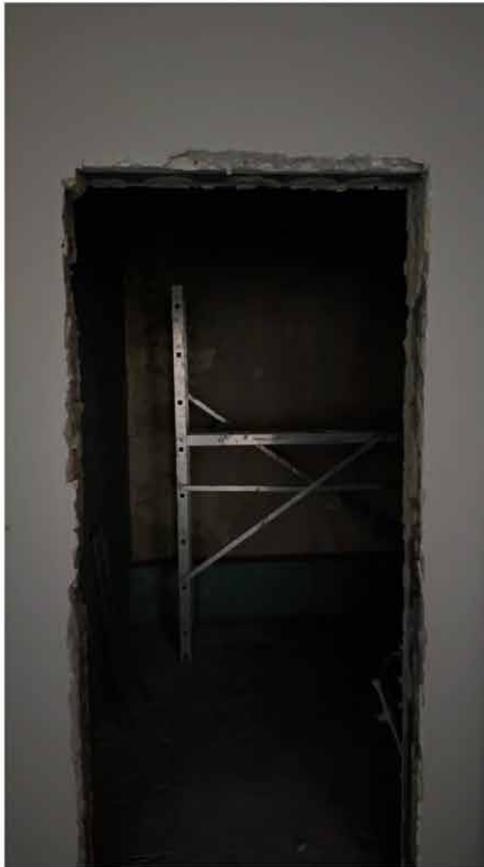
105. Вид в интерьере зоны «РВИО» в уровне 4-го этажа северного корпуса.
