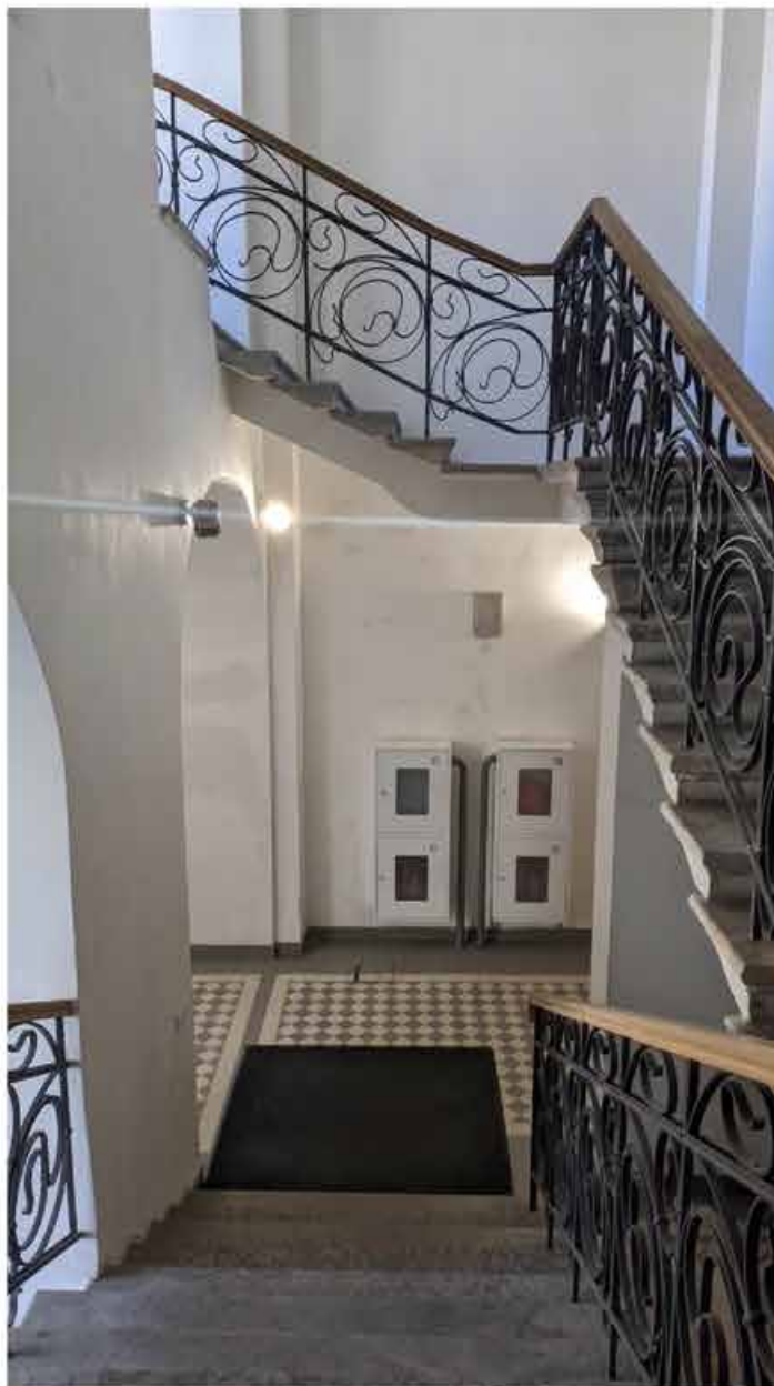
35. Вид с промежуточной площадки лестничной клетки зоны «СЗД» в уровне 1-го этажа южного корпуса.
