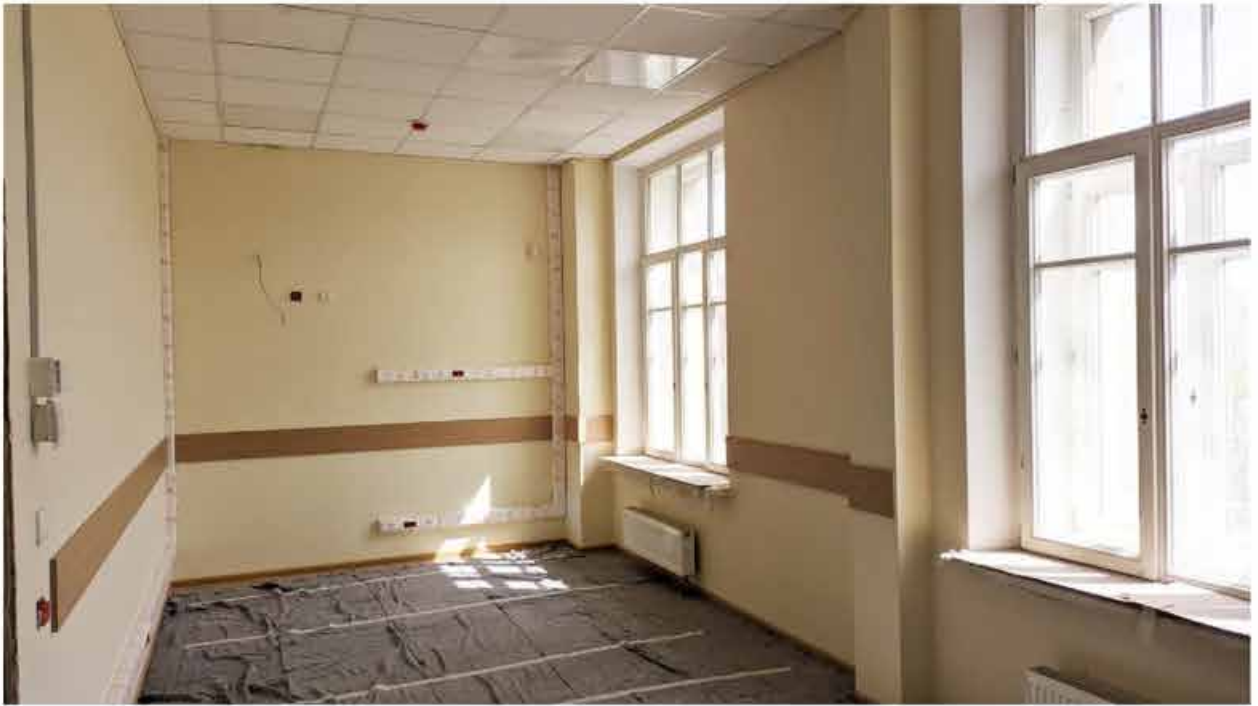
234. Вид в интерьере зоны «Консерватория» в уровне 4-го этажа южного корпуса.
