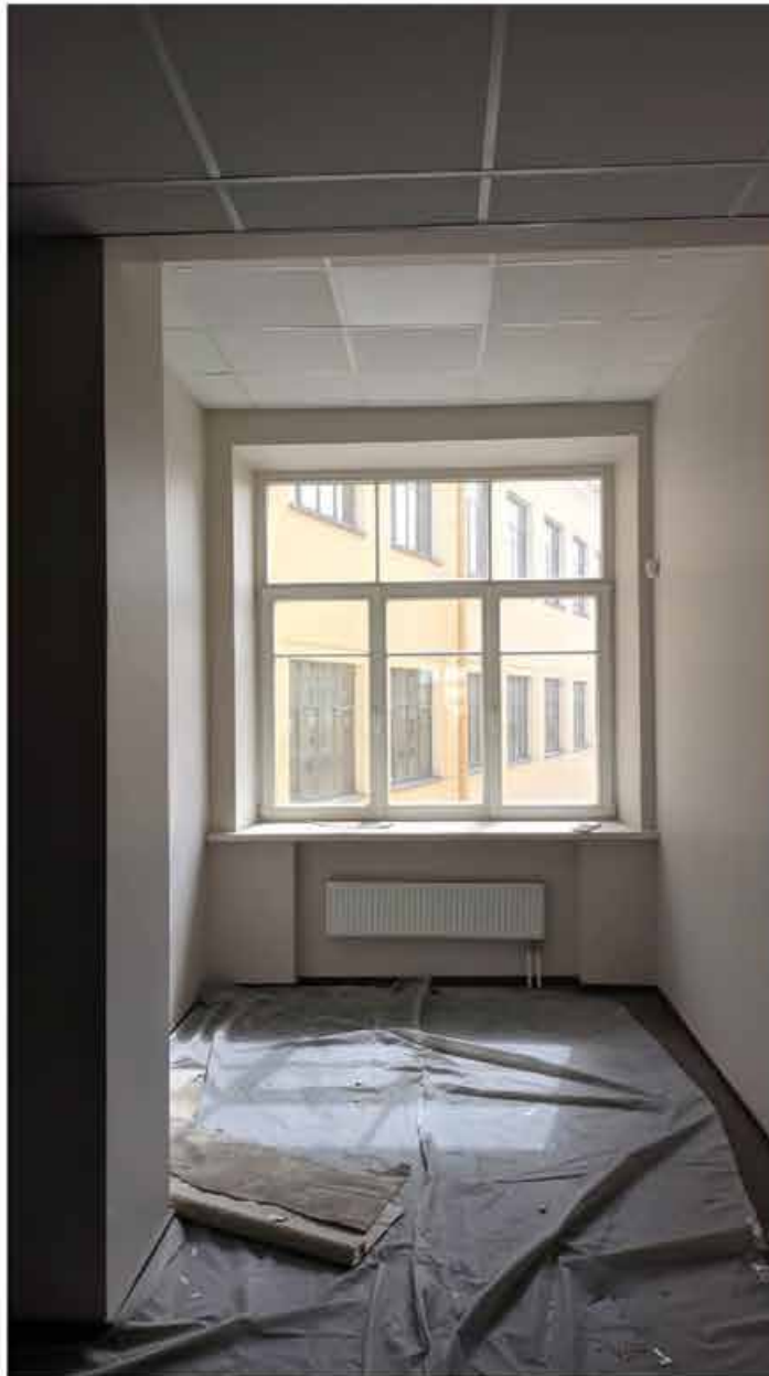
98. Вид в интерьере зоны «РВИО» в уровне 4-го этажа северного корпуса.
