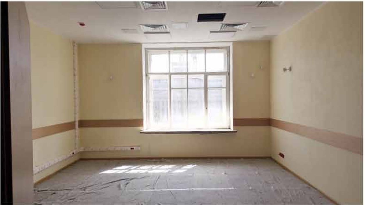
229. Вид в интерьере зоны «Консерватория» в уровне 4-го этажа южного корпуса.
