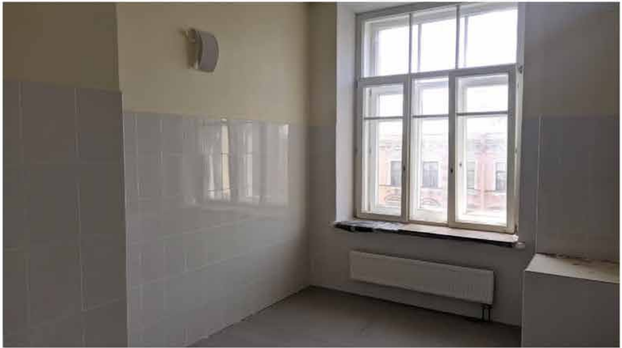
190. Вид в интерьере санузла зоны «Консерватория» в уровне 4-го этажа западного корпуса.
