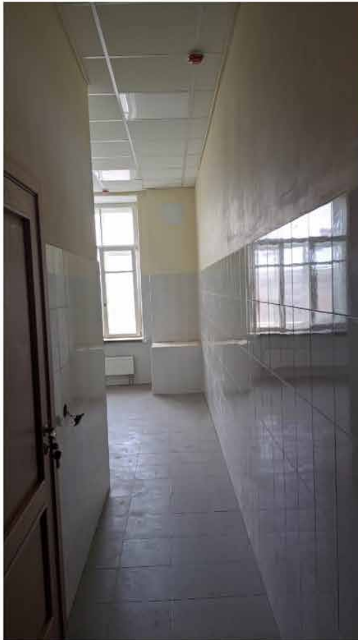
189. Вид в интерьере санузла зоны «Консерватория» в уровне 4-го этажа западного корпуса.
