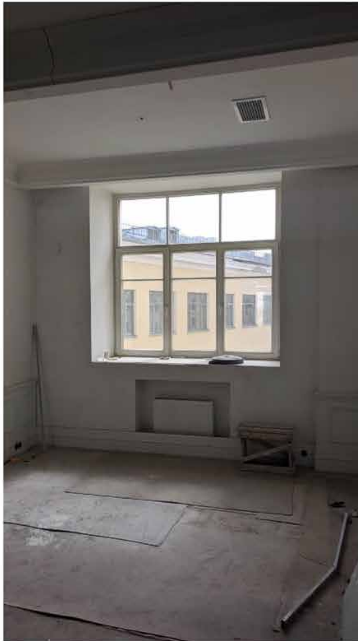
111. Вид в интерьере зоны «РВИО» в уровне 5-го этажа северного корпуса.
