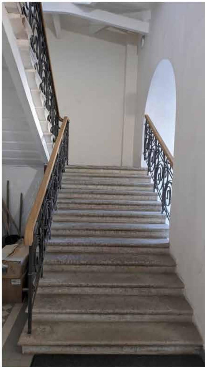
28. Вид на лестничную клетку зоны «СЗД» в уровне 1-го этажа южного корпуса.
