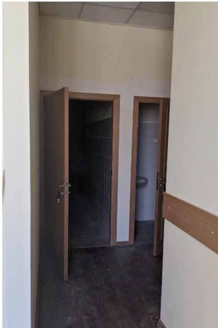
191. Вид в интерьере коридора зоны «Консерватория» в уровне 4-го этажа западного корпуса.
