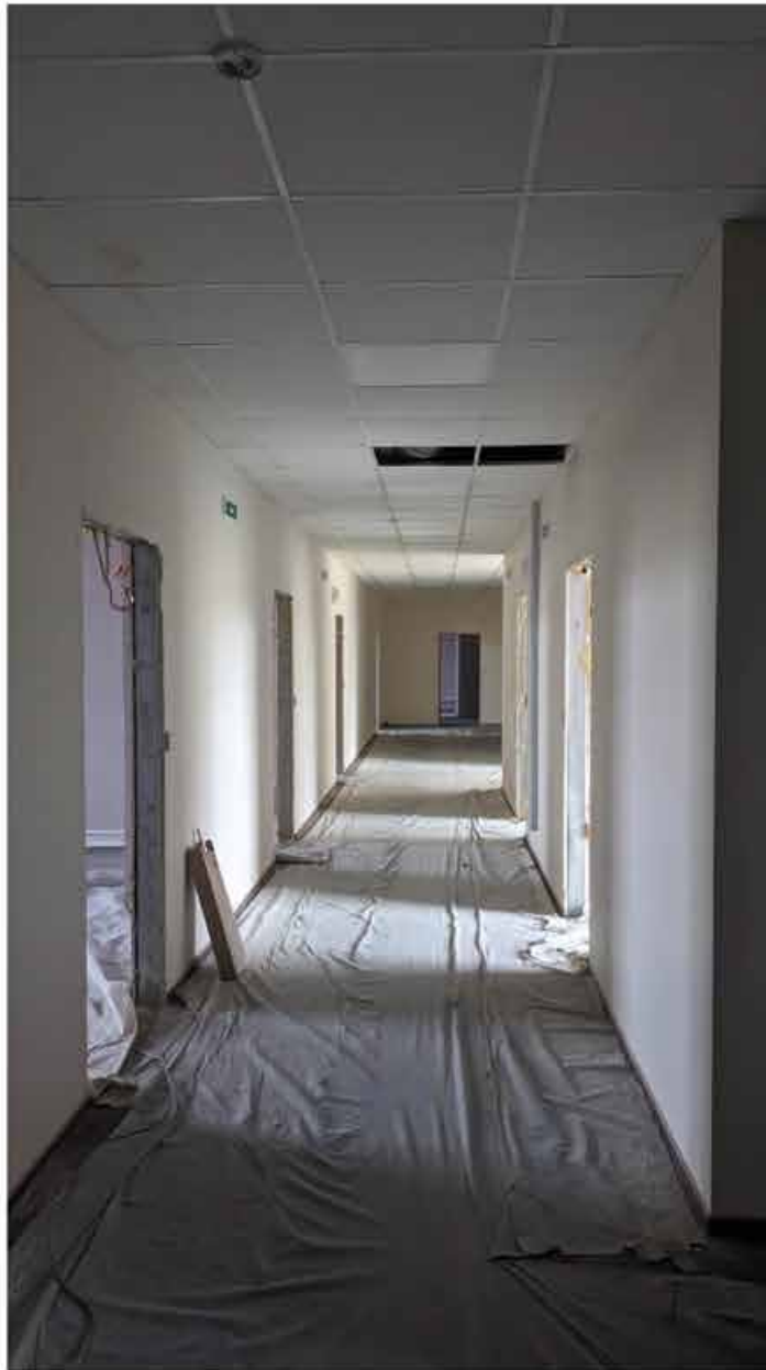
90. Вид в коридор зоны «РВИО» в уровне 4-го этажа северного корпуса.
