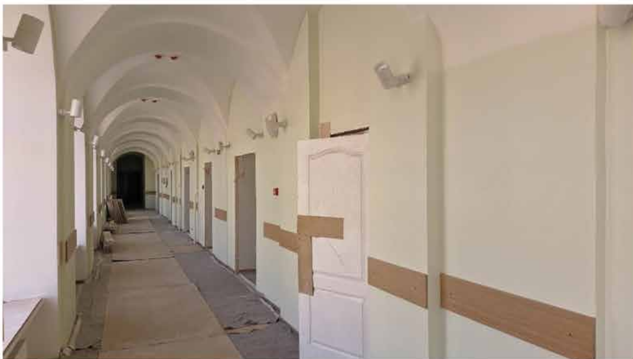
172. Вид в интерьере коридора зоны «Консерватория» в уровне 3-го этажа западного корпуса.
