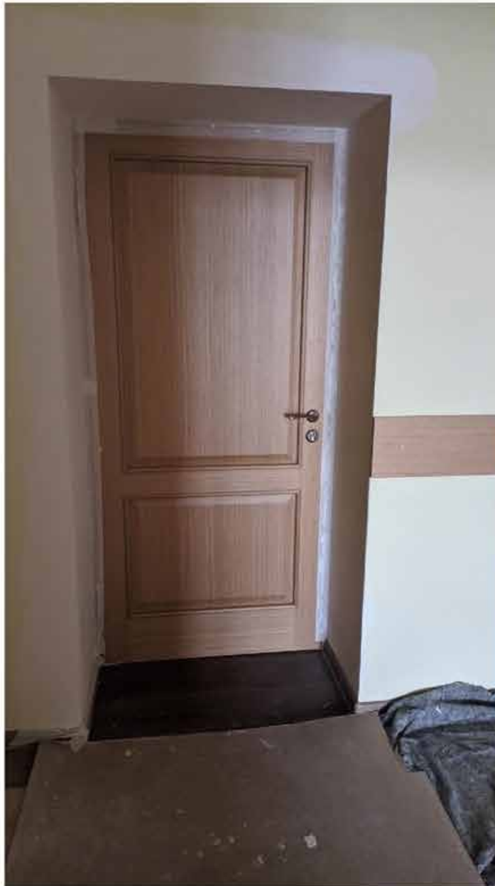
295. Вид в интерьере коридора зоны «Консерватория» в уровне 5-го этажа западного корпуса.
