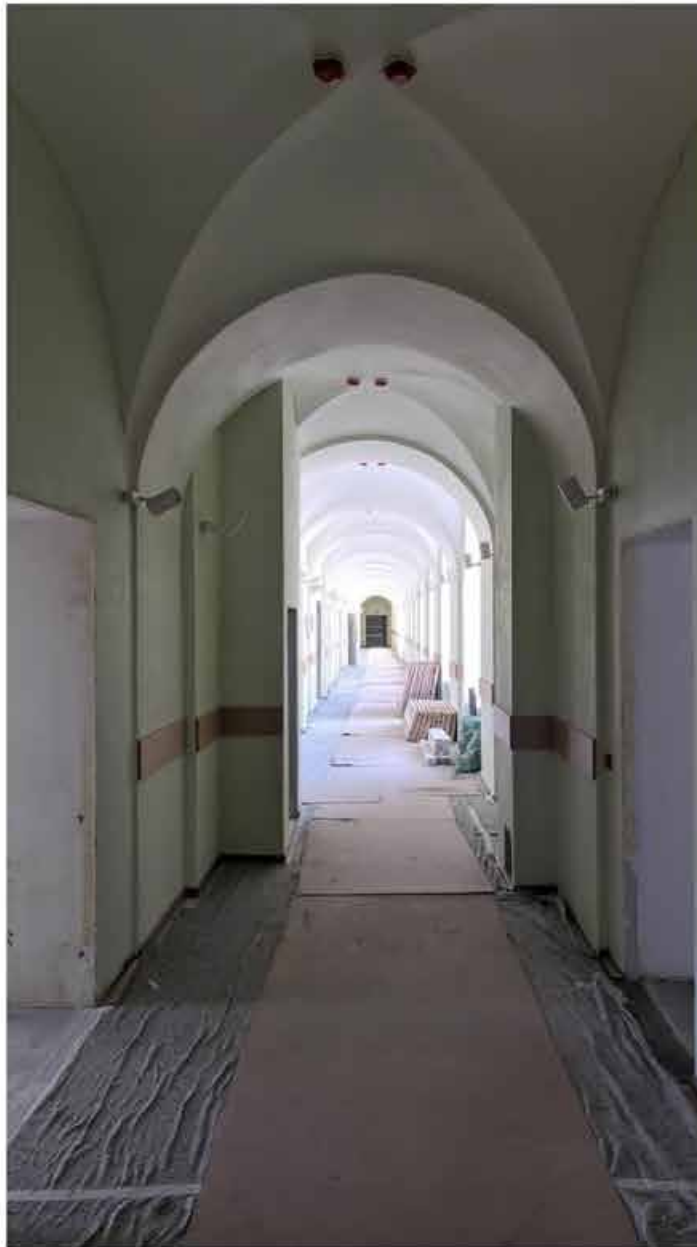
160. Вид в интерьере коридора зоны «Консерватория» в уровне 3-го этажа западного корпуса.
