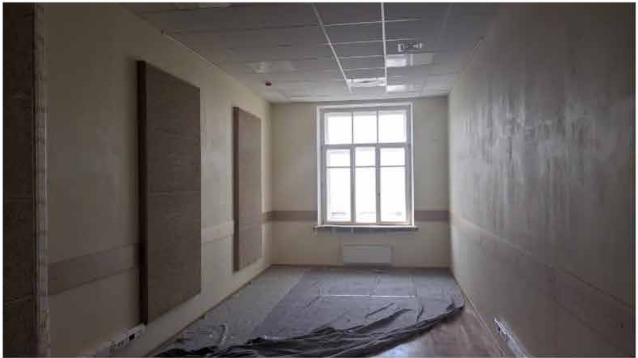
199. Вид в интерьере зоны «Консерватория» в уровне 4-го этажа западного корпуса.
