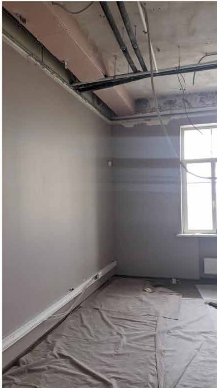
93. Вид в интерьере зоны «РВИО» в уровне 4-го этажа северного корпуса.
