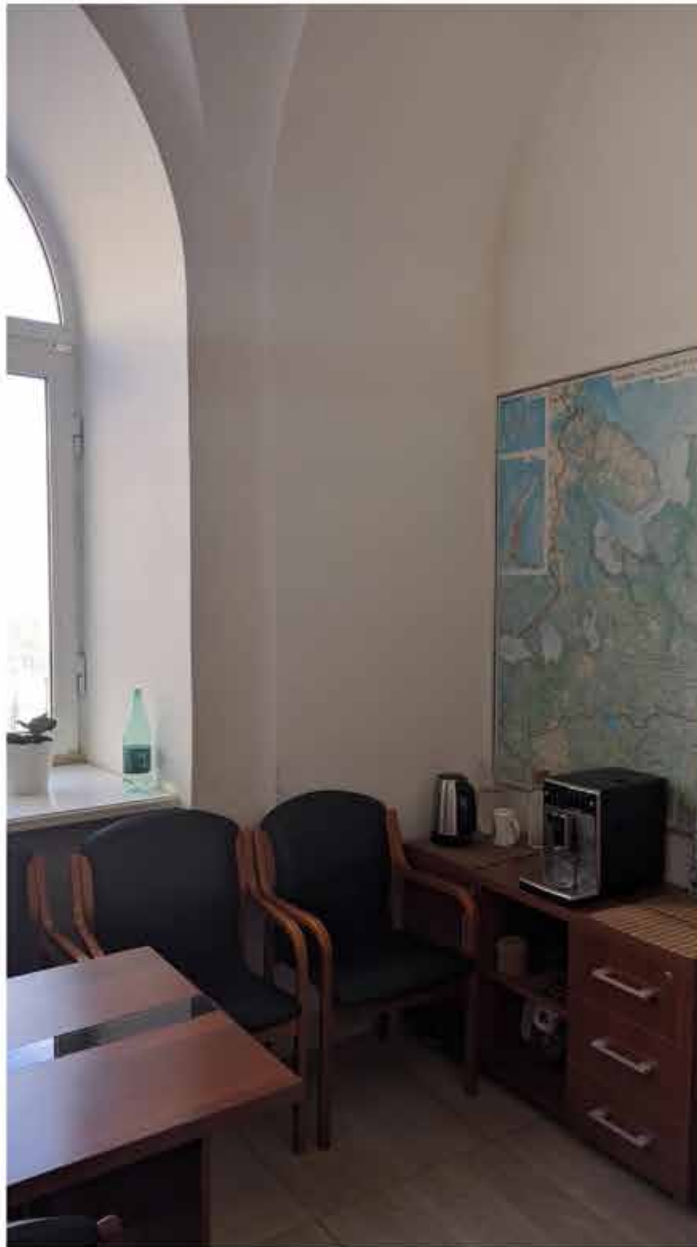
54. Вид в интерьере зоны «СЗД» в уровне 2-го этажа южного корпуса.
