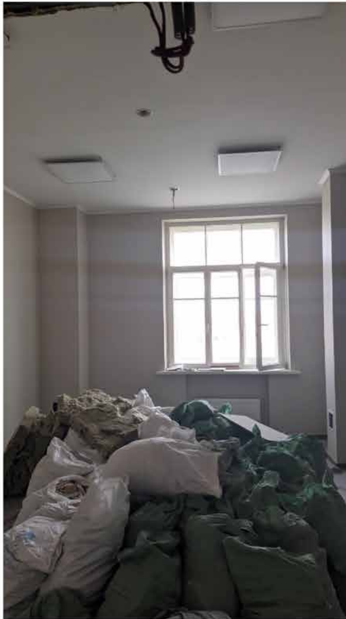
92. Вид в интерьере зоны «РВИО» в уровне 4-го этажа северного корпуса.
