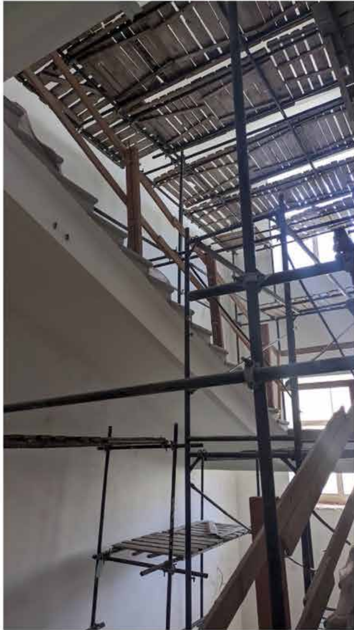
185. Вид на лестничную клетку зоны «Консерватория» в уровне 4-го этажа западного корпуса.
