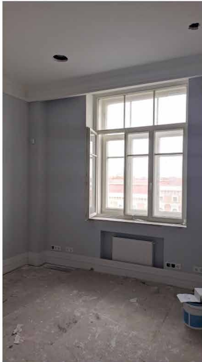
115. Вид в интерьере зоны «РВИО» в уровне 5-го этажа северного корпуса.
