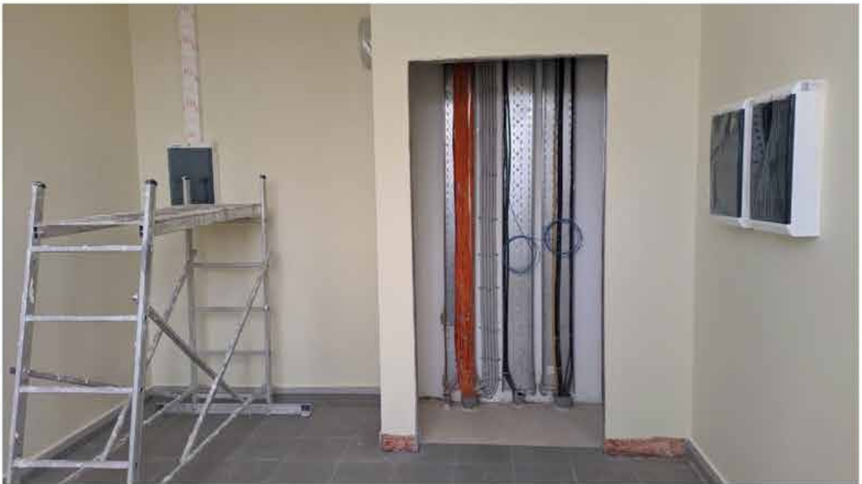
257. Вид в интерьере балкона репетиционного зала зоны «Консерватория» в уровне 5-го этажа южного корпуса.
