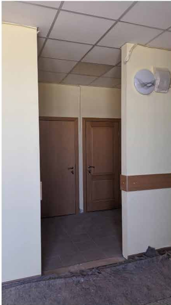
308. Вид в интерьере коридора зоны «Консерватория» в уровне 5-го этажа западного корпуса.
