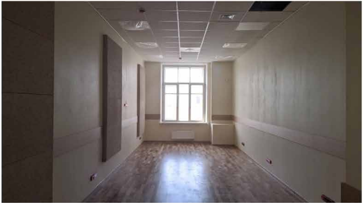
206. Вид в интерьере зоны «Консерватория» в уровне 4-го этажа западного корпуса.
