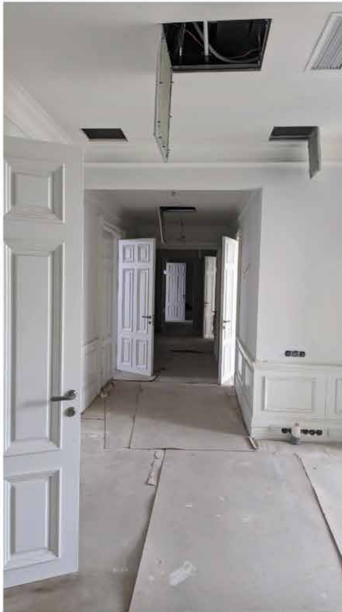
110. Вид в интерьере зоны «РВИО» в уровне 5-го этажа северного корпуса.
