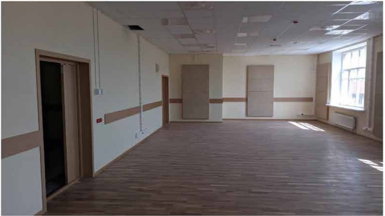
275. Вид в интерьере зоны «Консерватория» в уровне 5-го этажа южного корпуса.
