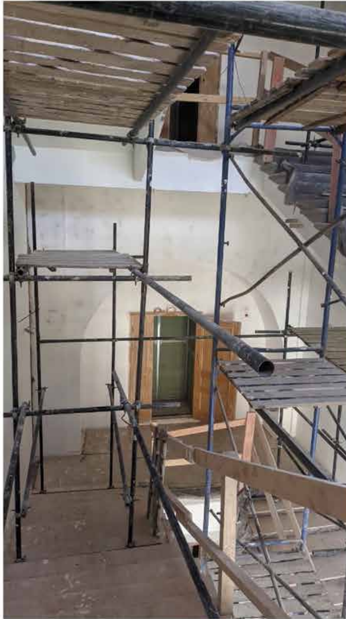
181. Вид на лестничную клетку зоны «Консерватория» в уровне 3-го этажа западного корпуса.
