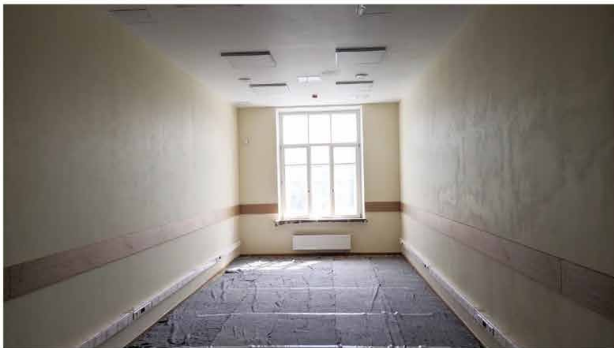
223. Вид в интерьере зоны «Консерватория» в уровне 4-го этажа южного корпуса.
