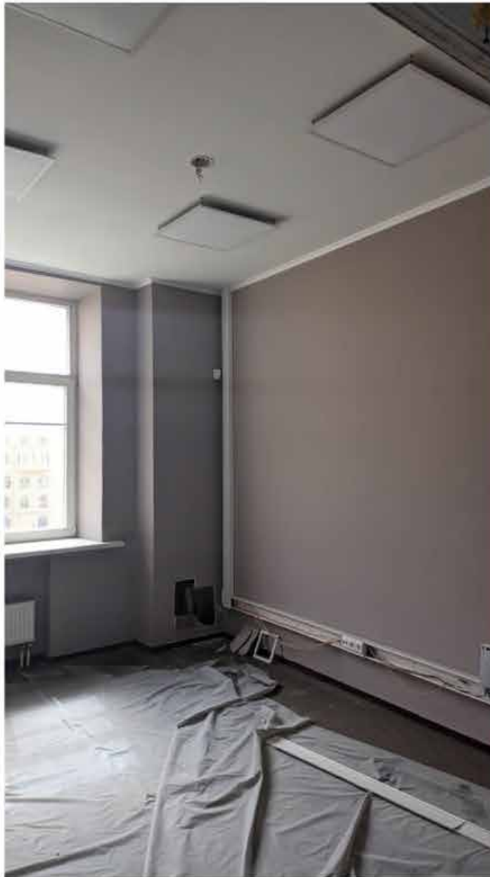
94. Вид в интерьере зоны «РВИО» в уровне 4-го этажа северного корпуса.
