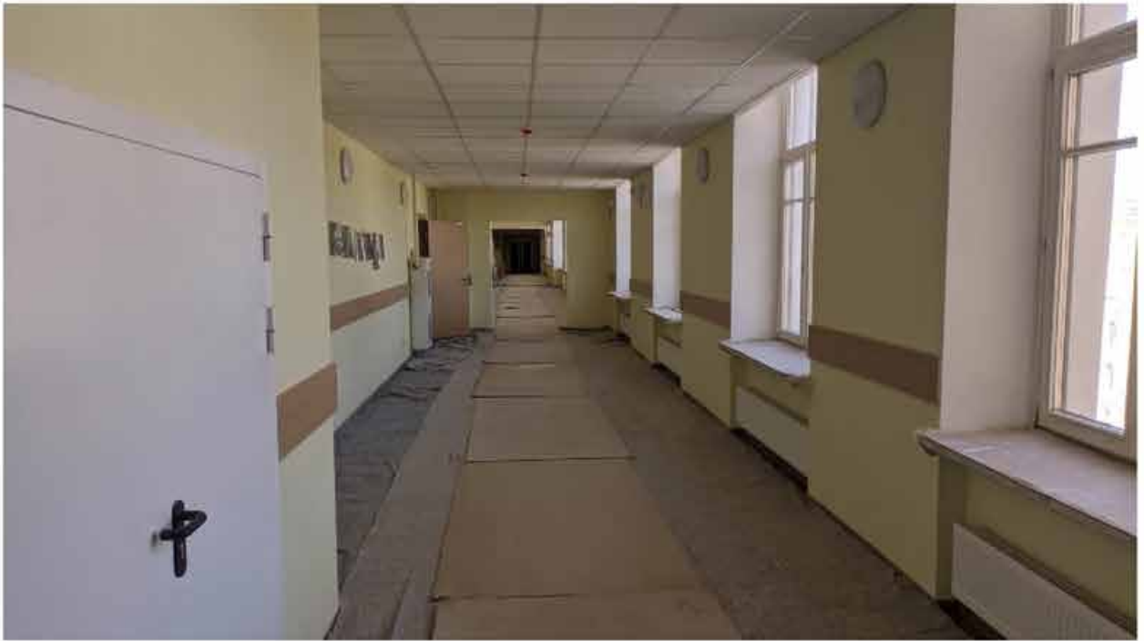
296. Вид в интерьере коридора зоны «Консерватория» в уровне 5-го этажа западного корпуса.
