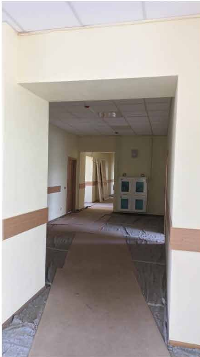
242. Вид в интерьере коридора зоны «Консерватория» в уровне 4-го этажа южного корпуса.
