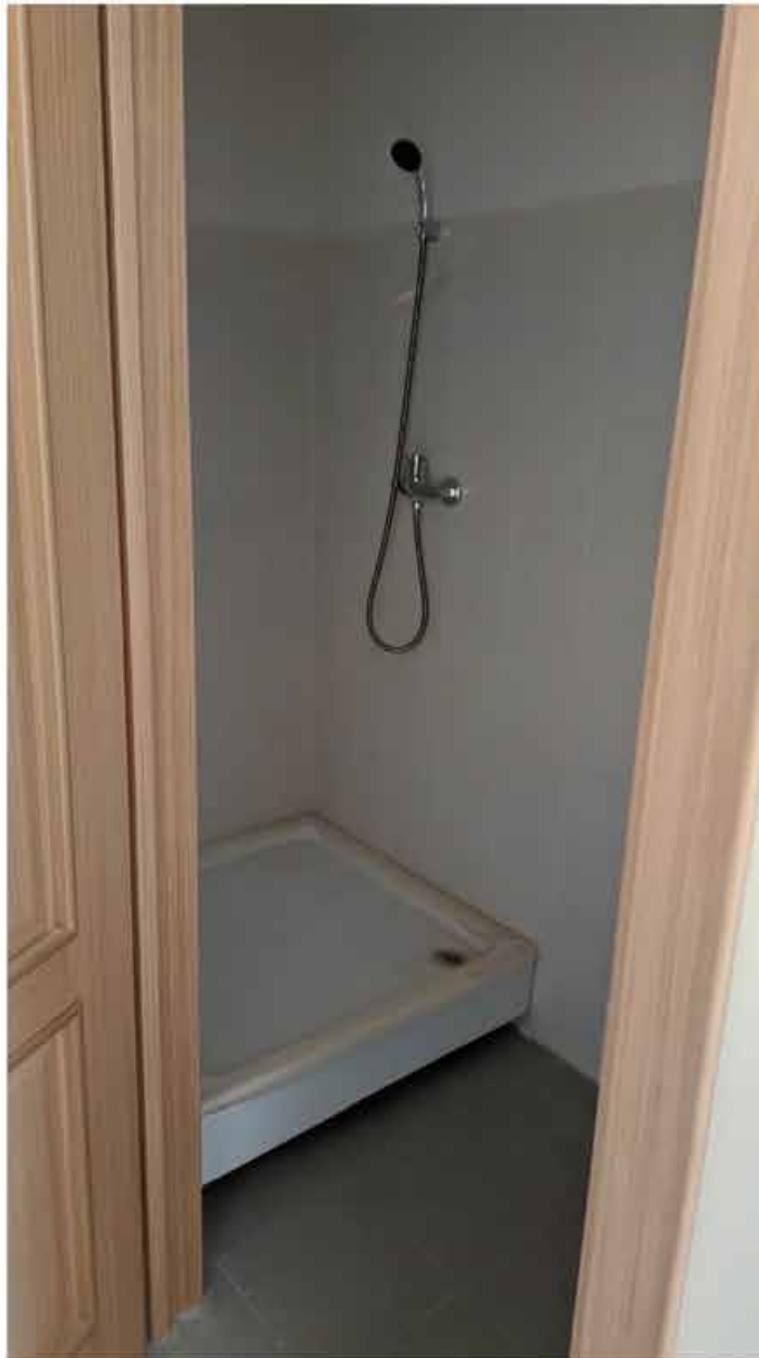
312. Вид в интерьере душевой зоны «Консерватория» в уровне 5-го этажа западного корпуса.
