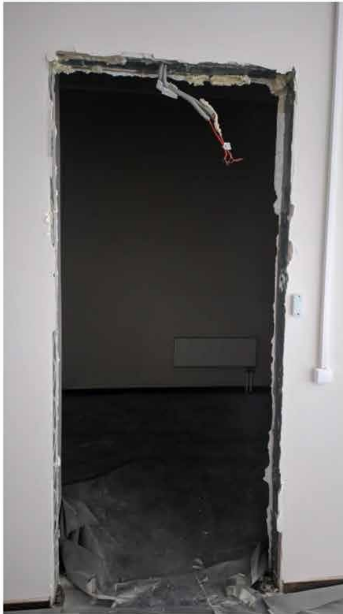
99. Вид в интерьере зоны «РВИО» в уровне 4-го этажа северного корпуса.
