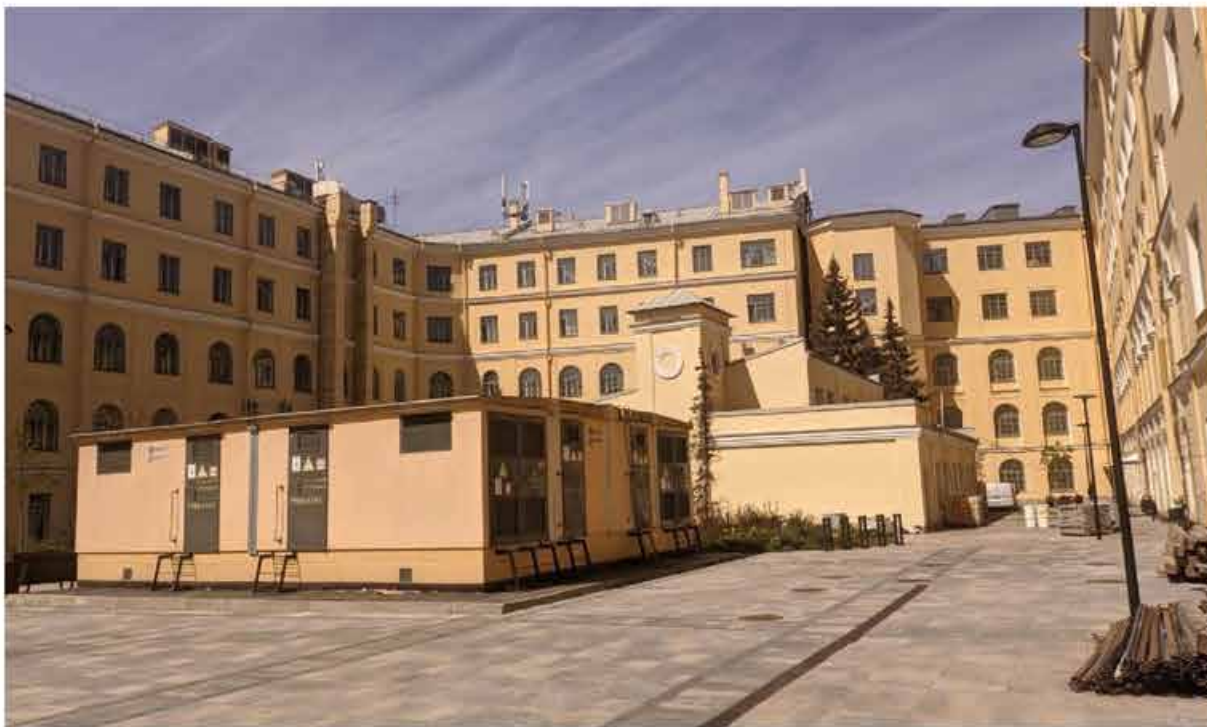
15. Вид на западный и северный корпус со стороны внутреннего двора (дополнительная фотофиксация от 26.04.2022г.).
