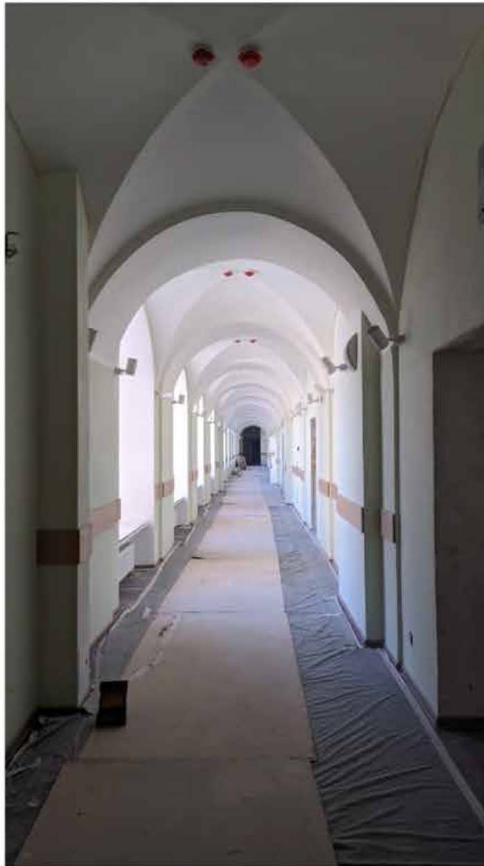
180. Вид в интерьере коридора зоны «Консерватория» в уровне 3-го этажа западного корпуса.
