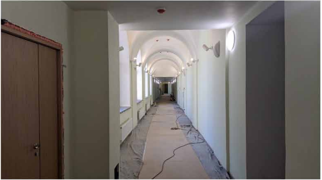
144. Вид в коридор зоны «Консерватория» в уровне 2-го этажа западного корпуса.
