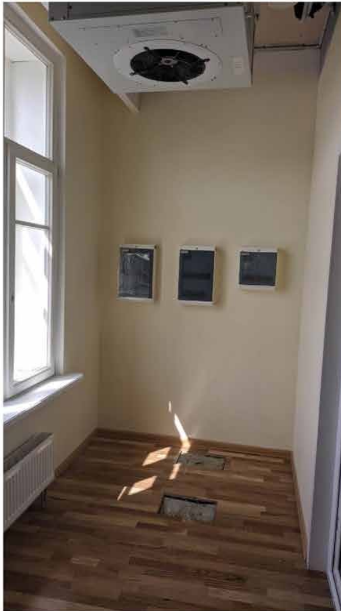
301. Вид в интерьере студии звукозаписи зоны «Консерватория» в уровне 5-го этажа западного корпуса.
