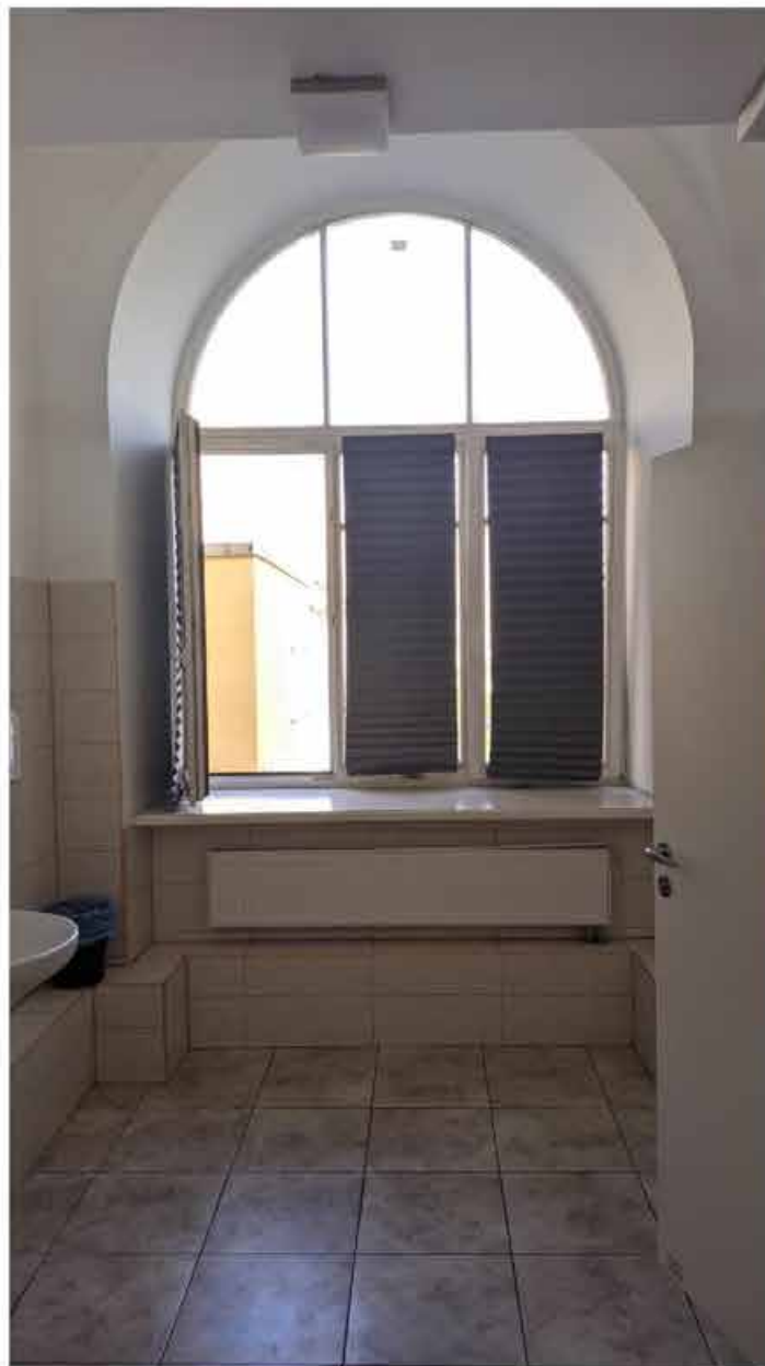
55. Вид в интерьере санузла зоны «СЗД» в уровне 2-го этажа южного корпуса.
