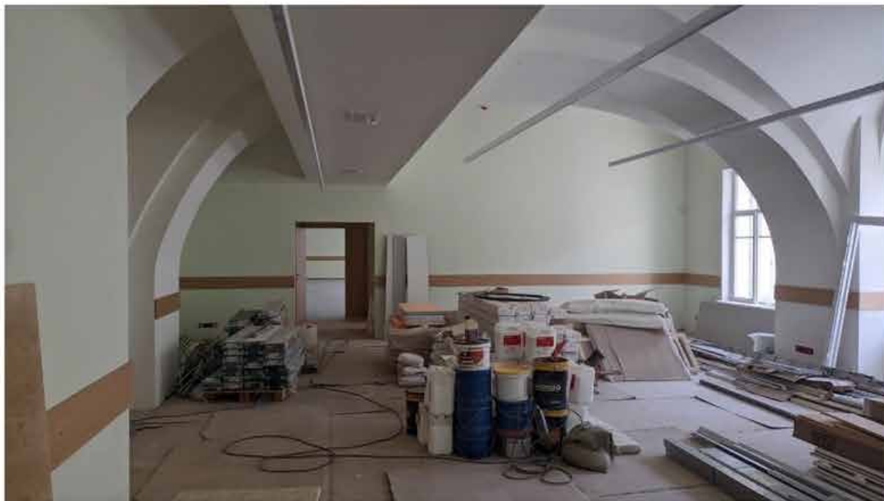
149. Вид в интерьере зоны «Консерватория» в уровне 2-го этажа западного корпуса.
