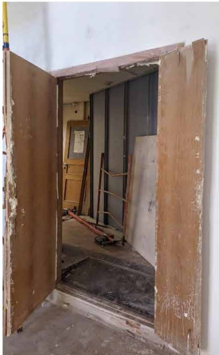
142. Вид с лестничной клетки в коридор зоны «Консерватория» в уровне 2-го этажа западного корпуса.
