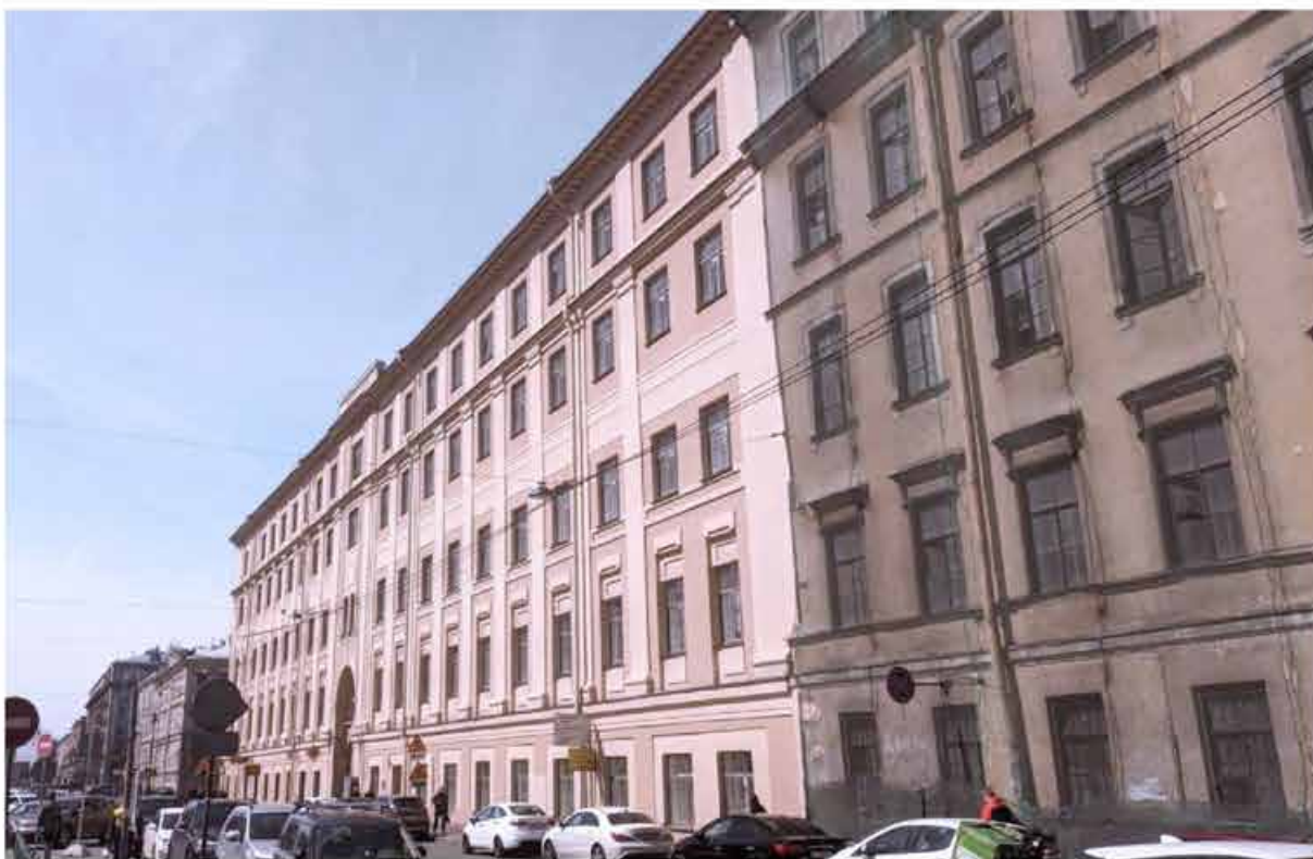
9. Вид на лицевой фасад южного корпуса со стороны улицы Декабристов.
