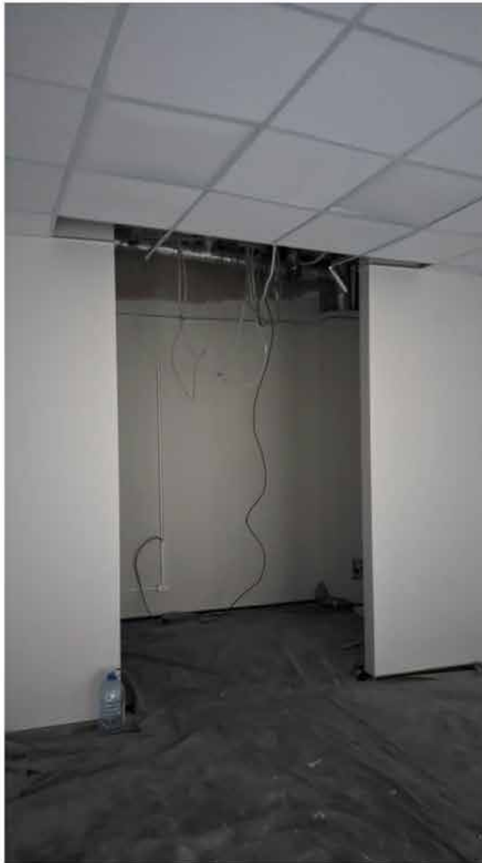
89. Вид в коридор зоны «РВИО» в уровне 4-го этажа северного корпуса.
