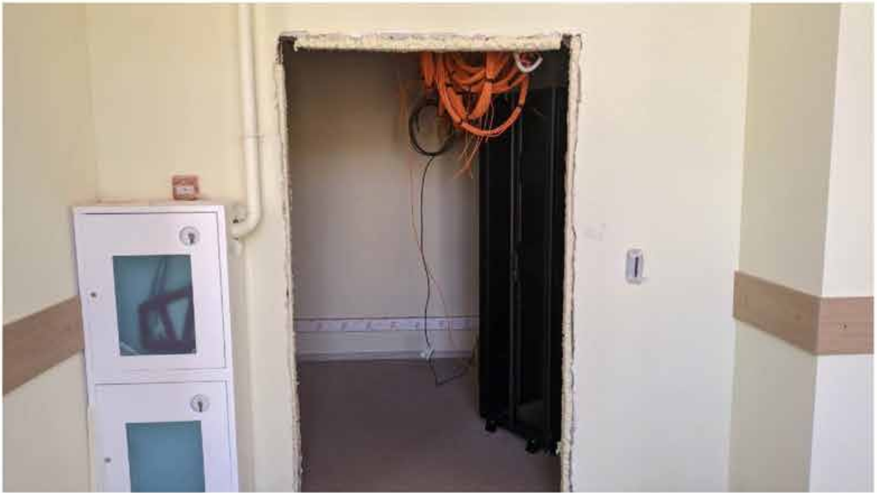
226. Вид в интерьере зоны «Консерватория» в уровне 4-го этажа южного корпуса.
