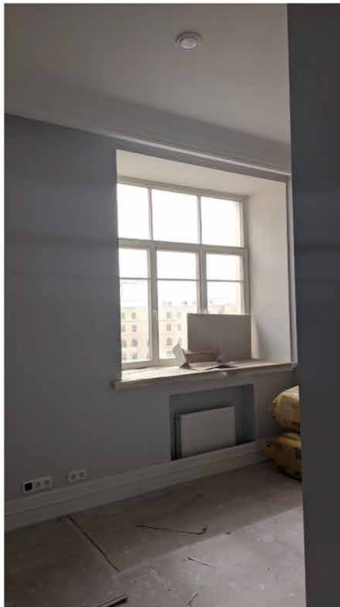
120. Вид в интерьере зоны «РВИО» в уровне 5-го этажа северного корпуса.
