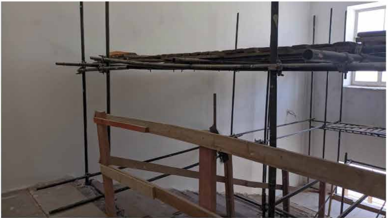
317. Вид в интерьере лестничной клетки зоны «Консерватория» в уровне 5-го этажа западного корпуса.
