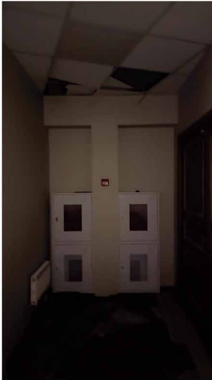
108. Вид в интерьере зоны «РВИО» в уровне 4-го этажа северного корпуса.
