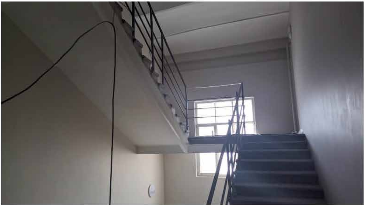
258.2. Вид в интерьере лестничной клетки зоны «Консерватория» в уровне 5-го этажа западного корпуса.
