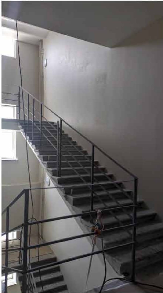
219. Вид в интерьере лестничной клетки зоны «Консерватория» в уровне 4-го этажа западного корпуса.
