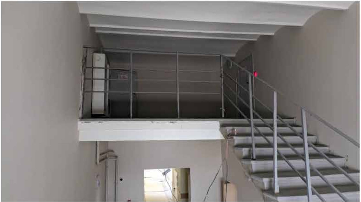
259.1. Вид в интерьере лестничной клетки зоны «Консерватория» в уровне 5-го этажа западного корпуса.
