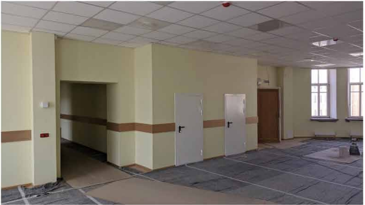
238. Вид в интерьере зоны «Консерватория» в уровне 4-го этажа южного корпуса.
