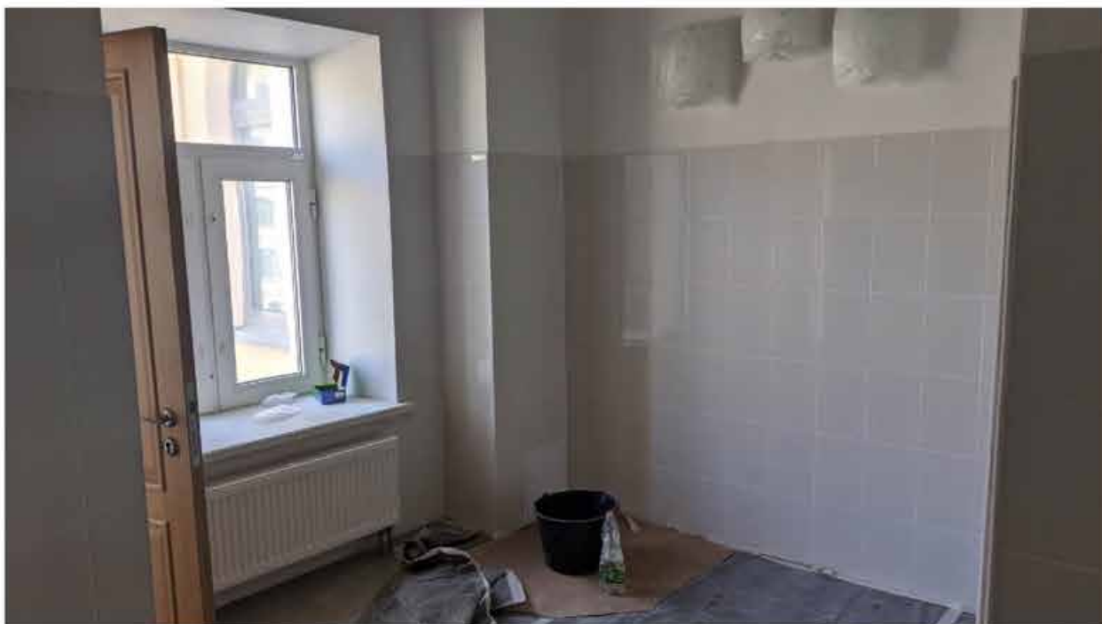
162. Вид в интерьере санузла коридора зоны «Консерватория» в уровне 3-го этажа западного корпуса.
