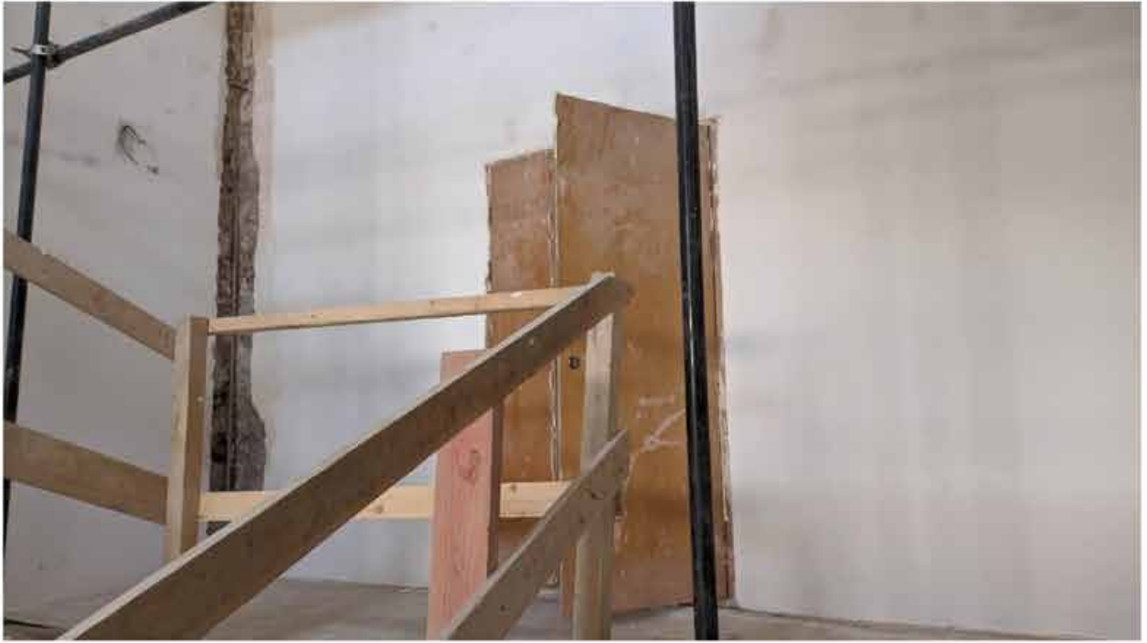
183. Вид на лестничную клетку зоны «Консерватория» в уровне 4-го этажа западного корпуса.
