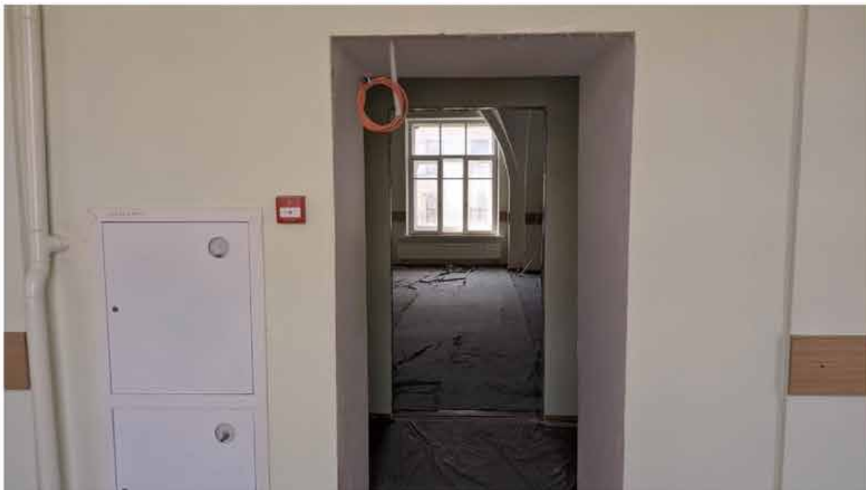
167. Вид в интерьере зоны «Консерватория» в уровне 3-го этажа западного корпуса.
