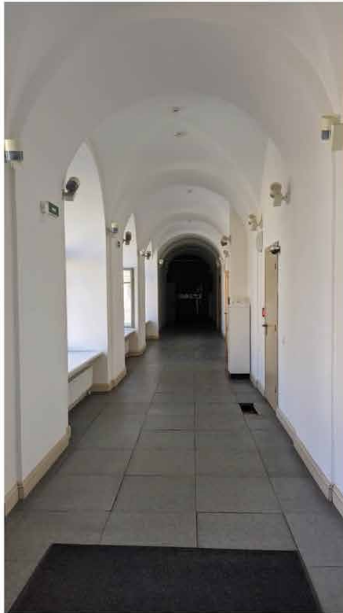
61. Вид в интерьере коридора зоны «СЗД» в уровне 3-го этажа южного корпуса.
