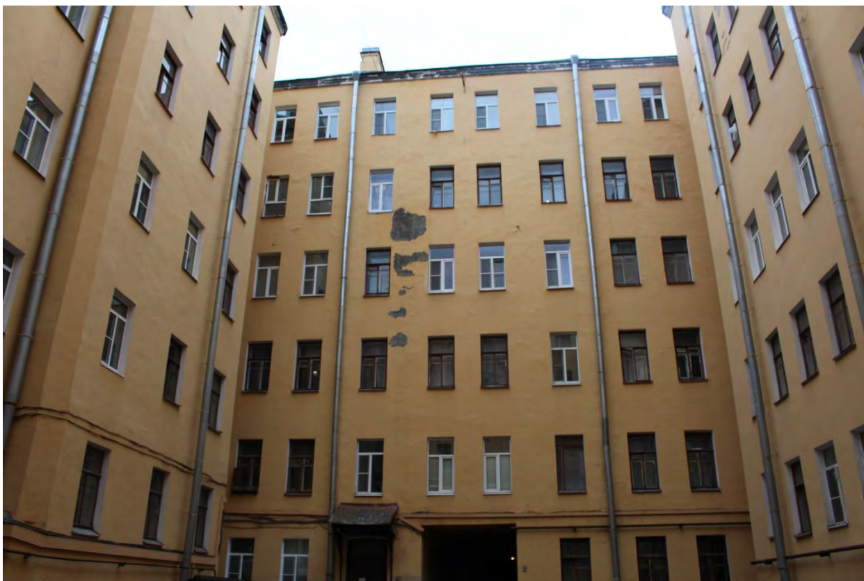
Фото 26. Вид на северо-восточный фасад западного дворового корпуса выявленного объекта культурного наследия «Дом И.Д. Коробкова».
