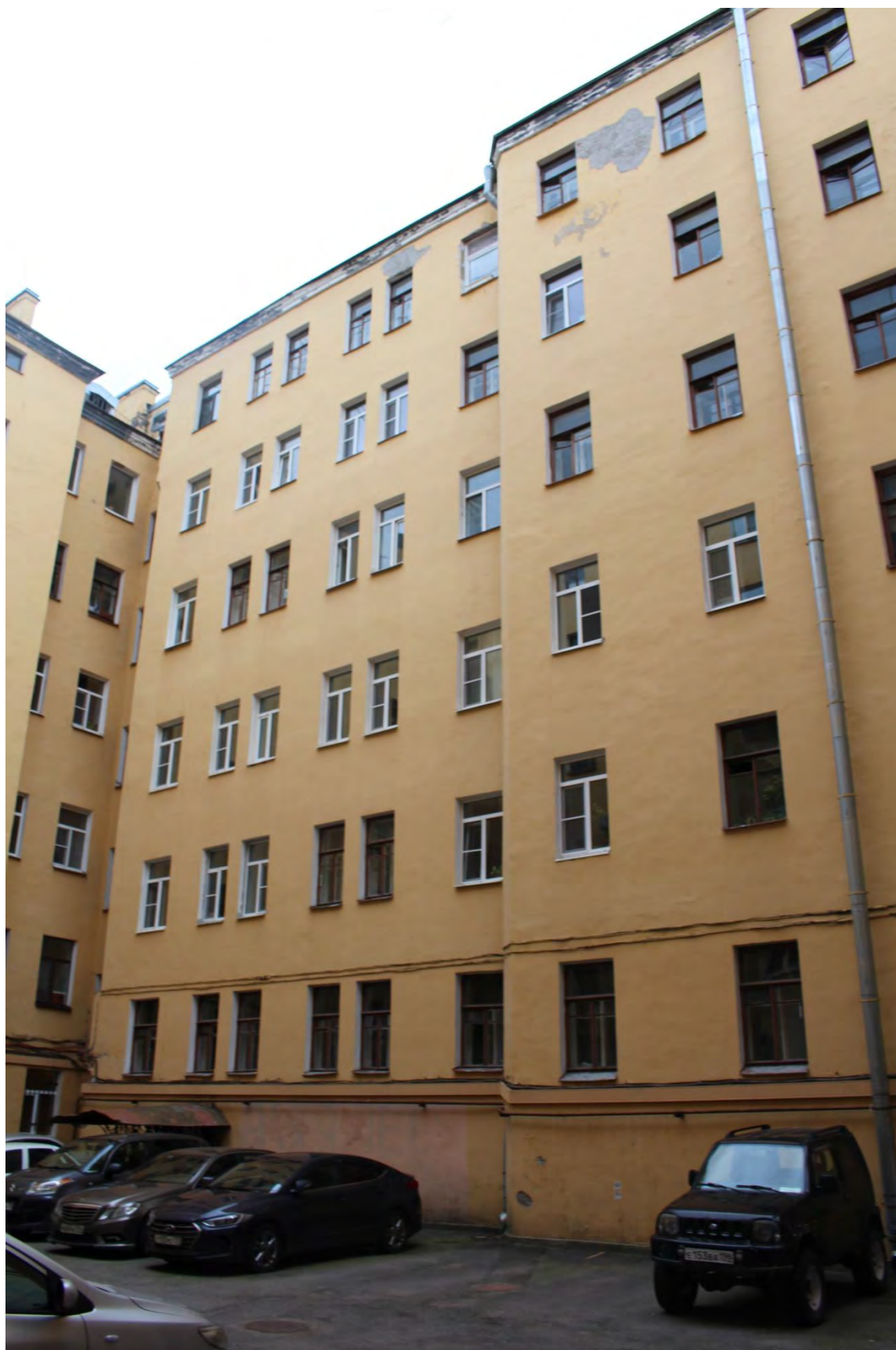
Фото 25. Вид на фасад южного дворового корпуса выявленного объекта культурного наследия «Дом И.Д. Коробкова».
