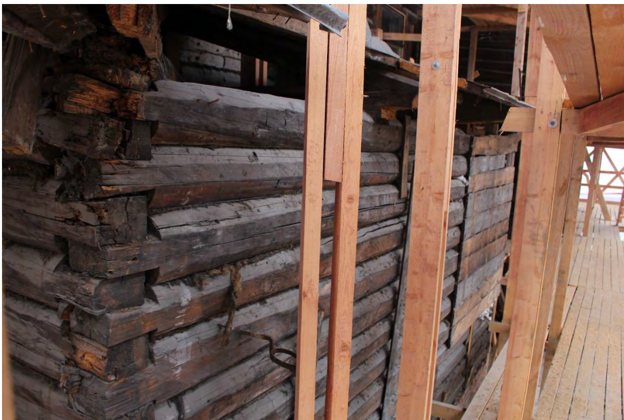
Фото 11. Вид на юго-восточный фасад объекта культурного наследия регионального значения «Особняк Э.Э. Бремме».
