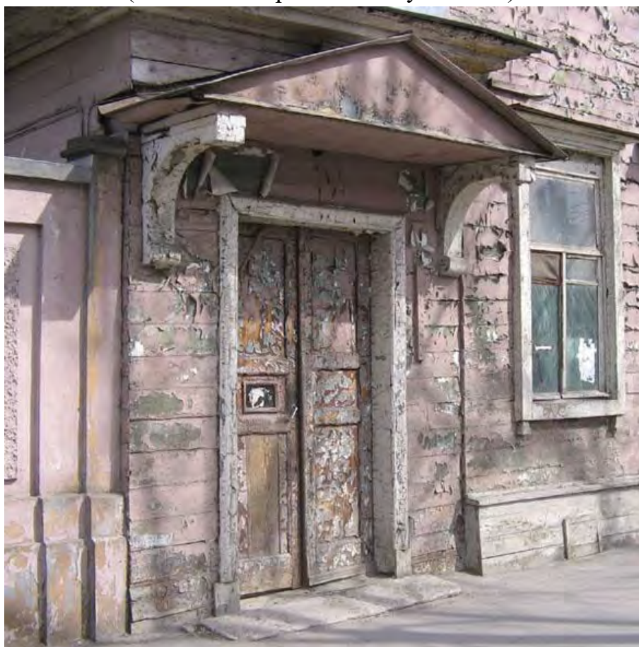
Илл. 92. Главный вход в здание с 12 линии Васильевского острова. Фотография. 2010 г. (источник: https://www.citywalls.ru/ ).
