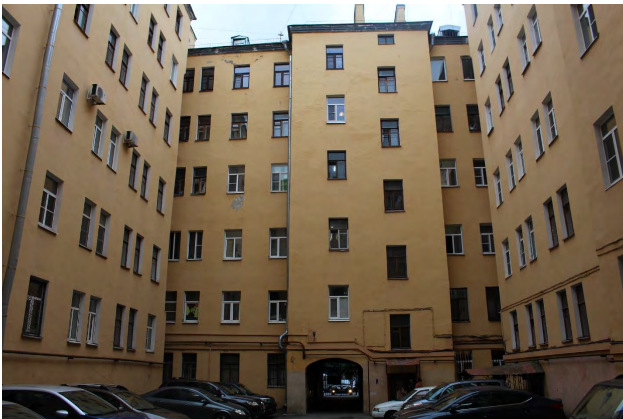
Фото 23. Вид на юго-западный (дворовый) фасад выявленного объекта культурного наследия «Дом И.Д. Коробкова».
