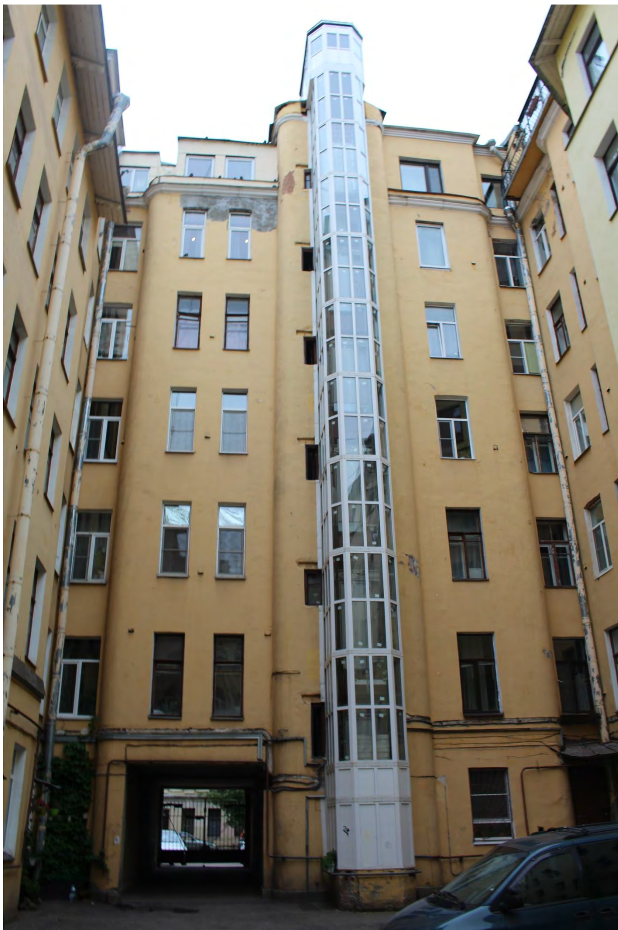
Фото 35. Вид на юго-западный (дворовый) фасад выявленного объекта культурного наследия «Дом И.Л. Львова».
