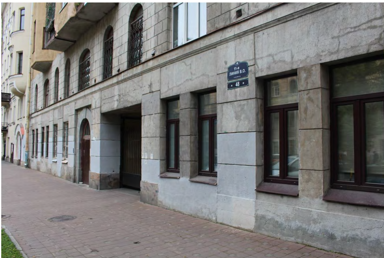
Фото 32. Вид на лицевой (северо-восточный) фасад выявленного объекта культурного наследия «Дом И.Л. Львова» в уровне 1-го этажа.
