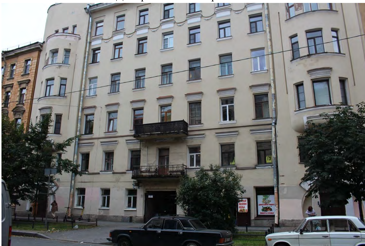
Фото 18. Вид на лицевой (северо-восточный) фасад выявленного объекта культурного наследия «Дом И.Д. Коробкова».
