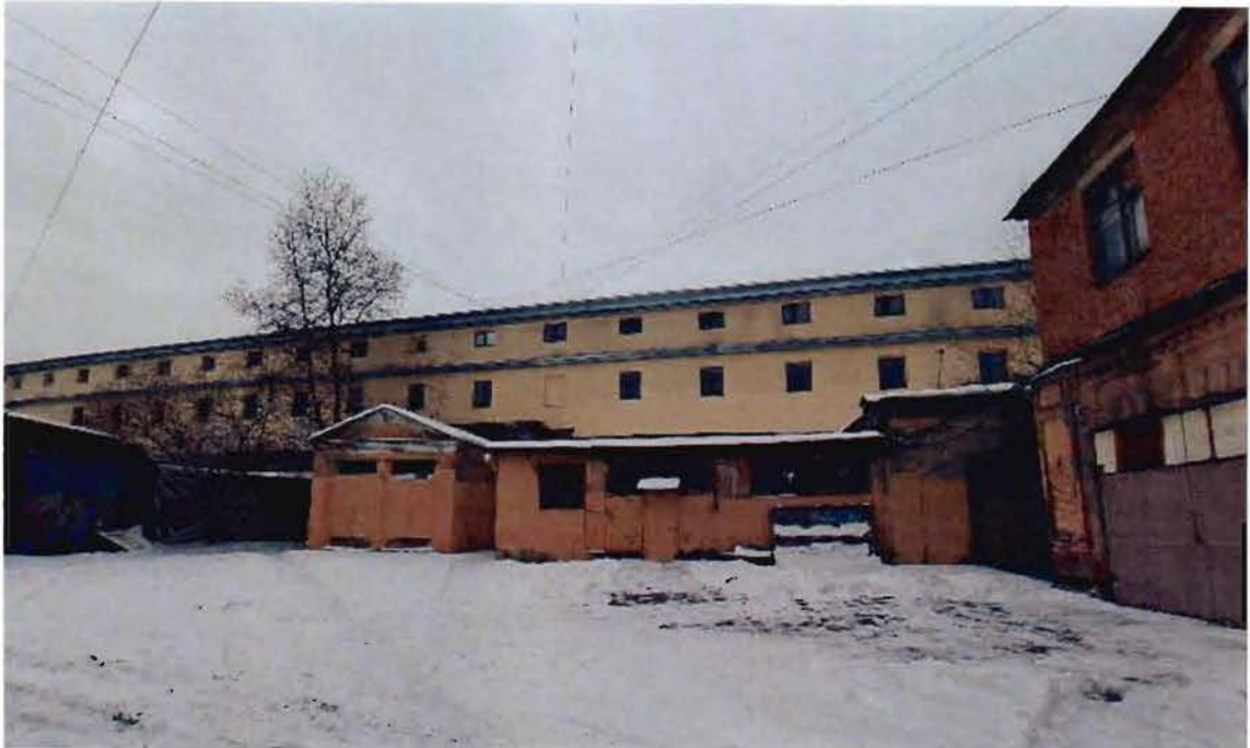
4. Вид на территорию объекта культурного наследия регионального значения «Конюшенный двор» и западный дворовой фасад объекта культурного наследия. Дата фотофиксации: 19.02.2021
