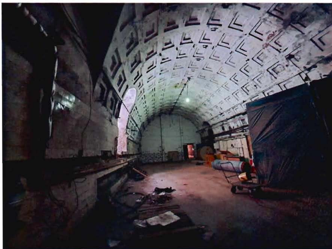
7. Интерьеры. 1 этаж. Дата фотофиксации: 19.02.2021
