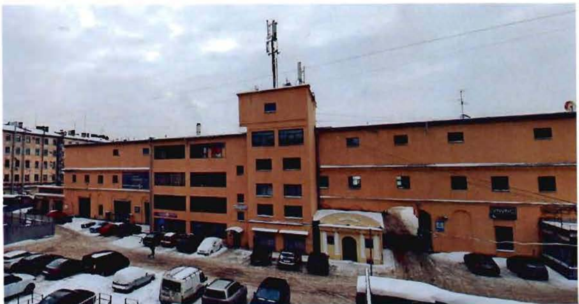
1. Вид на северный фасад объекта культурного наследия. Дата фотофиксации: 19.02.2021
