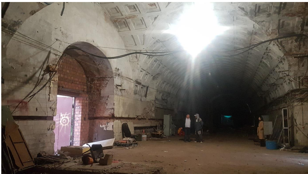
Фото 9. Арочный проем № 2. Помещение 2-Н.
