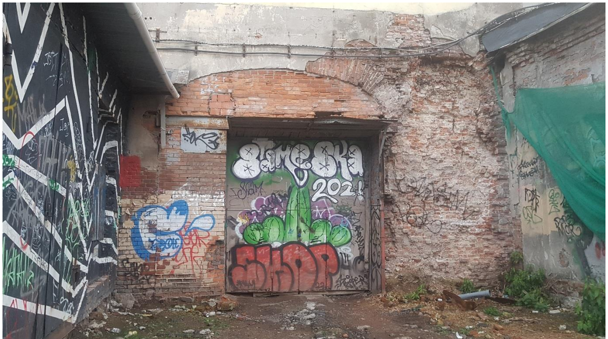
Фото 6. Арочный проем № 2. Вид со двора.
