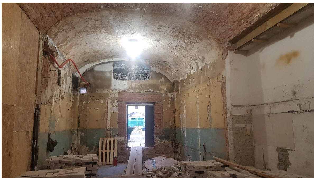
Фото 2. Арочный проем № 1. Помещение между арочными проемами.
