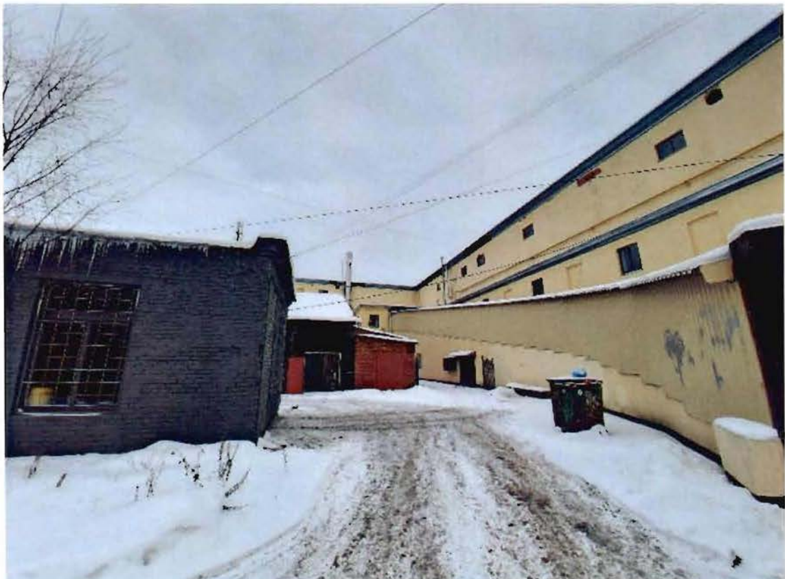
5. Фрагмент восточного дворового фасада объекта культурного наследия. Дата фотофиксации: 19.02.2021
