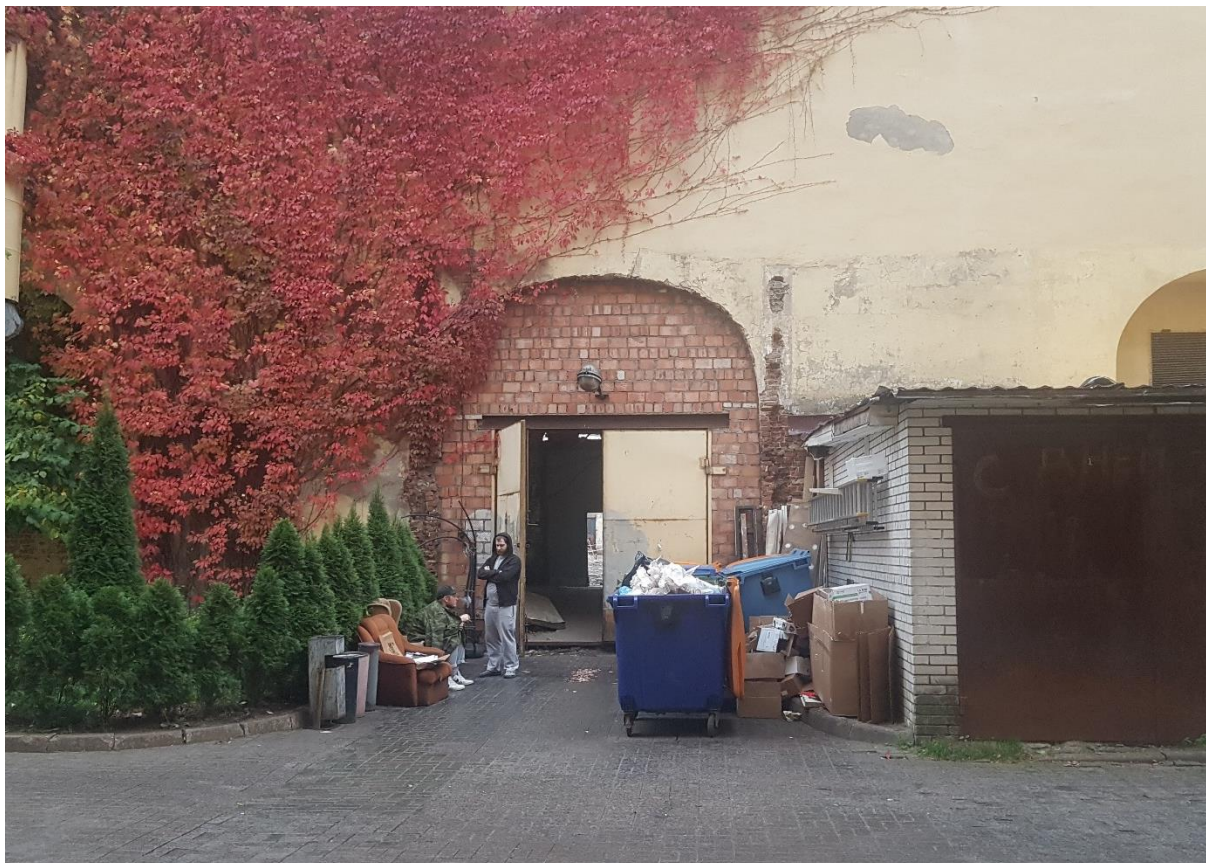
Фото 11. Арочный проем № 2. Вид со стороны Большой Конюшенной улицы.
