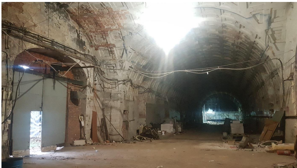
Фото 8. Арочный проем № 2. Помещение 2-Н.
