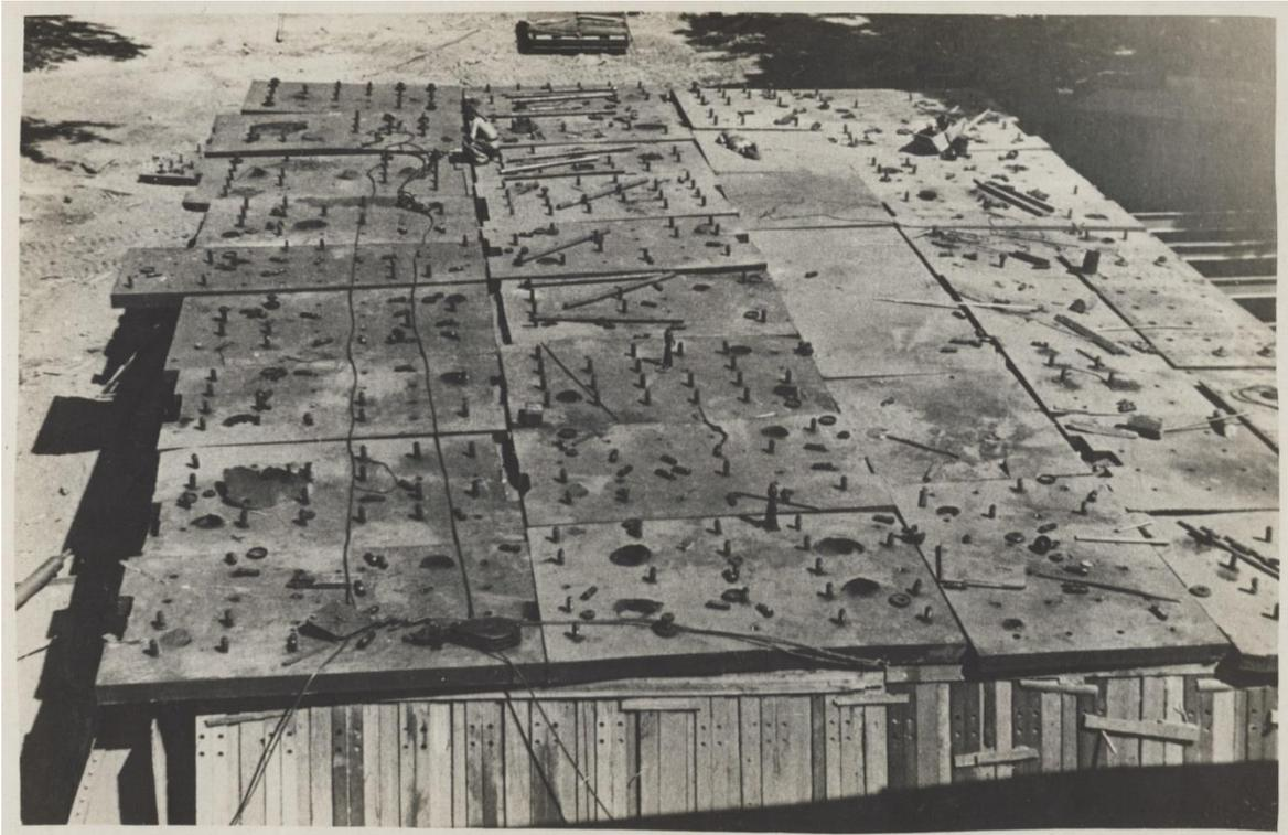
29. Общий вид верхнего покрытия из бронеплит. Часть гаек и шайб снята с гужонов перед стяжкой плит между собой от сдвигов. На заднем плане за КП – трейлер для перевозки бронеплит.
