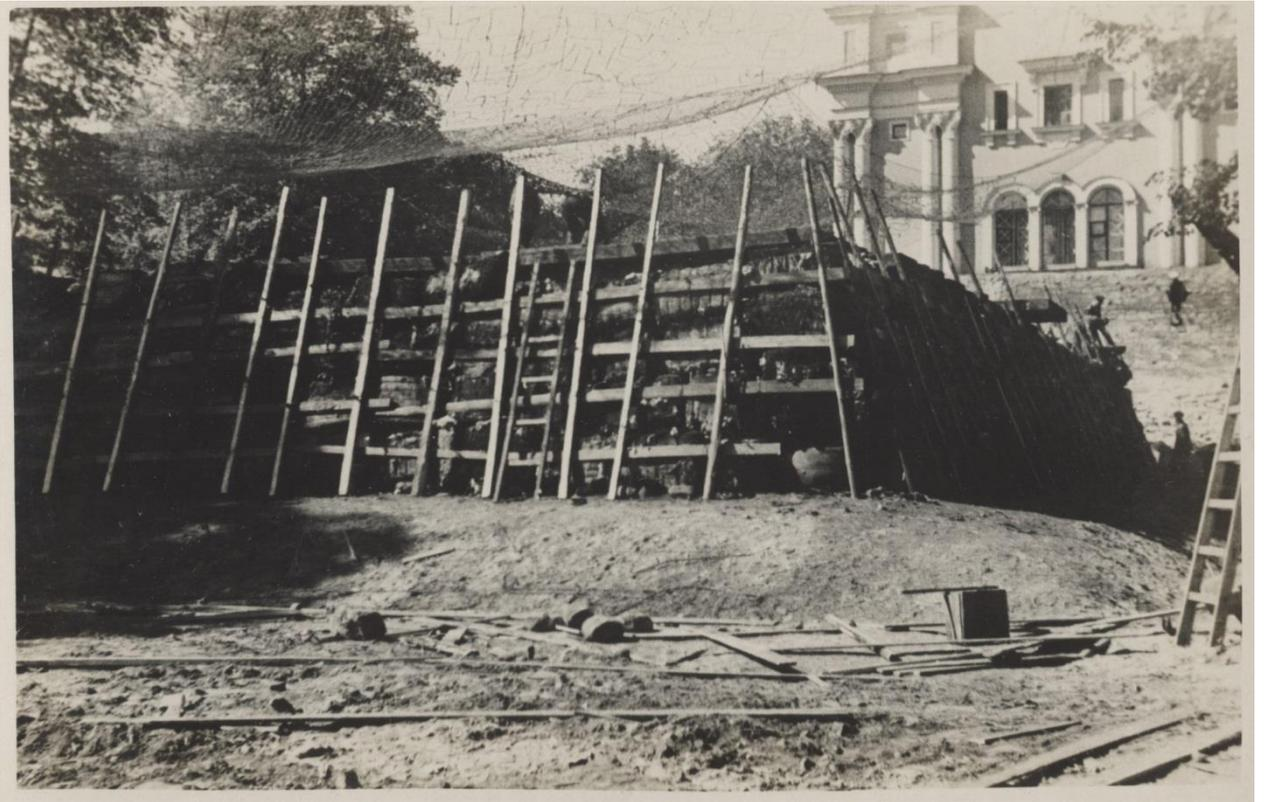
31. Общий вид сооружения КП ВС после устройства хлопкового тюфяка. На командном пункте установлена крыша.
