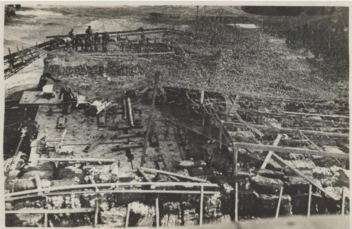
30. Момент подъёма краном бронеплиты на металлические катки. В качестве рельсового пути использовались двутавровые балки, уложенные на шпалы. После монтажа всей поверхности покрытия сооружения, они так и остались на своих местах. Плиту придерживают краснофлотцы. В левой части снимка полосы, которыми во избежание сдвигов броневые плиты скреплялись друг с другом. Идёт работа по укладке мешков с хлопком. Установлена часть деревянного каркаса крыши. Все работы ведутся под маскировочной сетью.
