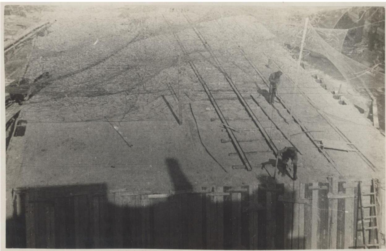
28. Укладка монтажных путей по перекрытию сооружения для перемещения бронеплит. Над местом проведения работ растянута маскировочная сеть. На переднем плане хорошо видны доски, при помощи которых заделаны промежутки между шпангоутами срубов. Это сделано для того, чтобы тюки с хлопком, которыми обкладывалось сооружение, не проваливались внутрь.
