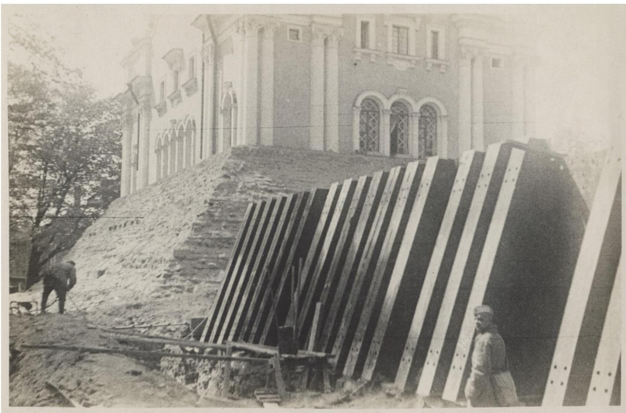
33. Земляные работы по устройству потерны между ФКП и КП ВС. На снимке срубы, установленные перед входом в сооружение и образующие сквозник. На заднем плане обваловка первого этажа командного пункта Военного совета.
