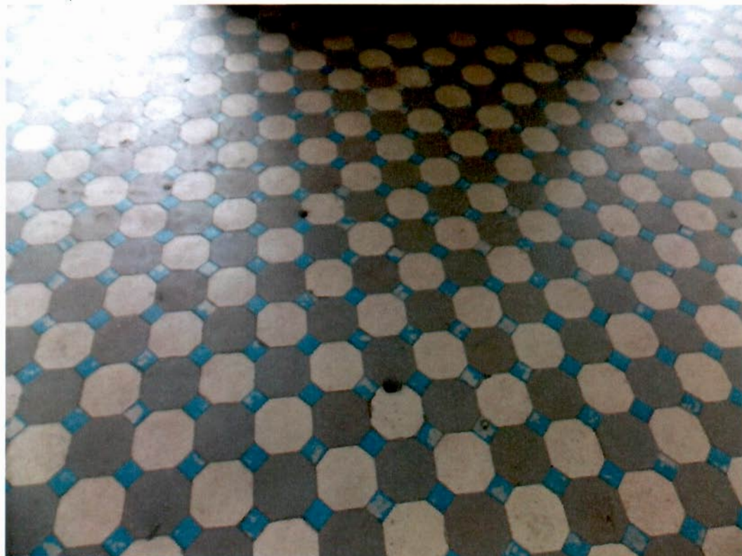
15. Пол парадного зала ж.д. станции Ланская
