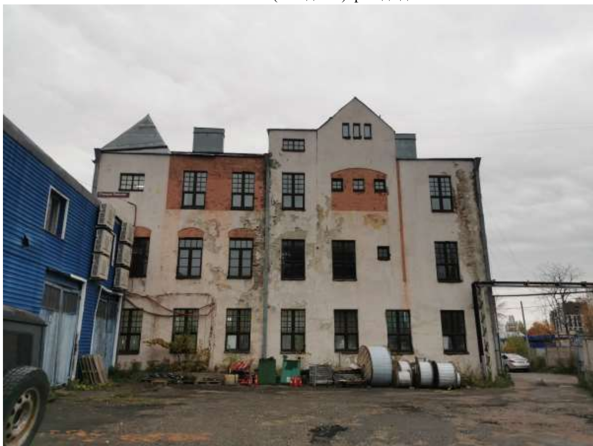
Фото 6. Дворовой (северный) фасад здания.
