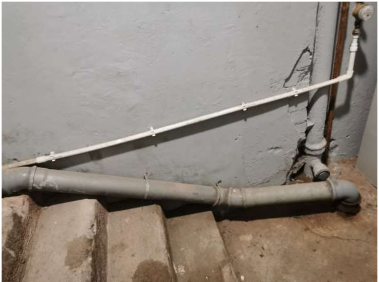
Фото 35-36. Подсобное помещение на втором этаже.
