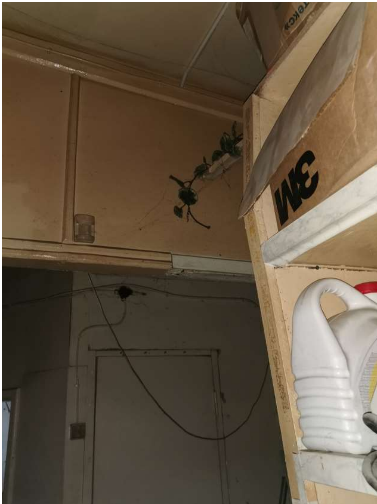
Фото 29. Помещение первого этажа в тоннеле под насыпью.
