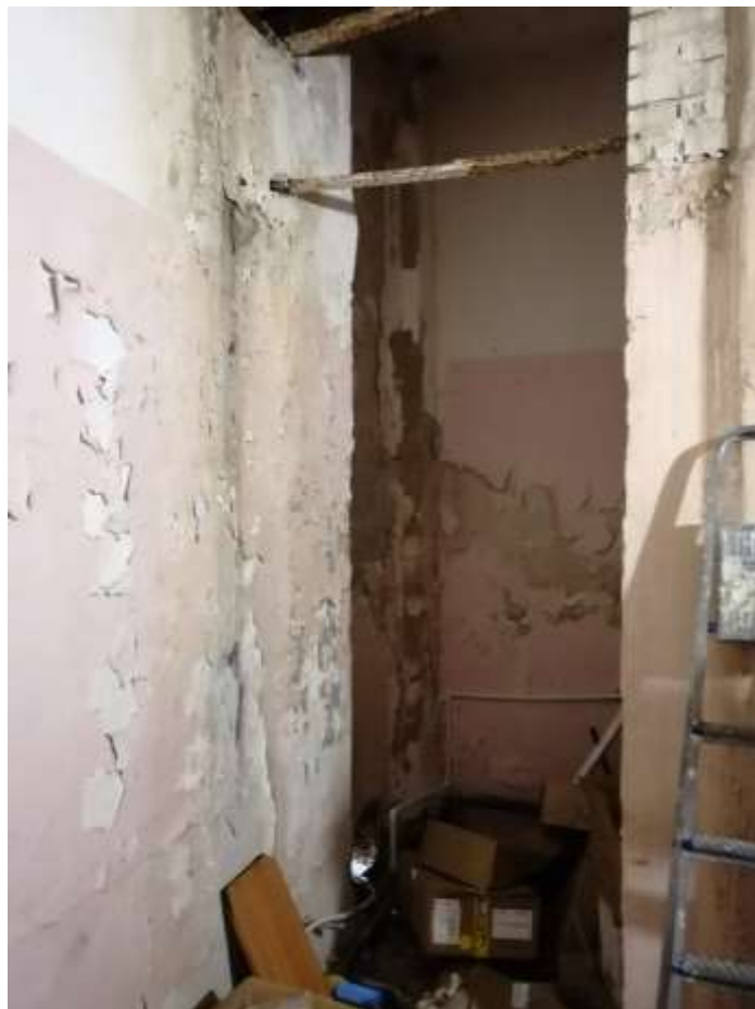
Фото 15. Техническое помещение в восточной части первого этажа.
