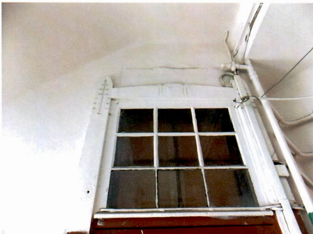
22. Оконный проем (исторически филенки) над входом в жилую квартиру.
