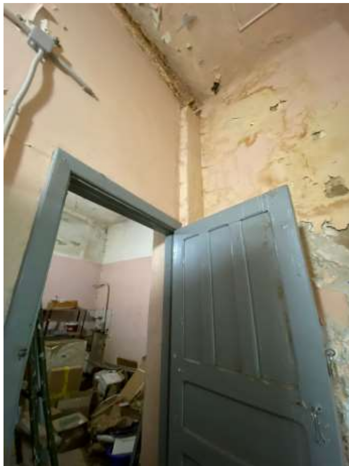
Фото 13. Техническое помещение в восточной части первого этажа.
