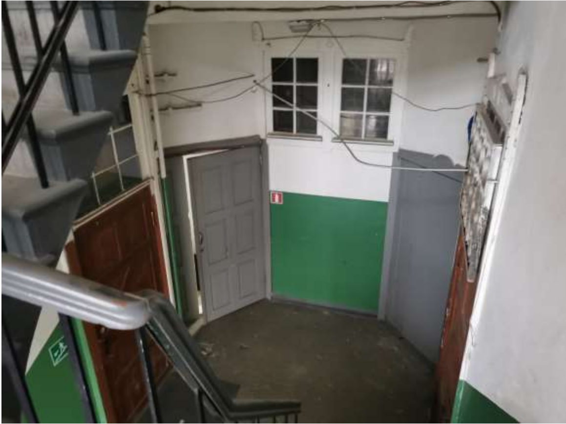
Фото 44. Вид на лестничную площадку на третьем этаже
