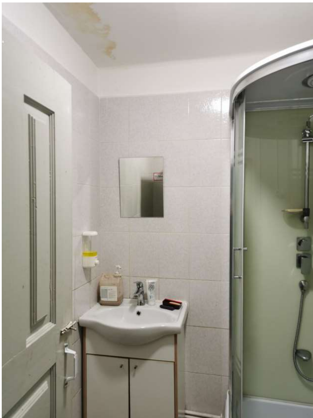
Фото 34. Санузел на втором этаже.
