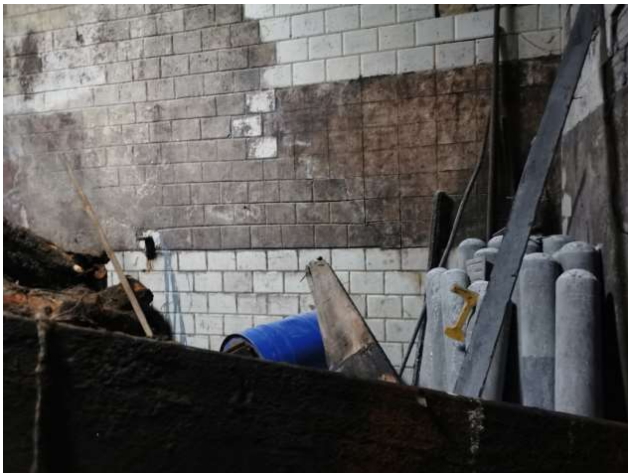
Фото 30. Неэксплуатируемый выход из тела насыпи к железнодорожным путям. Помещение, отсутствующее в техническом паспорте здания.
