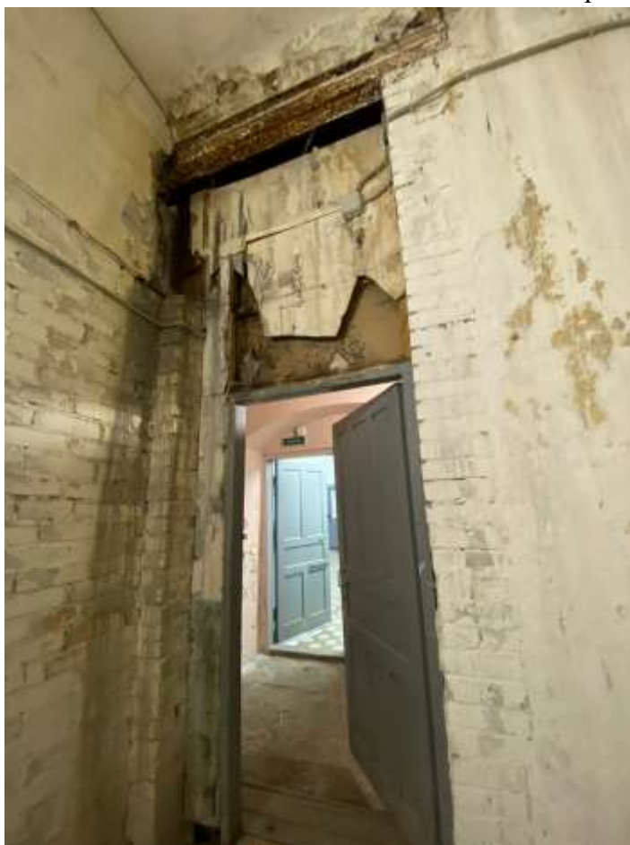
Фото 14. Техническое помещение в восточной части первого этажа.
