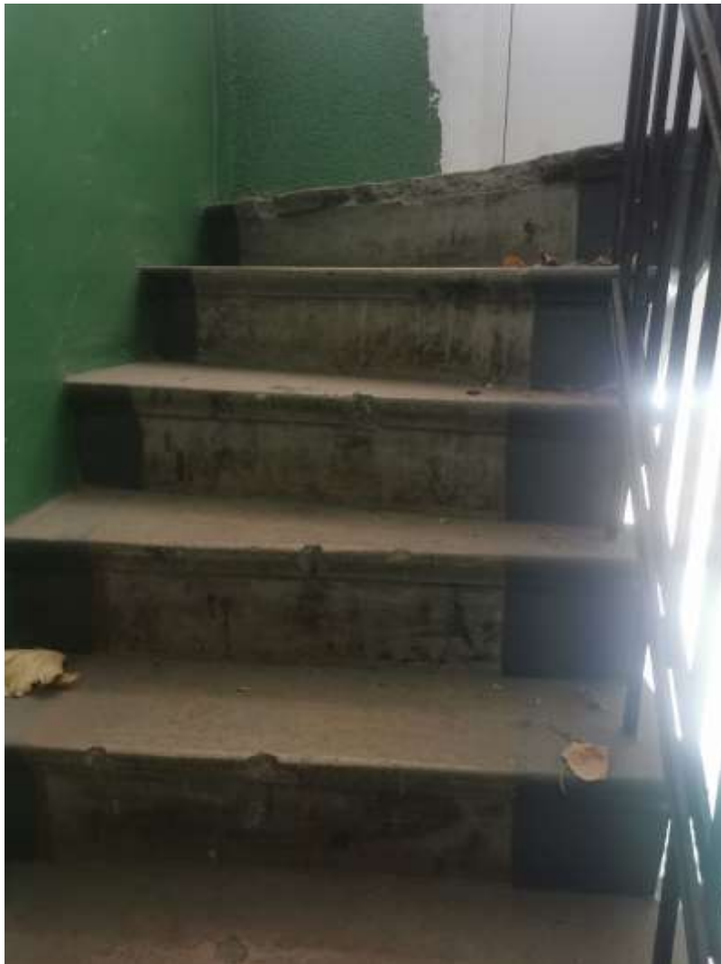
Фото 45. Вид на бетонную лестницу на третьем этаже
