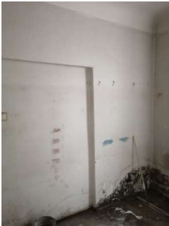
Фото 11. Неэксплуатируемое помещение на первом этаже.
