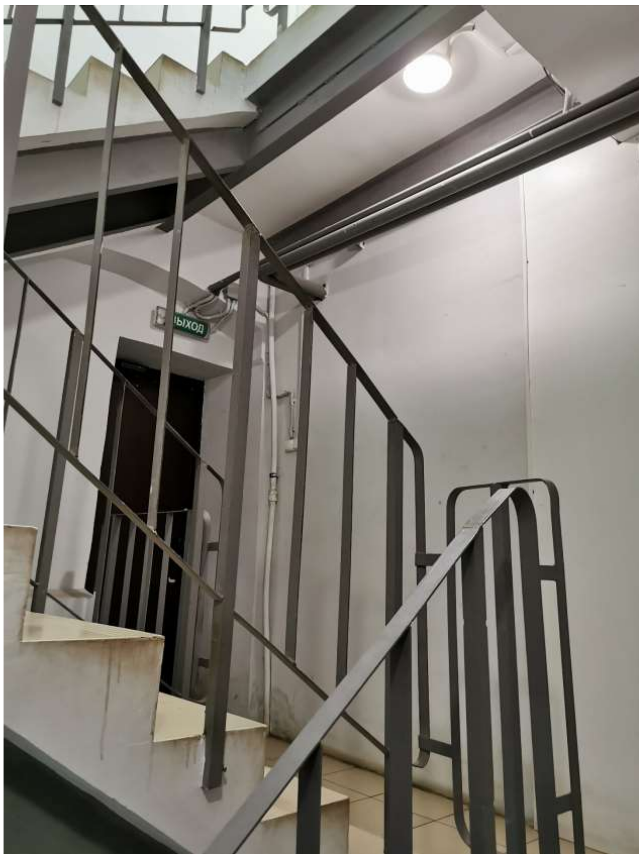
Фото 37. Поздняя лестница. Вход со стороны восточного фасада.
