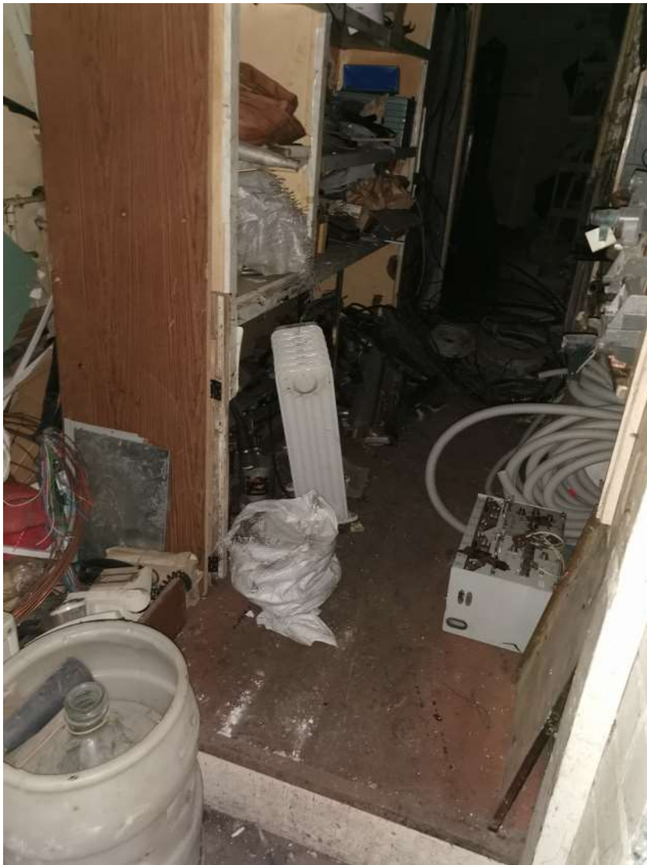
Фото 28. Помещение первого этажа в тоннеле под насыпью.
