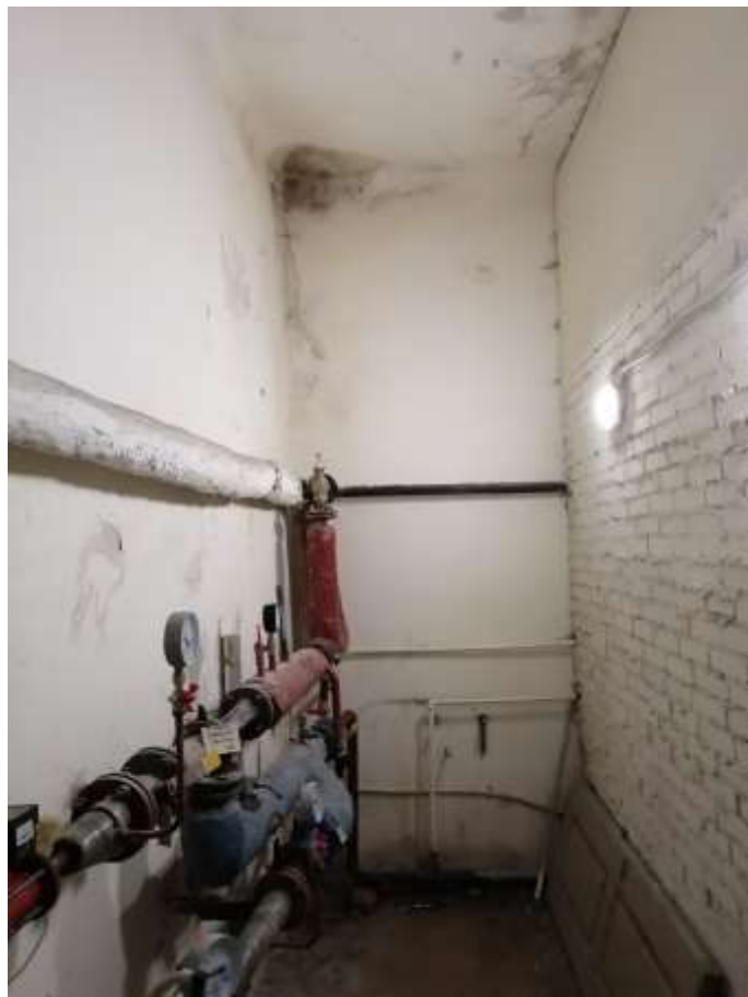
Фото 16. Техническое помещение в восточной части первого этажа.
