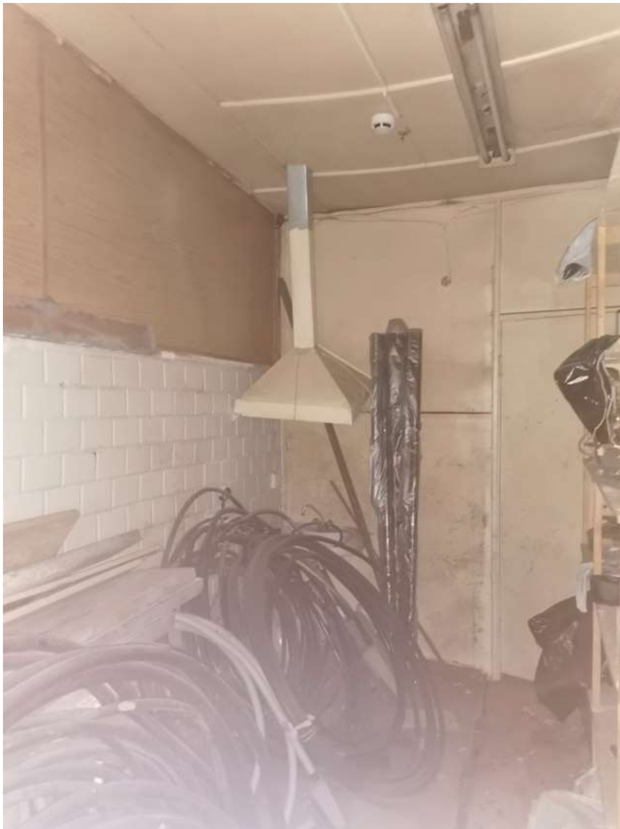
Фото 26. Помещение первого этажа в тоннеле под насыпью.
