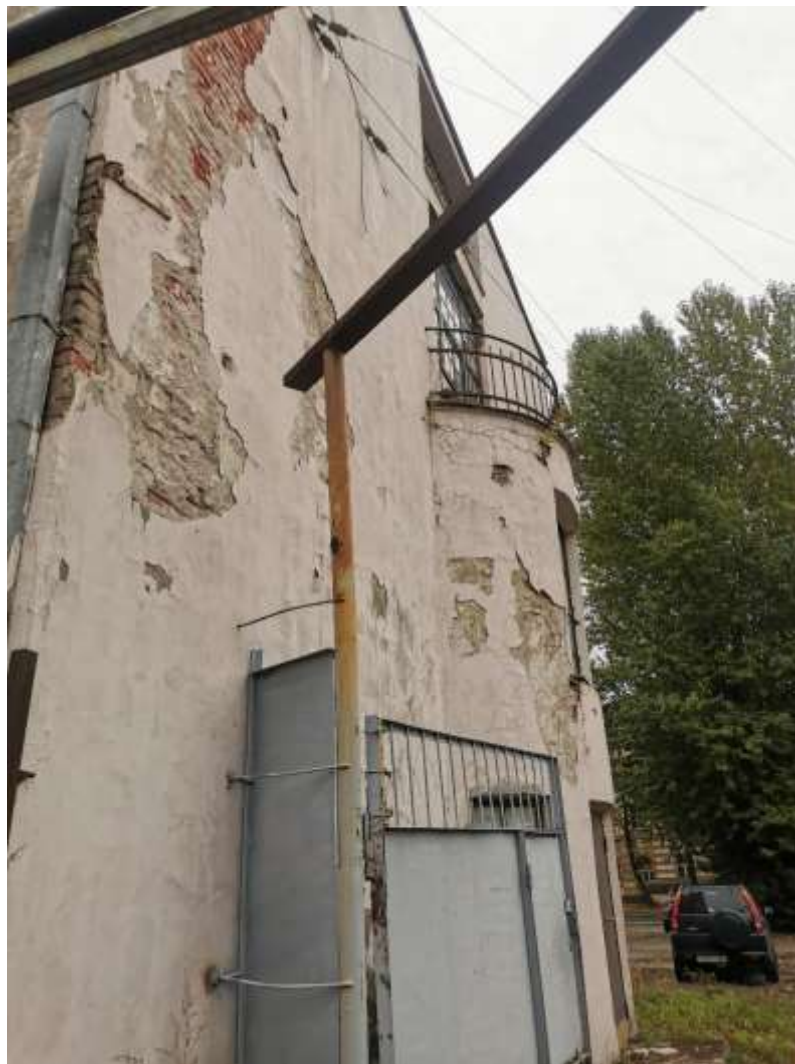
Фото 5. Боковой (западный) фасад здания.
