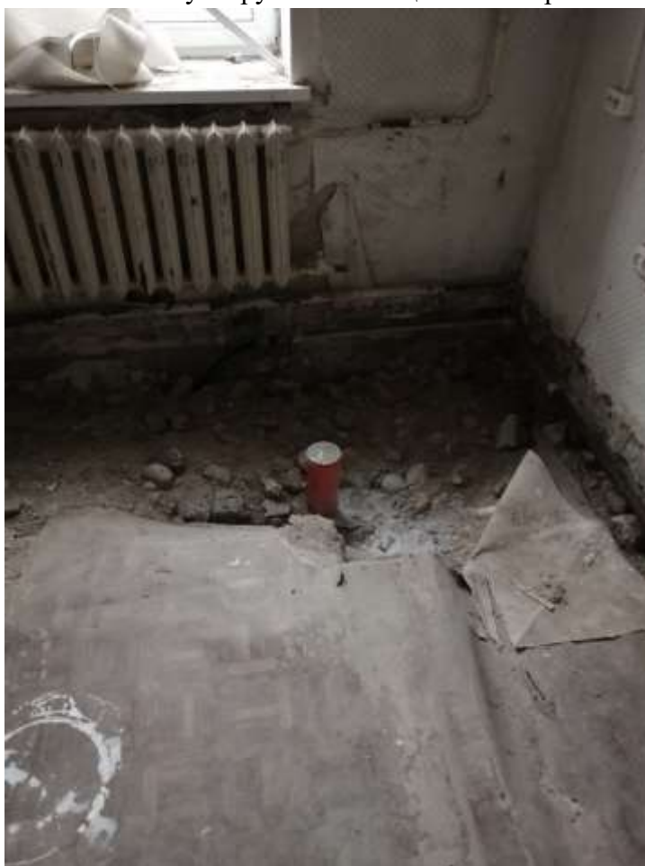
Фото 12. Неэксплуатируемое помещение на первом этаже.
