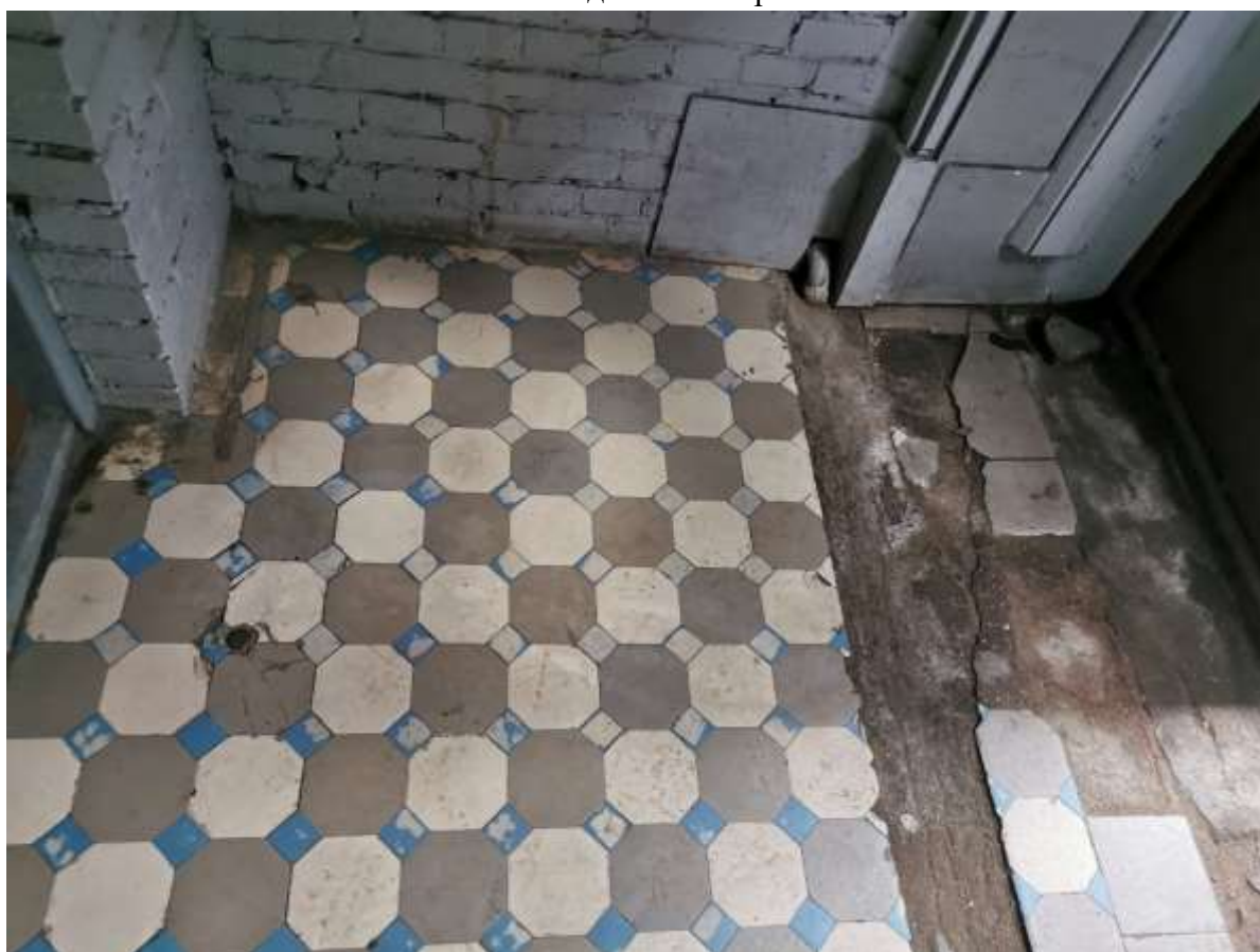
Фото 10. Метлахская плитка в зале ожидания на первом этаже.
