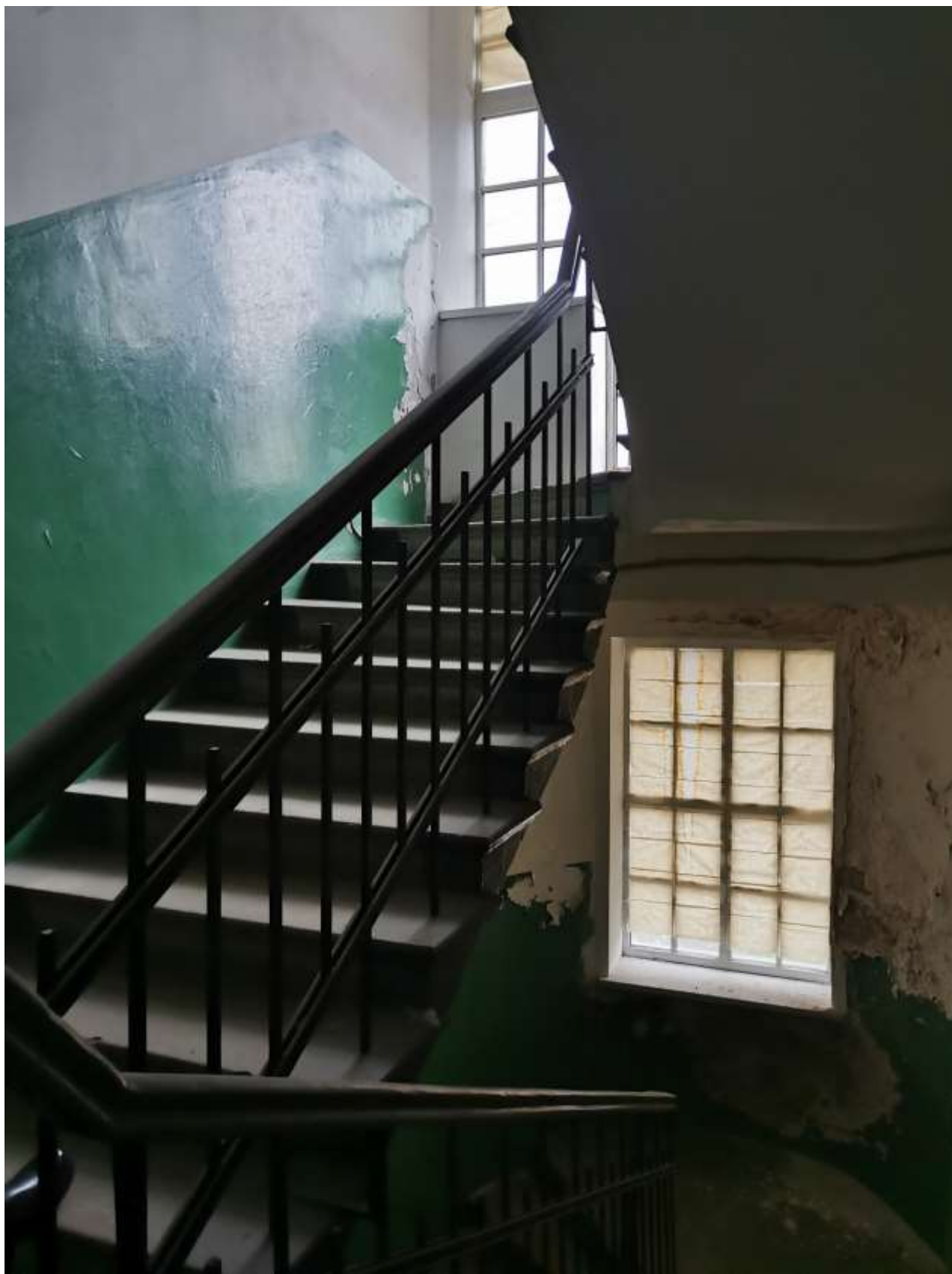
Фото 46. Вид на бетонную лестницу на втором этаже.
