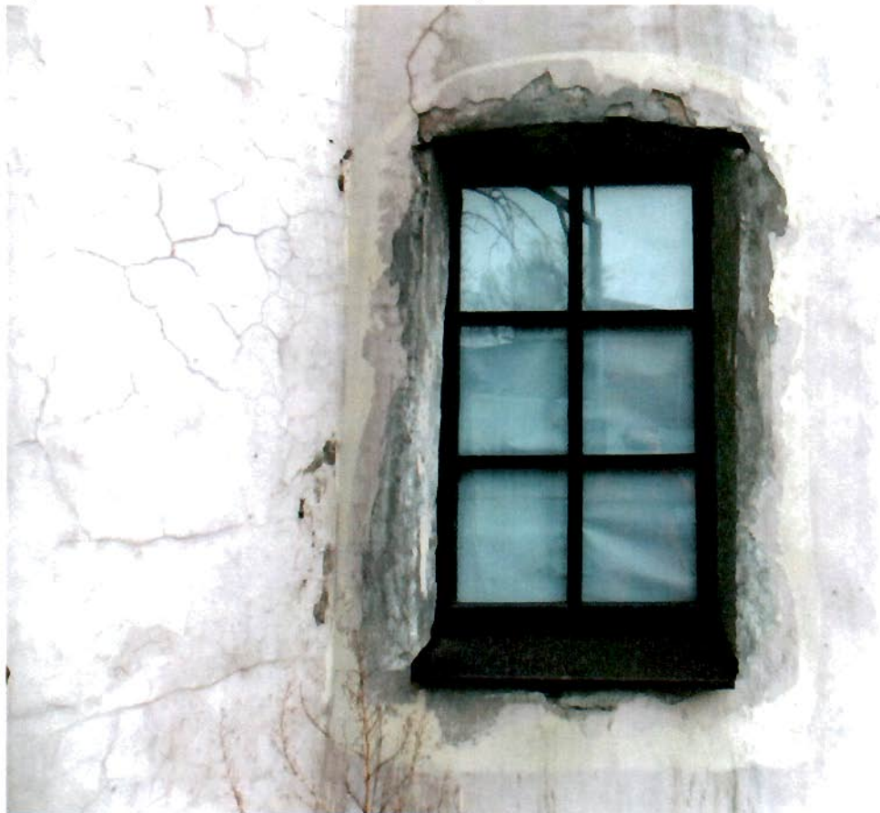
11. Фрагменты стены с юго-западной стороны
