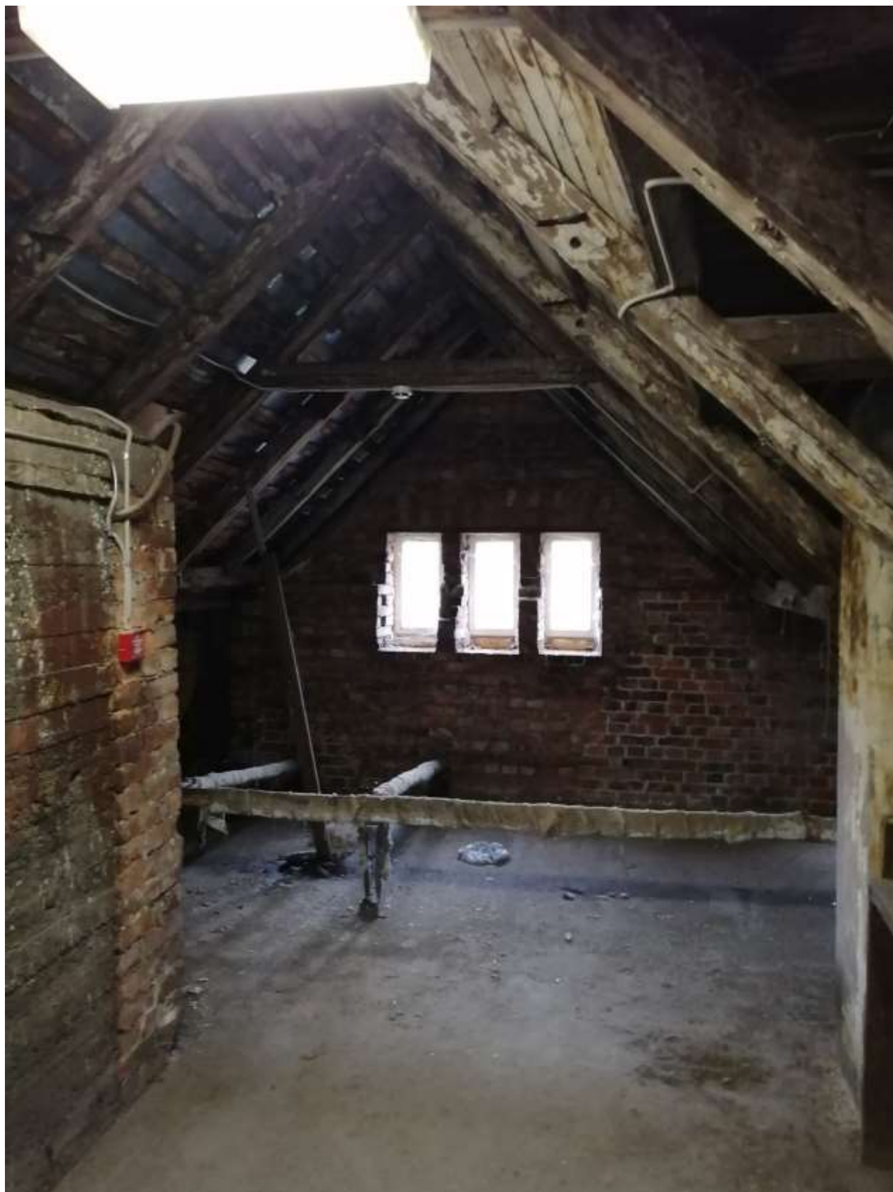
Фото 49. Вид на мансардный этаж.
