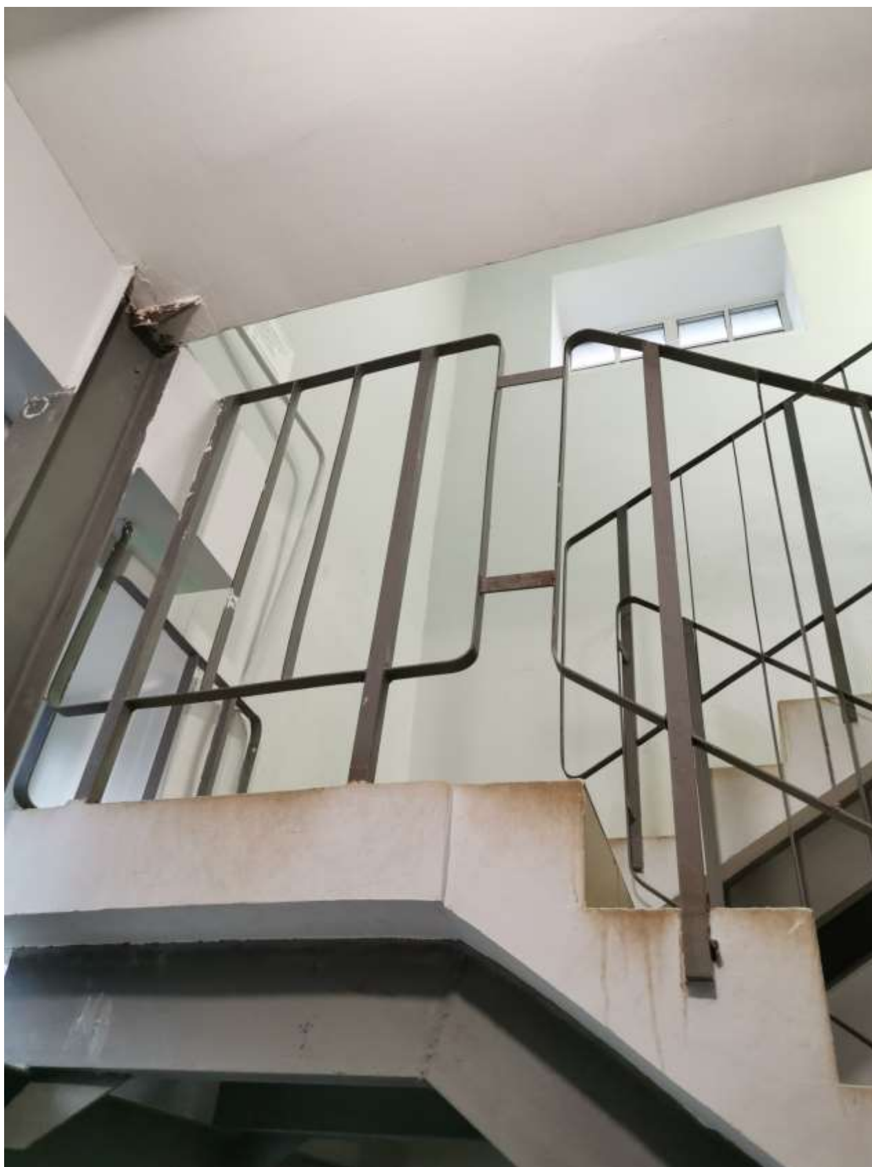
Фото 38. Поздняя лестница. Вход со стороны восточного фасада.
