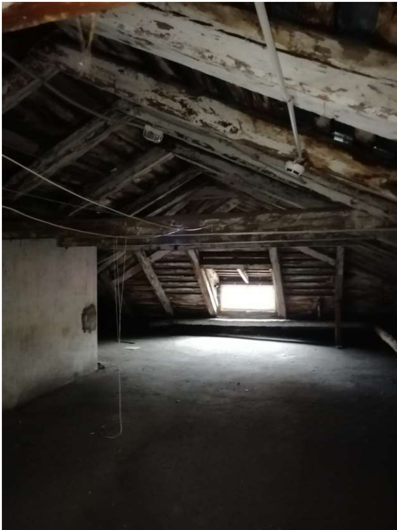
Фото 50. Вид на мансардный этаж.
