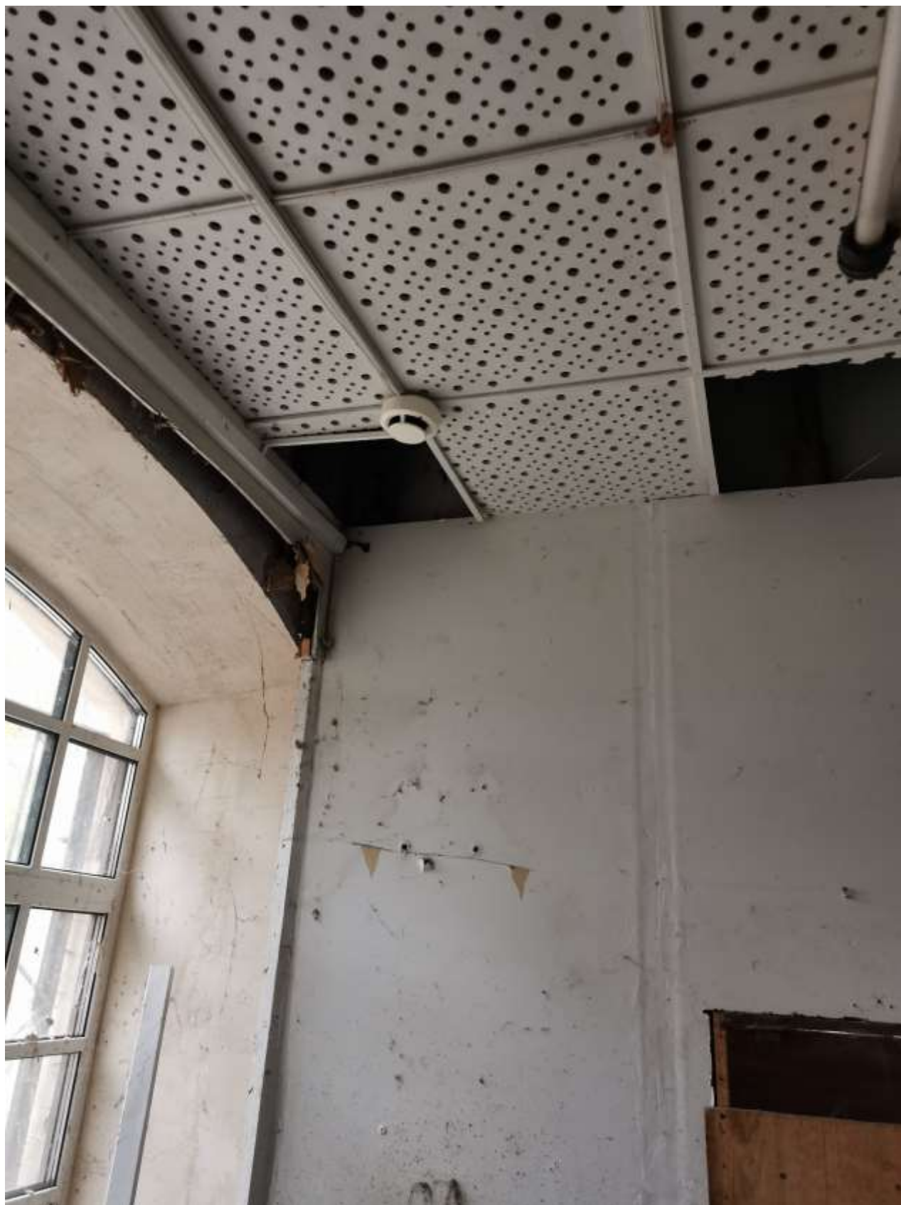
Фото 25. Неэксплуатируемое помещение первого этажа со стороны насыпи.
