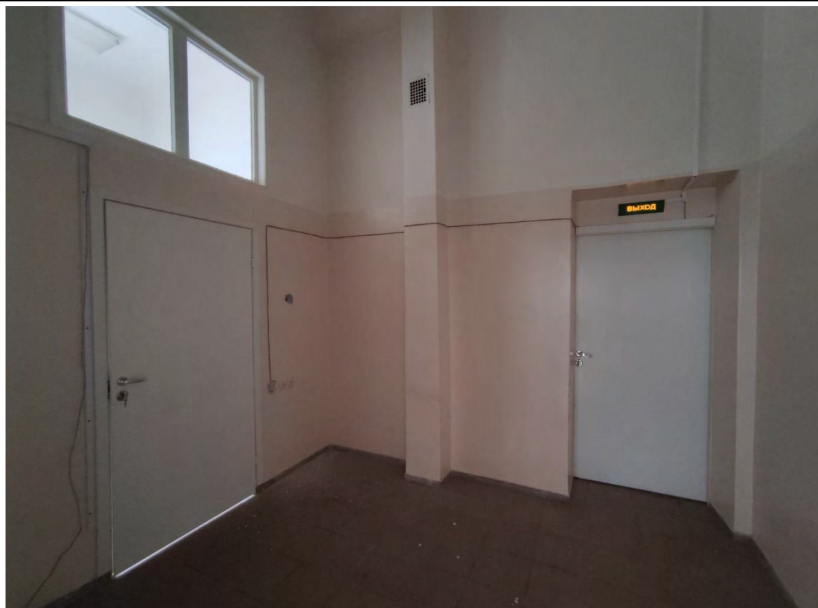
67. Общий вид пом. 3-Н (12) в уровне 2-го этажа.
