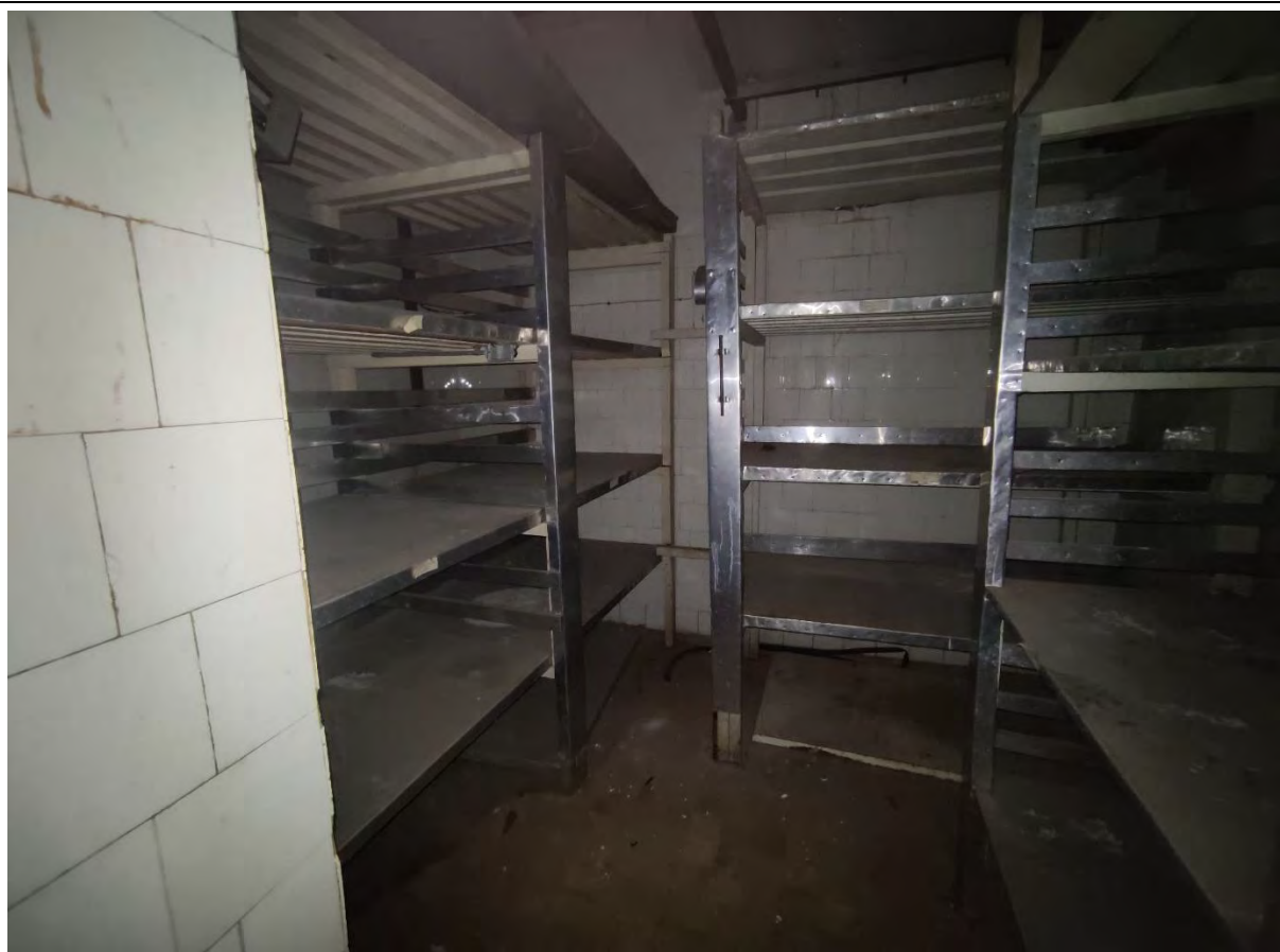
16. Общий вид пом. 1-Н (13) в уровне цокольного этажа.
