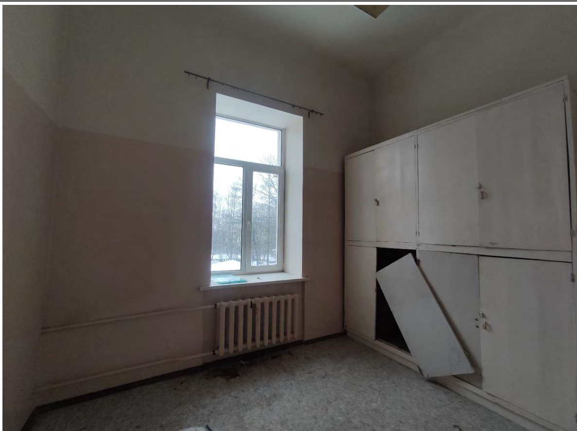
50. Общий вид пом. 3-Н (13) в уровне 2-го этажа.
