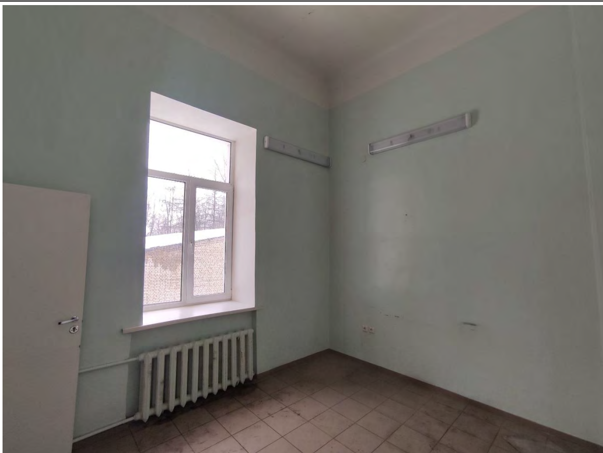
44. Общий вид пом. 2-Н (12) в уровне 1-го этажа.
