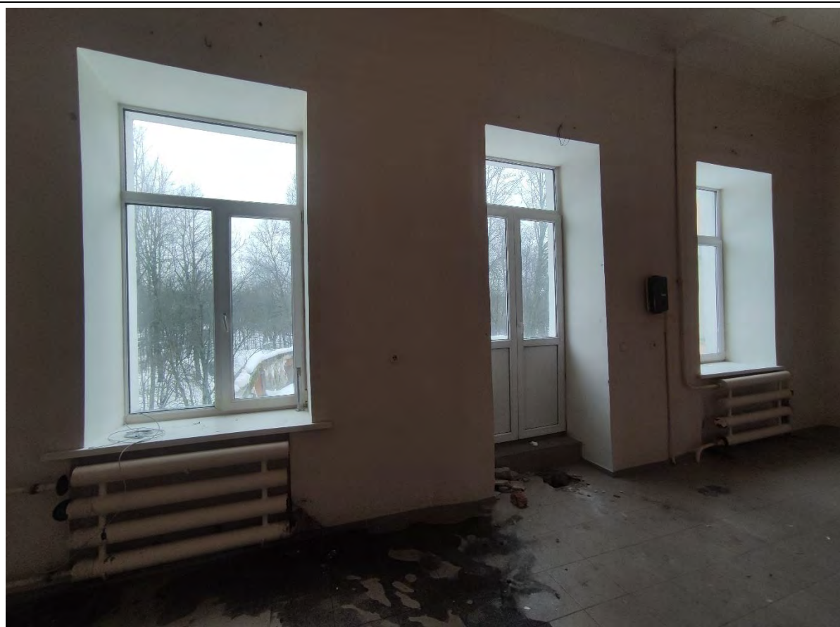
63. Фрагмент пом. 3-Н (4, 7, 26) в уровне 2-го этажа.
