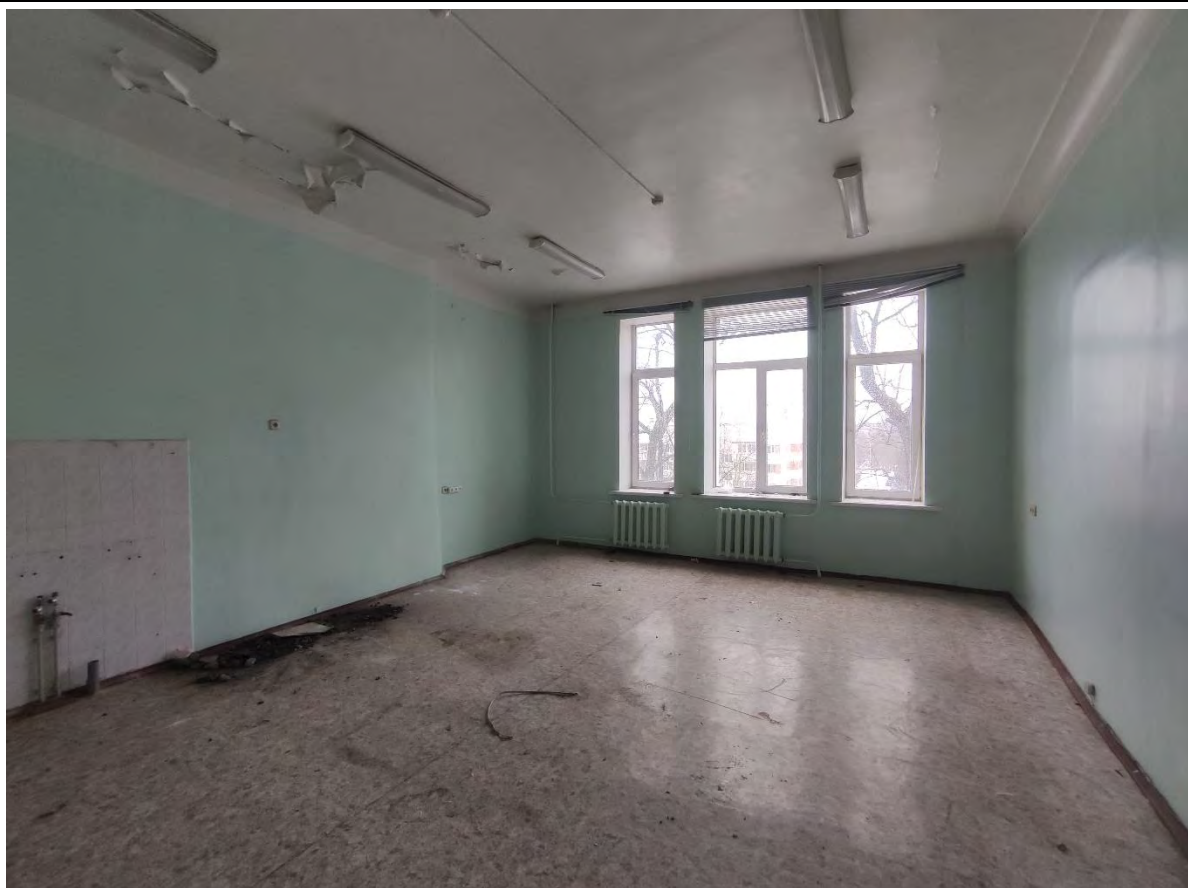
76. Общий вид пом. 4-Н (19) в уровне 3-го этажа.
