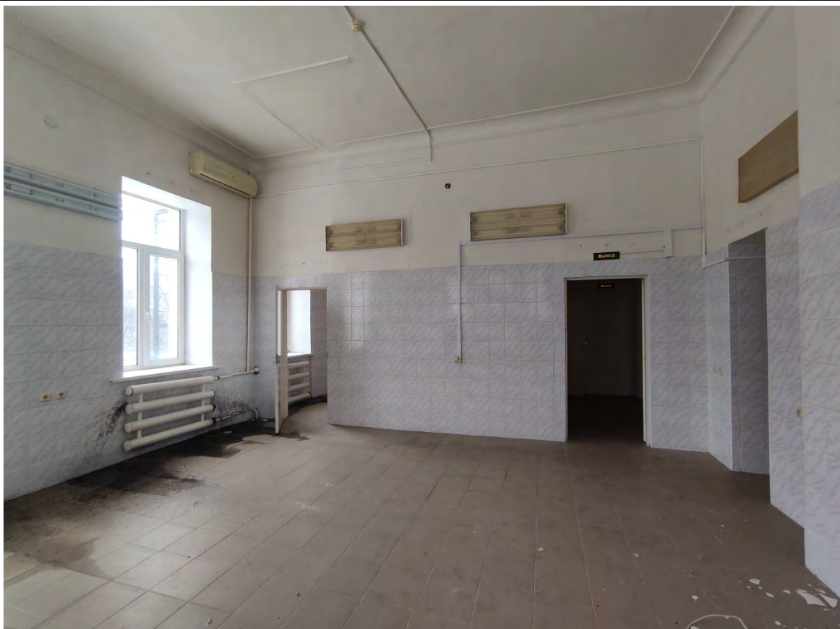
66. Общий вид пом. 3-Н (10) в уровне 2-го этажа.
