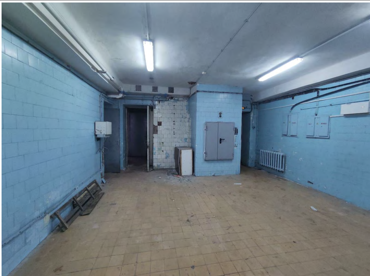
19. Общий вид пом. 1-Н (28) в уровне цокольного этажа.
