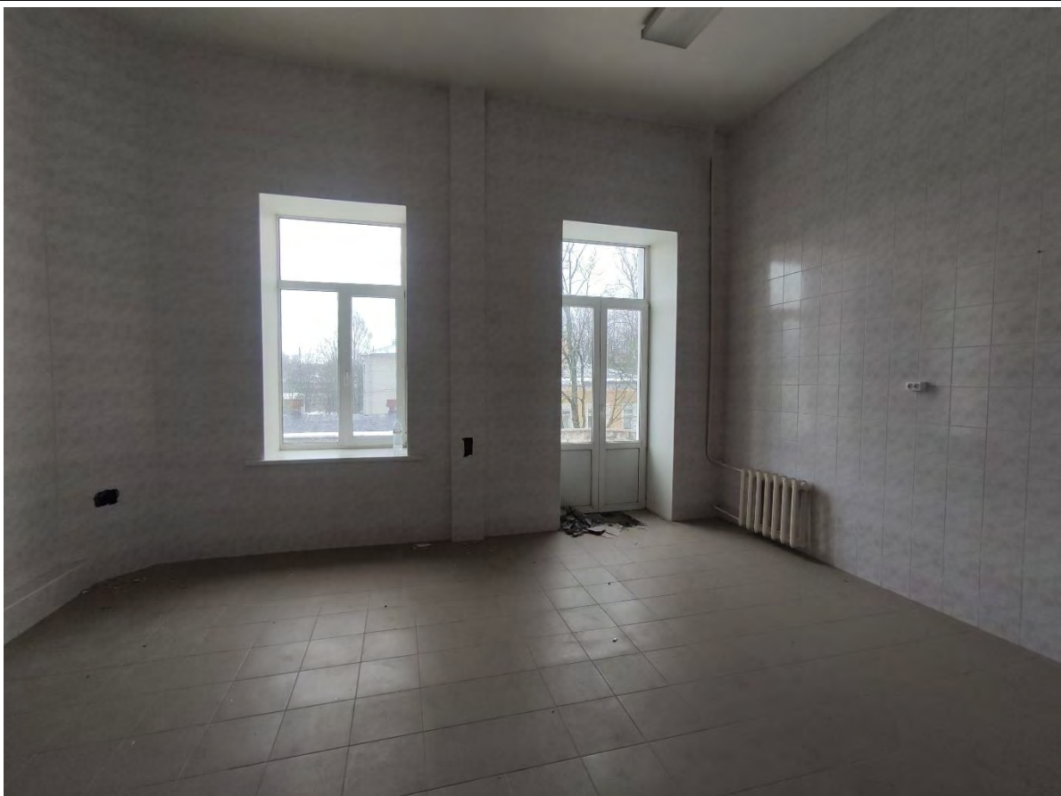
52. Общий вид пом. 3-Н (19) в уровне 2-го этажа.
