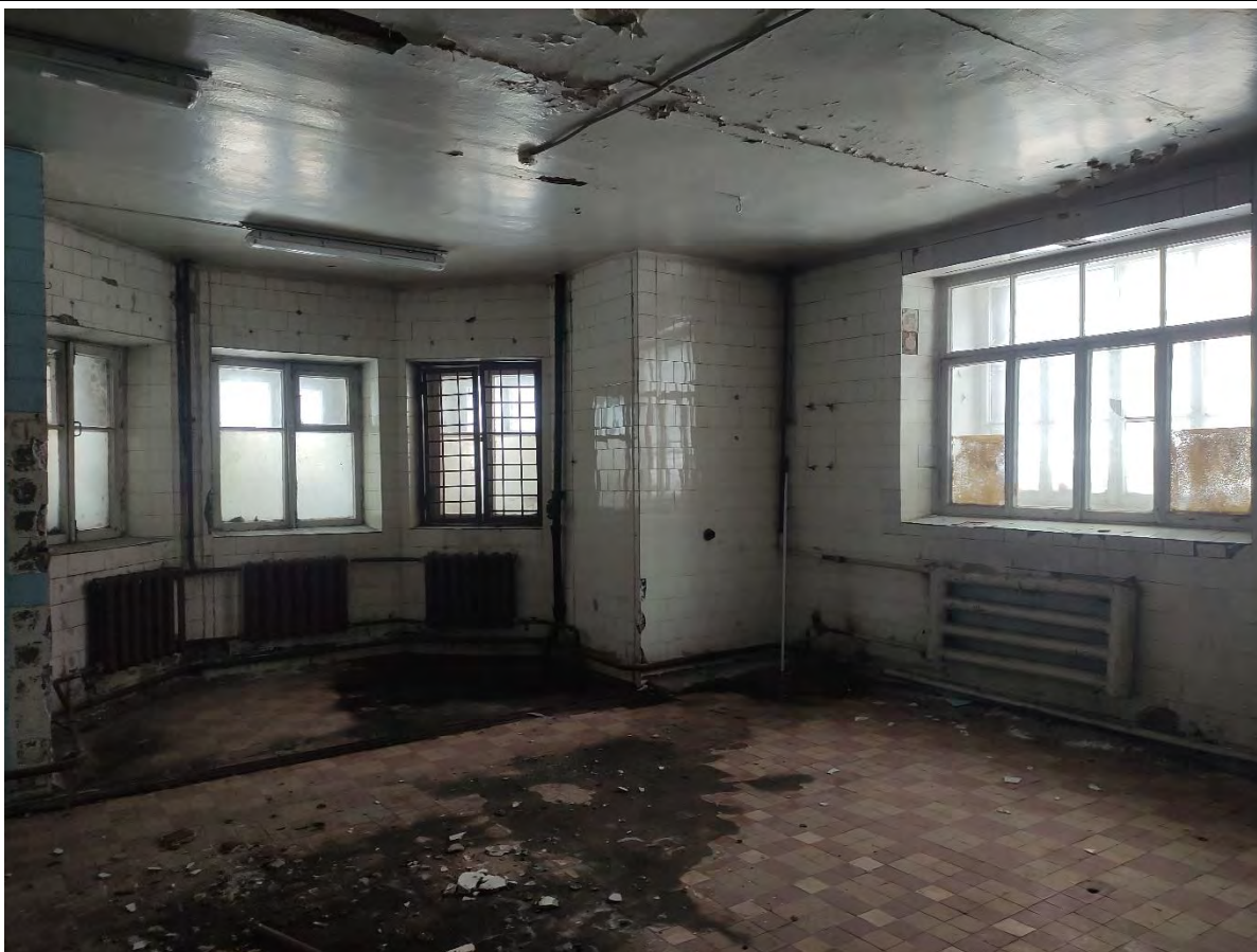
33. Общий вид пом. 1-Н (10) в уровне цокольного этажа.
