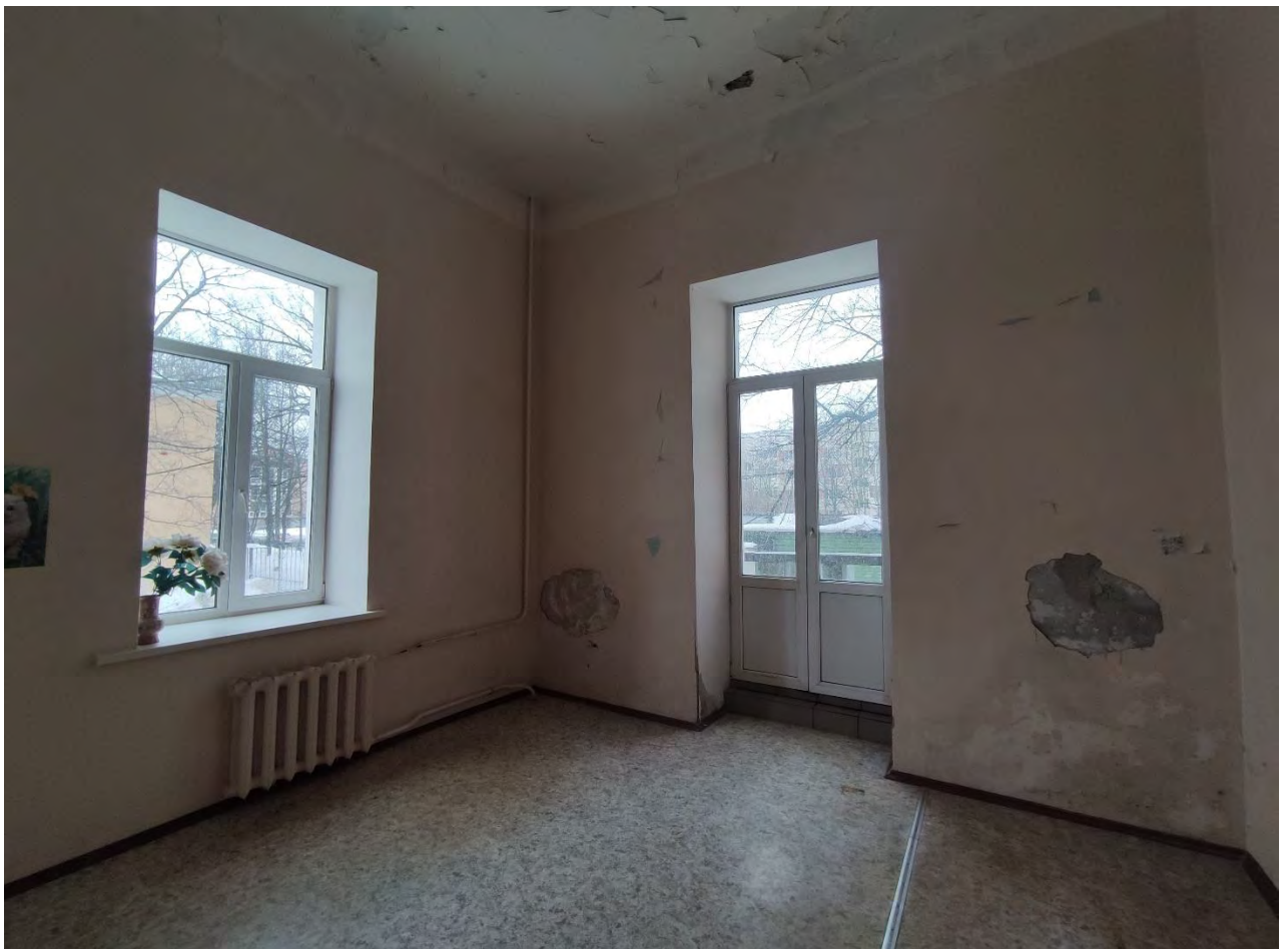
41. Общий вид пом. 2-Н (20) в уровне 1-го этажа.
