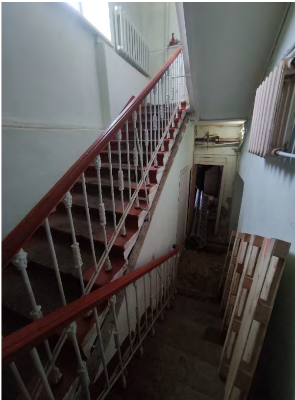
12. Общий вид объема двухмаршевой лестницы (пом. 1-Н (32)).
