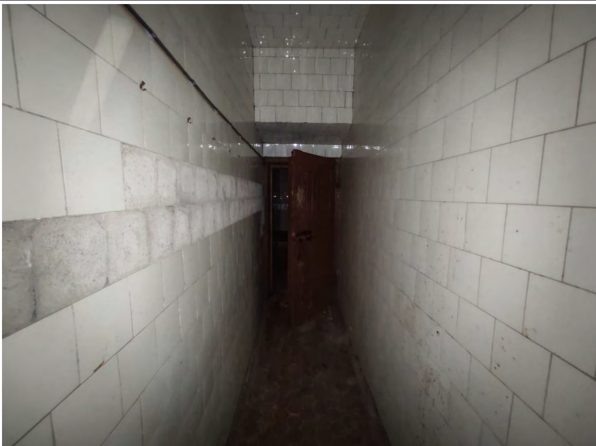
29. Общий вид пом. 1-Н (9) в уровне цокольного этажа.
