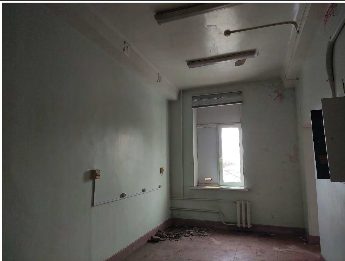
74. Общий вид пом. 4-Н (18) в уровне 3-го этажа.
