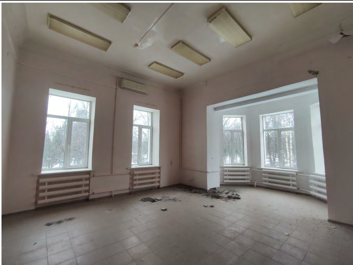
61. Общий вид пом. 3-Н (2) в уровне 2-го этажа.
