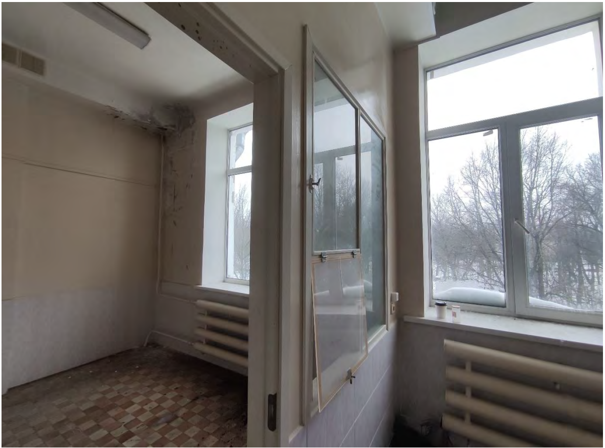
79. Общий вид пом. 4-Н (4, 5) в уровне 3-го этажа.
