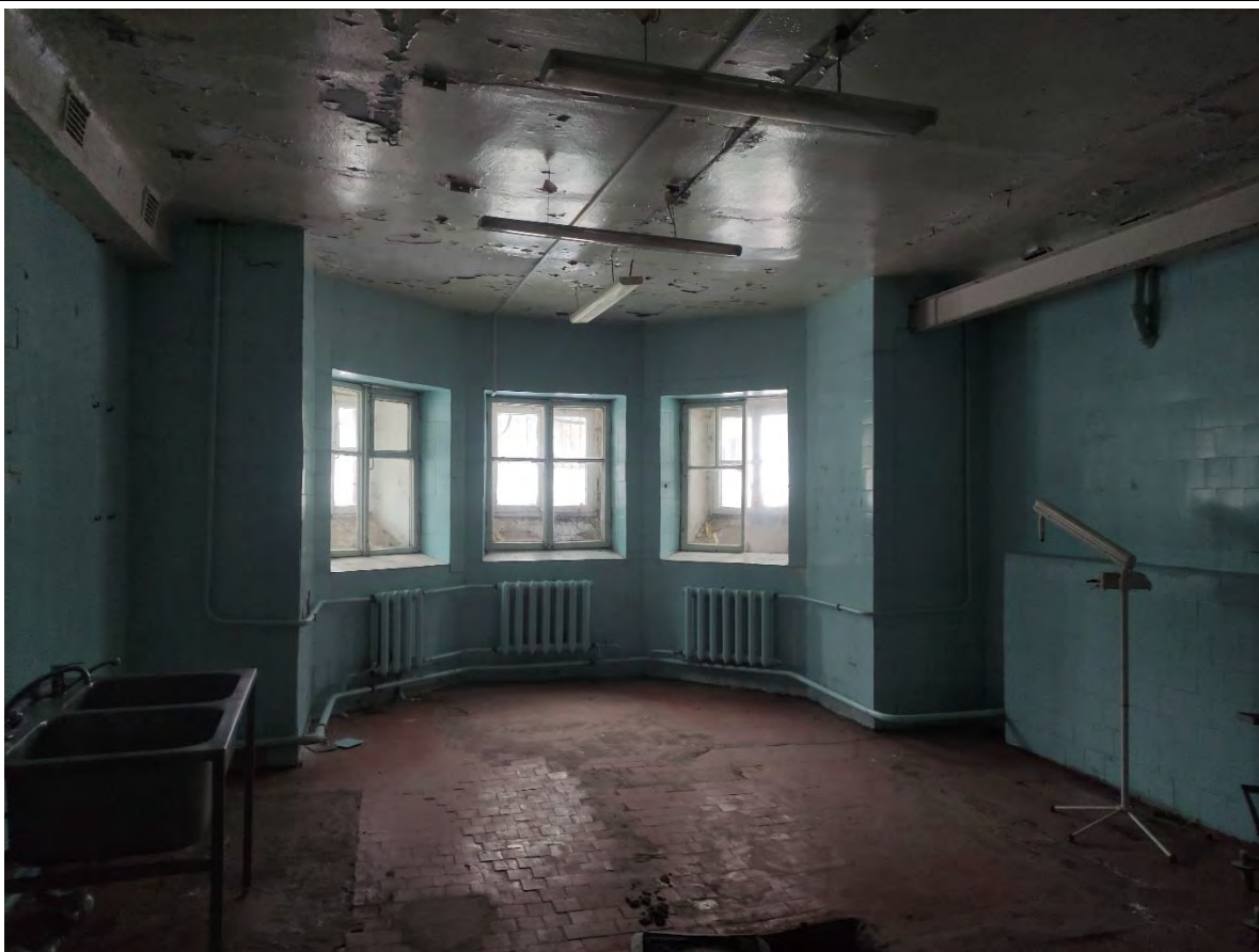
23. Общий вид пом. 1-Н (27) в уровне цокольного этажа.
