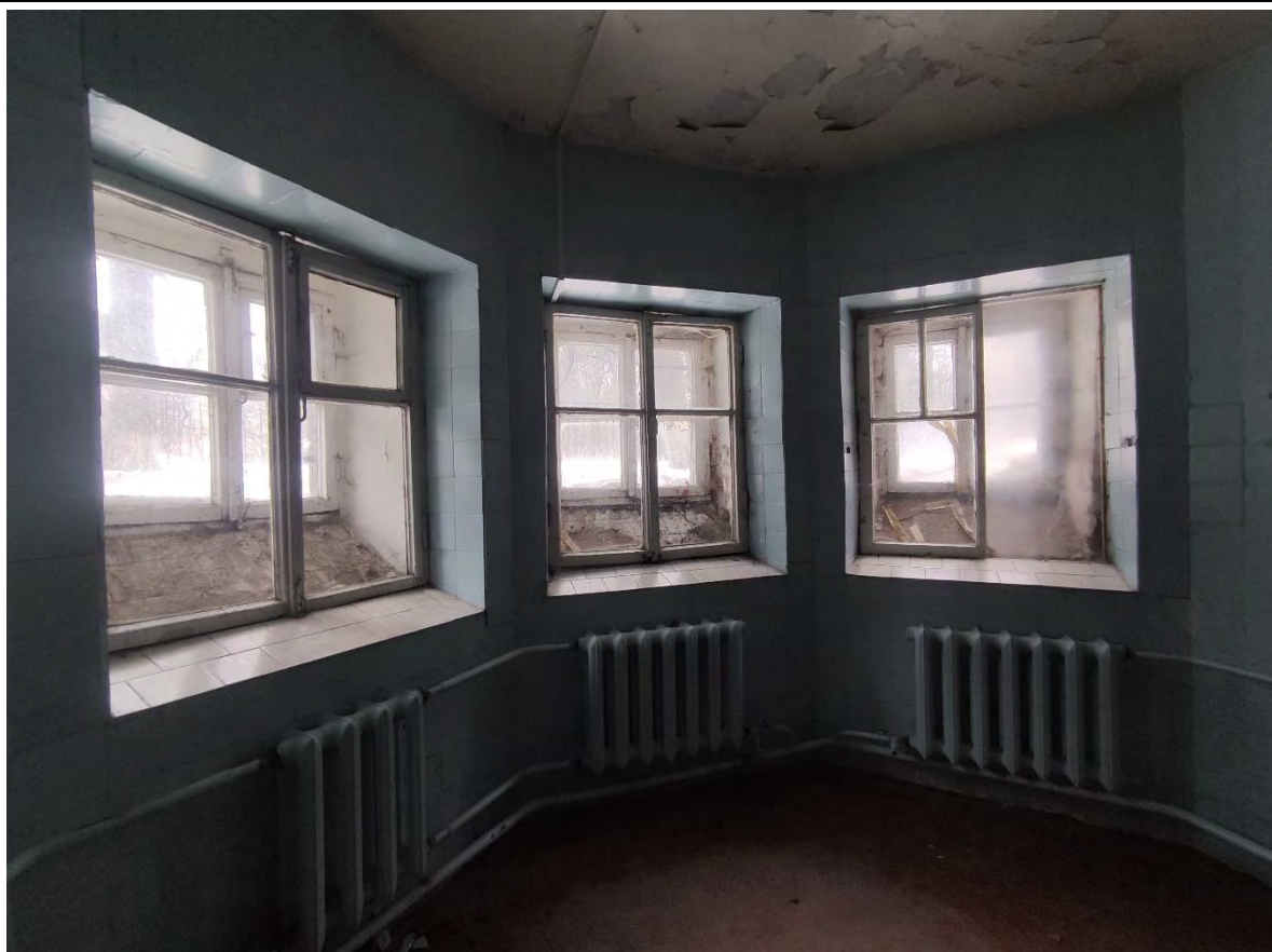
24. Фрагмент пом. 1-Н (27) в уровне цокольного этажа. Оконные проемы ризалита юго-западного фасада.
