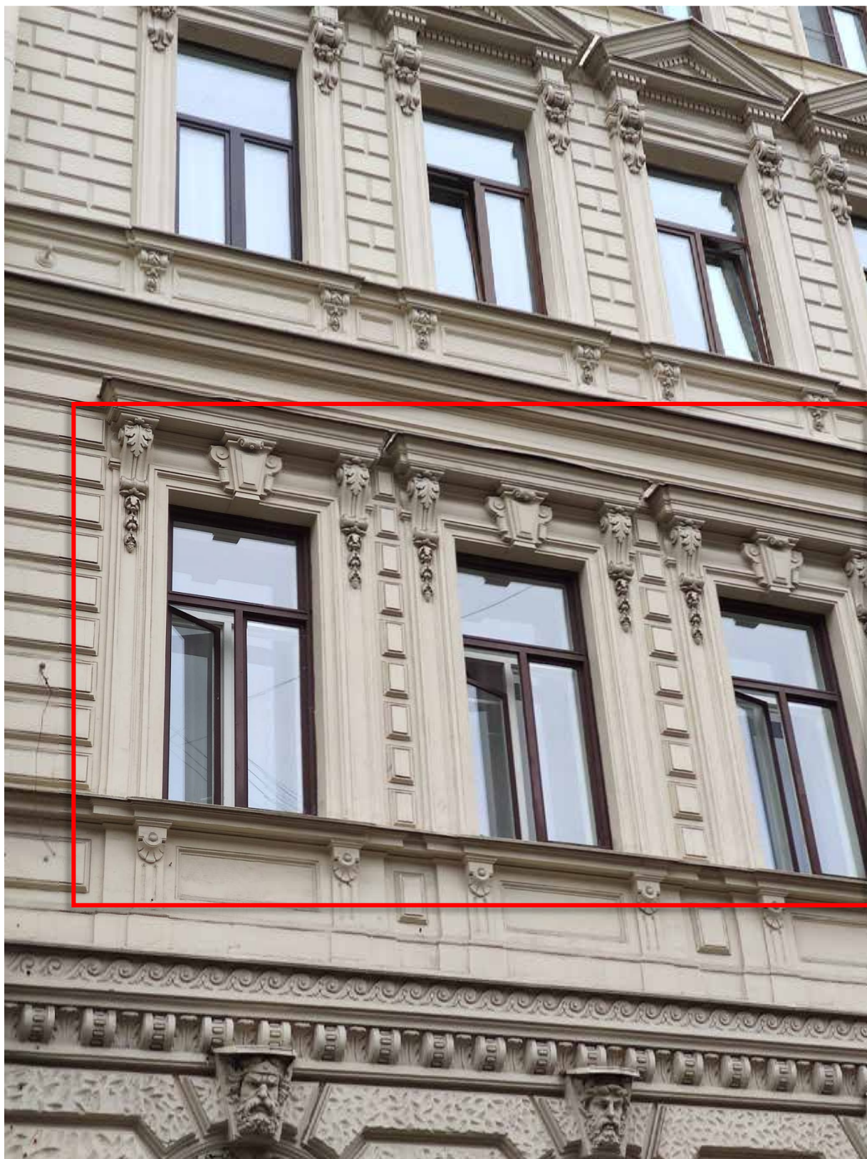
2. Вид на окна квартиры №19;
