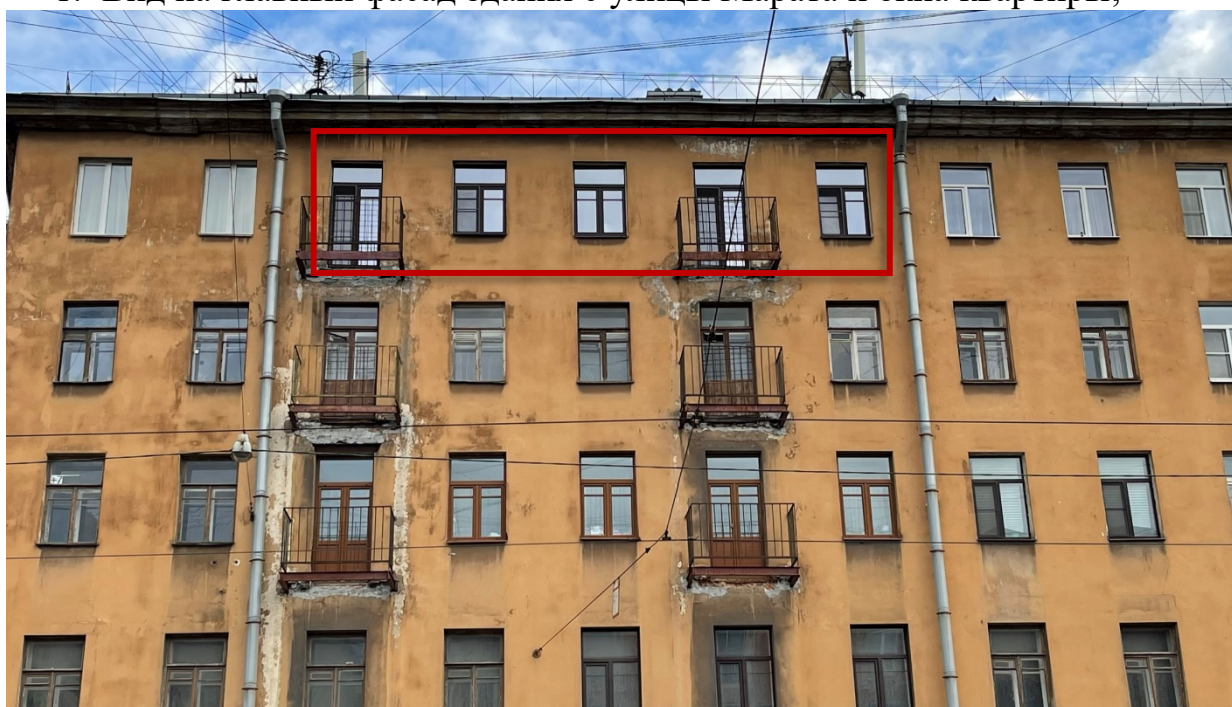
2. Вид на главный фасад здания с улицы Марата и окна квартиры;
