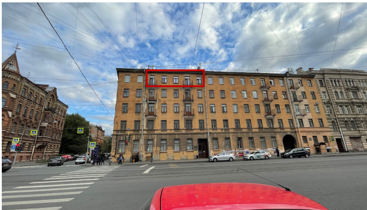
1. Вид на главный фасад здания с улицы Марата и окна квартиры;
