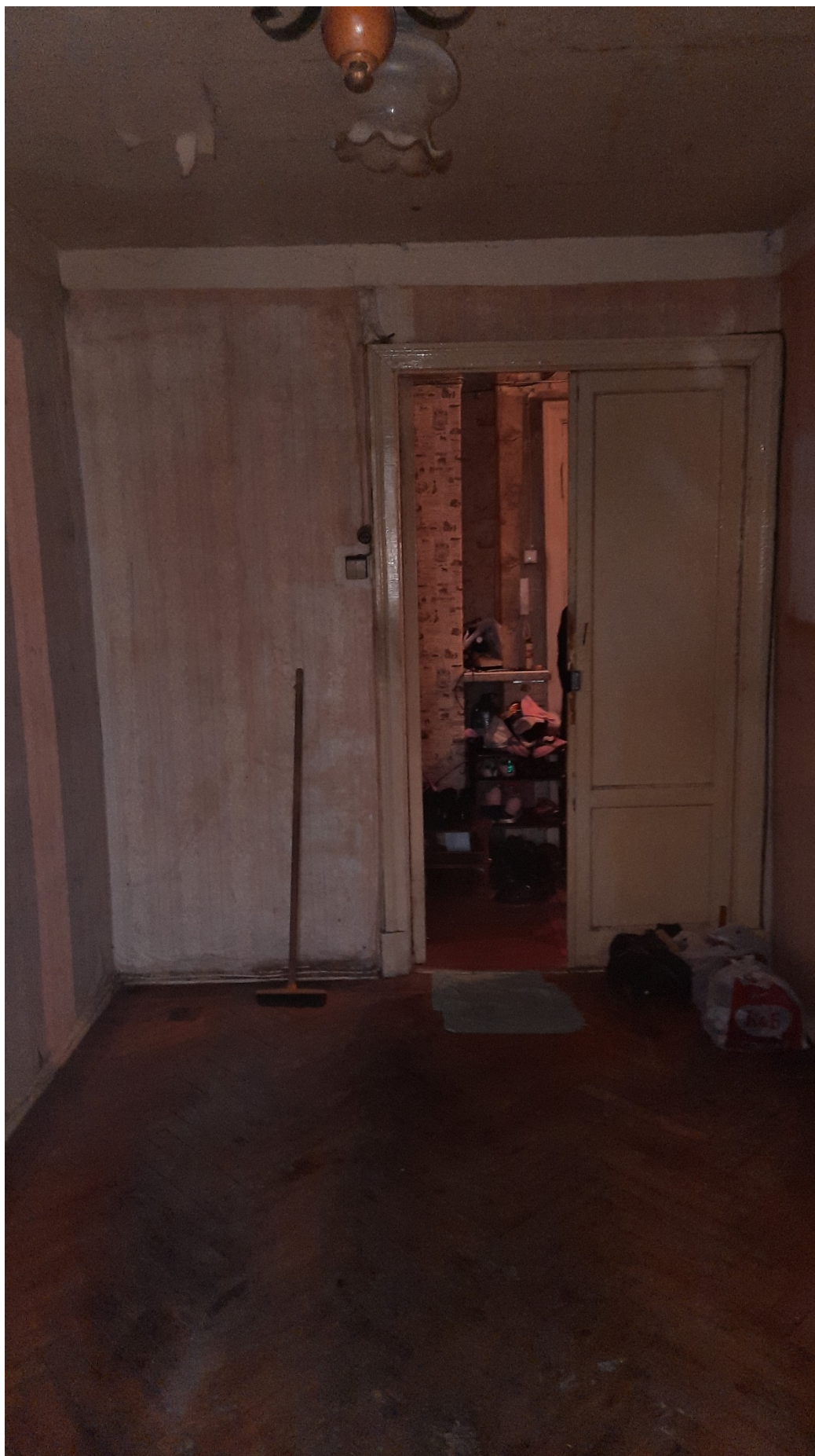
14.Фрагмент интерьера комнаты (помещение №6);
