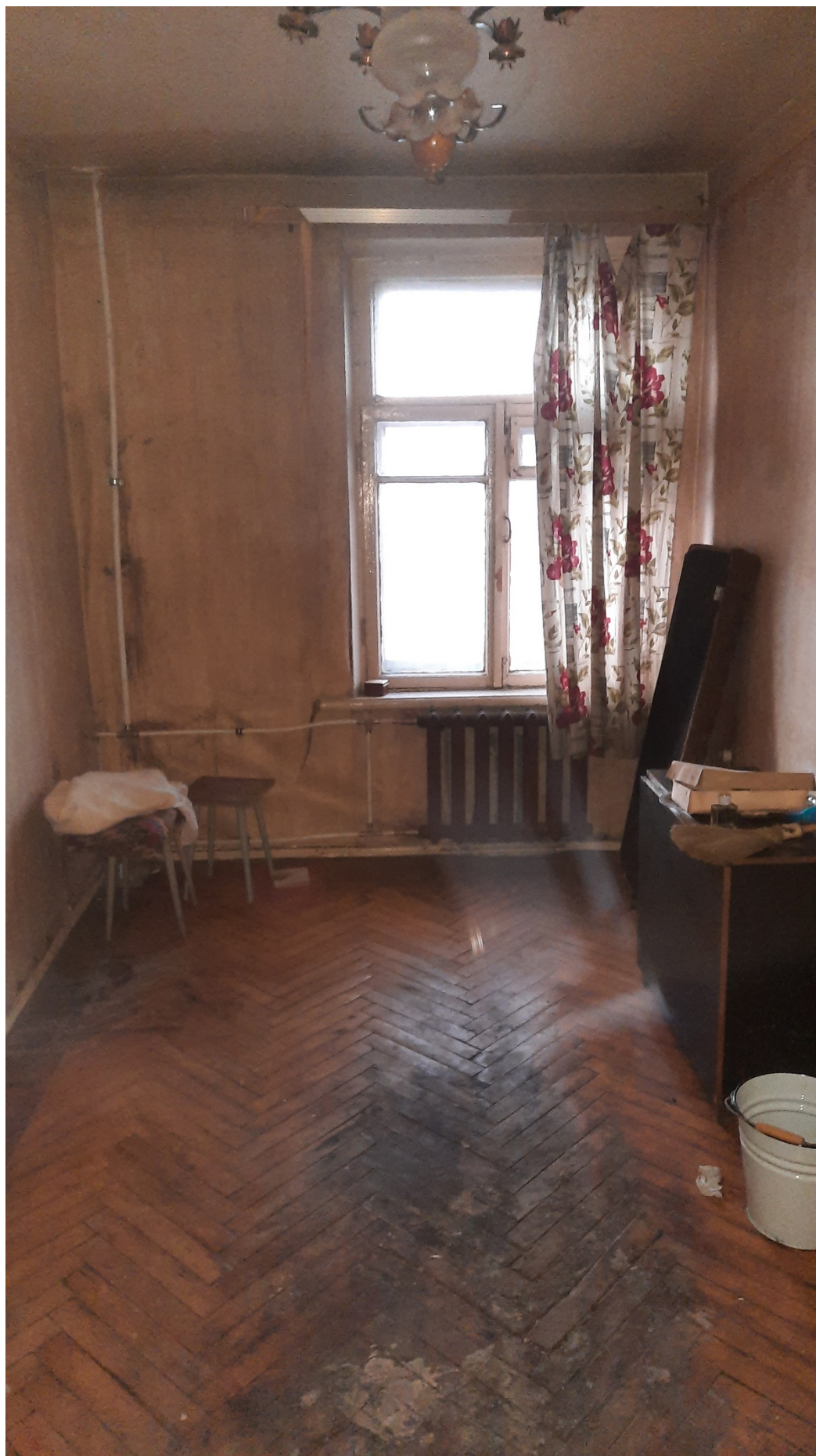
13. Фрагмент интерьера комнаты (помещение №6);
