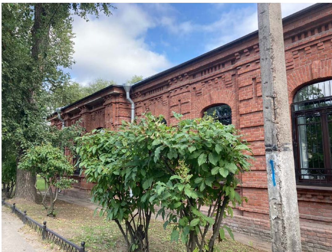
Фото 12. Фрагмент лицевого фасада объекта культурного наследия регионального значения «Школа Адмиралтейских Ижорских заводов»
