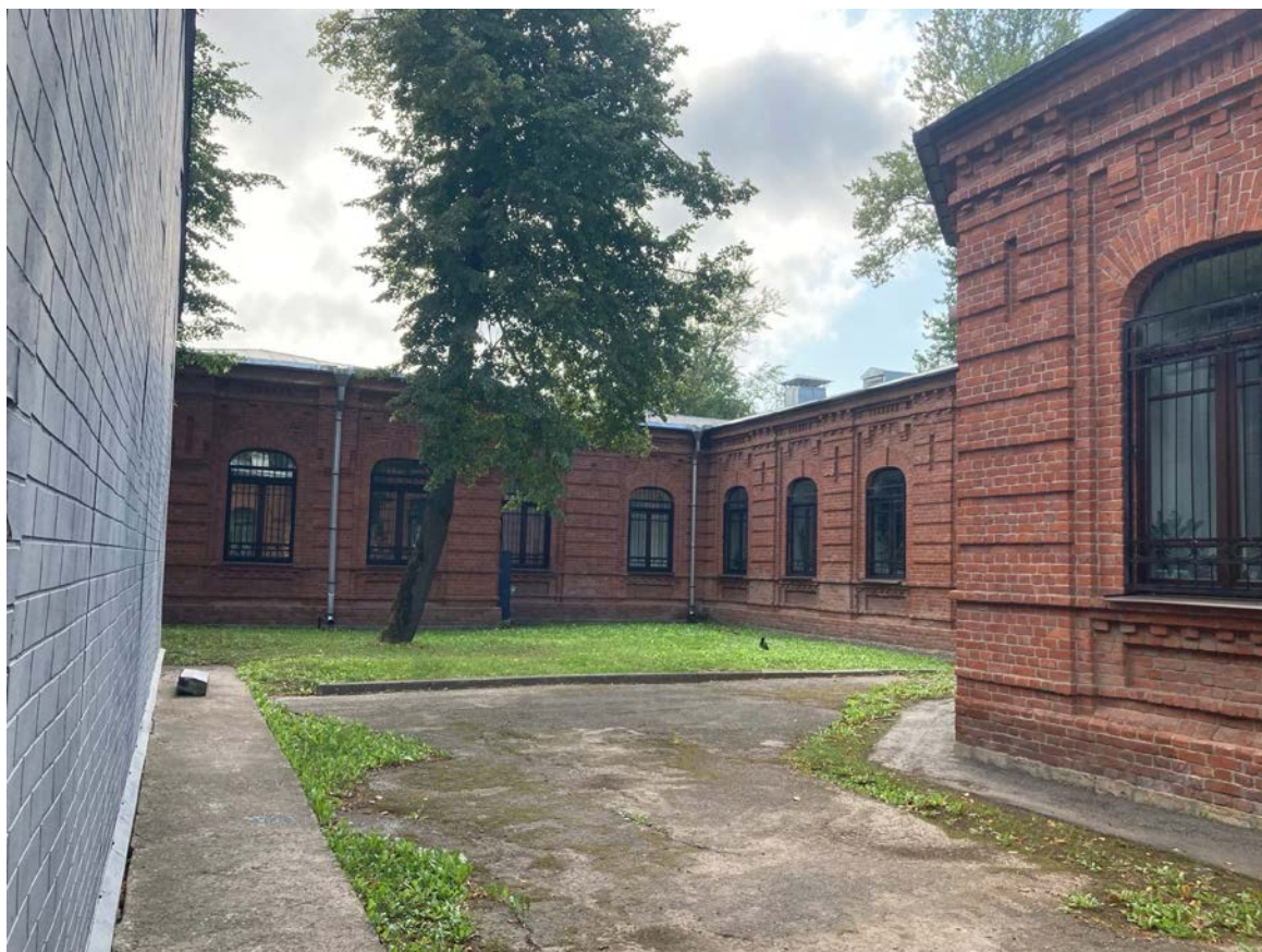
Фото 7. Фрагмент дворового фасада объекта культурного наследия регионального значения «Школа Адмиралтейских Ижорских заводов»
