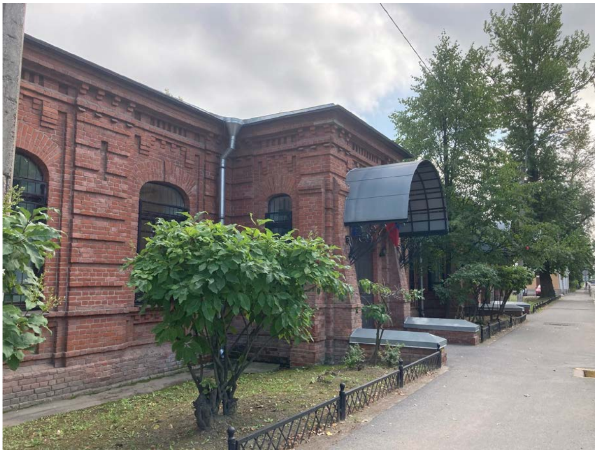
Фото 13. Фрагмент лицевого фасада объекта культурного наследия регионального значения «Школа Адмиралтейских Ижорских заводов»
