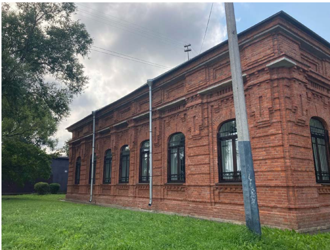
Фото 3.. Фрагмент лицевого фасада объекта культурного наследия регионального значения «Школа Адмиралтейских Ижорских заводов».
