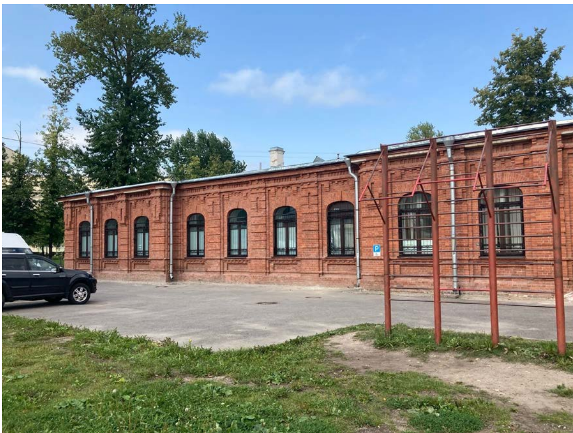
Фото 9. Фрагмент лицевого фасада объекта культурного наследия регионального значения «Школа Адмиралтейских Ижорских заводов»
