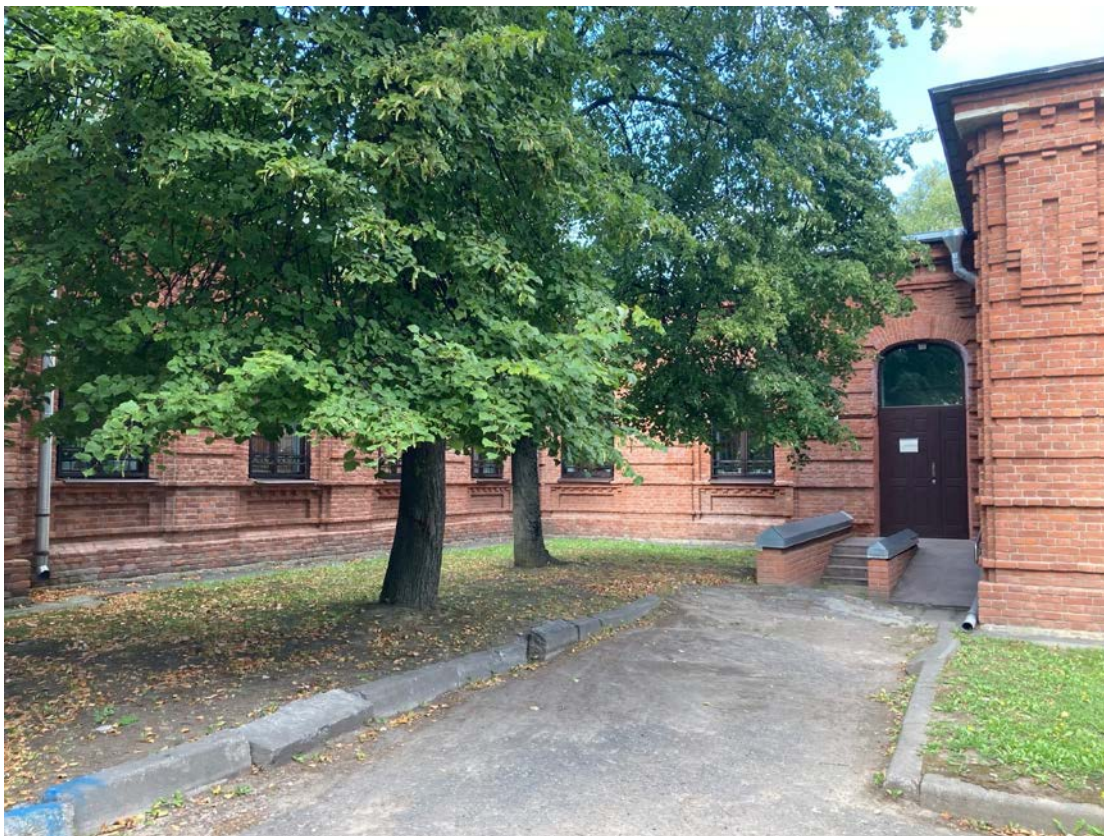
Фото 5. Фрагмент дворового фасада объекта культурного наследия регионального значения «Школа Адмиралтейских Ижорских заводов»
