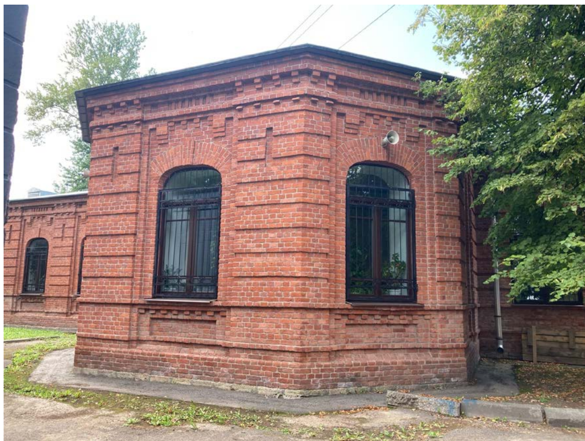
Фото 6. Фрагмент дворового фасада объекта культурного наследия регионального значения «Школа Адмиралтейских Ижорских заводов»
