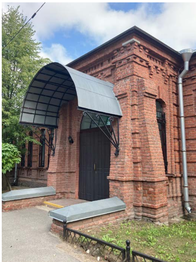
Фото 11. Фрагмент лицевого фасада объекта культурного наследия регионального значения «Школа Адмиралтейских Ижорских заводов», вход с Адмиралтейской ул.
