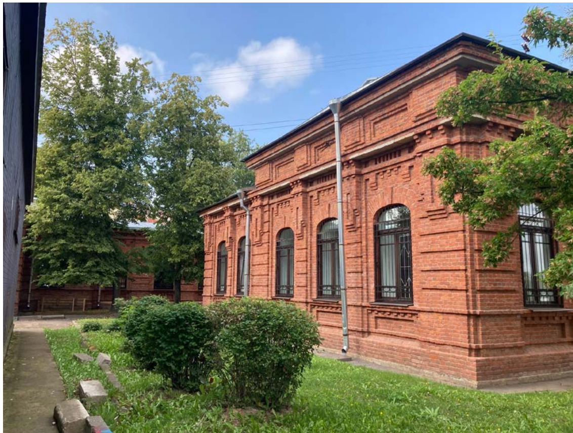
Фото 4. Фрагмент дворового фасада объекта культурного наследия регионального значения «Школа Адмиралтейских Ижорских заводов»
