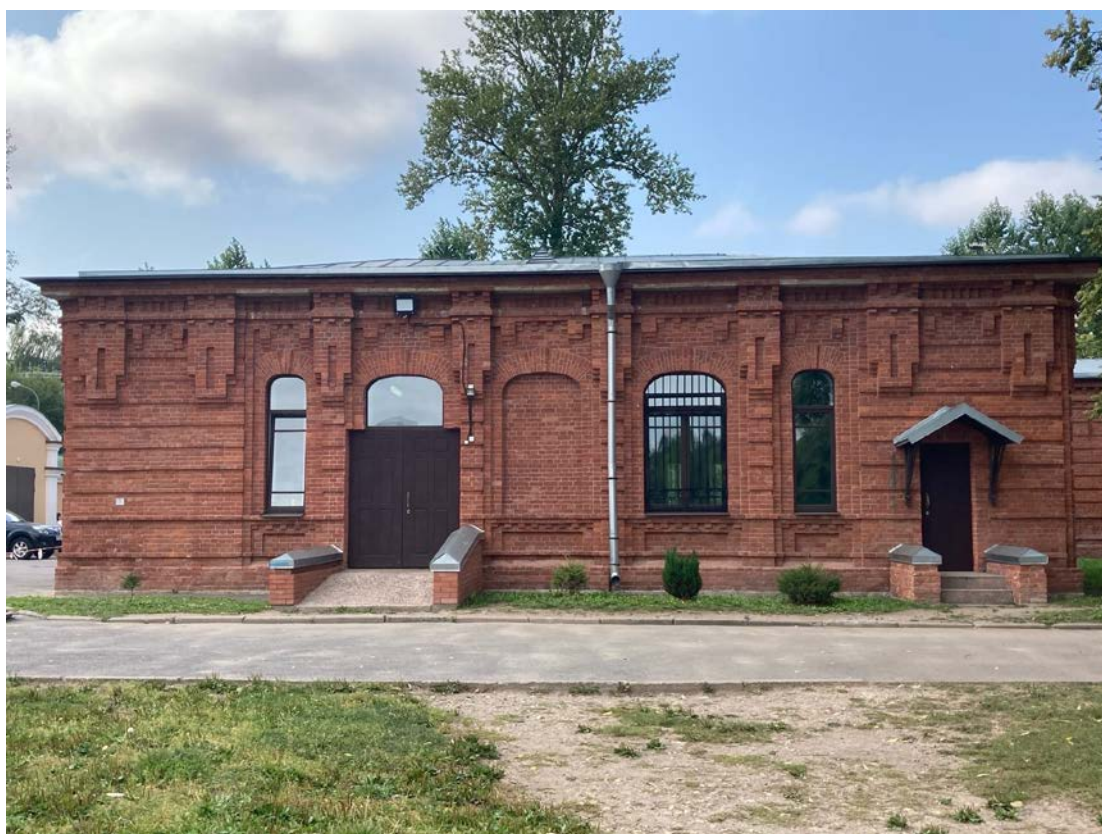
Фото 8. Фрагмент лицевого фасада объекта культурного наследия регионального значения «Школа Адмиралтейских Ижорских заводов»
