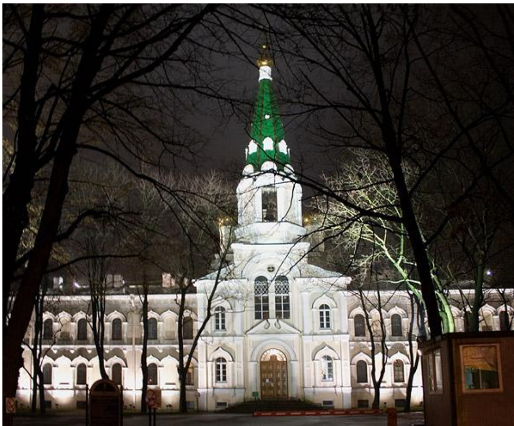
44. Воскресенский Новодевичий монастырь. Южный корпус с церковью Афонской Божией Матери. Западный фасад. Подсветка в вечернее-ночное время. 2010-е гг. Фотография. https://www.citywalls.ru .
