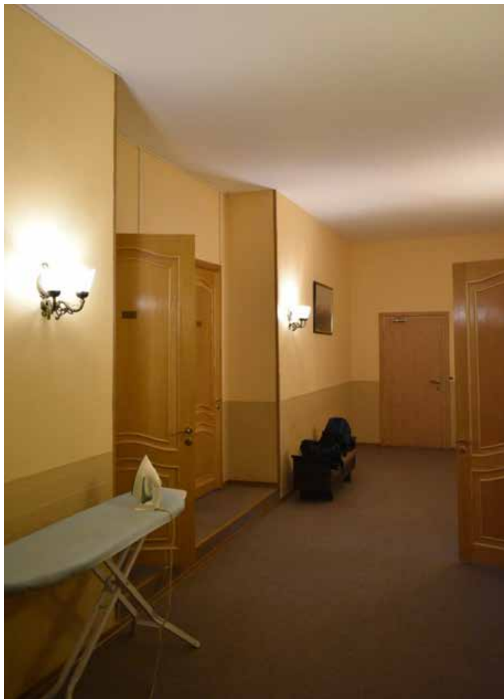
39. Объект культурного наследия федерального значения «Корпус южный с церковью Афонской Божией Матери» по адресу: г. Санкт-Петербург, г. Санкт-Петербург, Московский пр., 100 (Московский проспект, дом 100, литера А), входящий в состав объекта культурного наследия федерального значения «Монастырь Воскресенский Новодевичий. Помещение второго этажа. Фрагмент интерьера.
