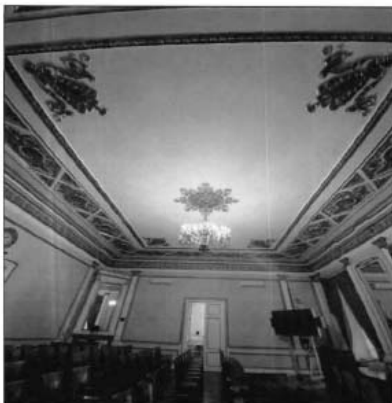
47. Декоративно художественная отделка помещений в уровне 3-го этажа (пом 27-Н (6)). Живописный плафон. Фото от 16.11.2021 г.
