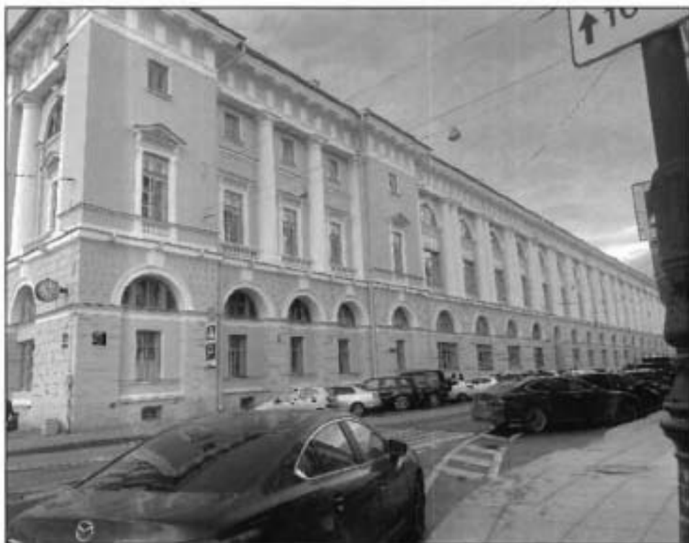
9. Лицевой фасад (ул. Зодчего Росси). Фото от 19.11.2021 г.
