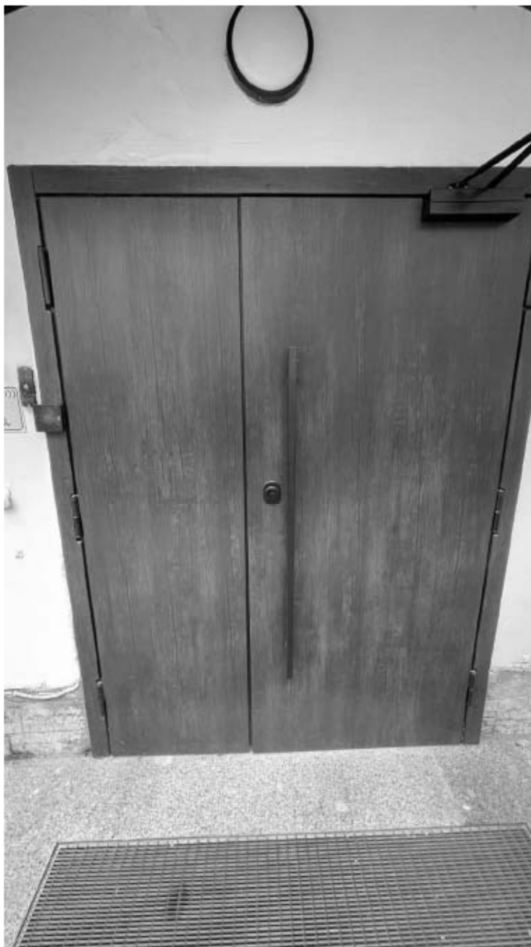
76. Вид на входную дверь на 4-ЛК;
