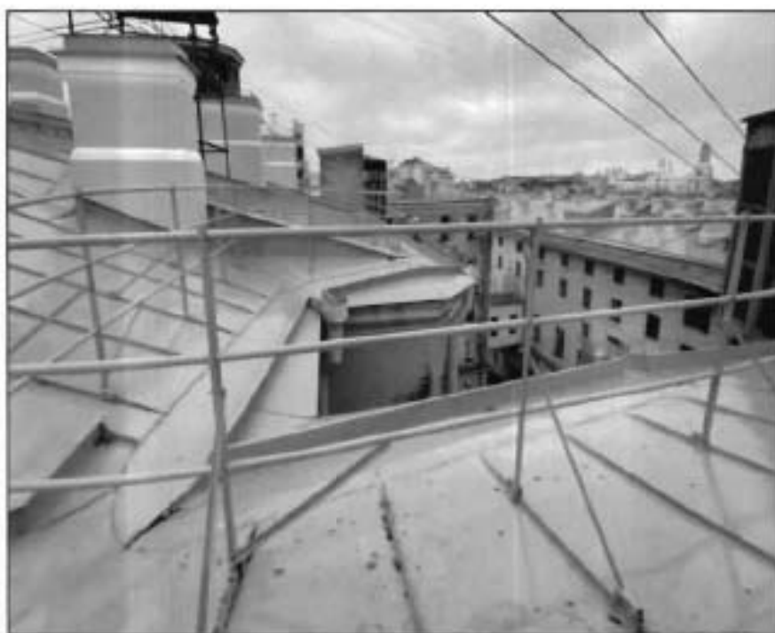
26. Металлическая кровля дворовых корпусов и флигелей (северный дворовый флигель). Фото от 18.11.2021
