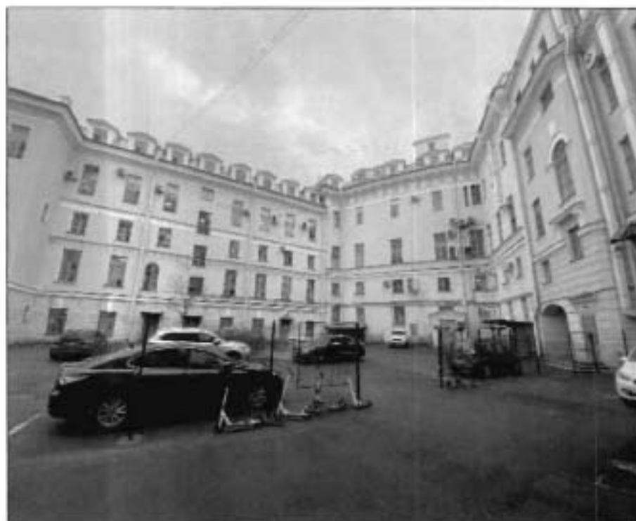
16. Дворовые фасады со стороны Торгового переуллка. Общий вид. Фото от 19.11.2021 г.
