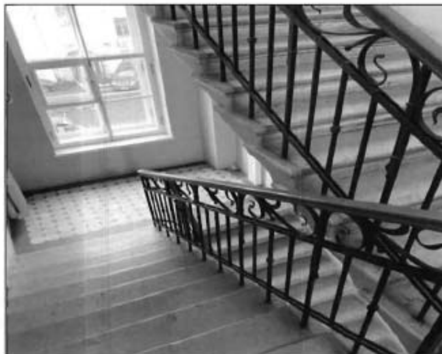
30. . Служебная двухмаршевая лестница (2ЛК). Метлахская плитка лестничных площадок. Фото от 16.11.2021 г.
