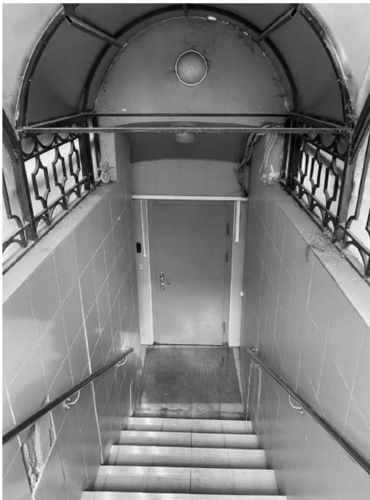
10. Вид на входную дверь в подвал,
