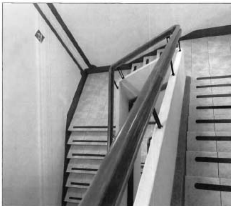
41. Двухмаршевая лестница, облицованная керамической плиткой (центральный дворовый флигель (центральный внутренний двор № 1). Фото от 17.11.2021 г.
