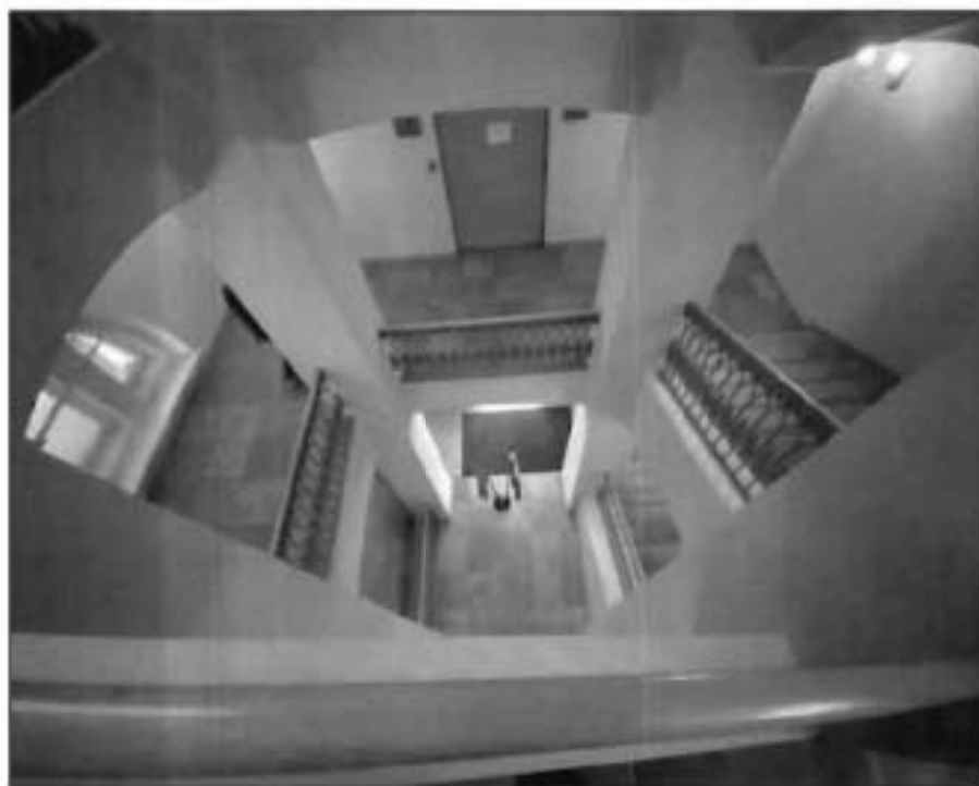
29. Парадная лестница (3ЛК) со стороны пл. Ломоносова, многомаршевая, на пилонах по ползучим с распалубками и крестовым сводам на подпружных арках. Фото от 16.11.2021 г.
