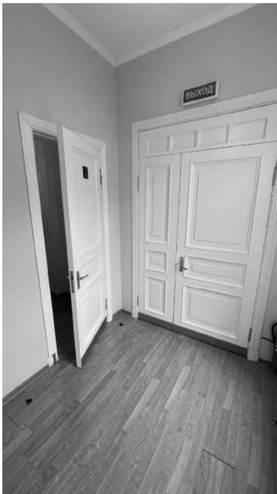
224. Вид на коридор на 5 этаже;
