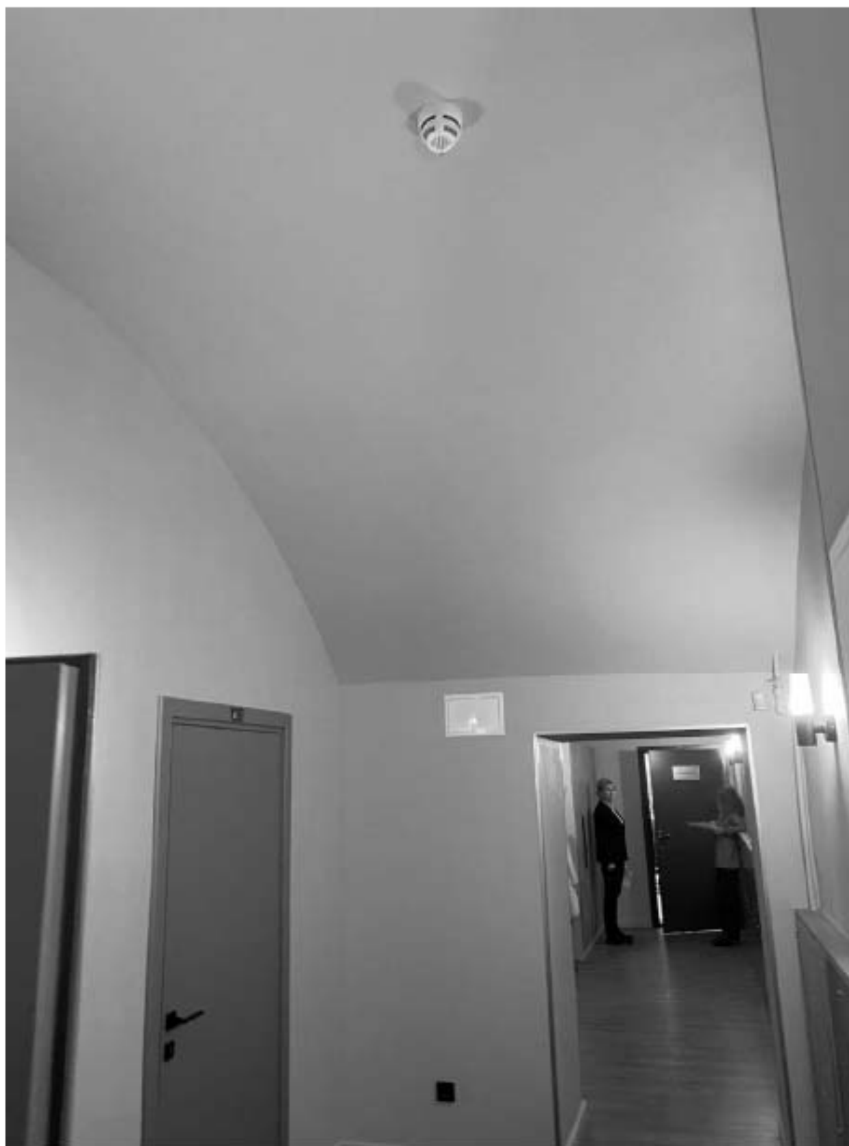
57. Фрагмент интерьера коридора (помещение №116);
