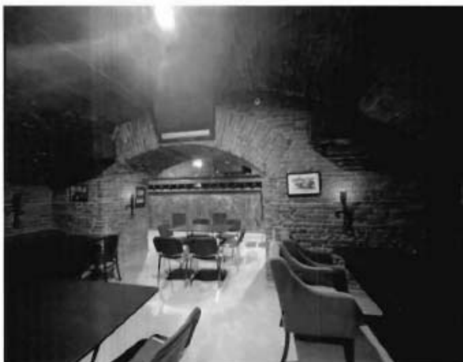
40. Своды в уровне цокольного этажа (пом. 5-Н (5-12)). Фото от 19.11.2021 г.
