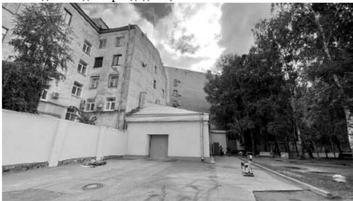
6. Вид на западный фасад здания;
