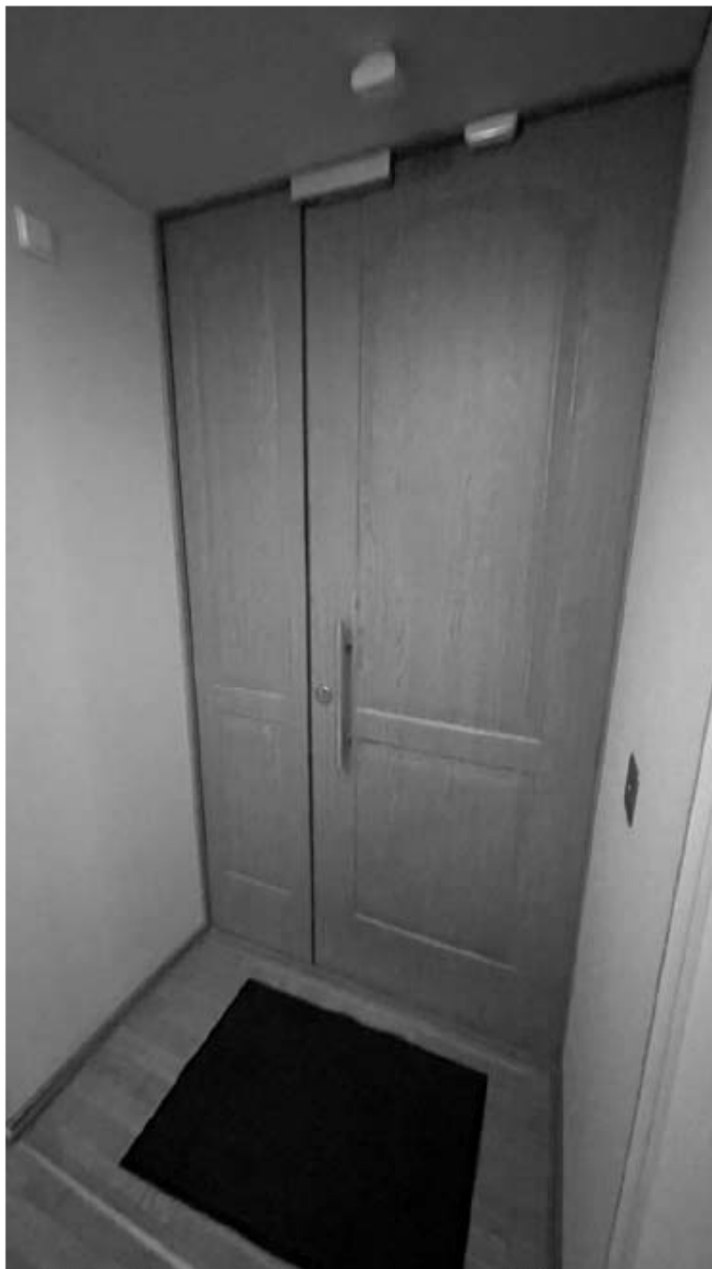
131. Дверь на лестницу в помещение 24-Н;
