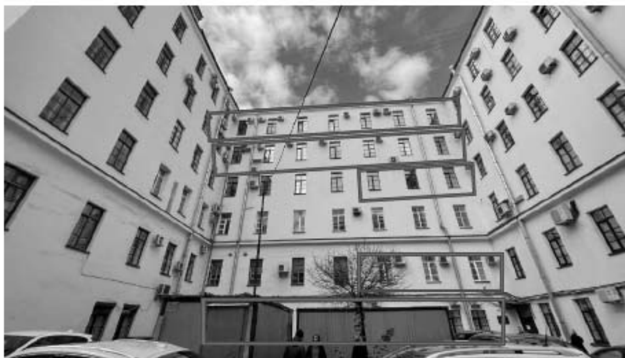
9. Вид на дворовой фасад здания;
