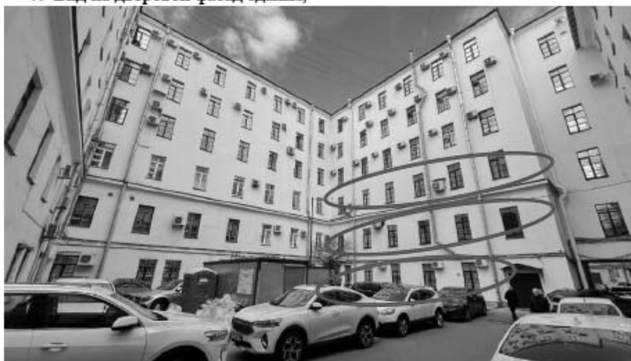
8. Вид на дворовой фасад здания;
