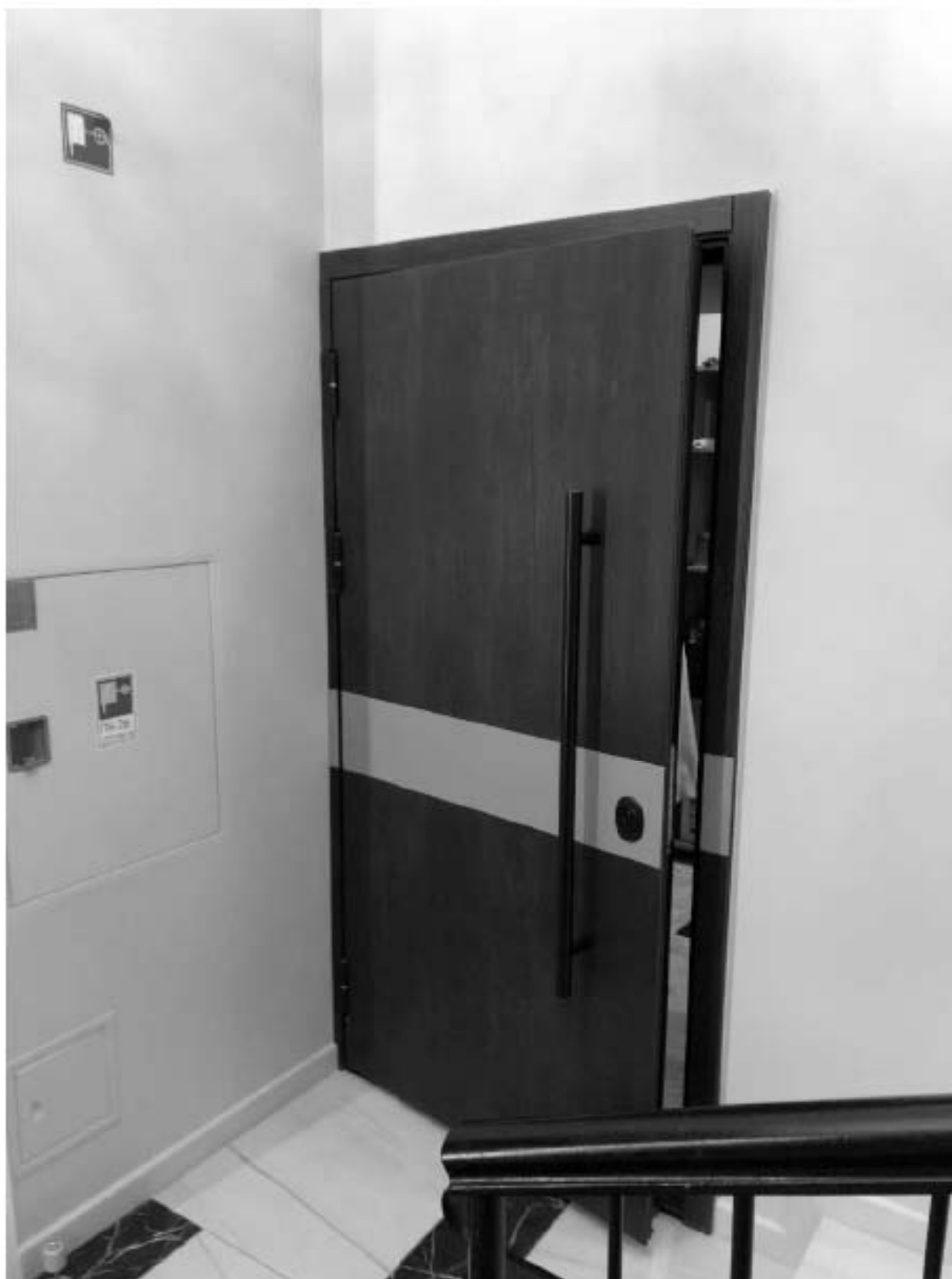
51. Вид на служебное помещение (помещение №103);
