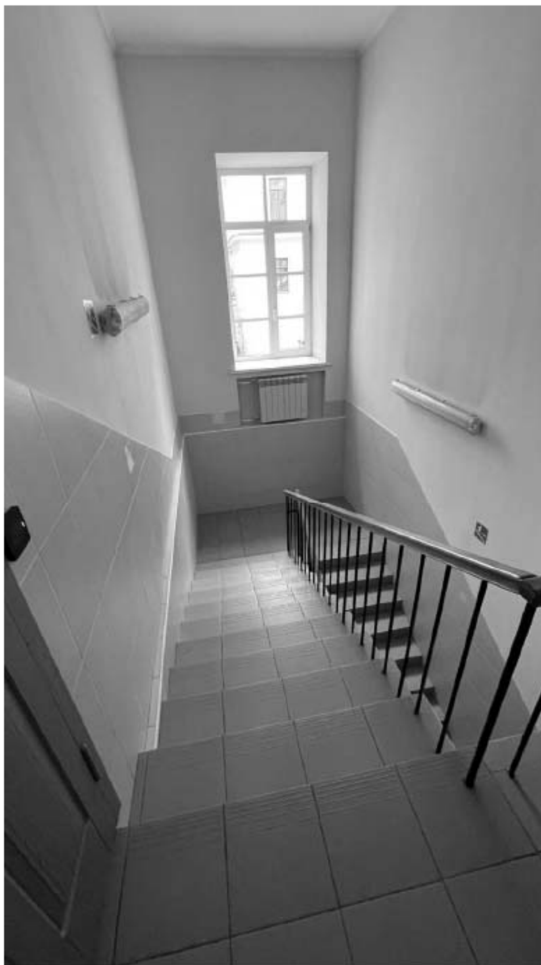
132. Вид на лестницу;
