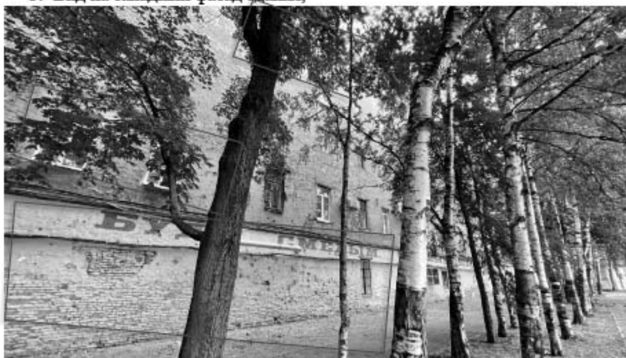
4. Вид на западный фасад здания;
