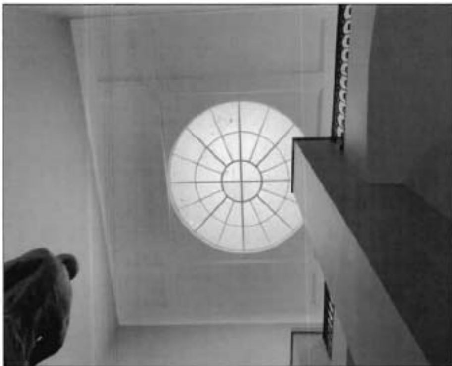
34. Круглый в плане световой фонарь над парадной лестницей № 5 в уровне 6-го этажа (пом.112-Н (67)). Фото от 16.11.2021 г.
