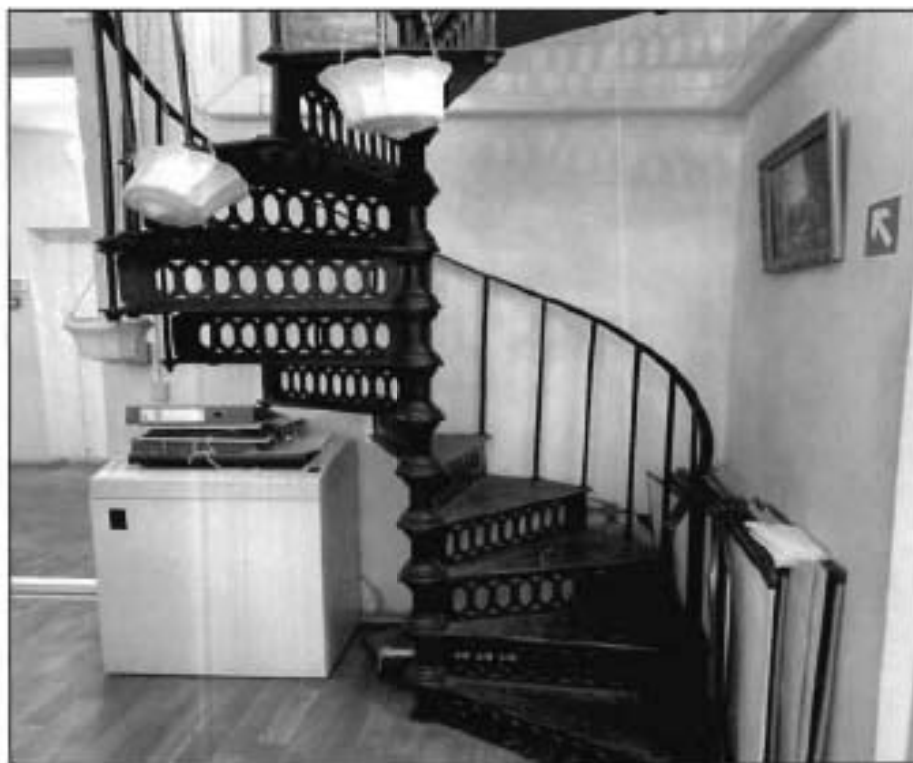
46. Металлическая винтовая лестница, в уровне 3-го этажа (пом. 27-Н (22)). Фото от 19.11.2021 г.
