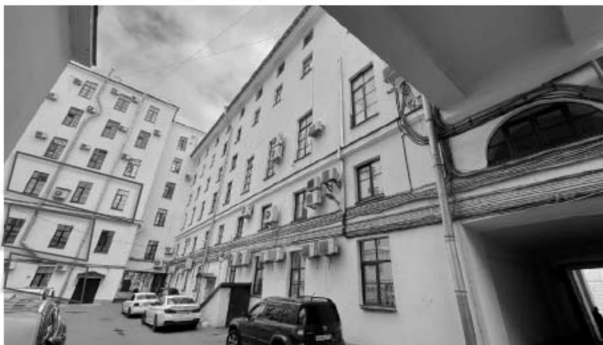
7. Вид на дворовой фасад здания;
