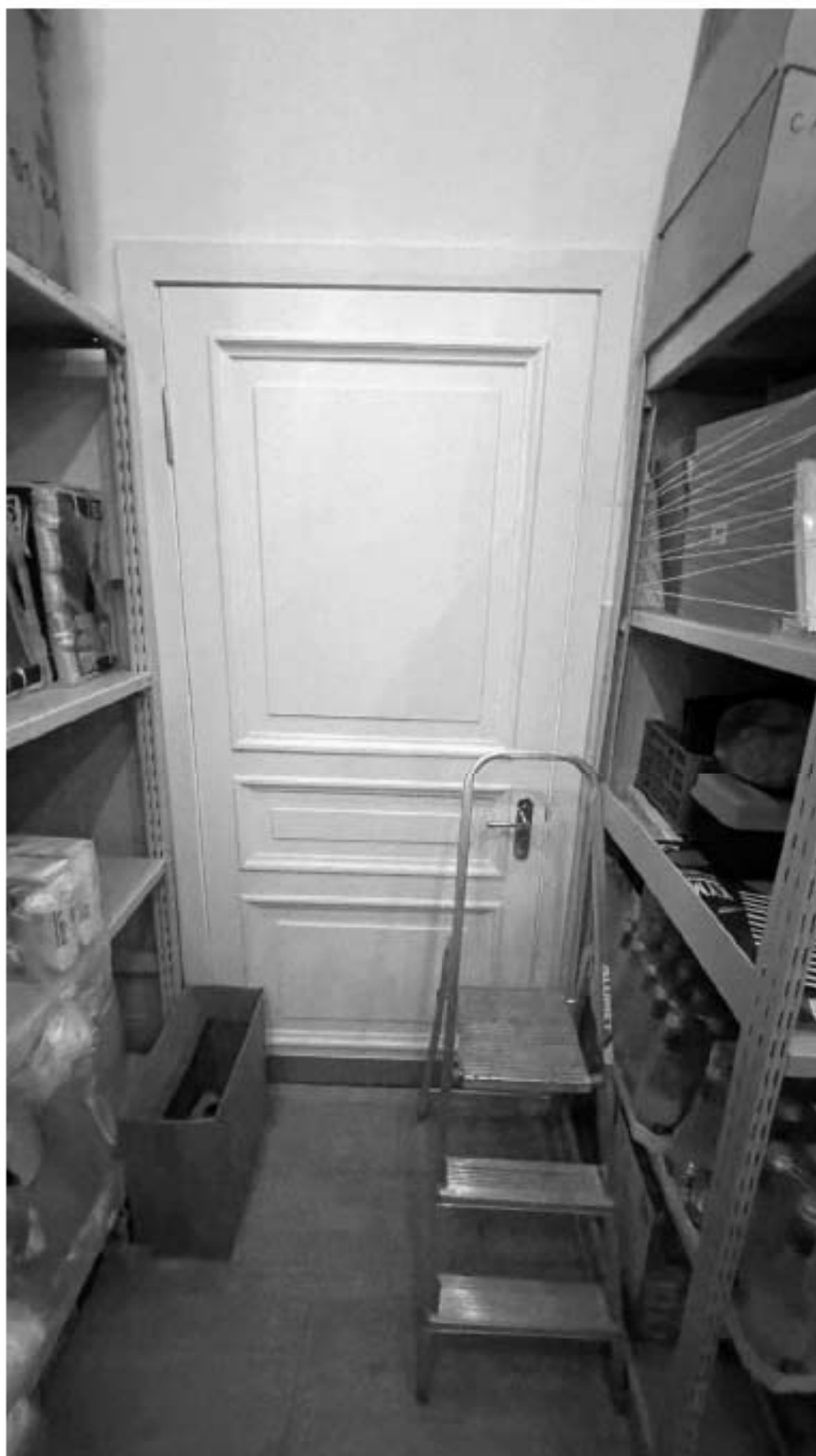
82. Вид на дверь в помещение №104;
