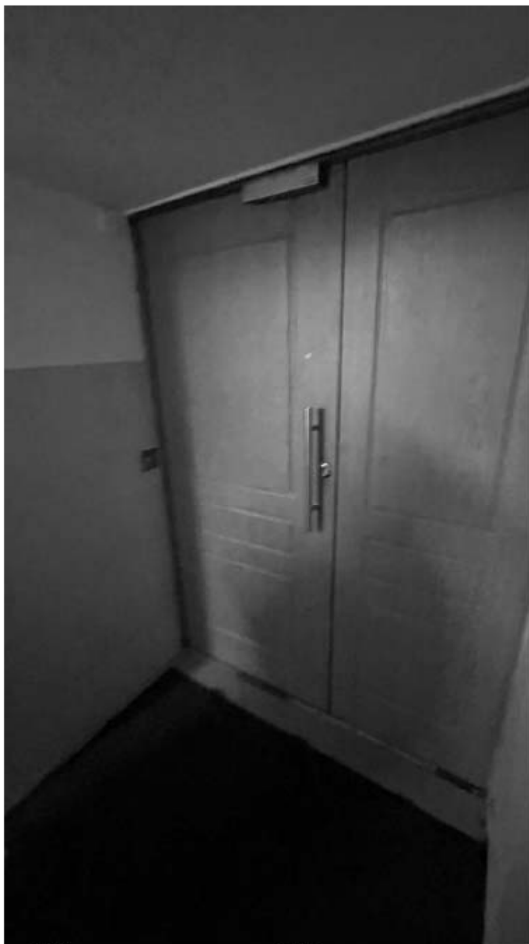
75. Вид на входную дверь на 4-ЛК;
