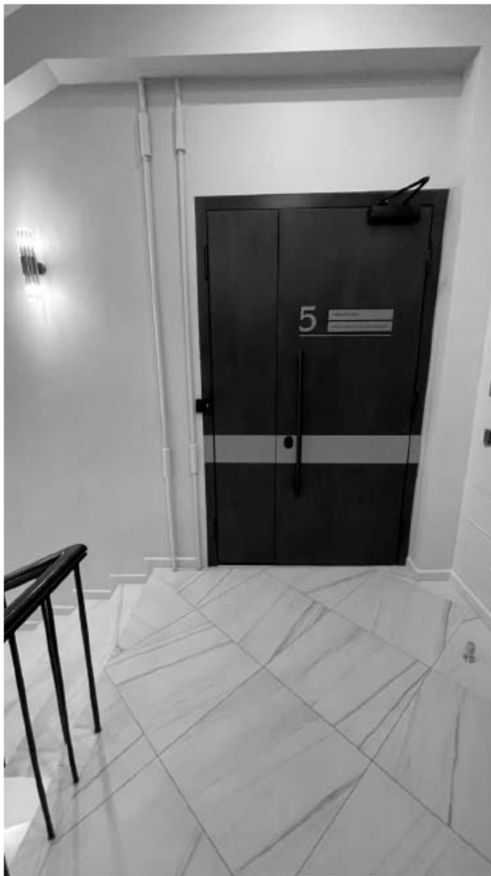
183. Фрагмент интерьера лестничной площадки и вход в помещение 58-Н;
