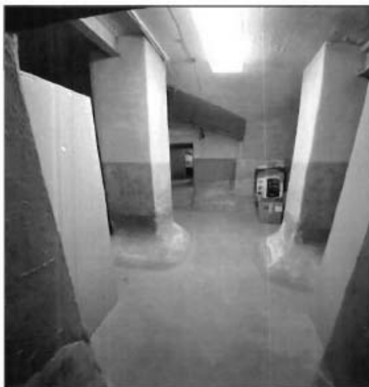
52. Пилоны подвальных помещений. Фото от 19.11.2021 г.
