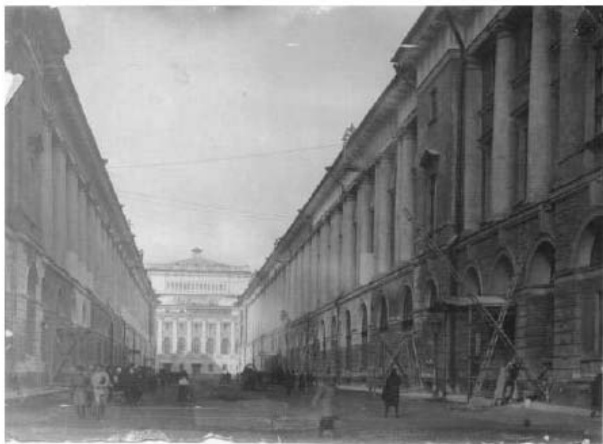
Илл. 28. Восстановление Петрограда. Ремонт домов на Театральной ул. ГЦМСИР 18203/А45-21. 1922 г.;
