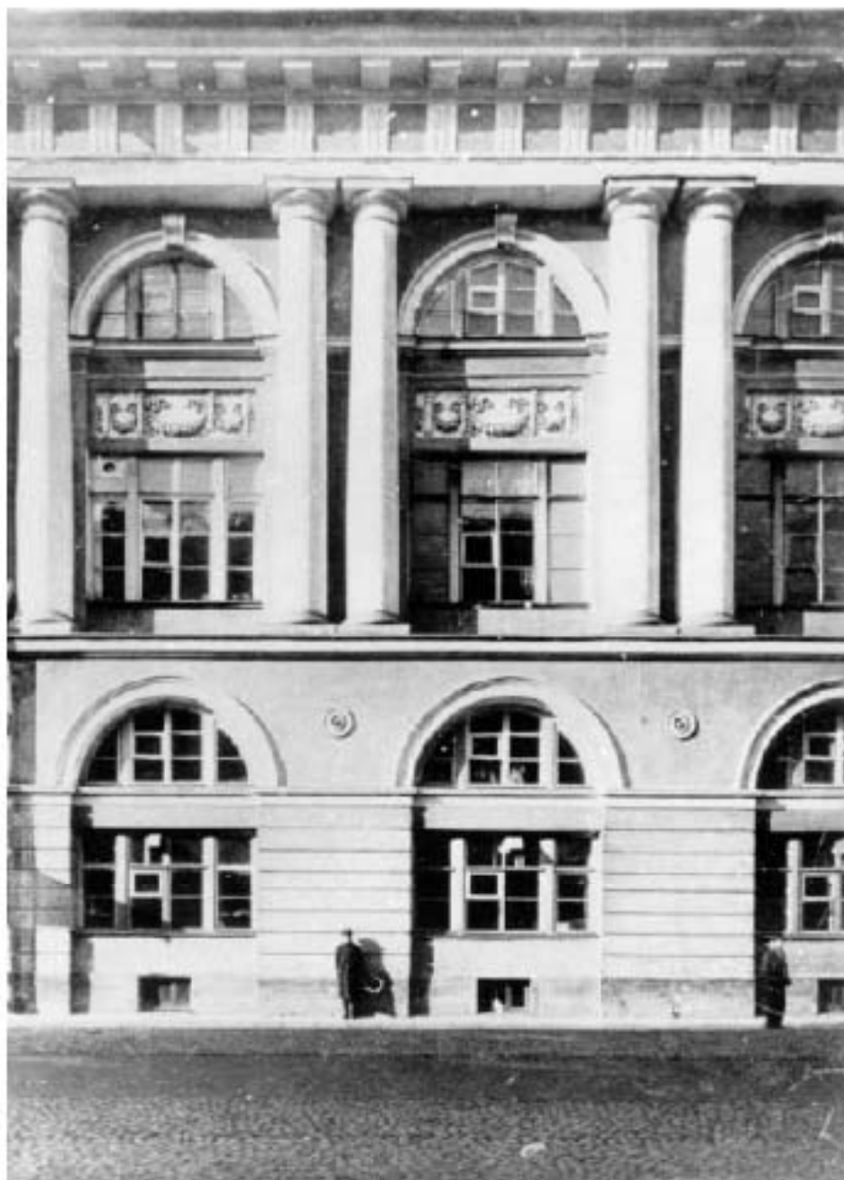
Илл. 24. Часть фасада здания на Театральной улице. ЦГАКФФД СПб. Фотодокумент А 10908. начало 1900-х гг.;
