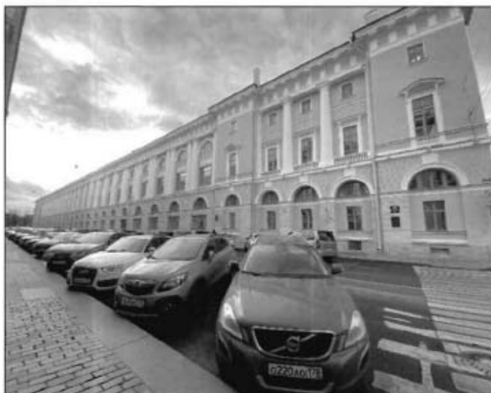
11. Лицевой фасад (ул. Звездного Росси). Фото от 19.11.2021 г.
