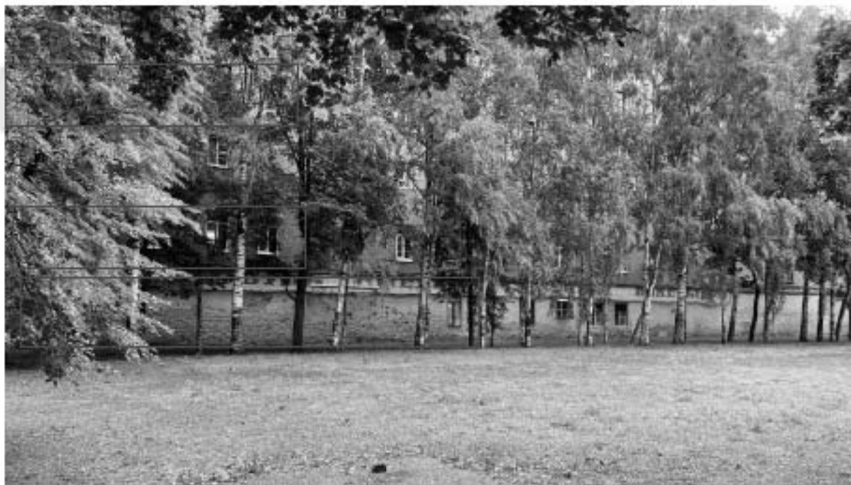
5. Вид на западный фасад здания;
