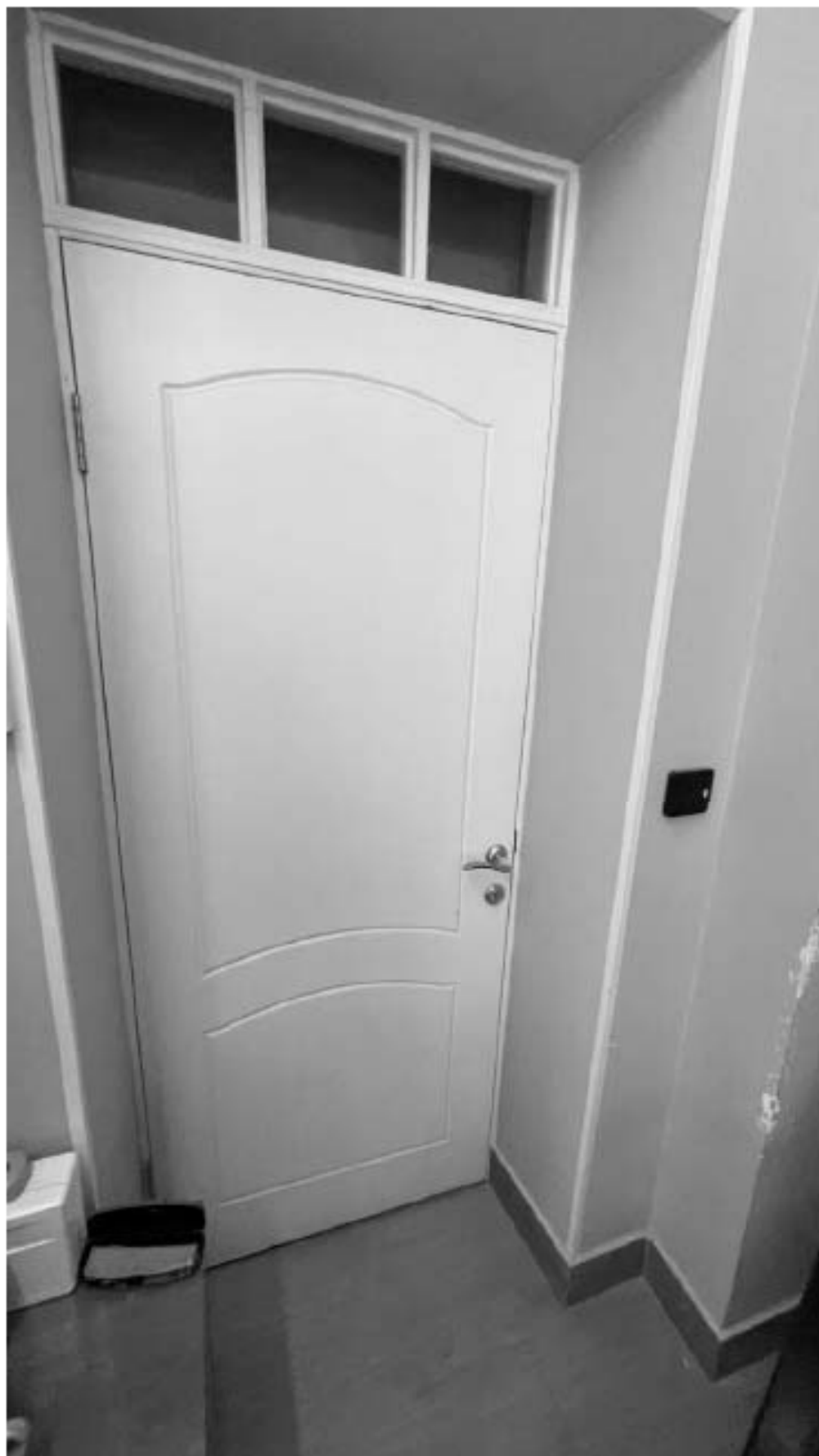
41. Вид на дверь в помещение №109;
