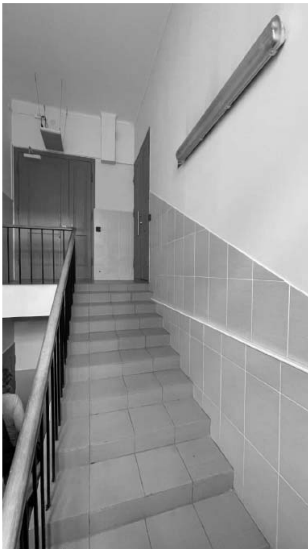
133. Вид на лестницу;
