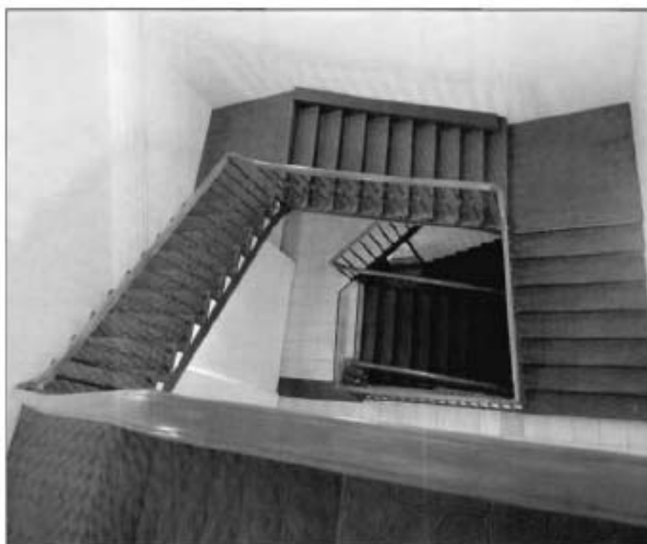
31. Четырехмаршевая железная лестница в пом. 21-Н (20) в угловой части корпусов по пл. Ломоносова и ул. Зодчего Росси. Фото от 16.11.2021 г.
