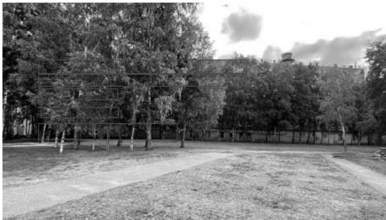
1. Вид на западный фасад здания;
