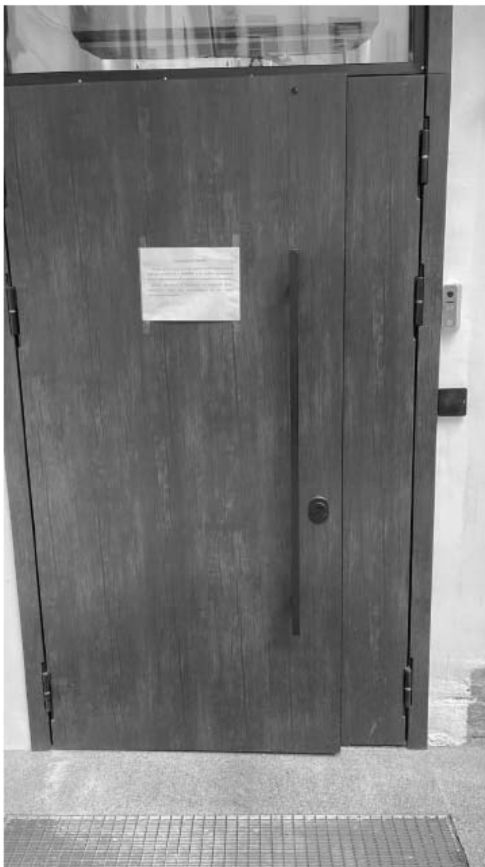
39. Вид на входную дверь;
