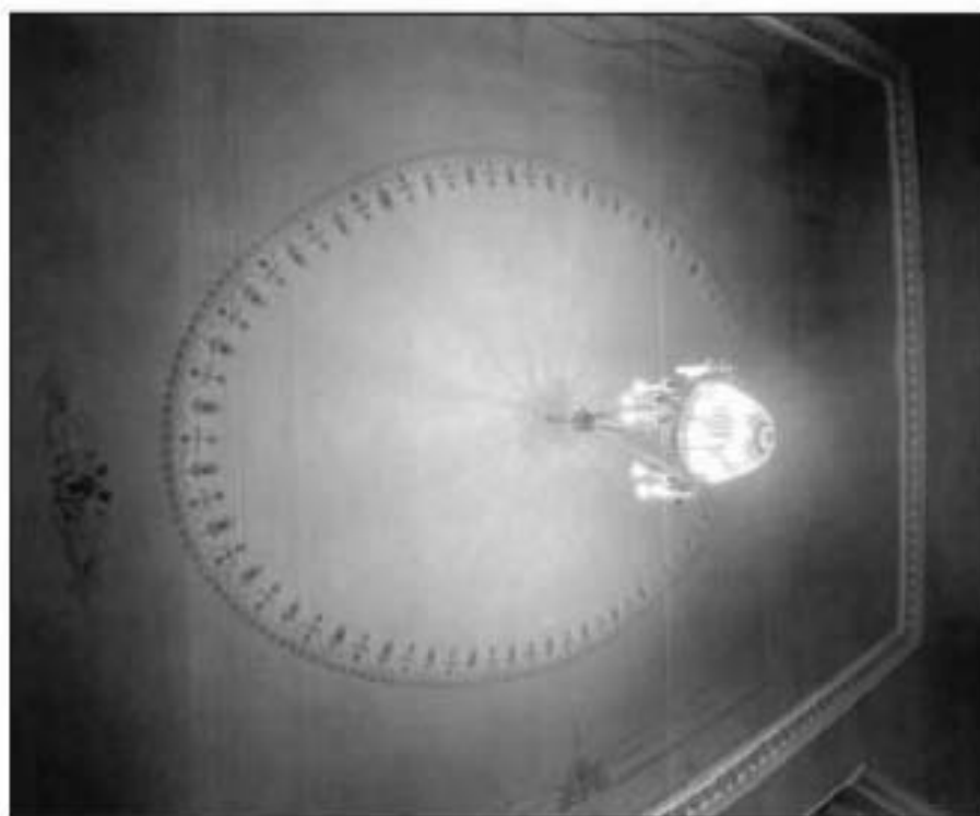
38. Декоративно художественная отделка помещений (пом. 30-Н (41)) в уровне 3-го этажа. Живописный плафон. Фото от 16.11.2021 г.
