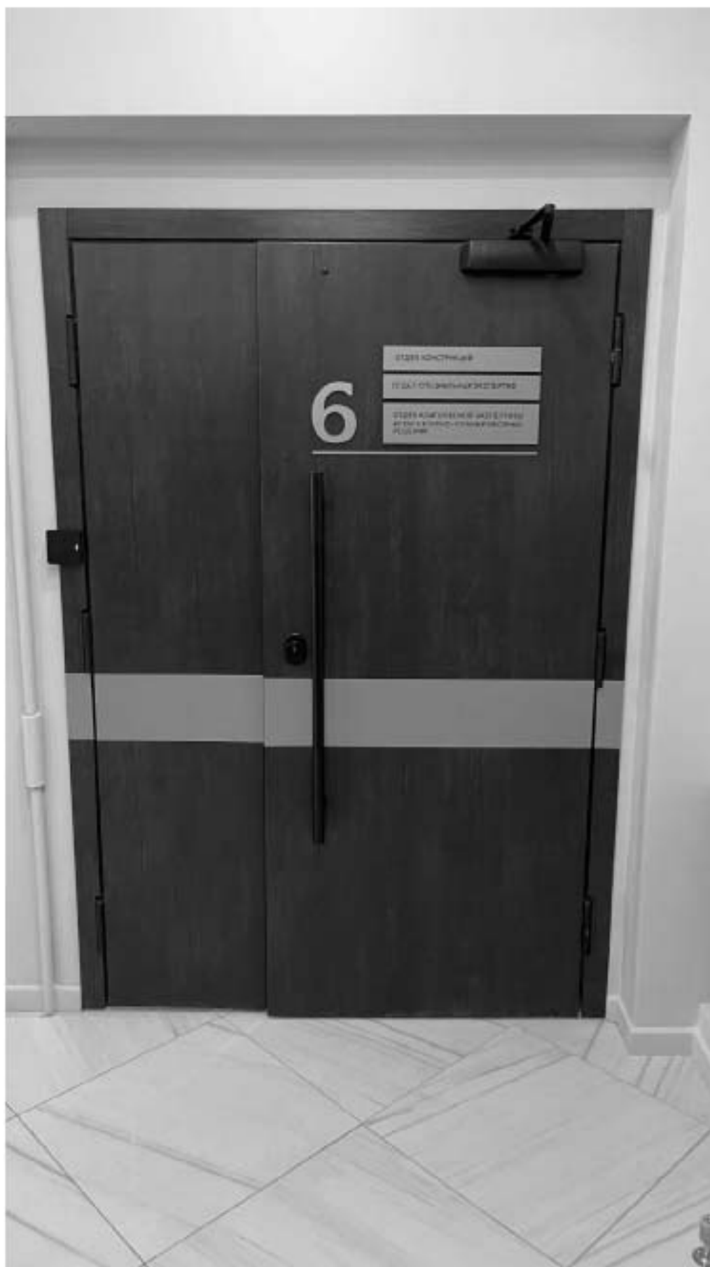
243. Вход в помещение 42-Н;
