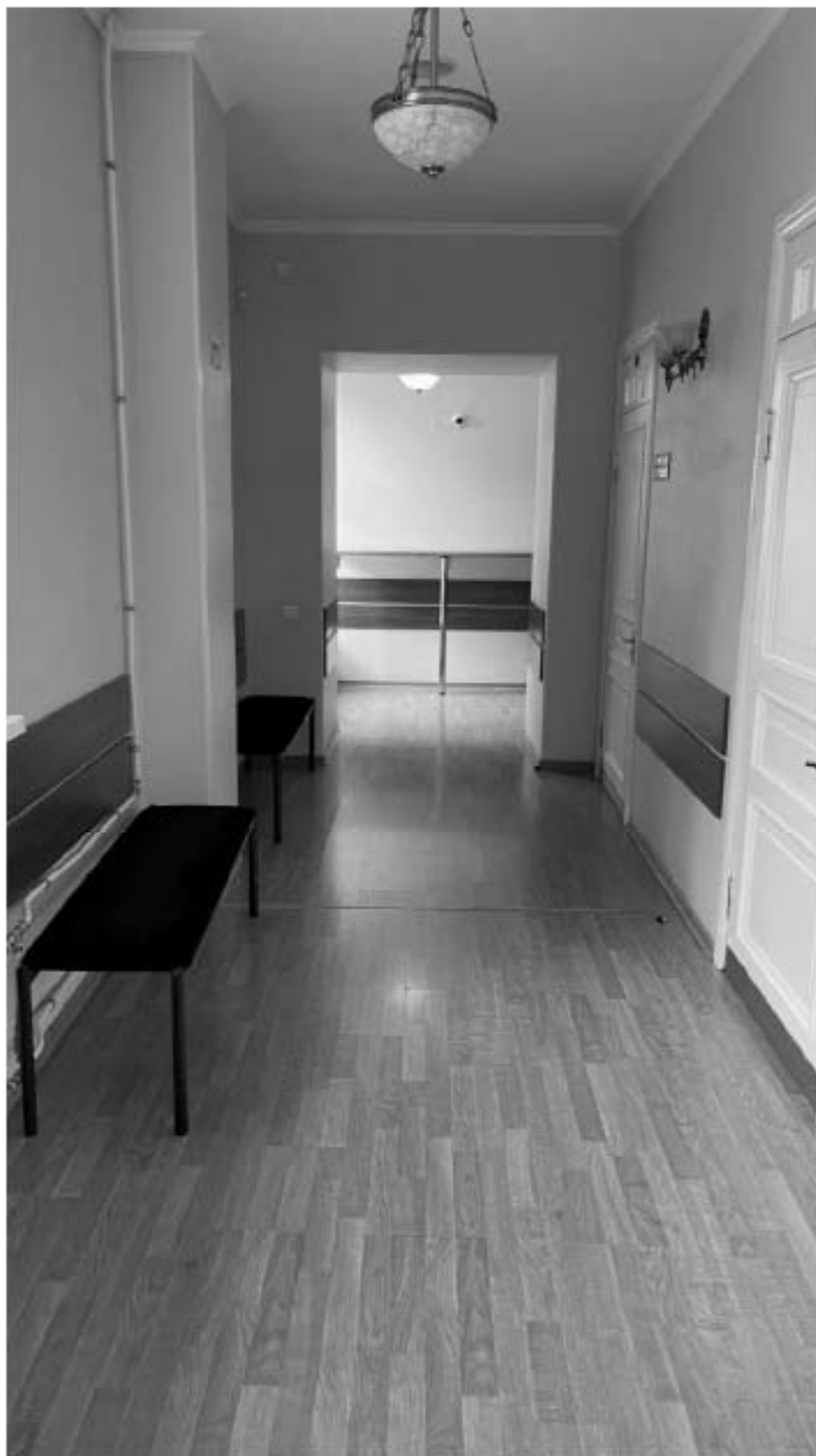
223. Вид на коридор на 5 этаже;
