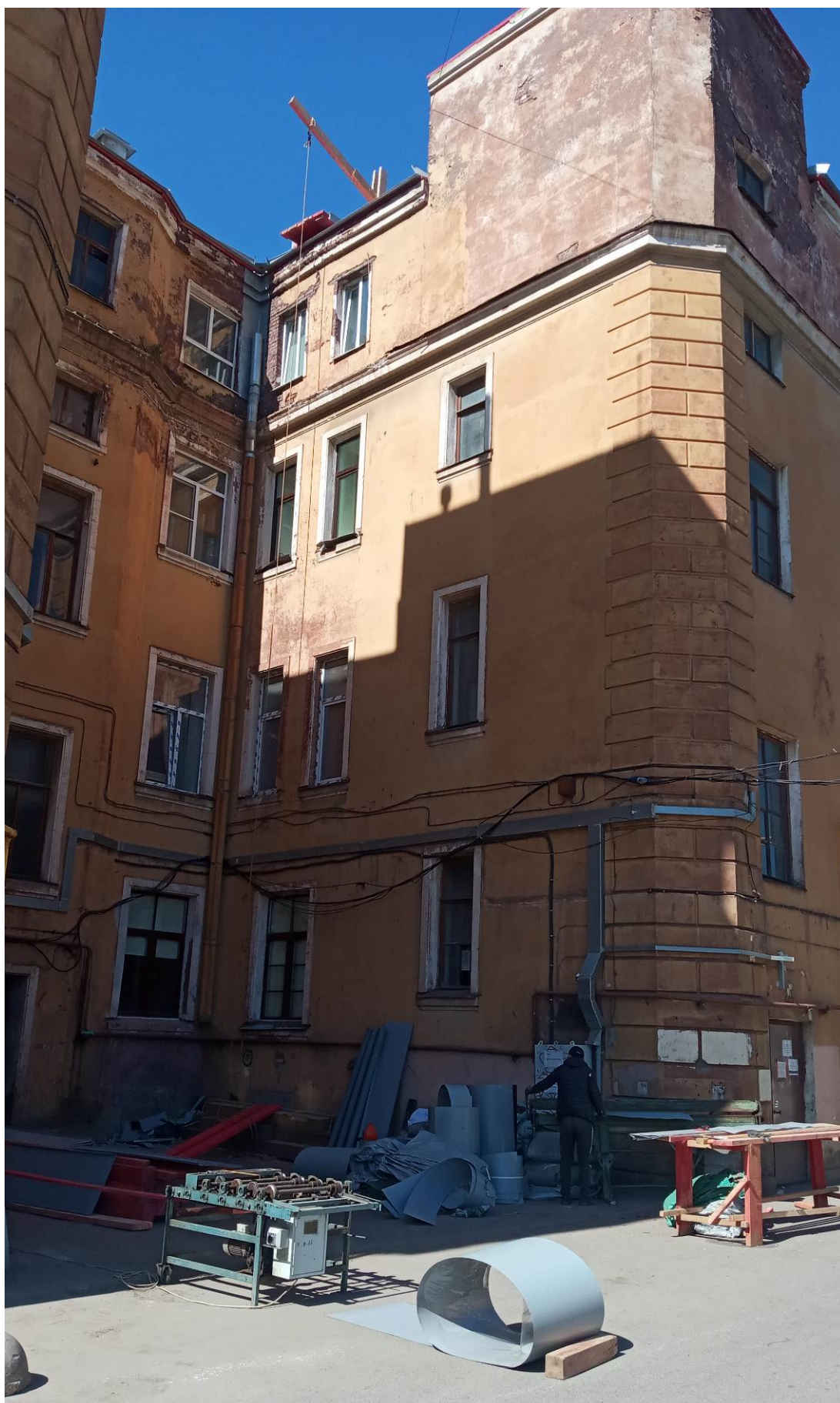
Фото 2. Общій вид дворового юго-восточного фасада здания.
