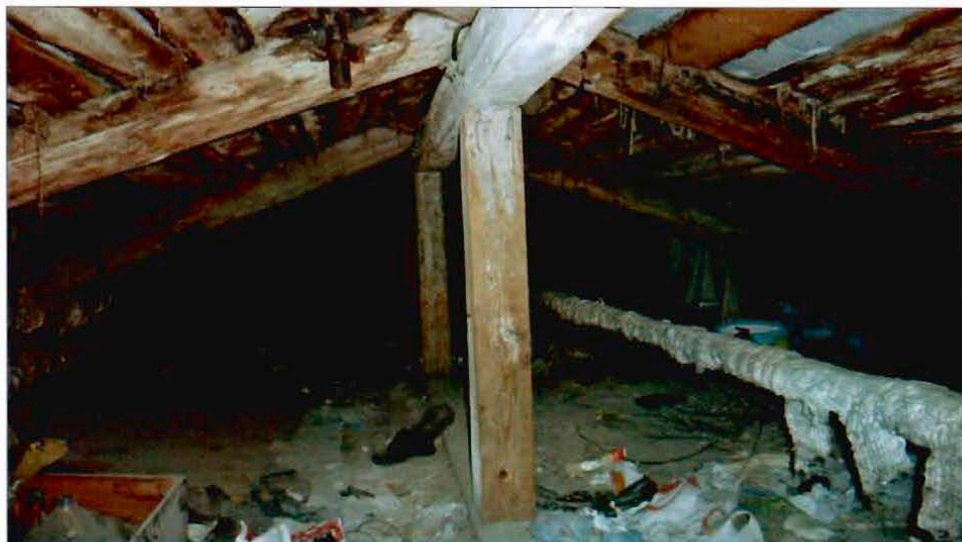
7. Стропильная система. Чердак.
