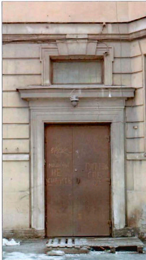
6. Оформление дверного проема. Юго-восточный фасад. Фрагмент.
