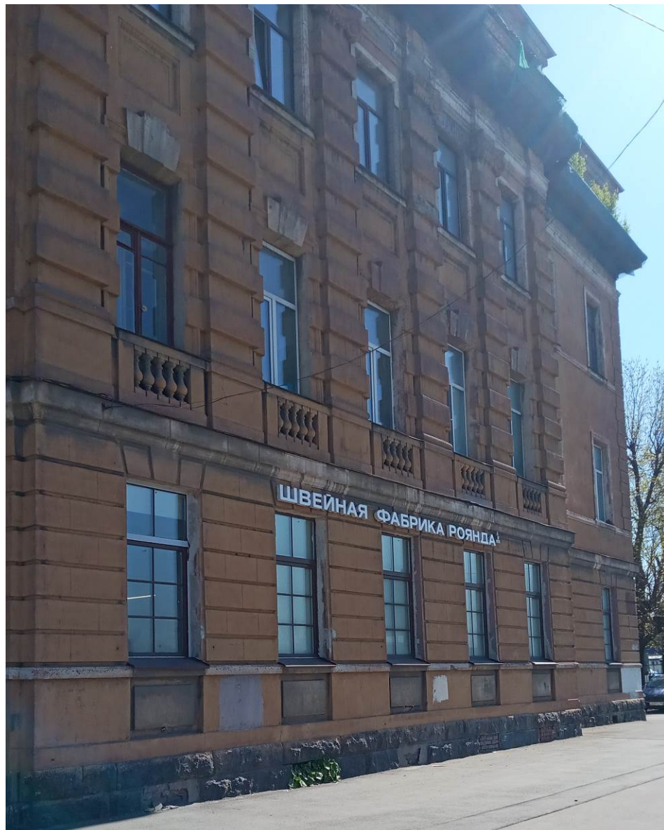
Фото 4. Общий вид лицевого юго-западного фасада здания.
