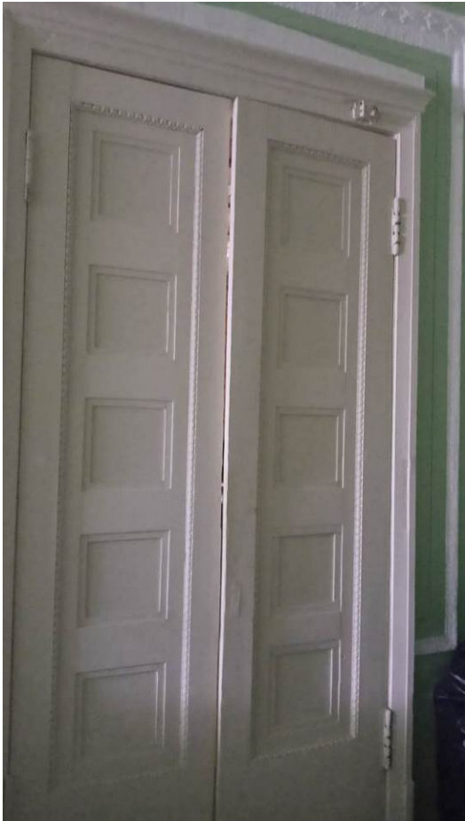
Фото 17. Входная дверь в помещение 2-Н со стороны вестибюля главного входа.
