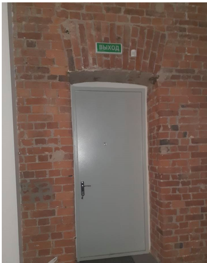
Фото 6. Входная дверь со стороны помещения 2-Н.
