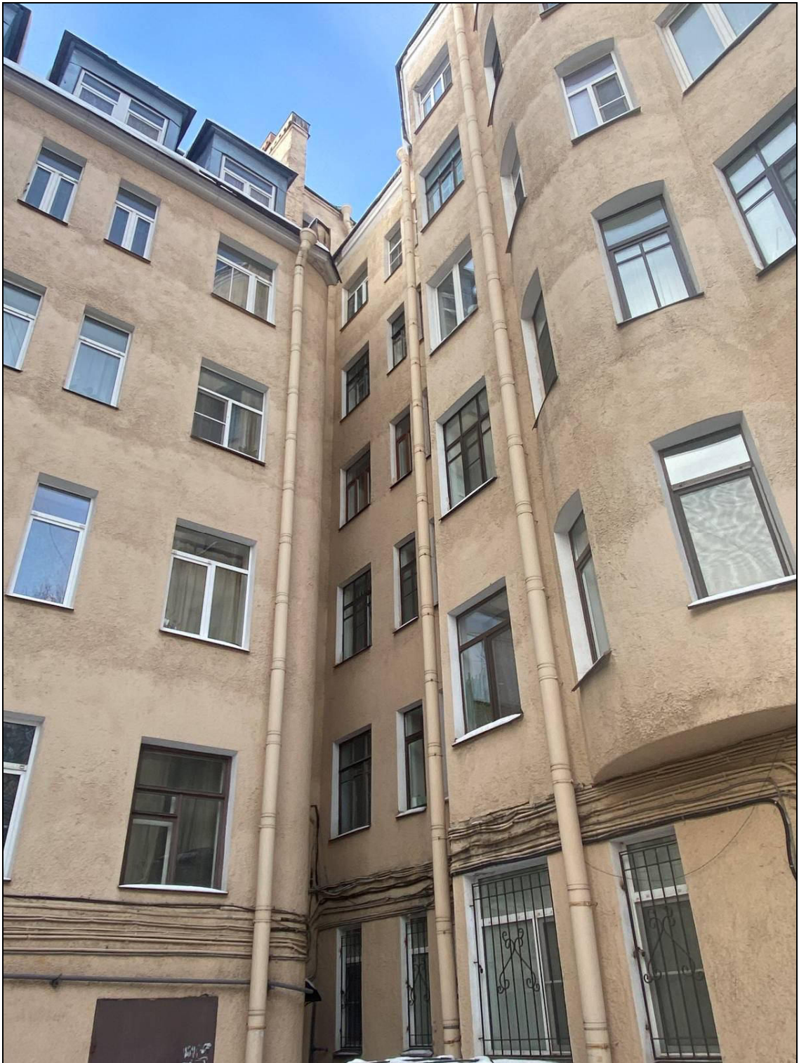
04. Фрагмент дворового фасада лицевого корпуса и дворового фасада дворового флигеля.
