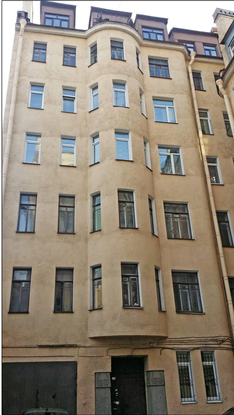
03. Фрагмент дворового фасада юго-восточного дворового флигеля.
