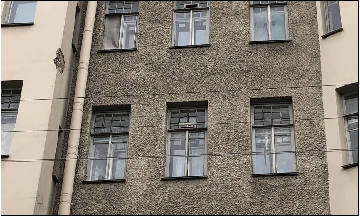
01.2. Фрагмент лицевого фасада. Заполнения оконных проемов, сохранившие исторический рисунок мелкой расстекловки.
